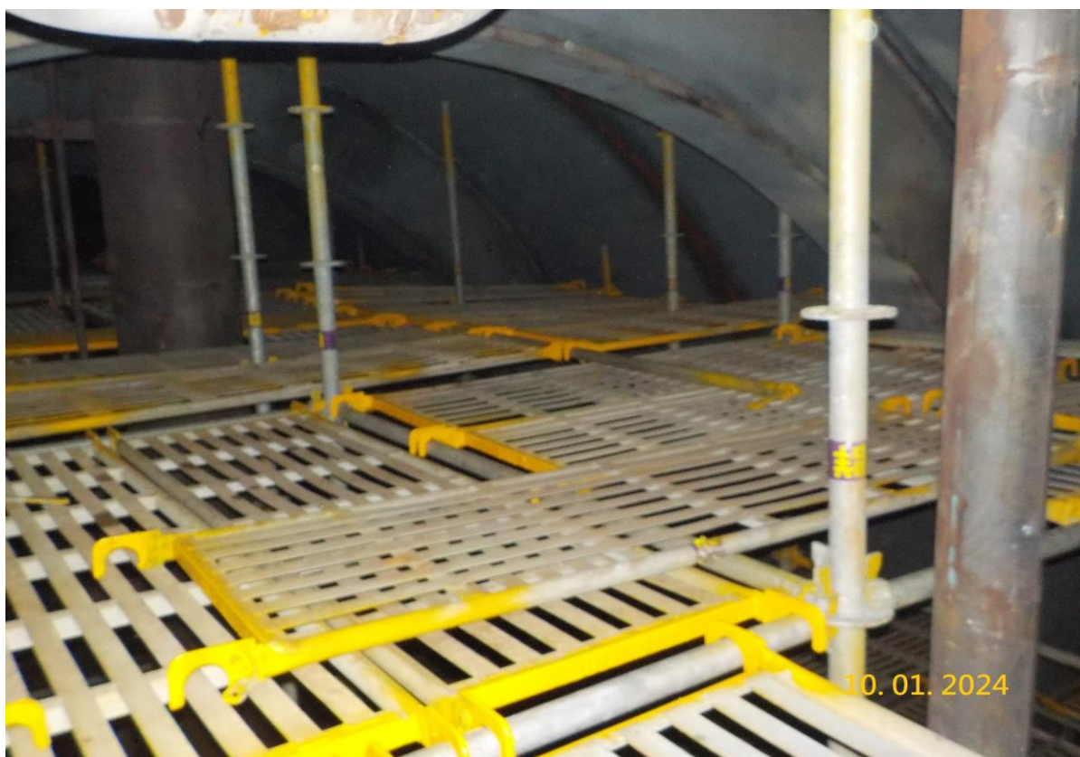
8. 槽內搭架作業情形(3)
