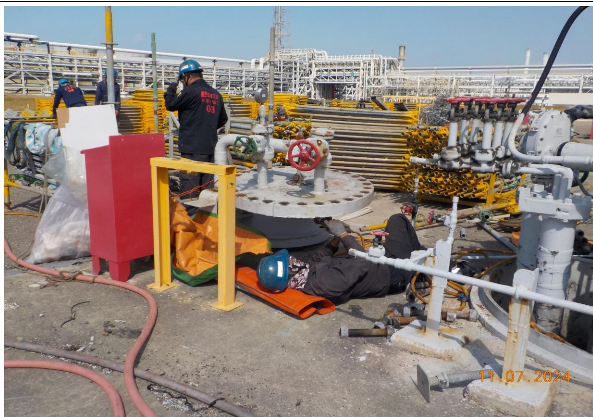
11.人孔復原前法蘭面整理
