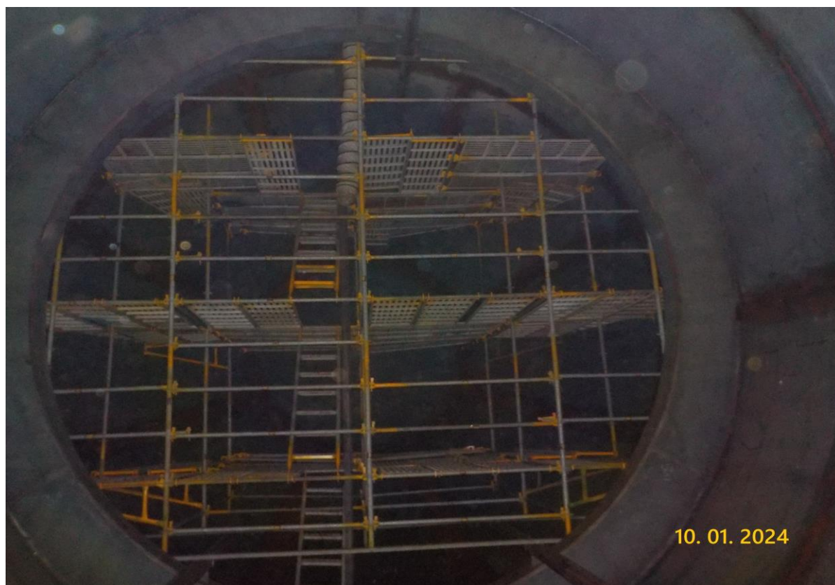
6. 槽內搭架作業情形(1)
