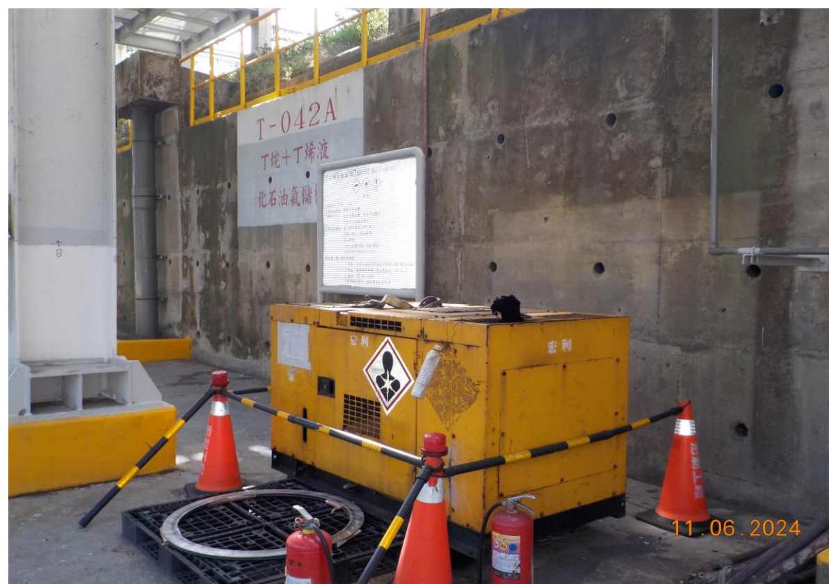
4.空壓機定位情形
