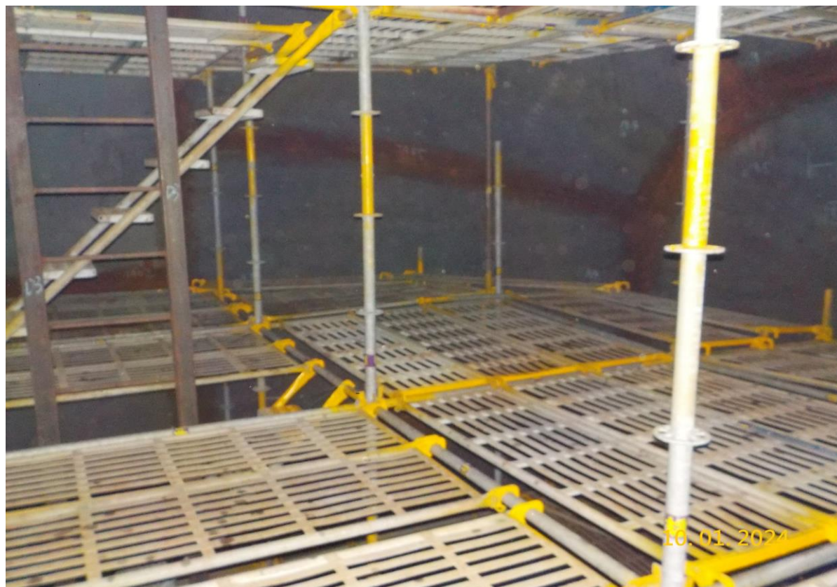
7. 槽內搭架作業情形(2)
