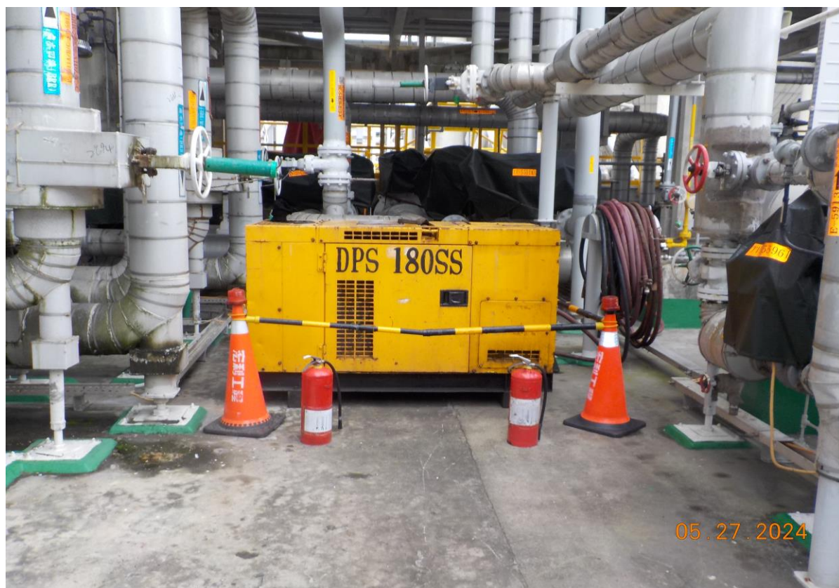
1. 空壓機定位情形
