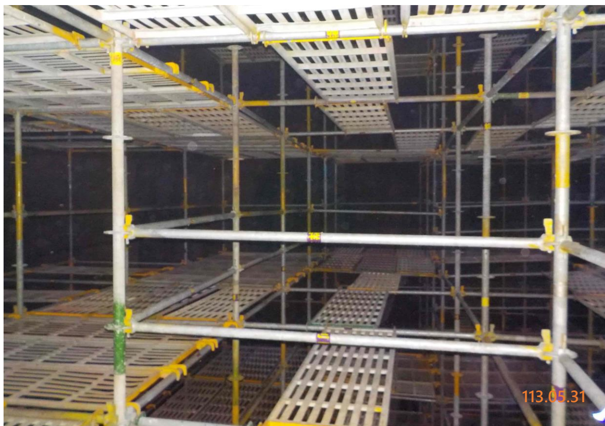
12. 槽內搭架作業情形(4)
