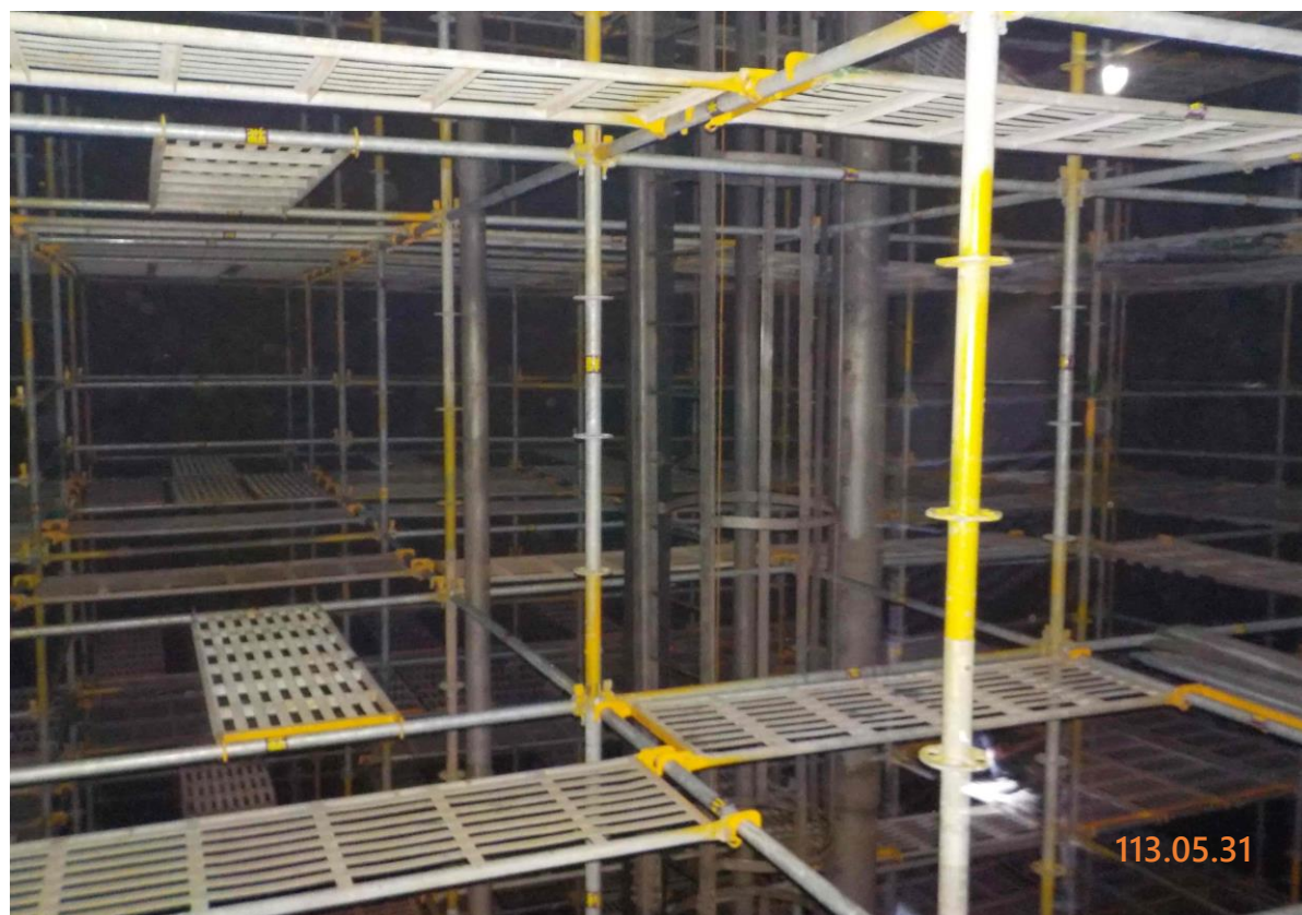
9. 槽內搭架作業情形(1)
