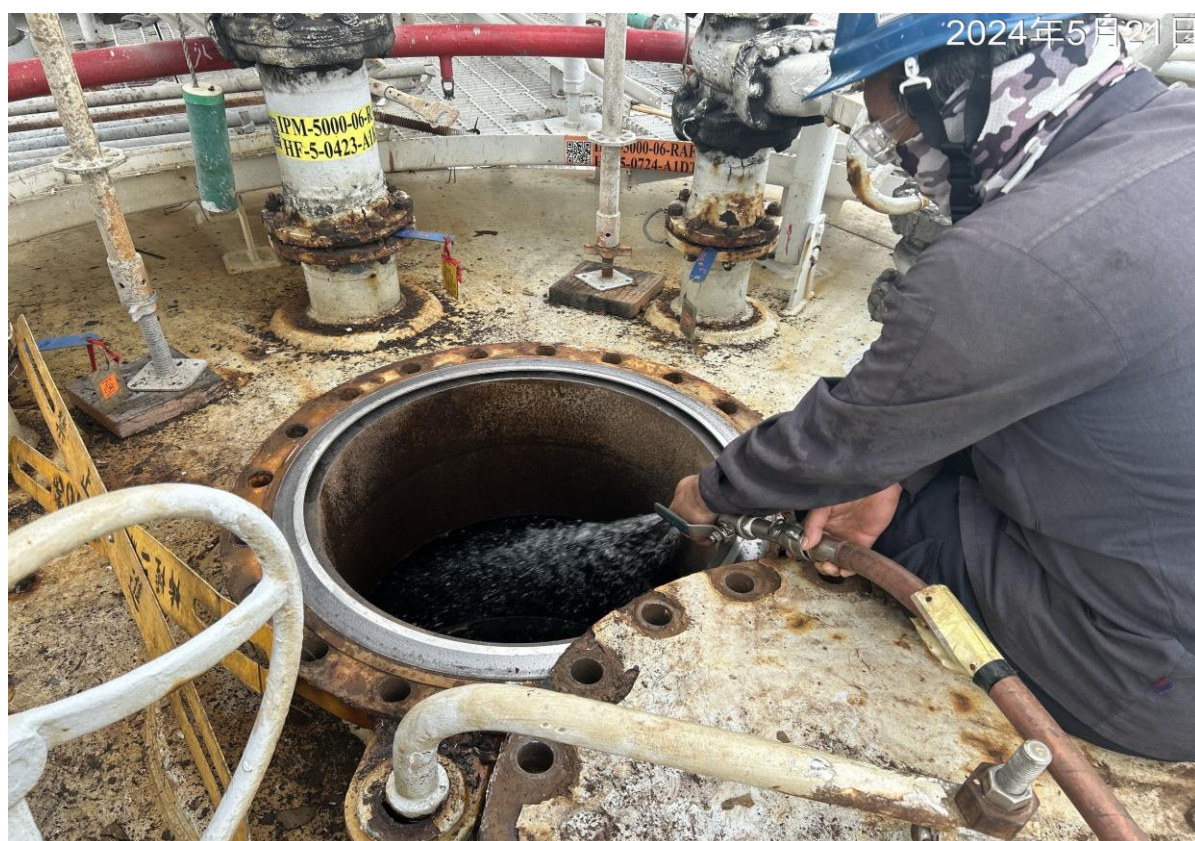
6. 槽內水洗情形
