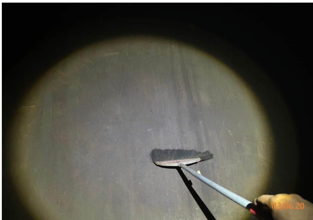
13. 槽內清掃作業
