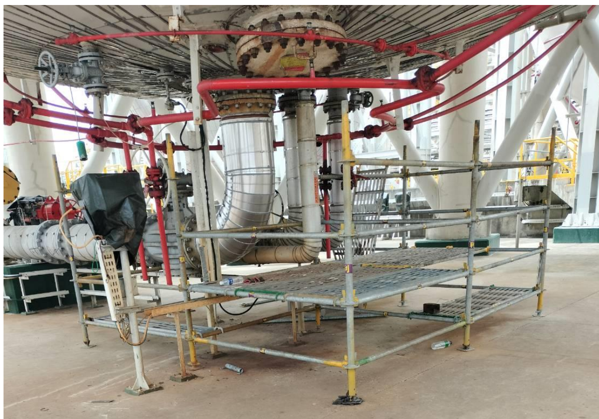
8. 槽外人孔架搭設情形
