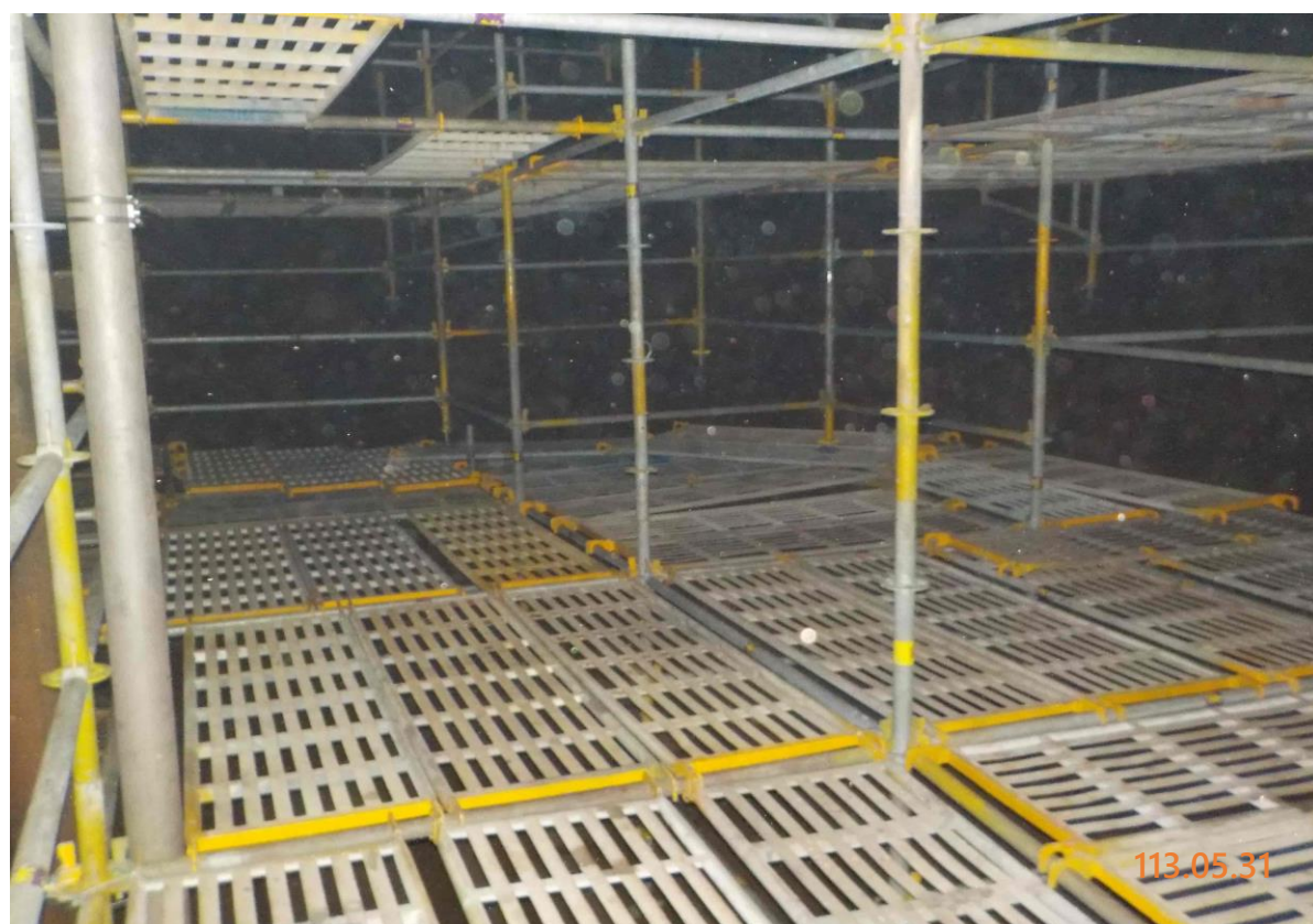
10. 槽內搭架作業情形(2)
