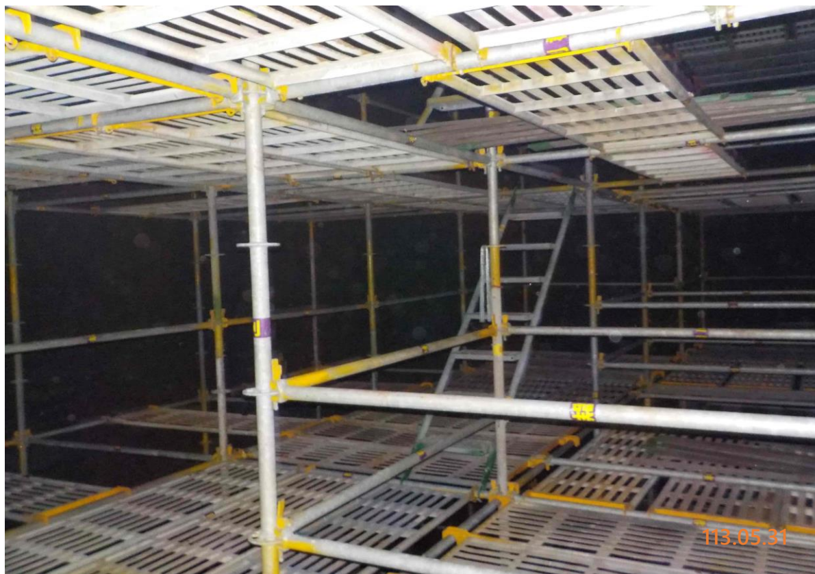
11. 槽內搭架作業情形(3)
