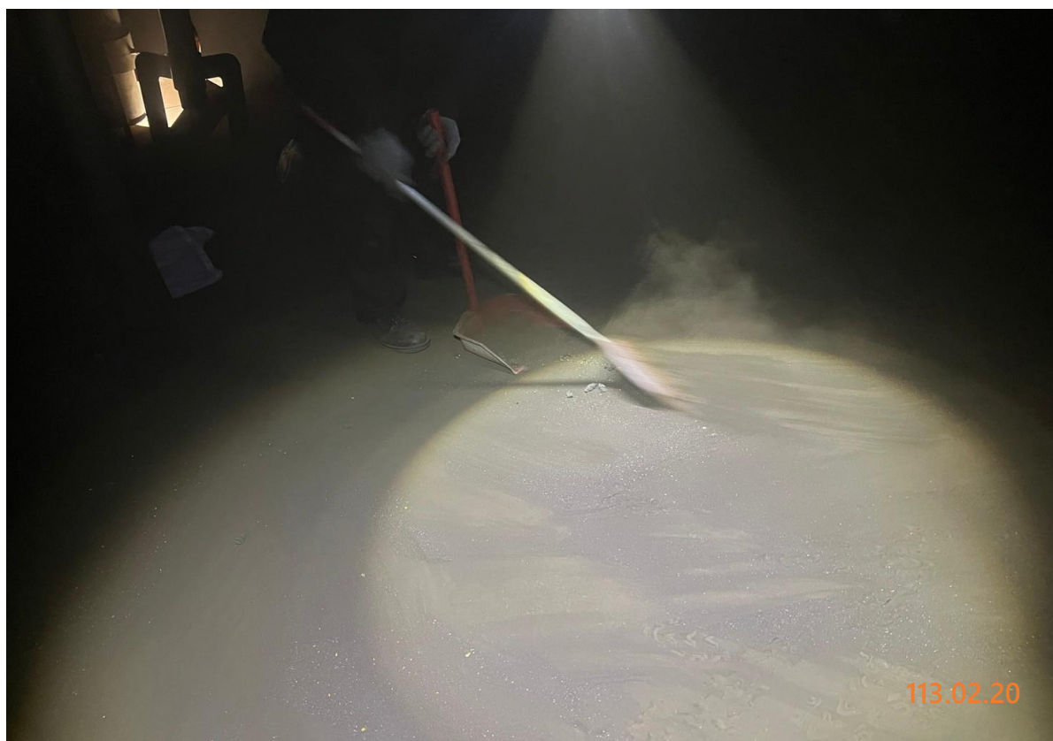
13. 槽內清掃作業
