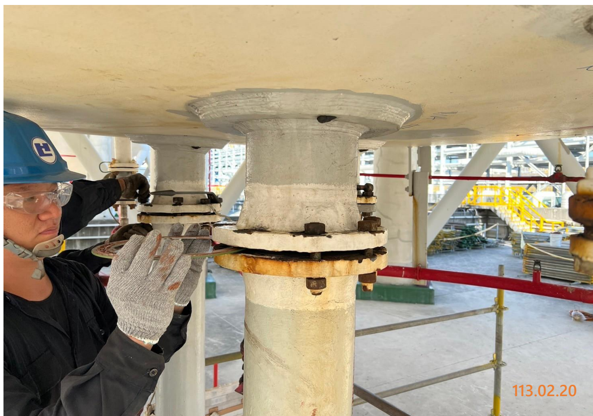
15. 管線抽盲作業(1)
