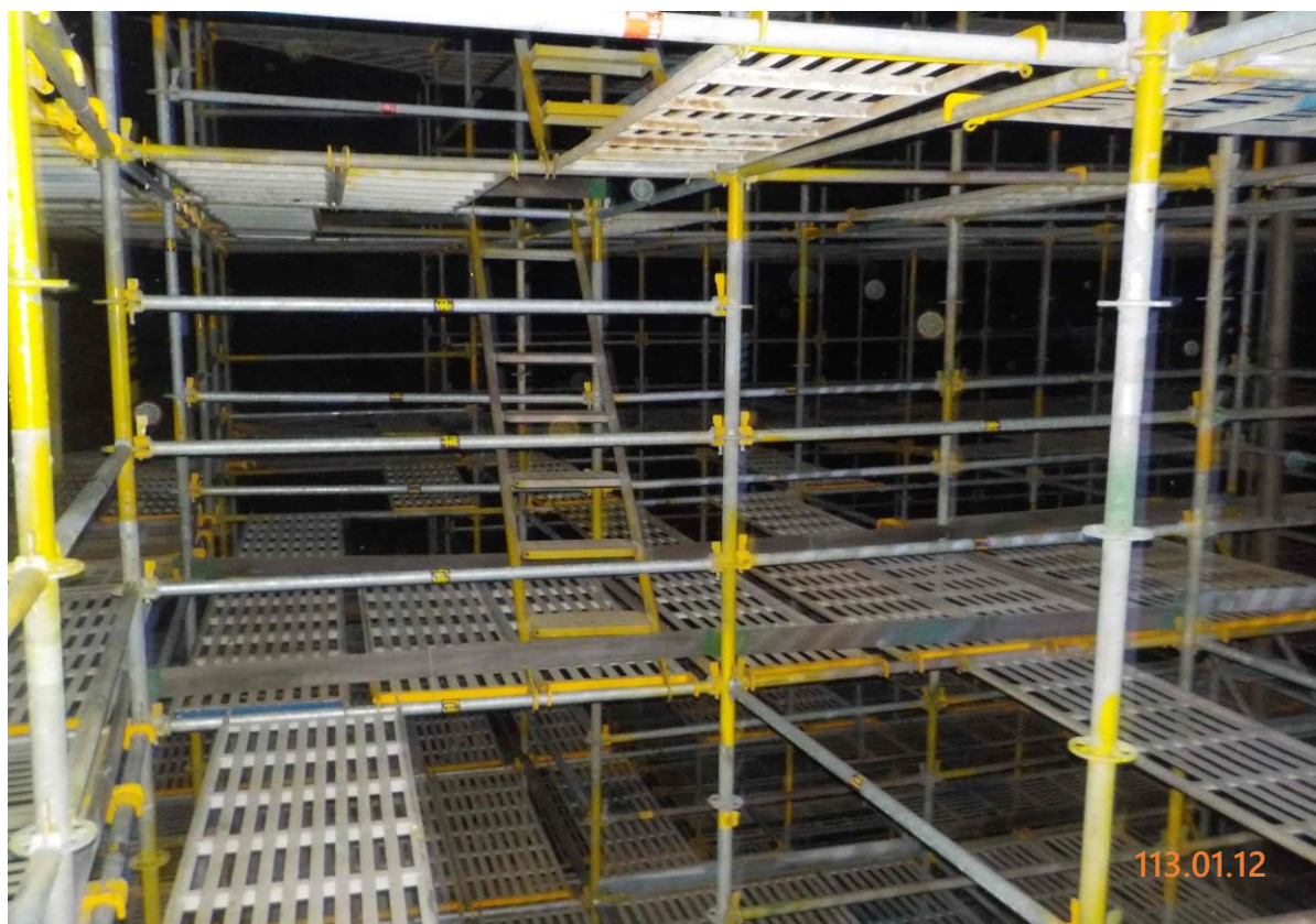
10. 槽內搭架作業情形(2)
