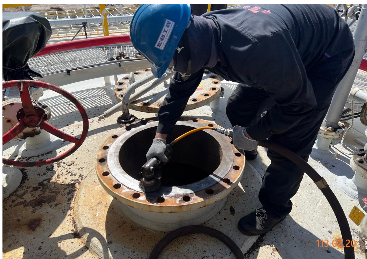
14. 上方人孔復原前法蘭面整理作業
