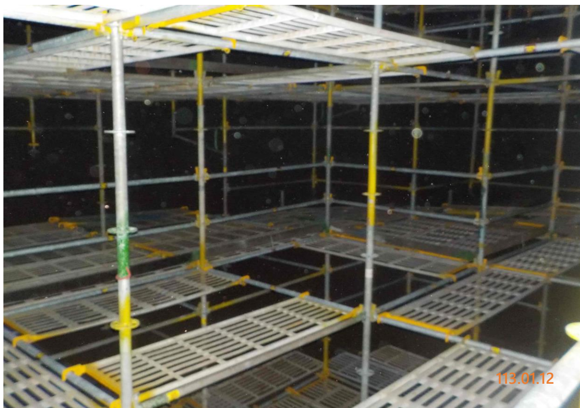
9. 槽內搭架作業情形(1)
