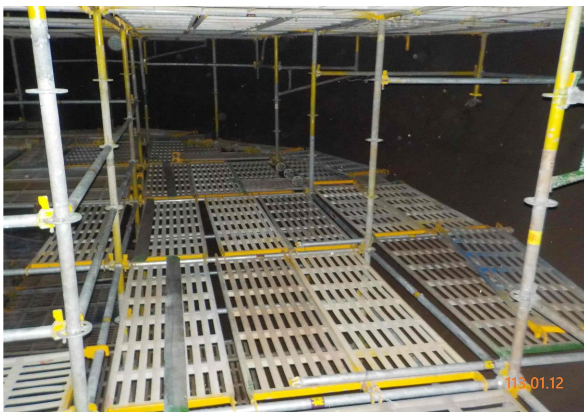
12. 槽內搭架作業情形(4)
