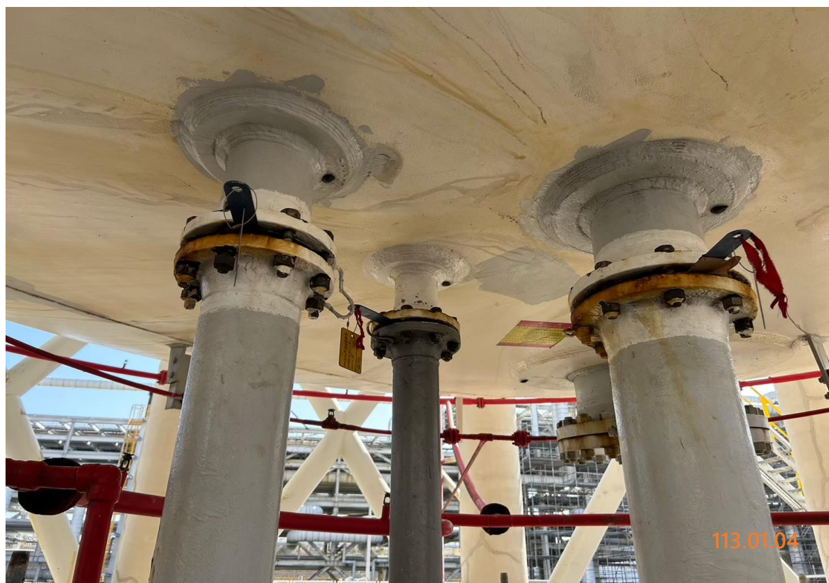
5. 槽底插盲作業
