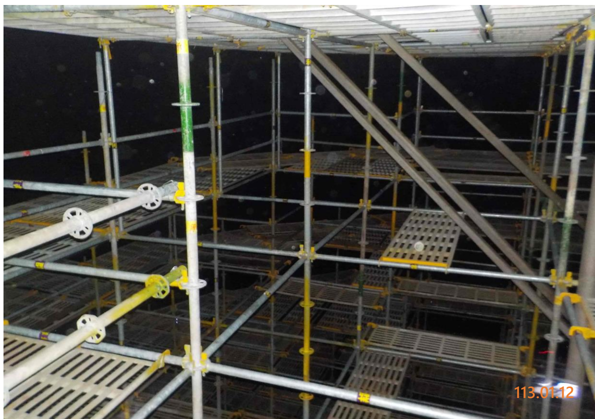
11. 槽內搭架作業情形(3)
