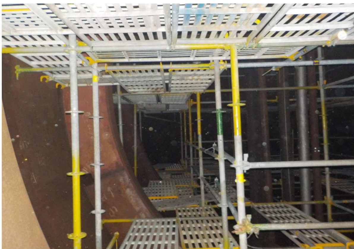
6. 槽內搭架作業情形(3)
