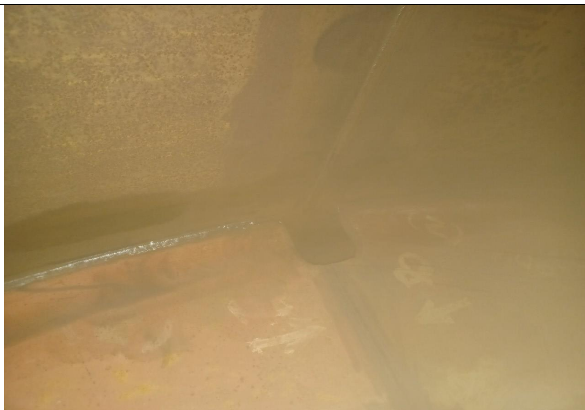
12. 槽內焊道研磨(4)
