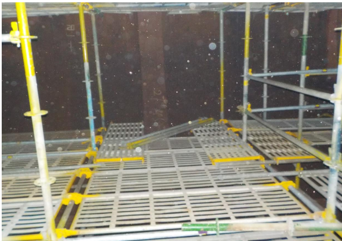
5. 槽內搭架作業情形(2)
