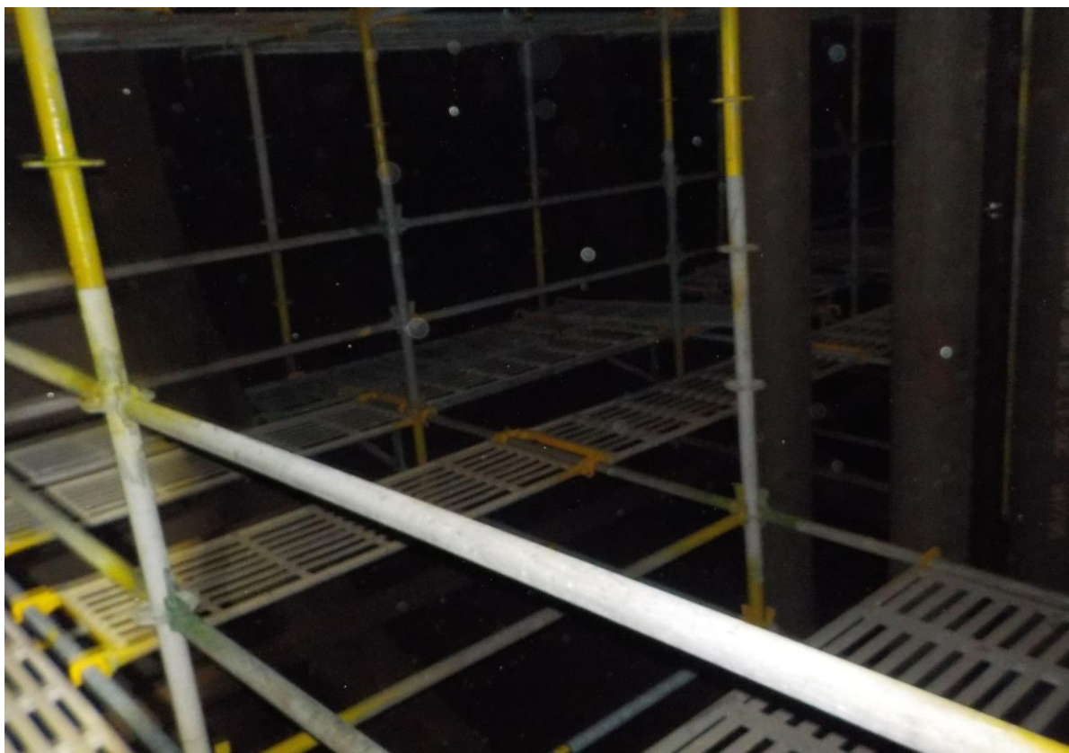
7. 槽內搭架作業情形(4)
