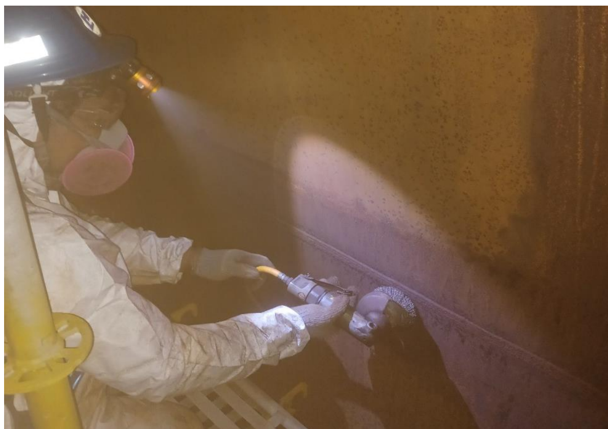
10. 槽內焊道研磨(2)
