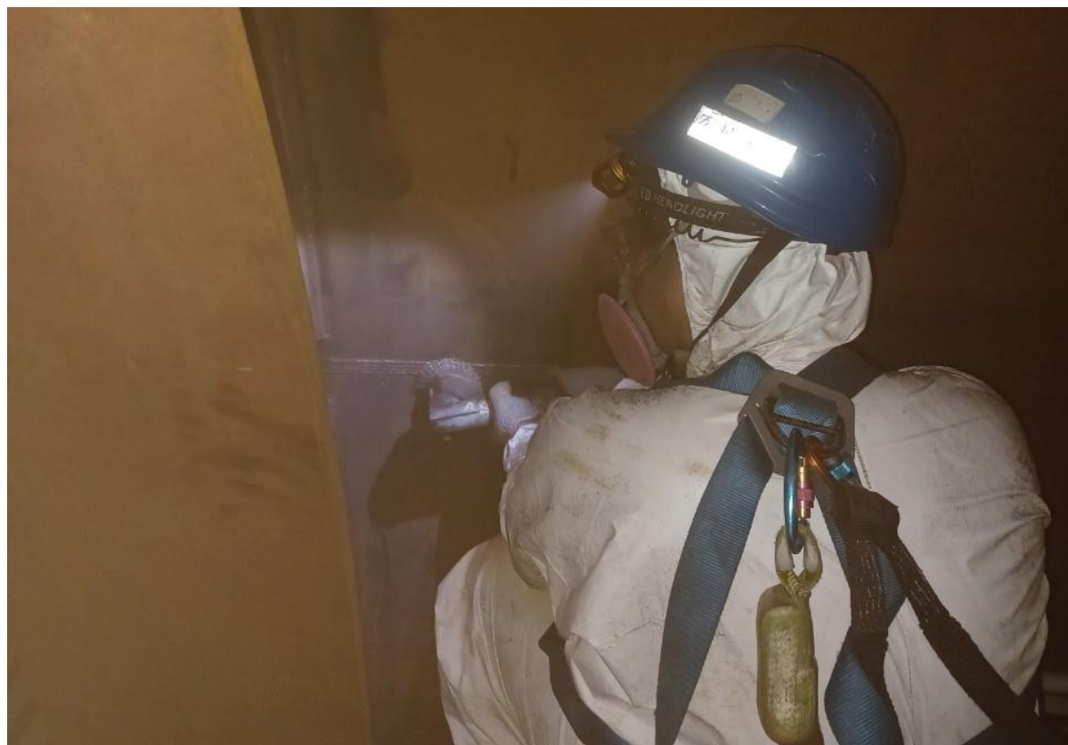
9. 槽內焊道研磨(1)
