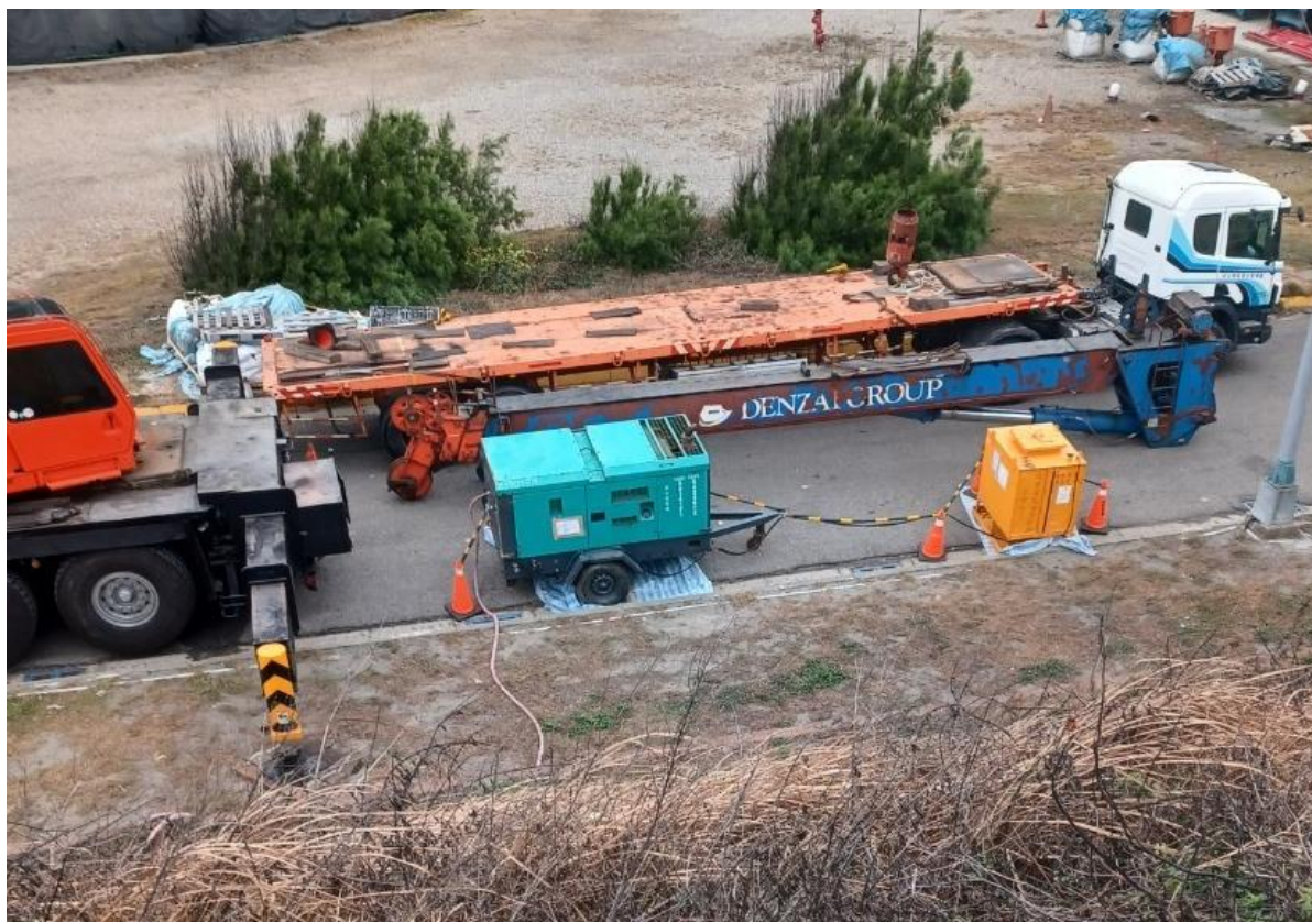
1. 空壓機定位情形
