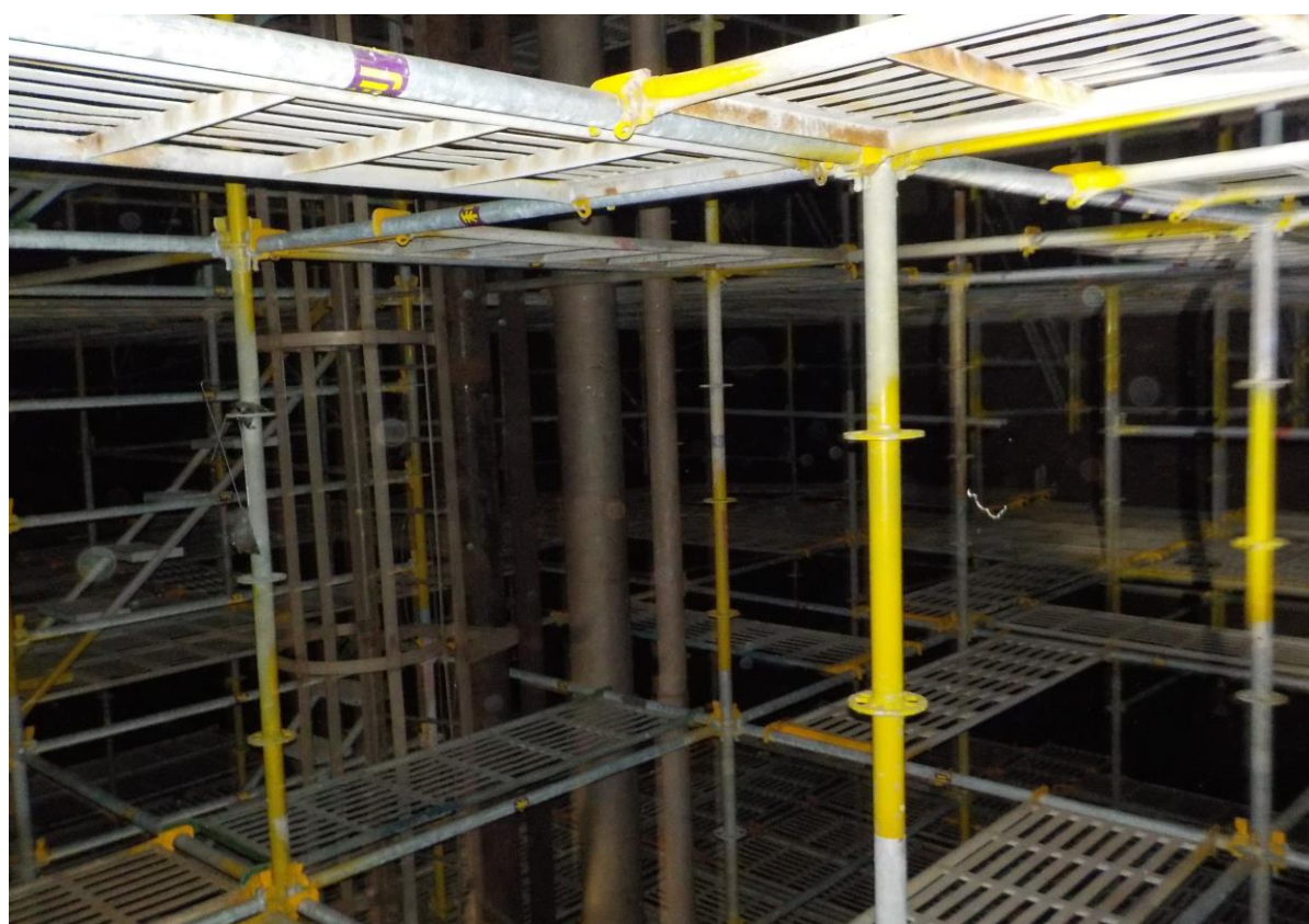
7. 槽內搭架作業情形(3)
