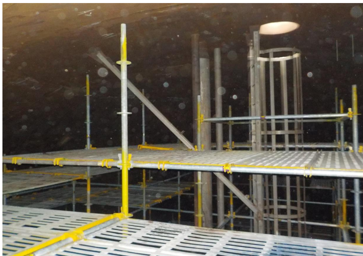
6. 槽內搭架作業情形(2)
