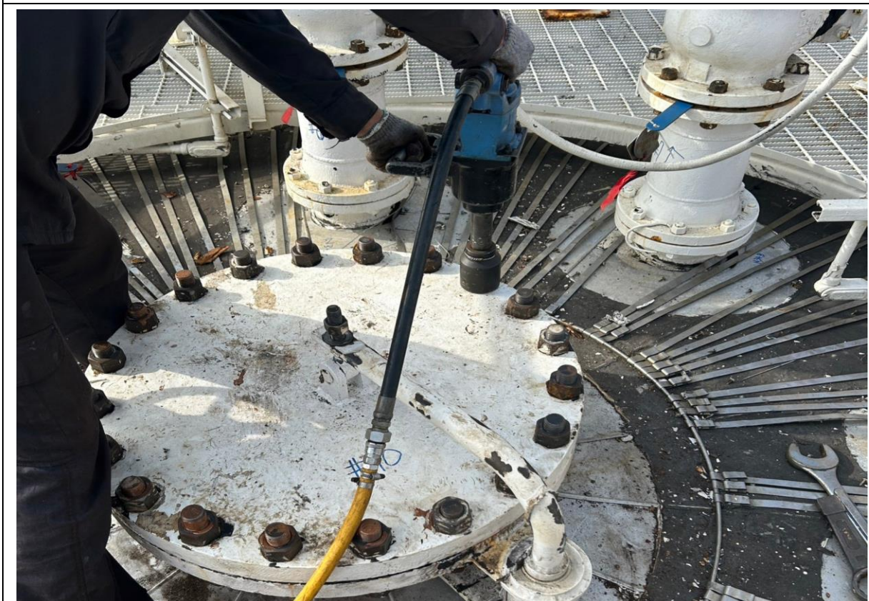
12. 上人孔復原情形
