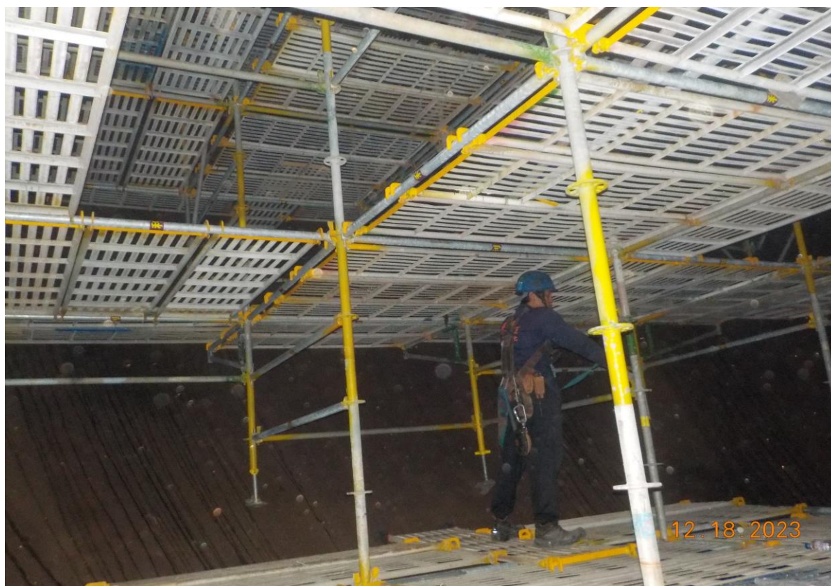
5. 槽內搭架作業情形(1)
