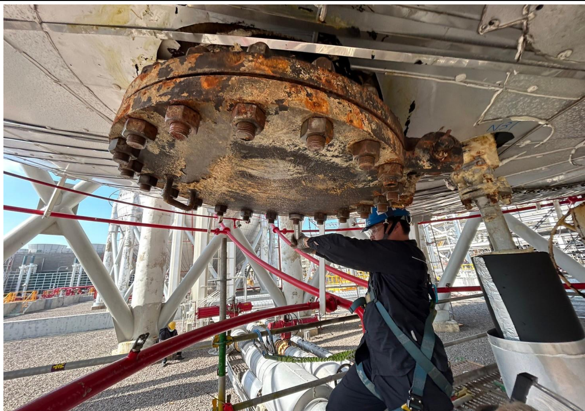
13. 施工完成，人孔復原情形
