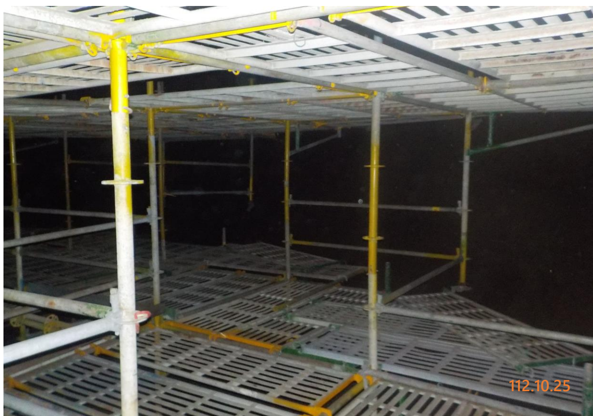
10. 槽內搭架作業情形(2)
