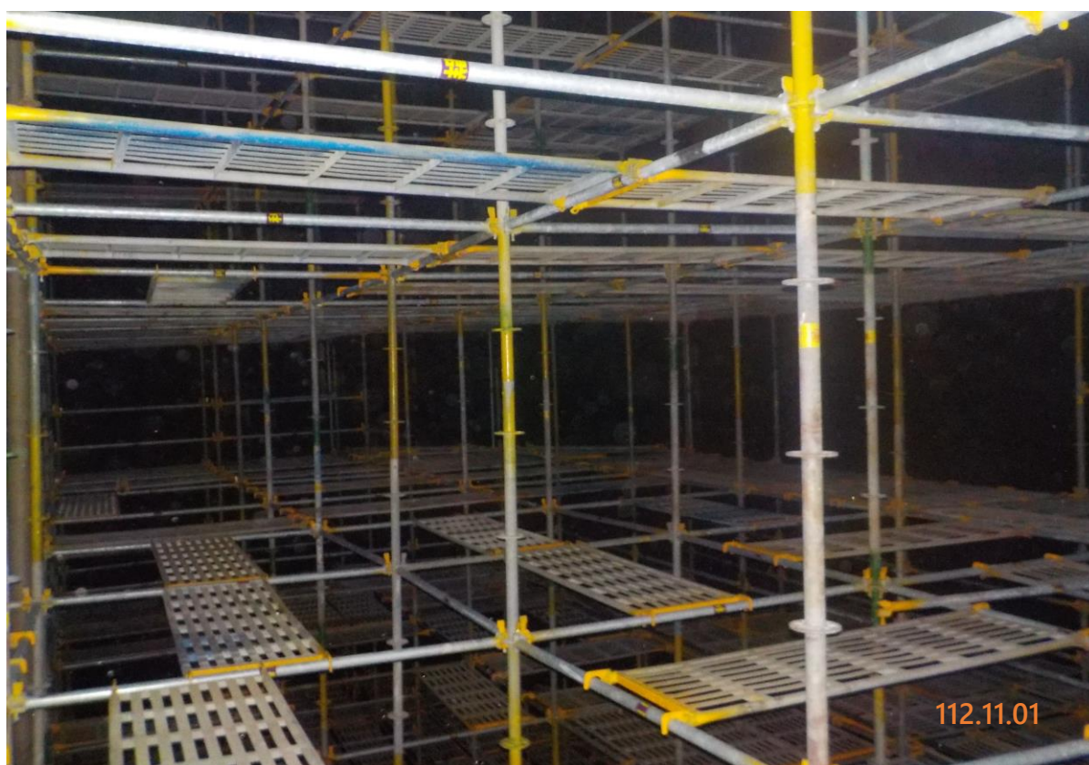
12. 槽內搭架作業情形(4)
