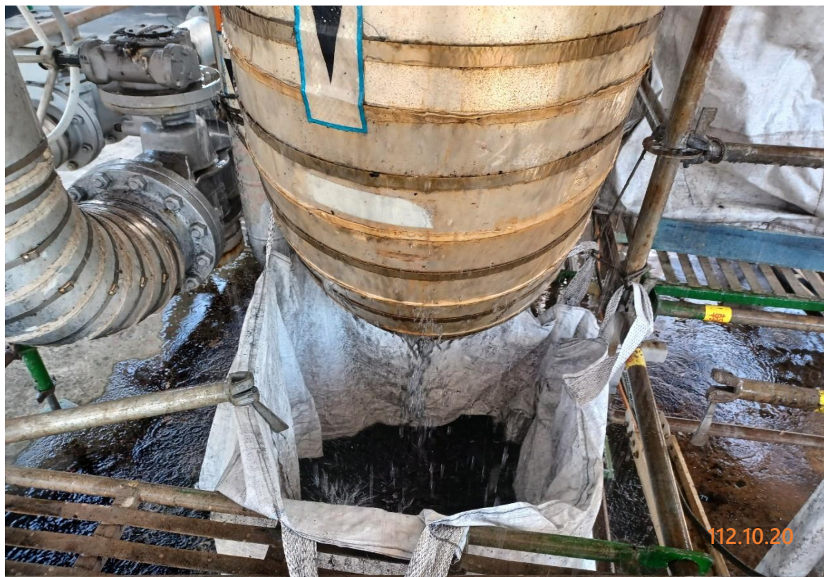
7. 下方人孔太空袋承接情形
