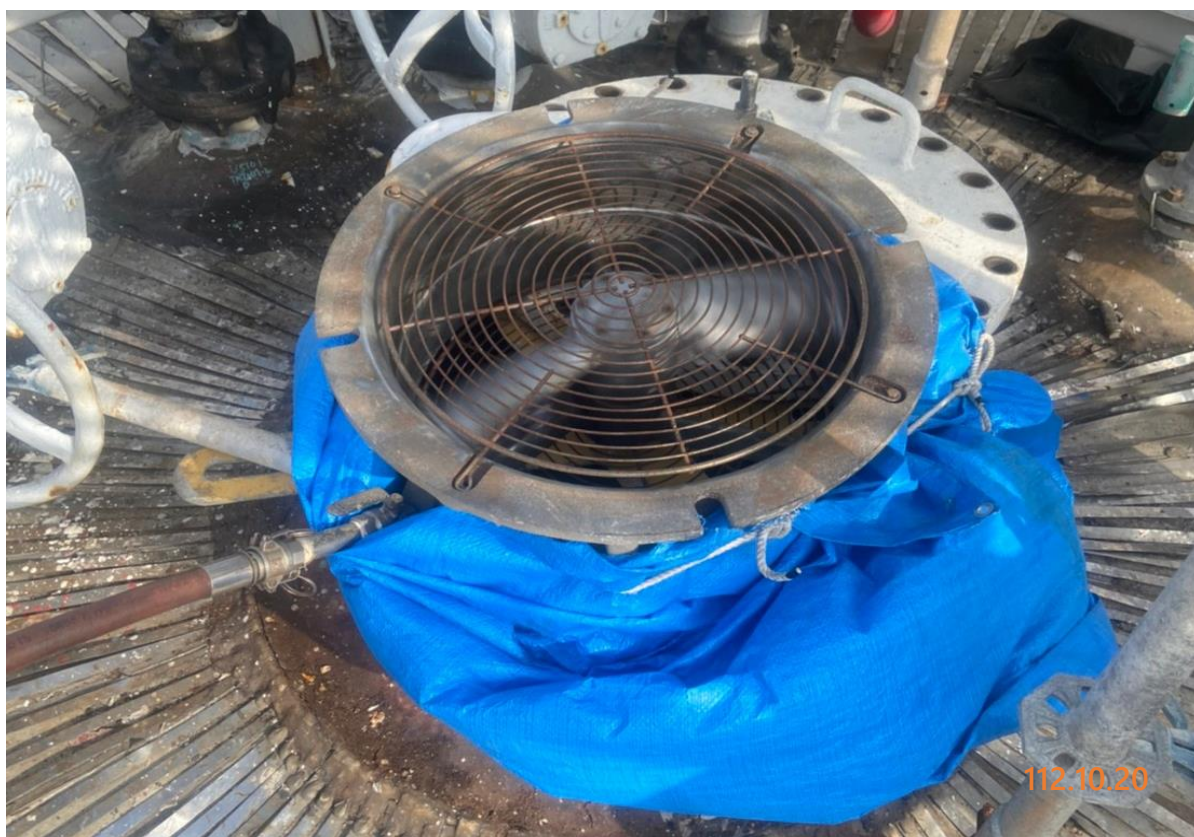
8. 上人孔通風設備及帆布鋪設情形
