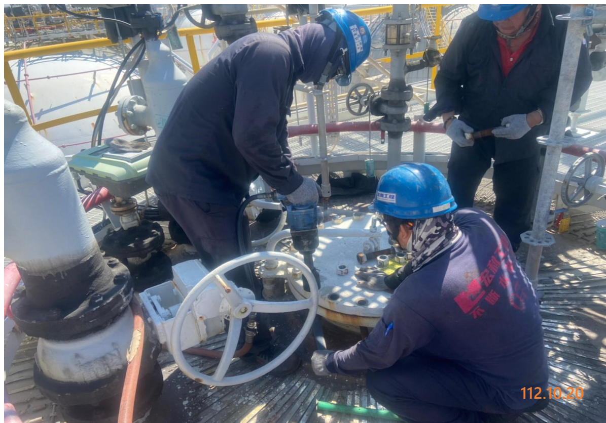
5. 人員開人孔作業
