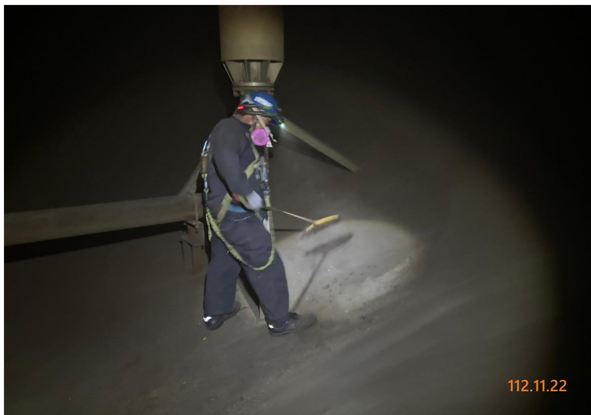
13. 槽內清掃作業
