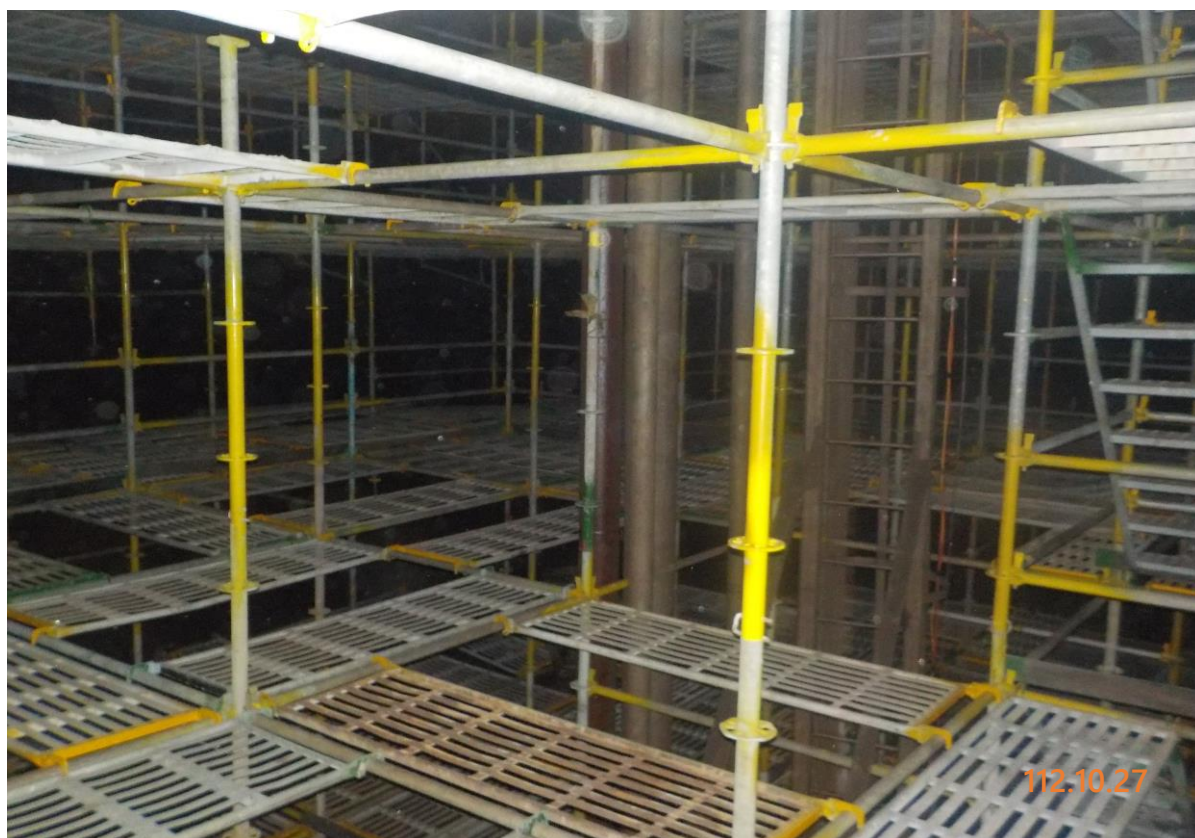
11. 槽內搭架作業情形(3)
