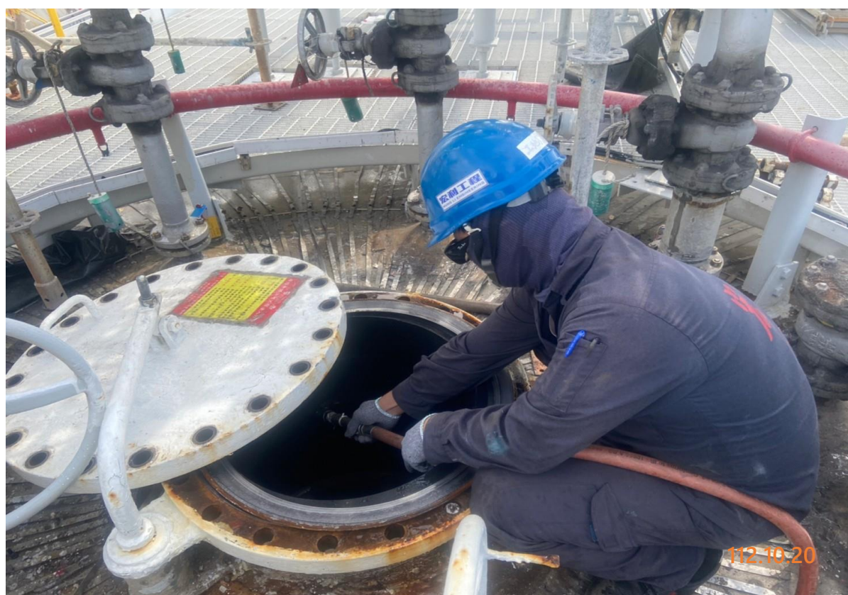
6. 槽內水洗情形
