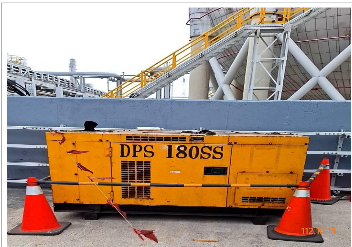
1. 空壓機定位情形
