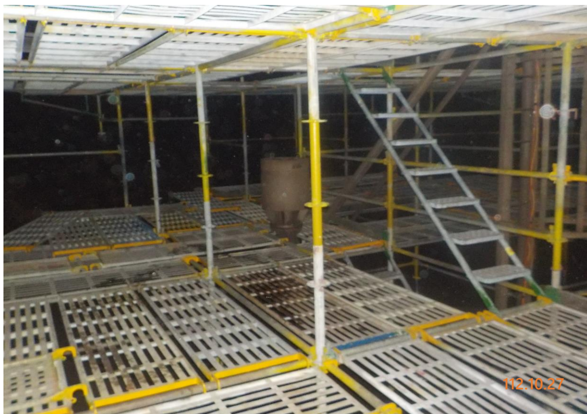
9. 槽內搭架作業情形(1)
