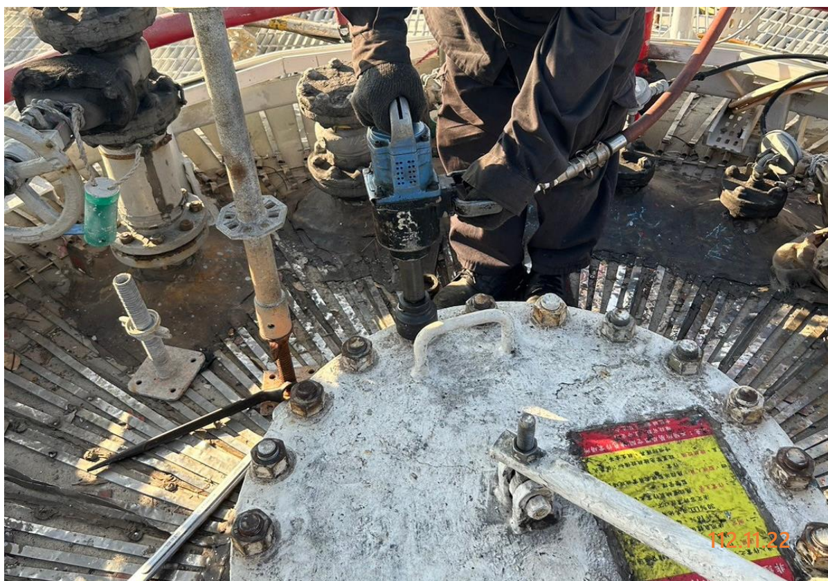
14. 上方人孔復原作業
