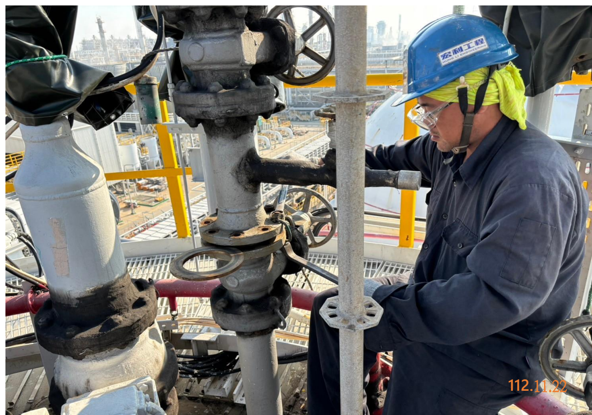
16. 管線抽盲作業(2)
