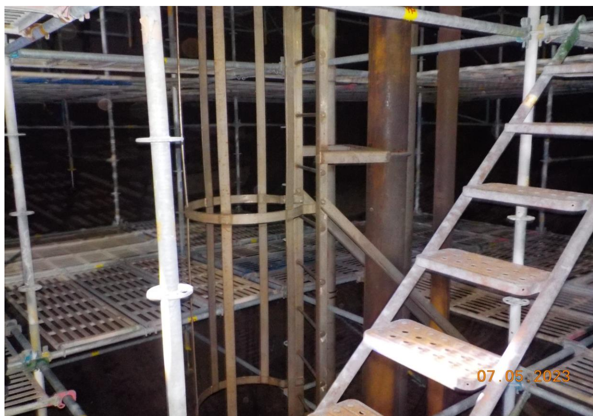
8. 槽內搭架作業情形(4)
