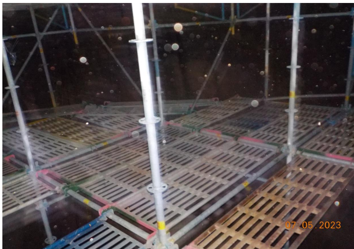
7. 槽內搭架作業情形(3)
