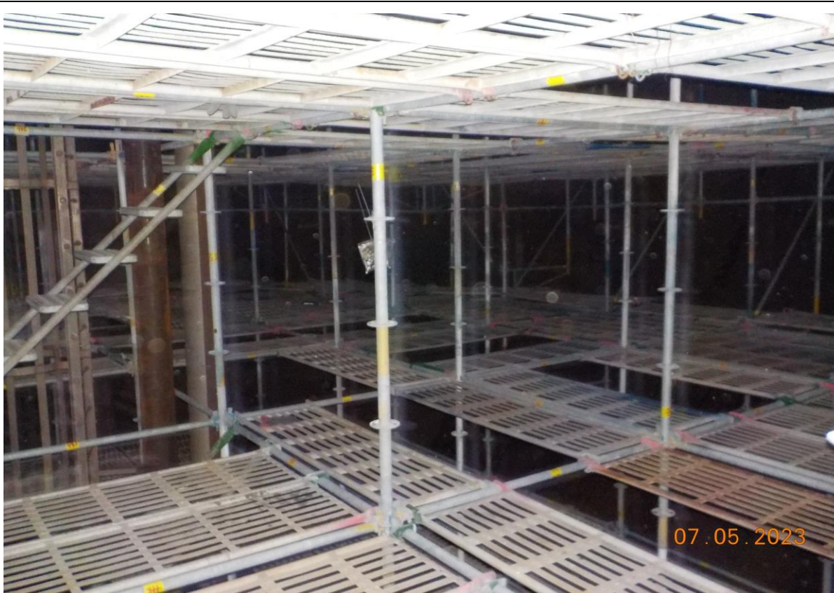
6. 槽內搭架作業情形(2)
