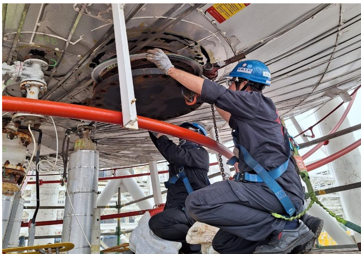
14. 人孔復原作業
