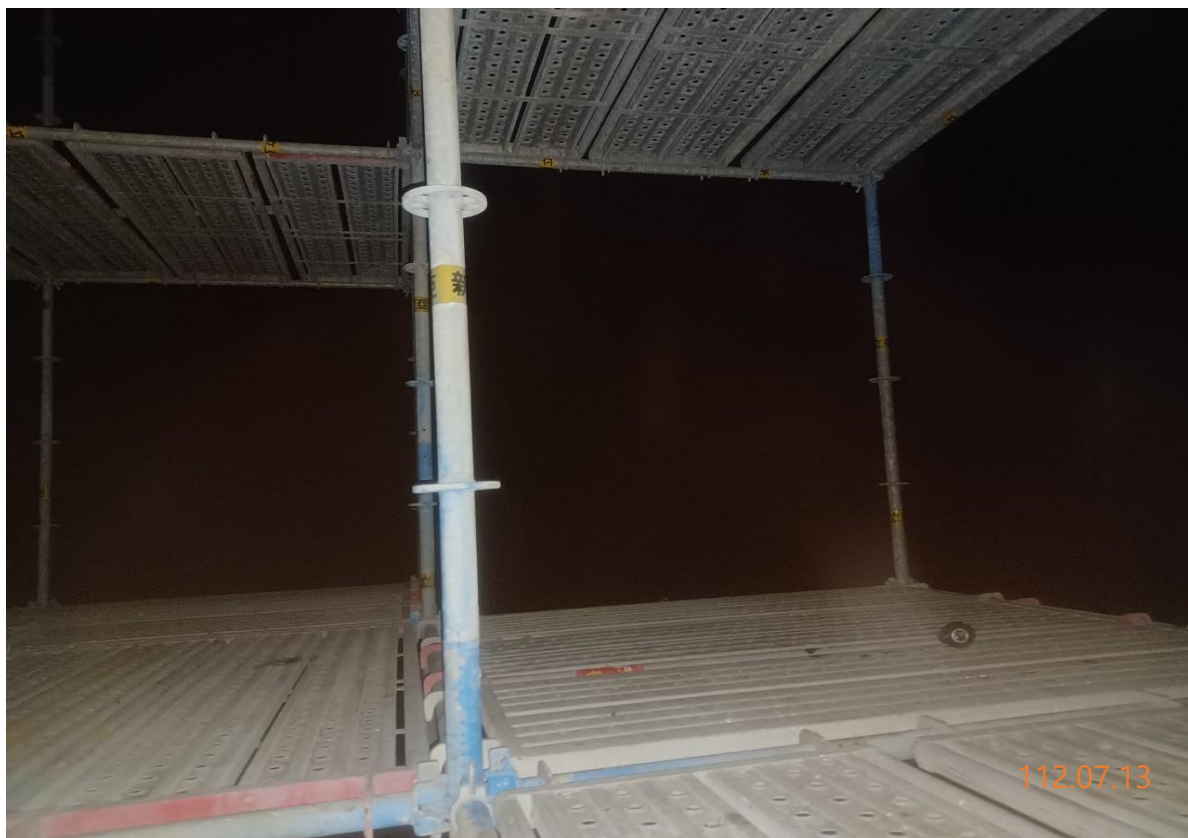
9. 槽內搭架作業情形(1)
