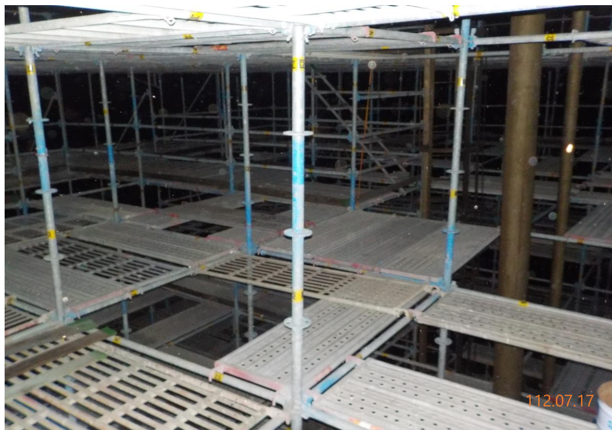
11. 槽內搭架作業情形(3)
