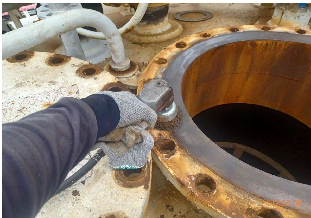
14. 上方人孔復原前法蘭面整理作業
