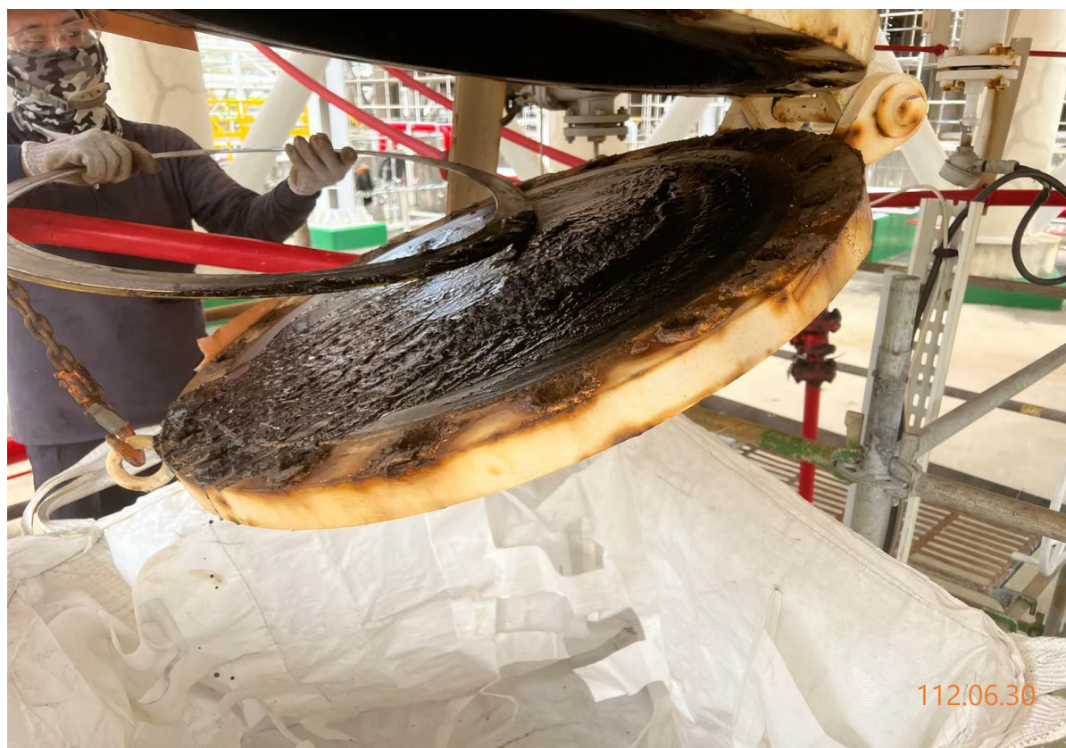
5. 人員開人孔作業
