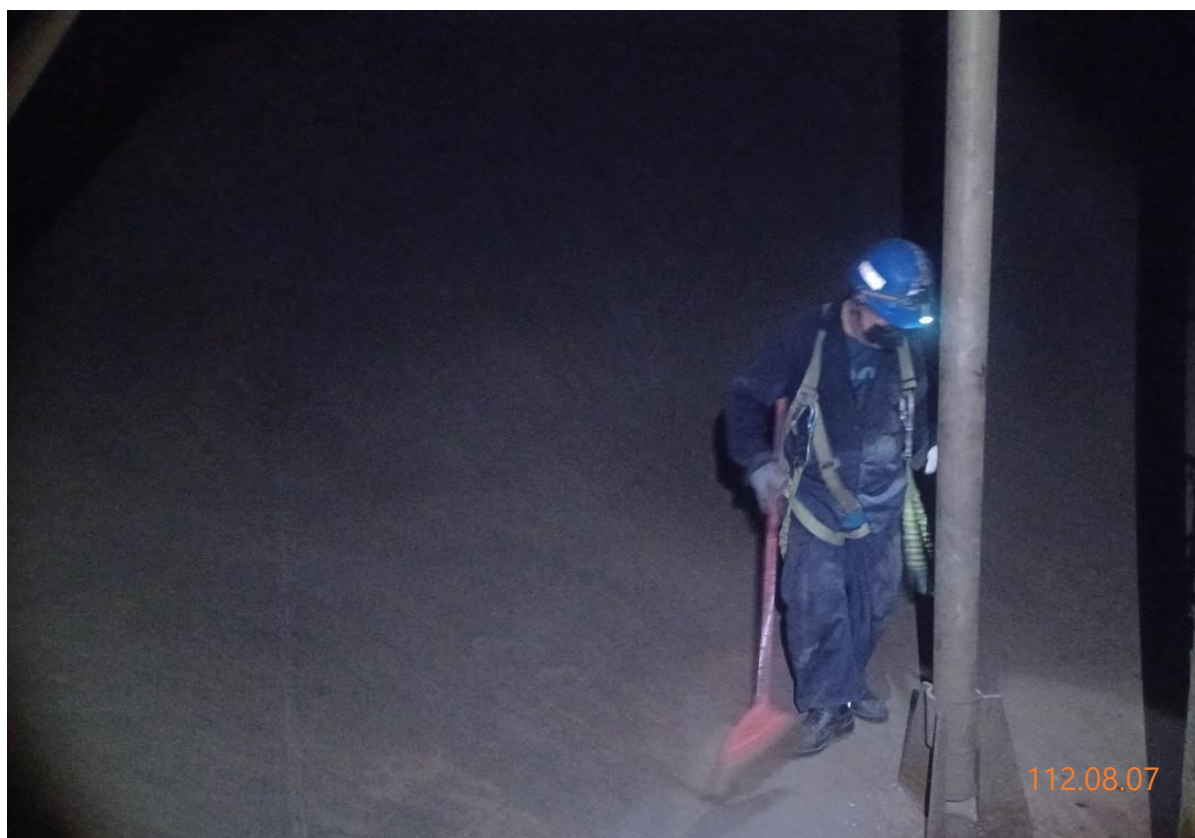
13. 槽內清掃作業
