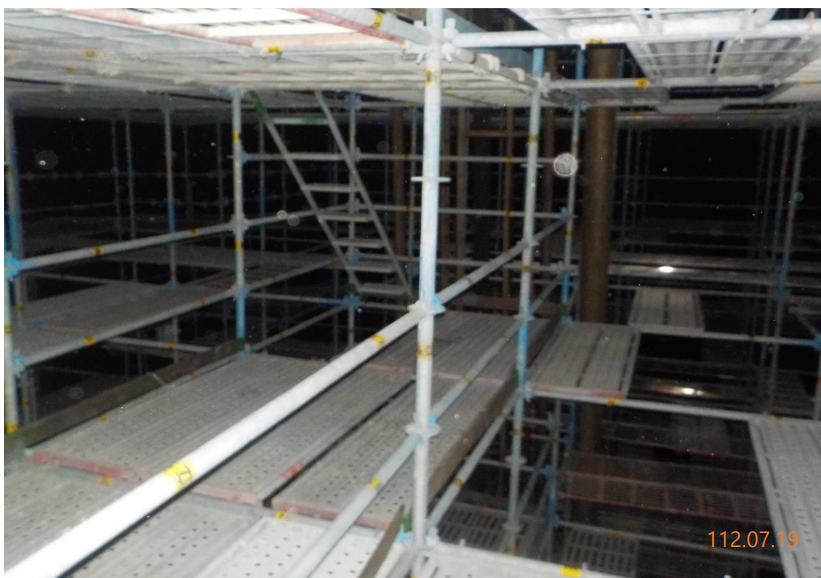
12. 槽內搭架作業情形(4)
