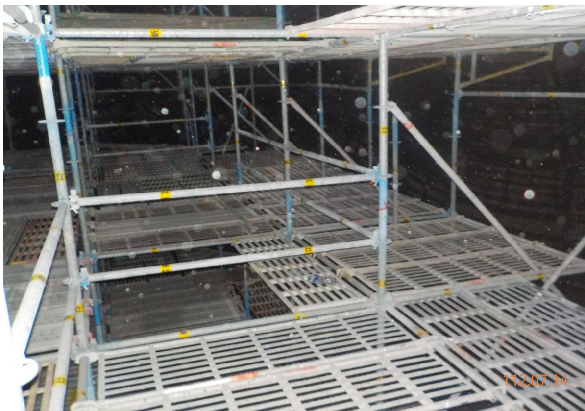
10. 槽內搭架作業情形(2)
