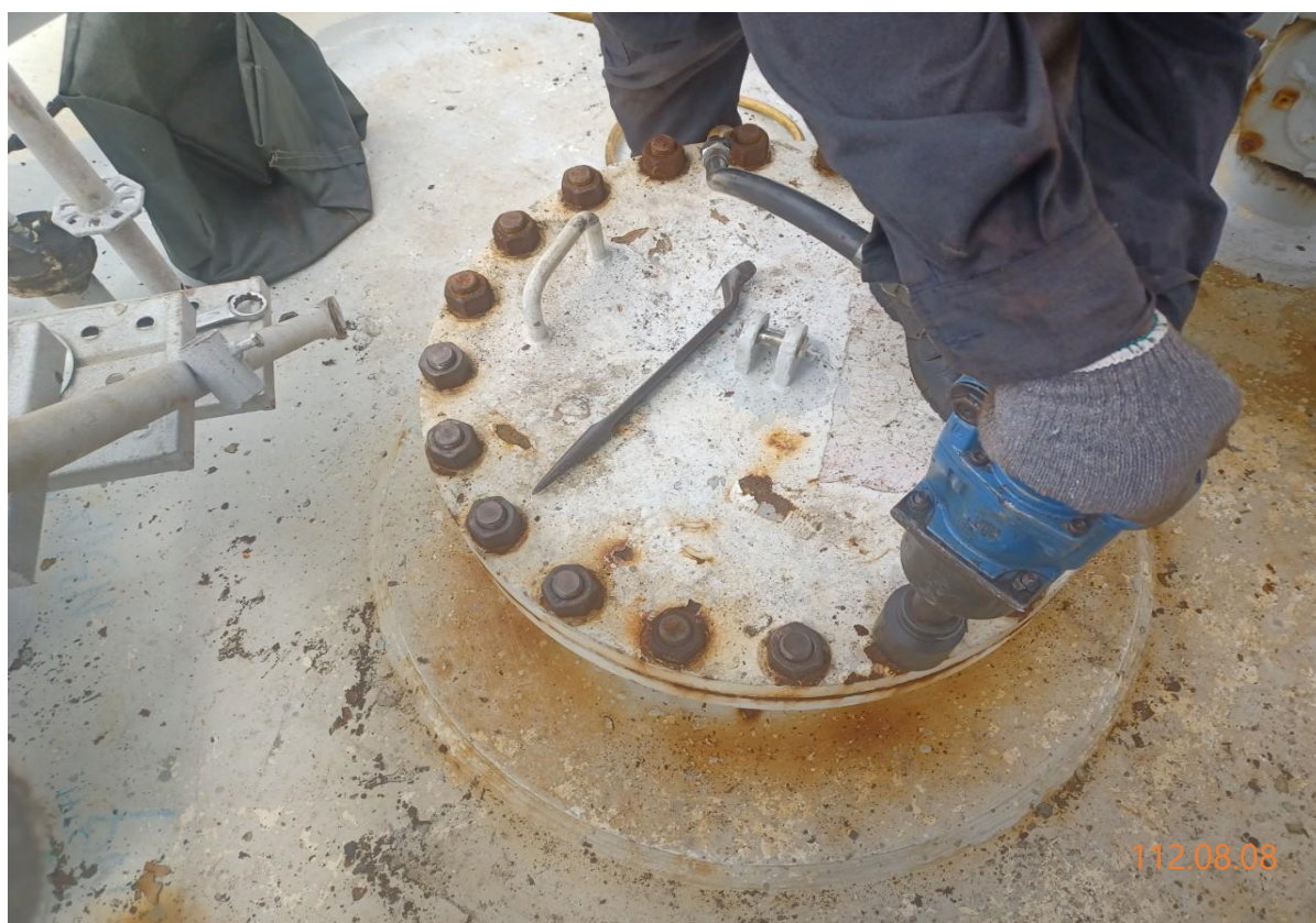
16. 上方人孔復原作業
