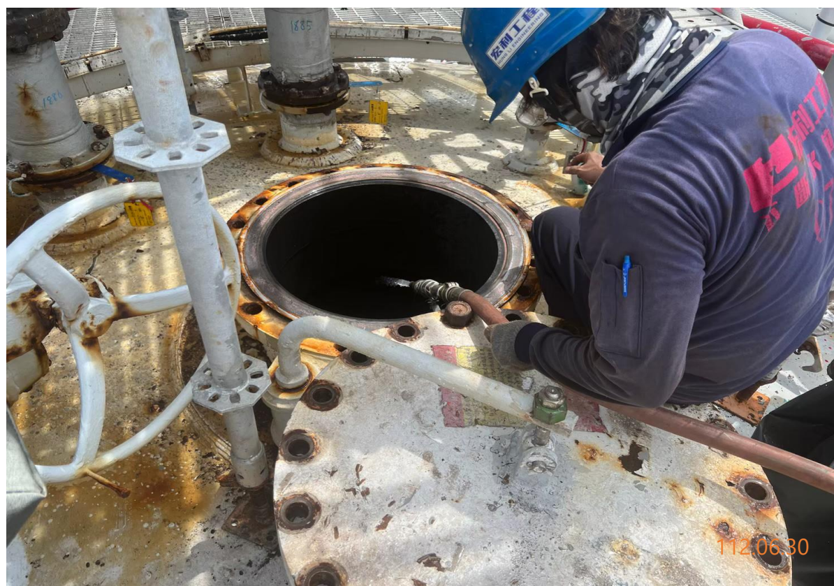
6. 槽內水洗情形
