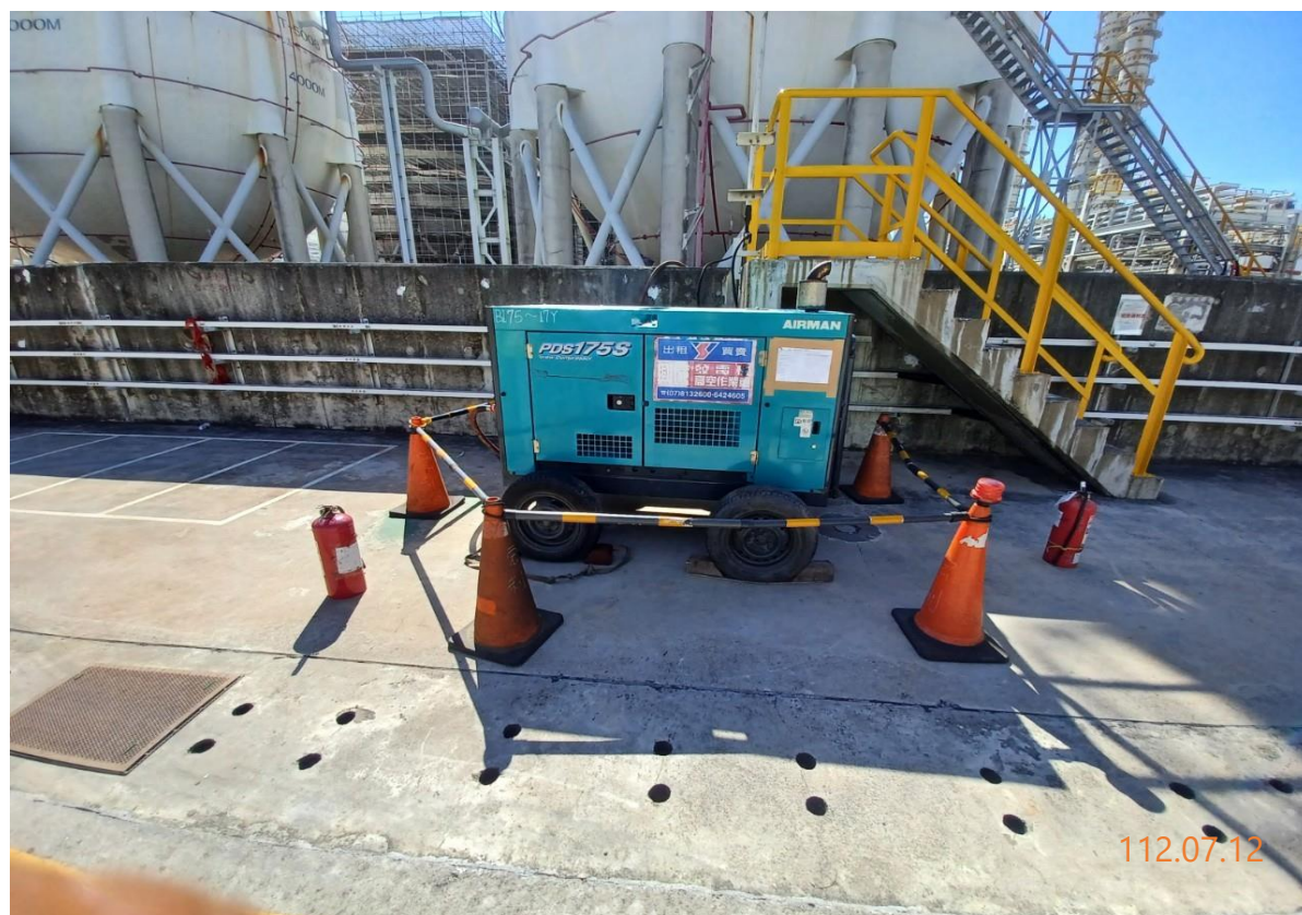
1. 空壓機定位情形
