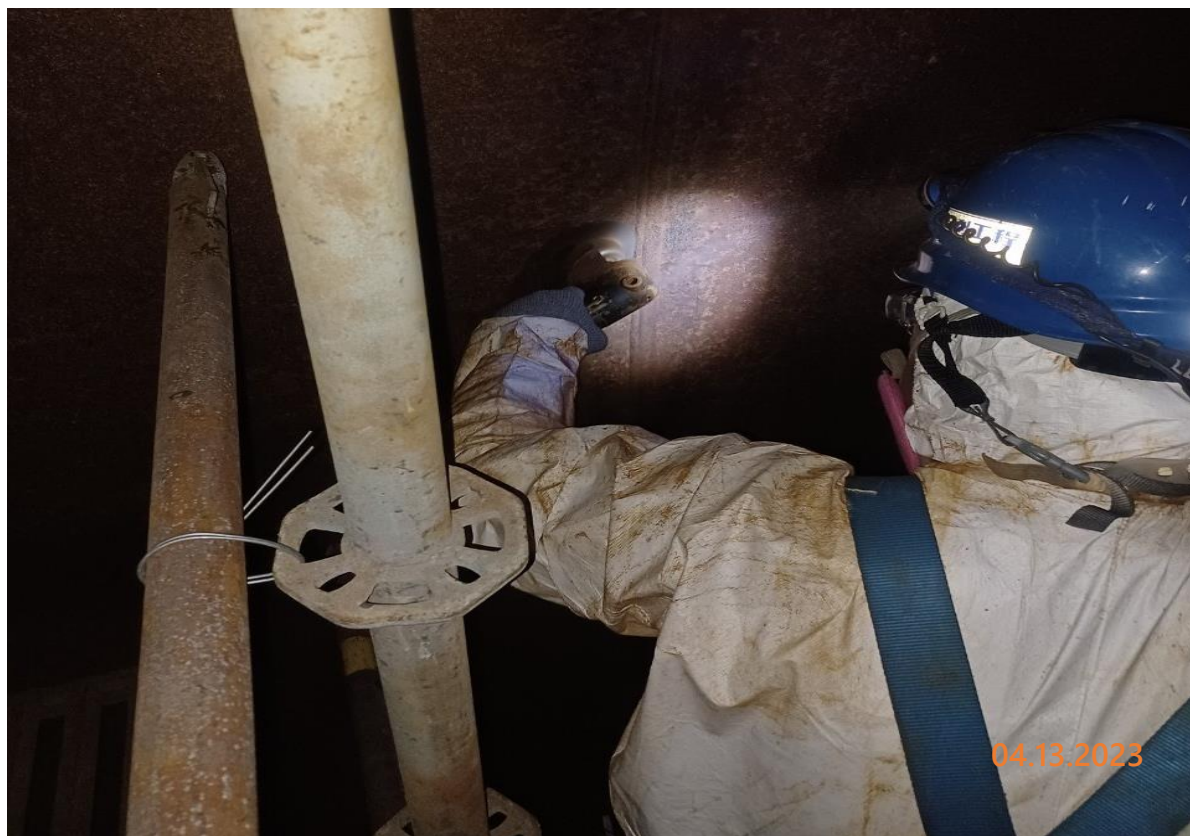
13. 槽內焊道研磨作業(2)
