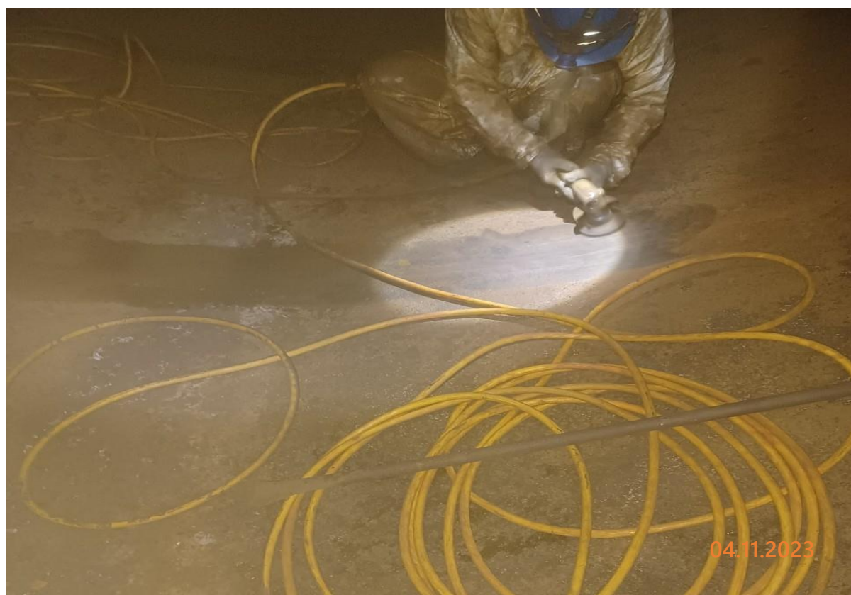
12. 槽內焊道研磨作業(1)
