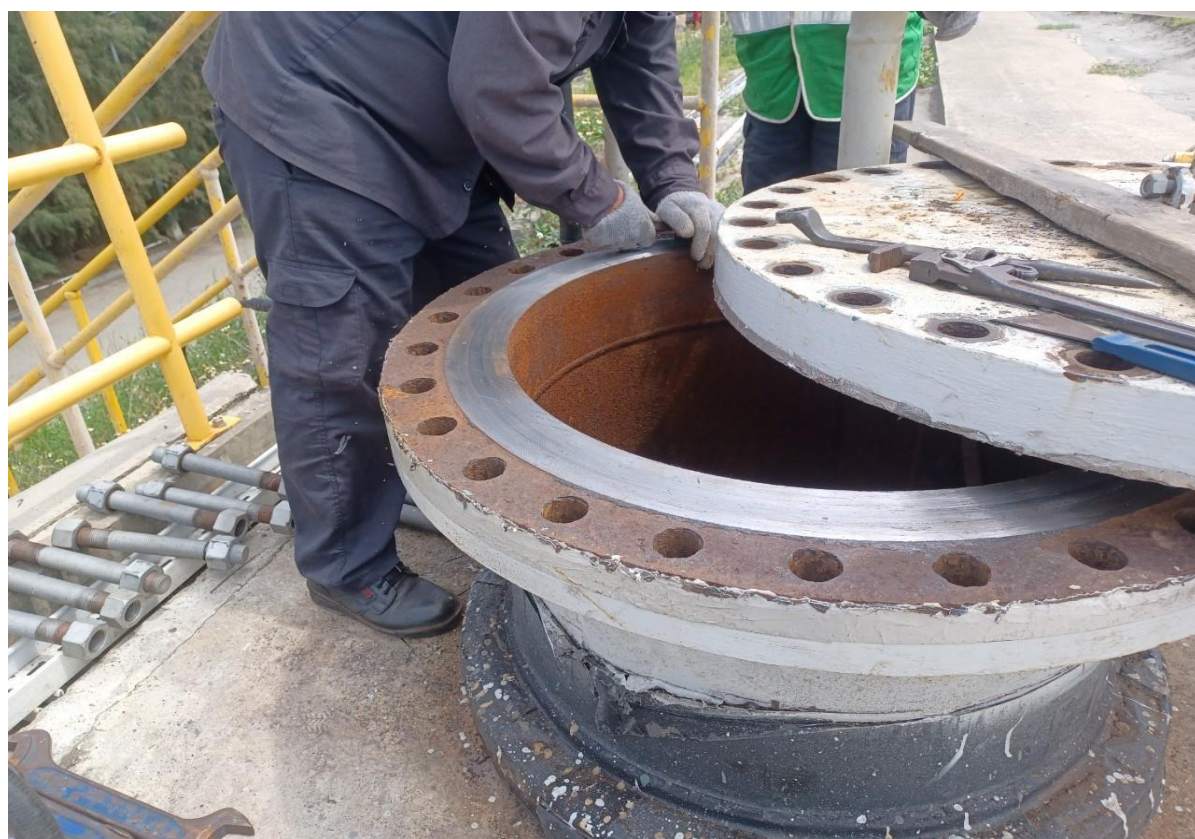
16. 人孔復原前法蘭面整理
