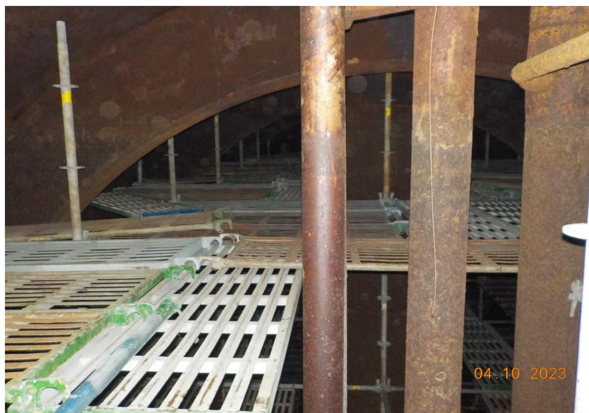
6. 槽內搭架情形(2)
