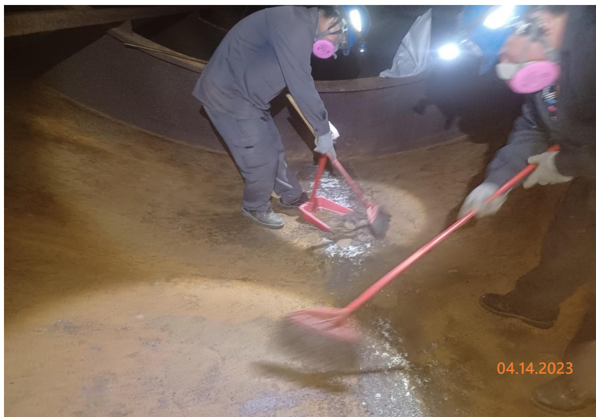
15. 人員槽內清掃(2)
