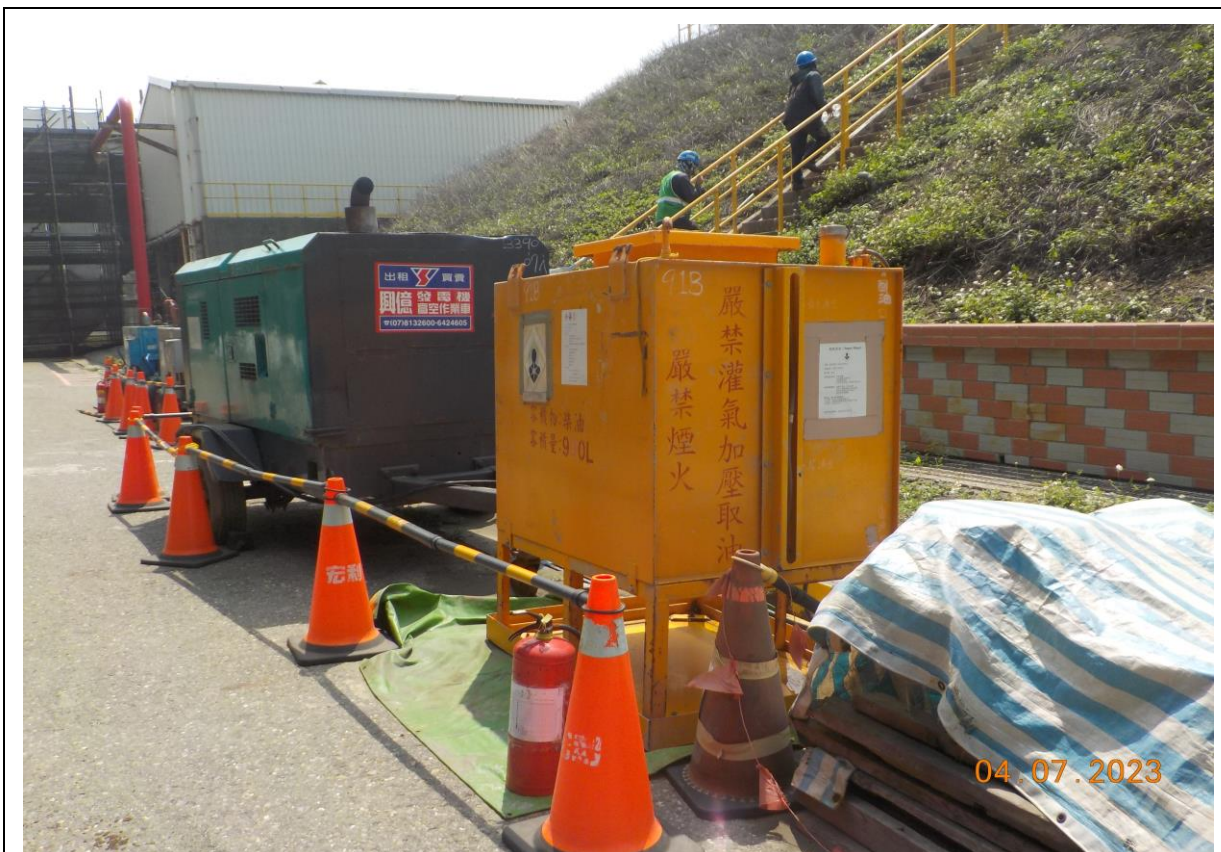
3. 空壓機定位情形
