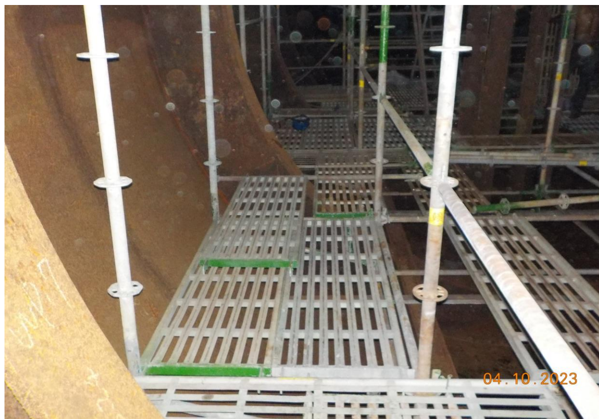
7. 槽內搭架情形(3)
