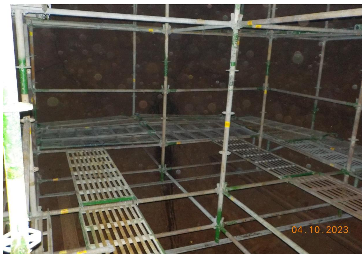
8. 槽內搭架情形(4)
