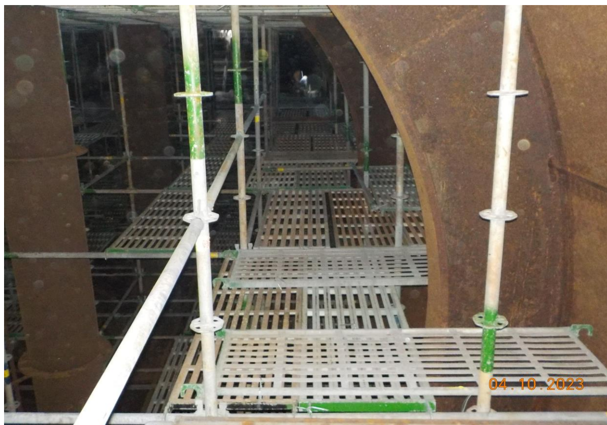
5. 槽內搭架情形(1)
