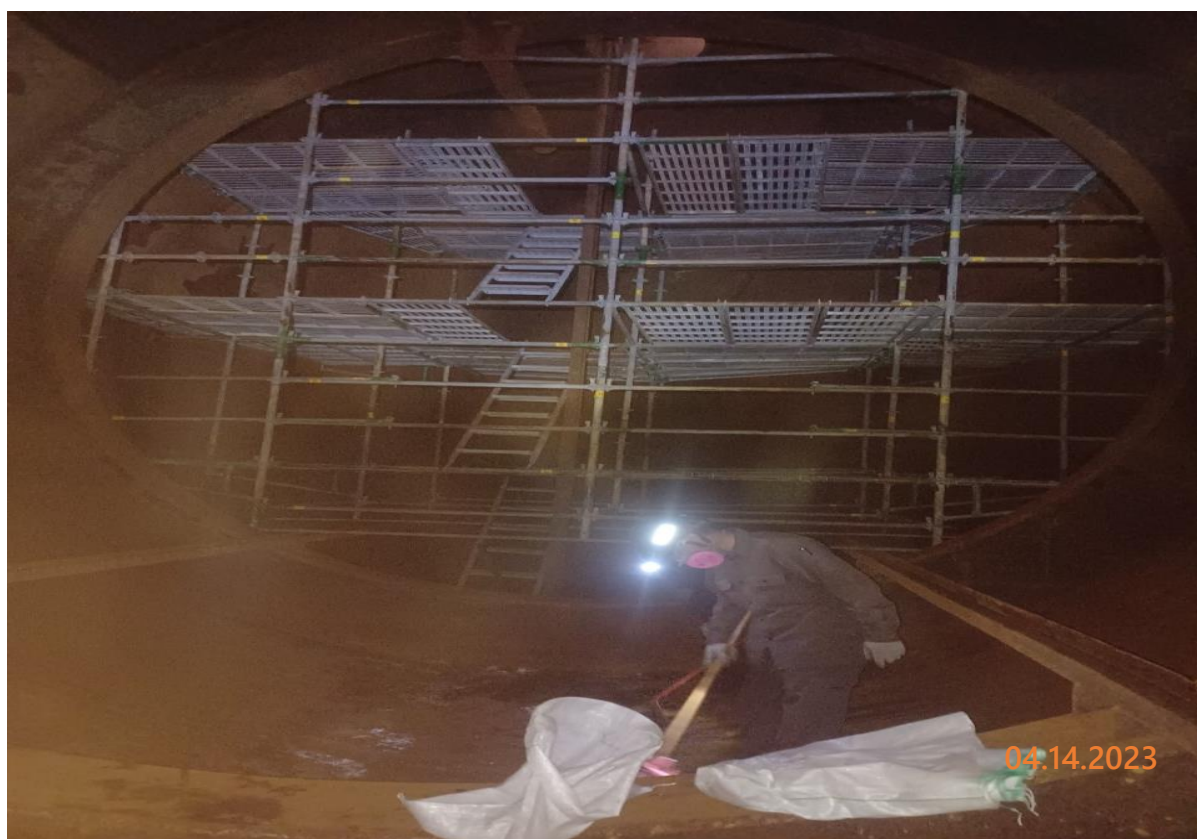
14. 人員槽內清掃(1)
