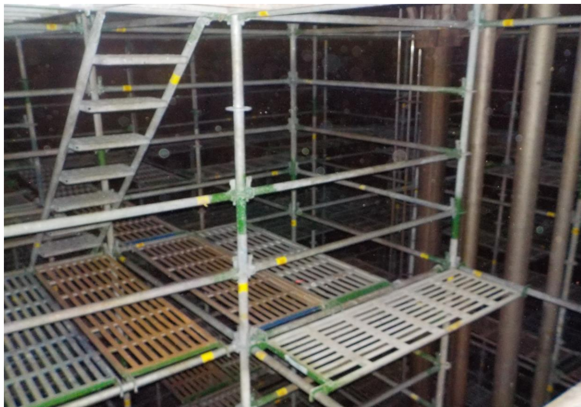
7. 槽內搭架作業情形(3)
