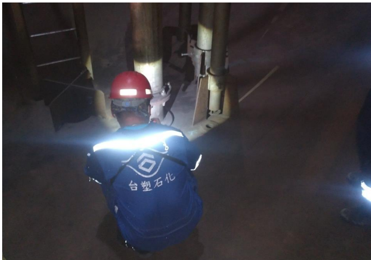
9. 槽內清掃後人員檢查清掃狀況
