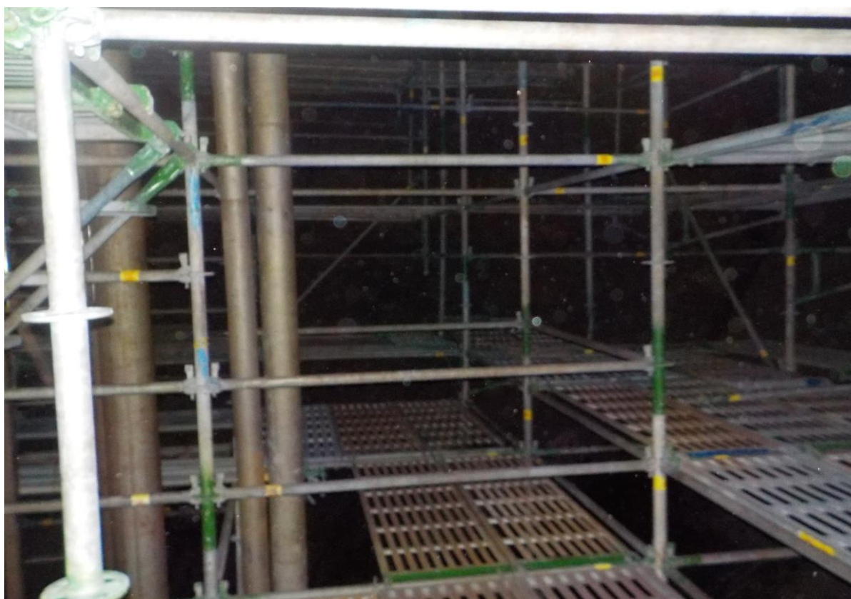
6. 槽內搭架作業情形(2)
