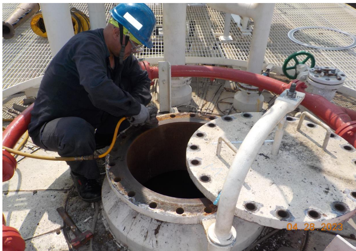
10. 人孔復原前法蘭面整理
