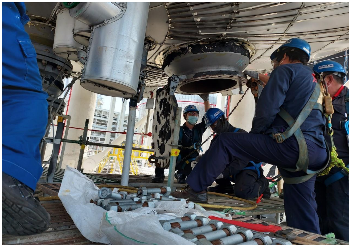
11.人孔復原作業
