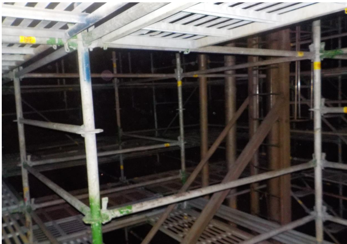
5. 槽內搭架作業情形(1)
