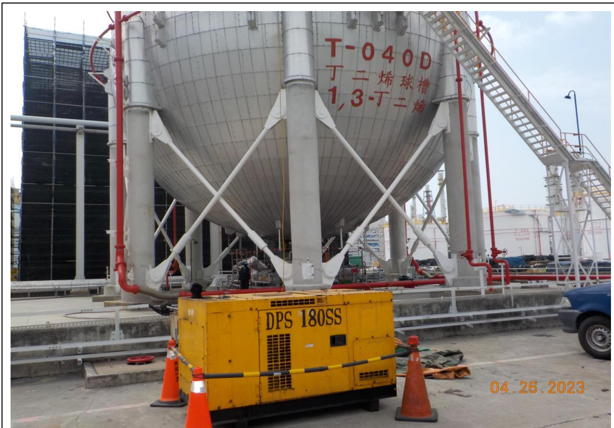
3. 空壓機定位情形
