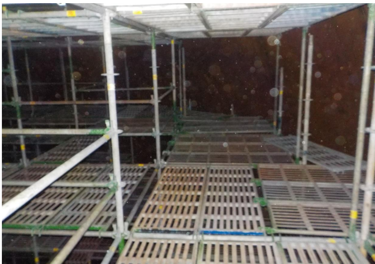
8. 槽內搭架作業情形(4)
