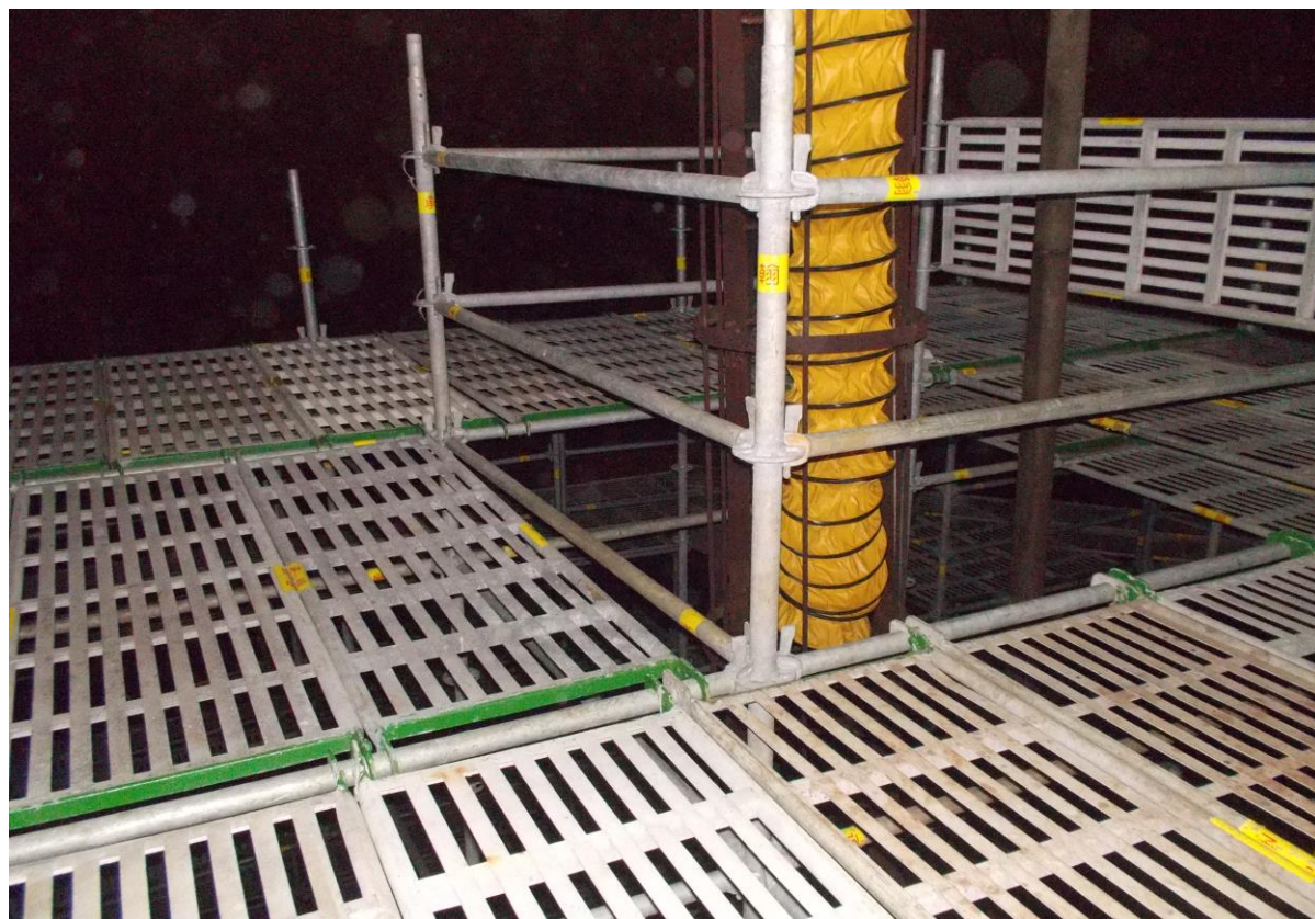
7. 槽內搭架作業情形(3)
