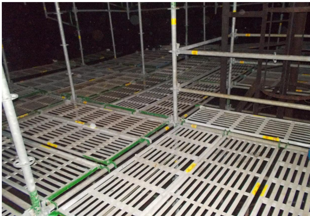
5. 槽內搭架作業情形(1)
