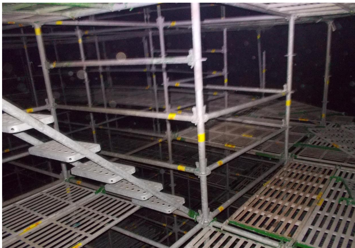
6. 槽內搭架作業情形(2)
