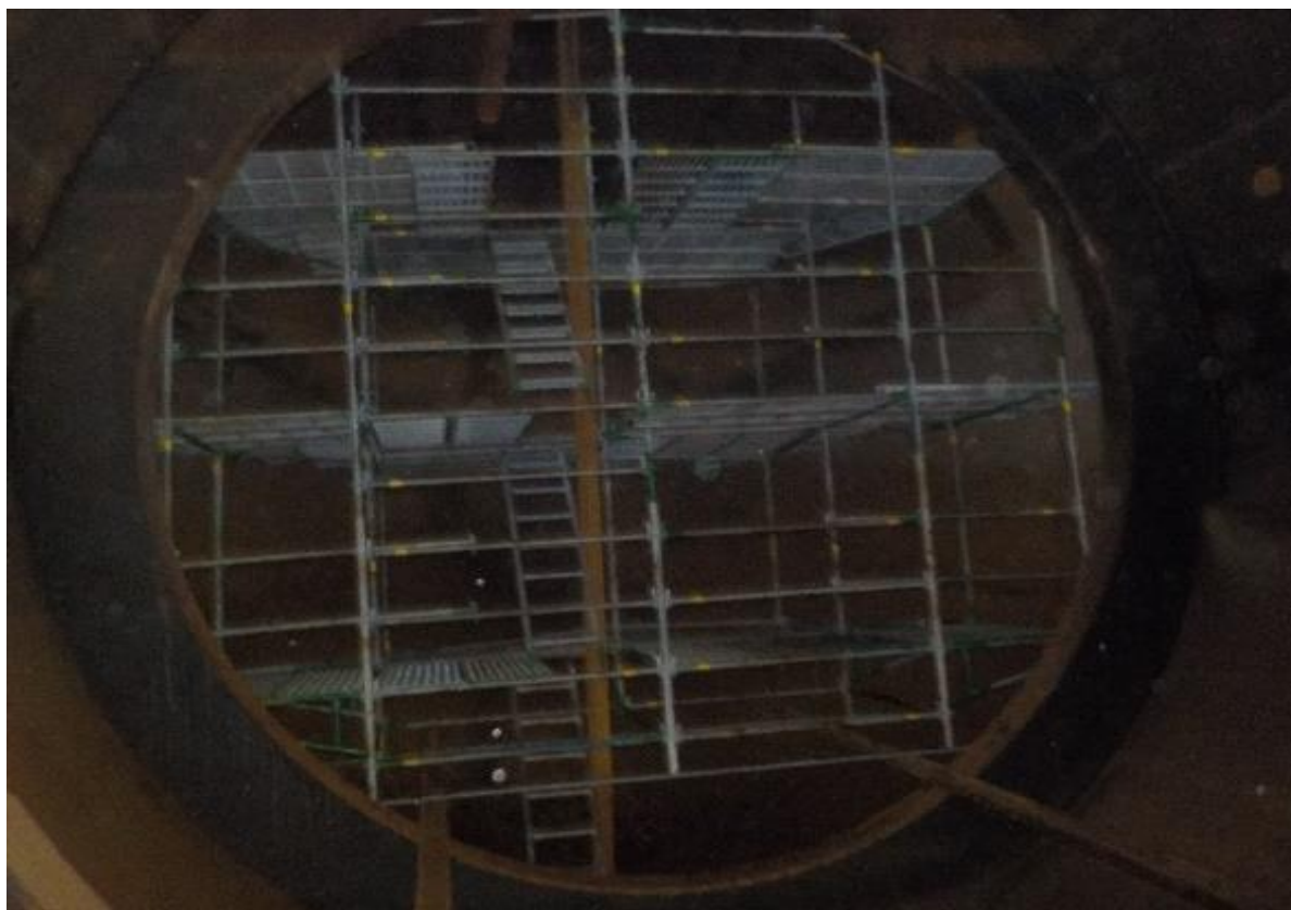
7. 槽內搭架作業情形(3)
