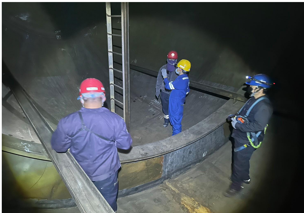
9. 槽內清掃後人員檢查清掃狀況
