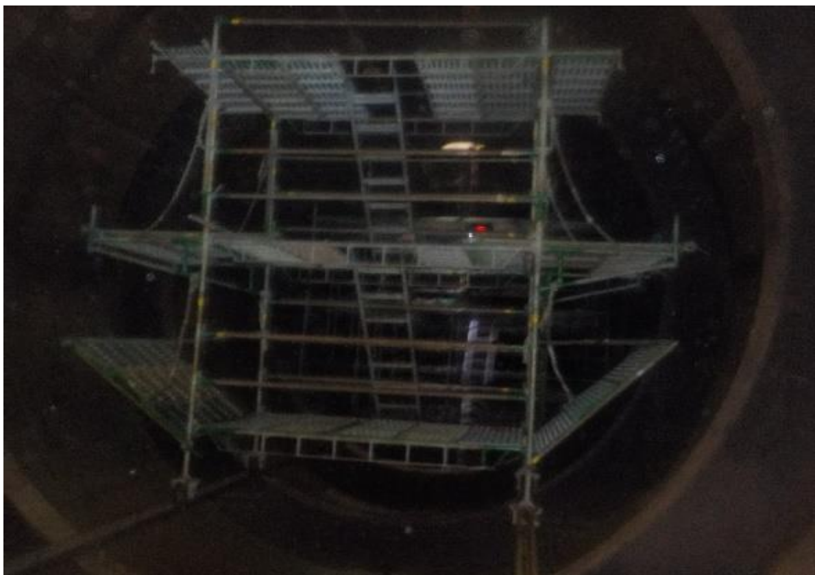
5. 槽內搭架作業情形(1)
