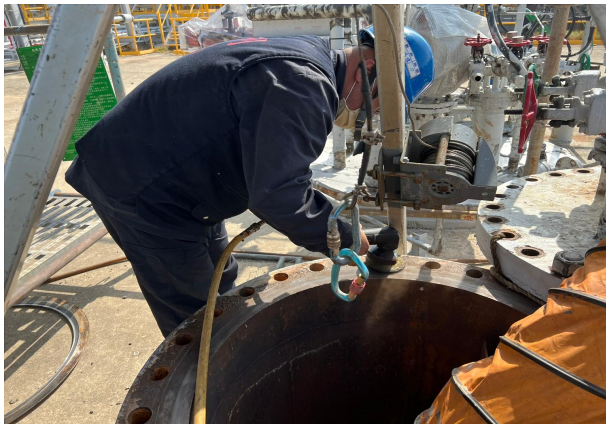
11.人孔復原前法蘭面整理
