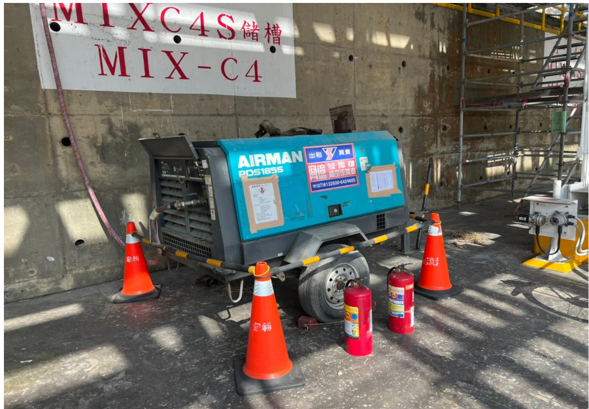
3. 空壓機定位情形
