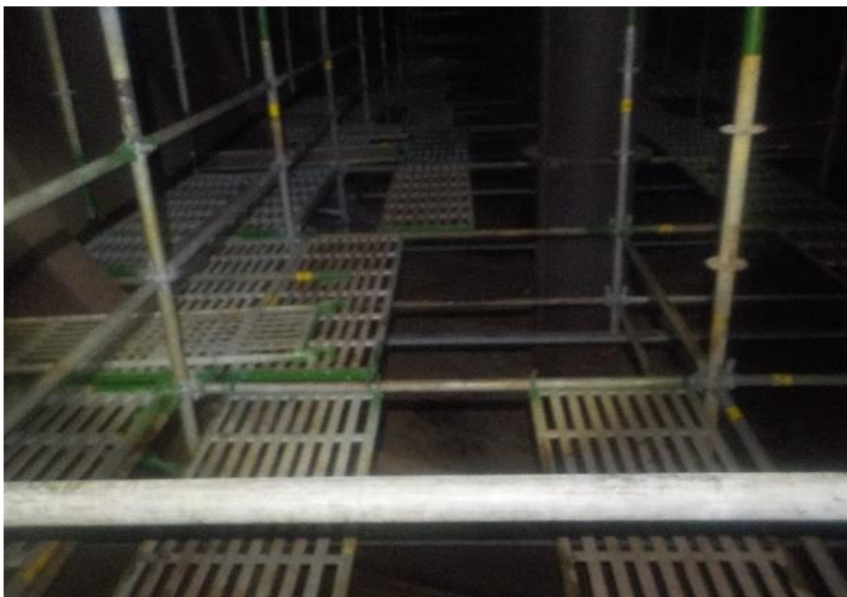
6. 槽內搭架作業情形(2)
