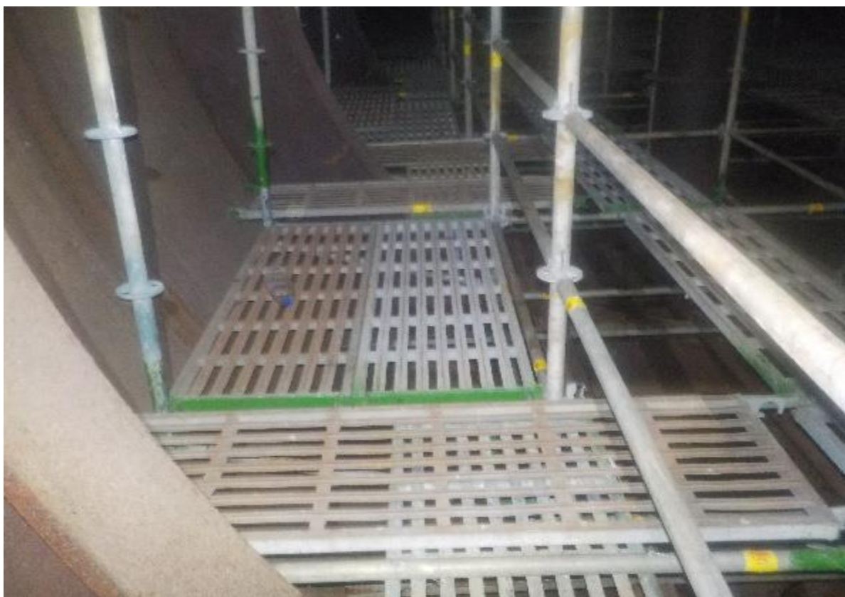
8. 槽內搭架作業情形(4)
