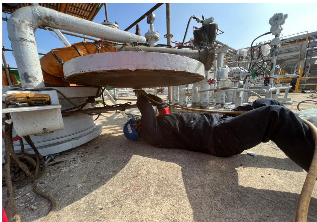
10. 人孔復原前法蘭面整理
