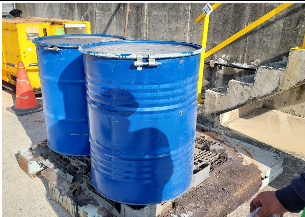
12. 施工用空壓機及粉塵裝桶情形
