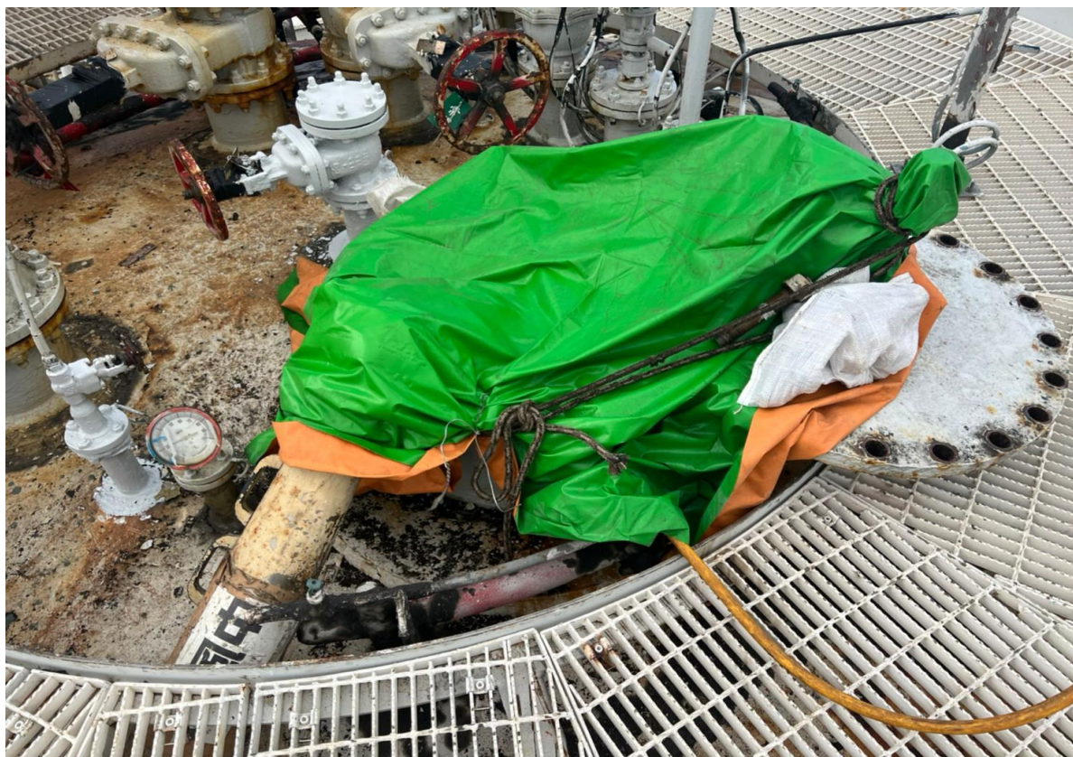
3. 槽頂人孔帆布包覆情形
