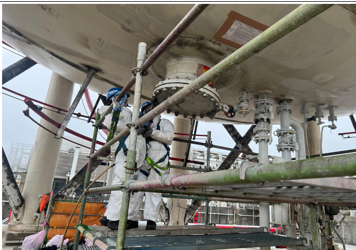
14. 施工完成，人孔復原情形
