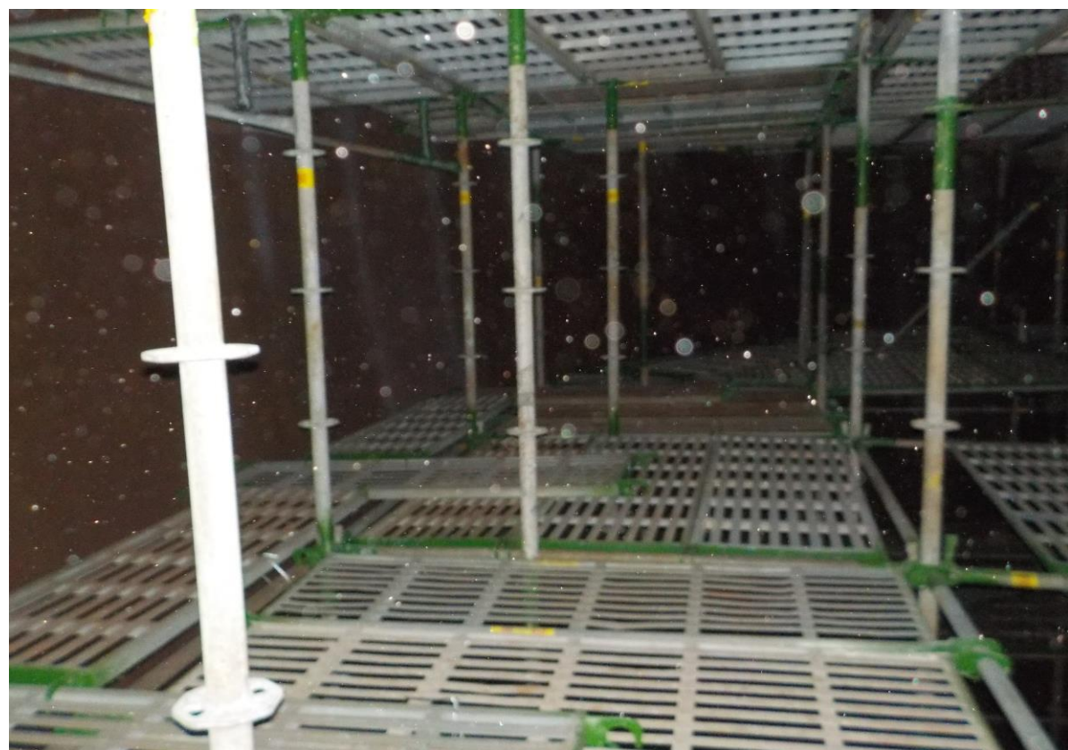
8. 槽內搭架作業情形(4)
