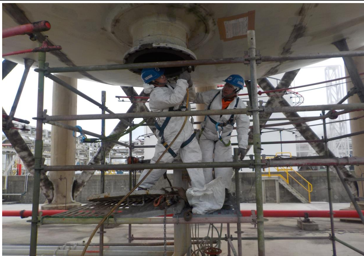
13.人孔復原前法蘭面整理
