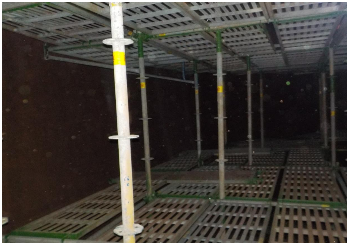
7. 槽內搭架作業情形(3)
