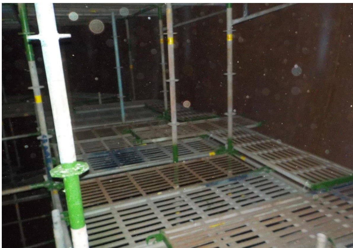
6. 槽內搭架作業情形(2)
