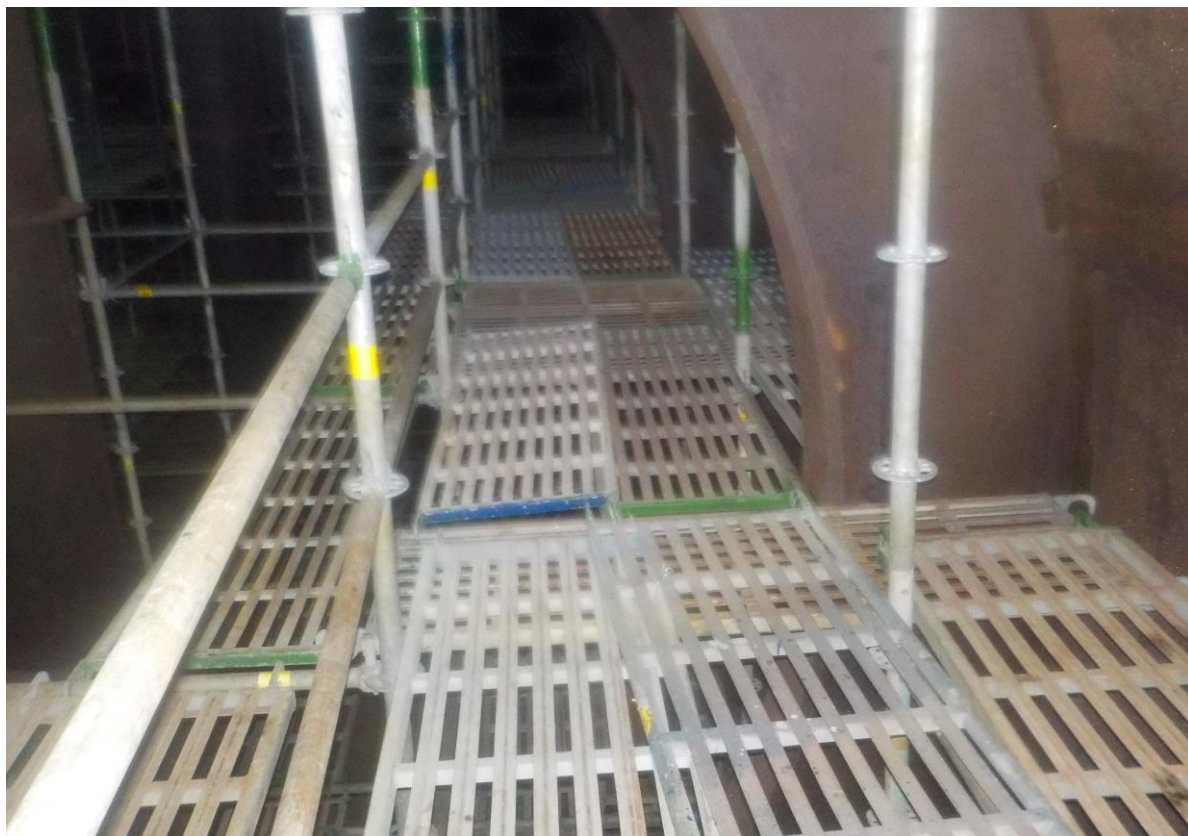
6. 槽內搭架情形(2)
