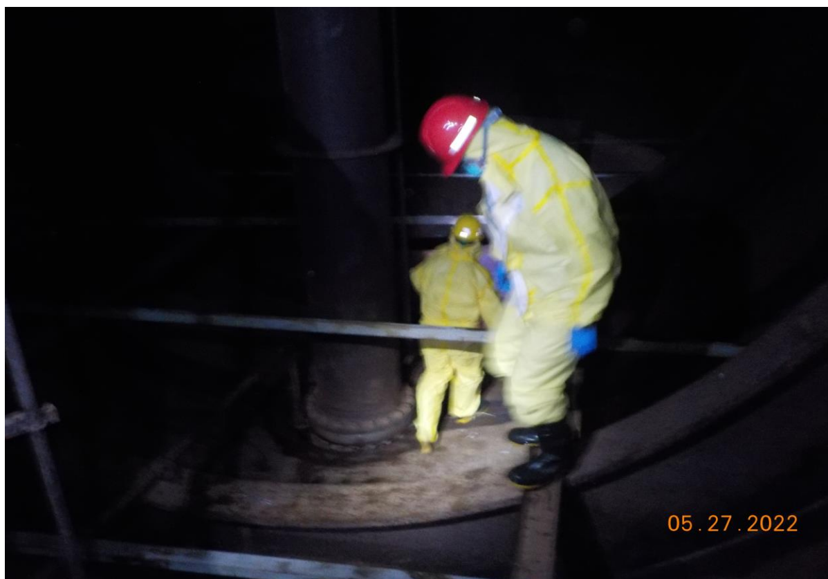
14. 監工入槽檢查
