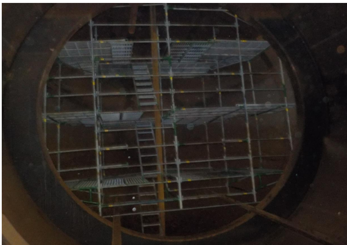
8. 槽內搭架情形(4)
