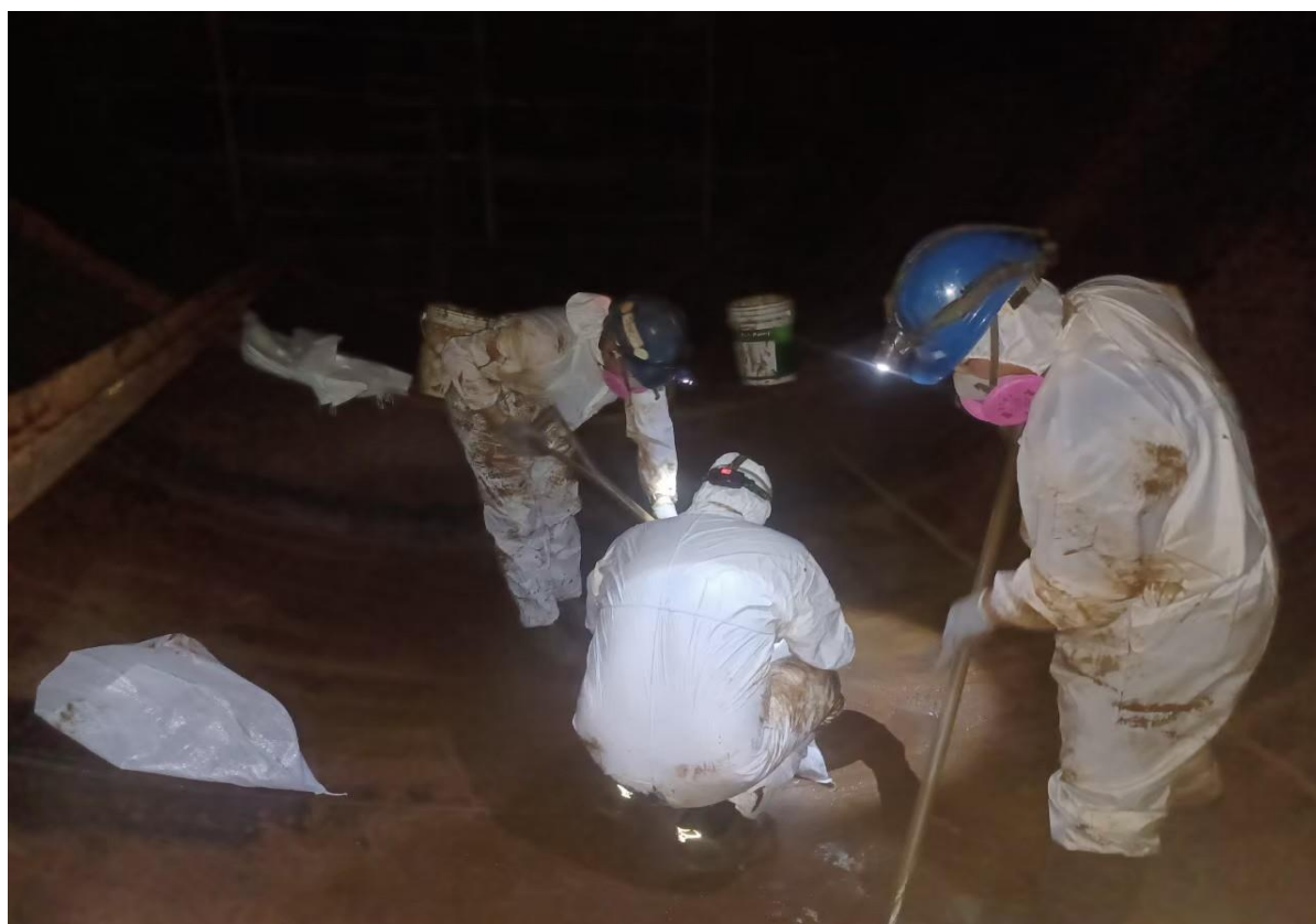
15. 人員槽內清掃(1)
