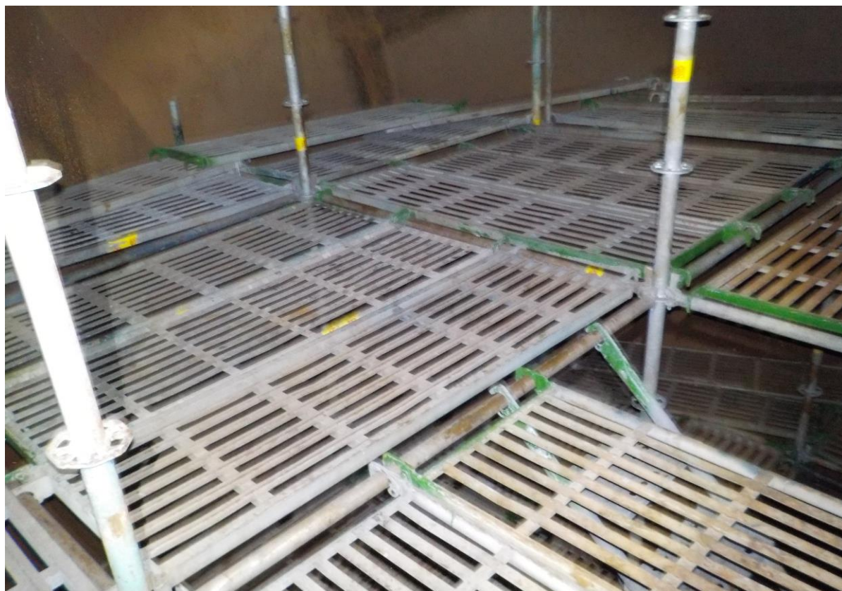
5. 槽內搭架情形(1)
