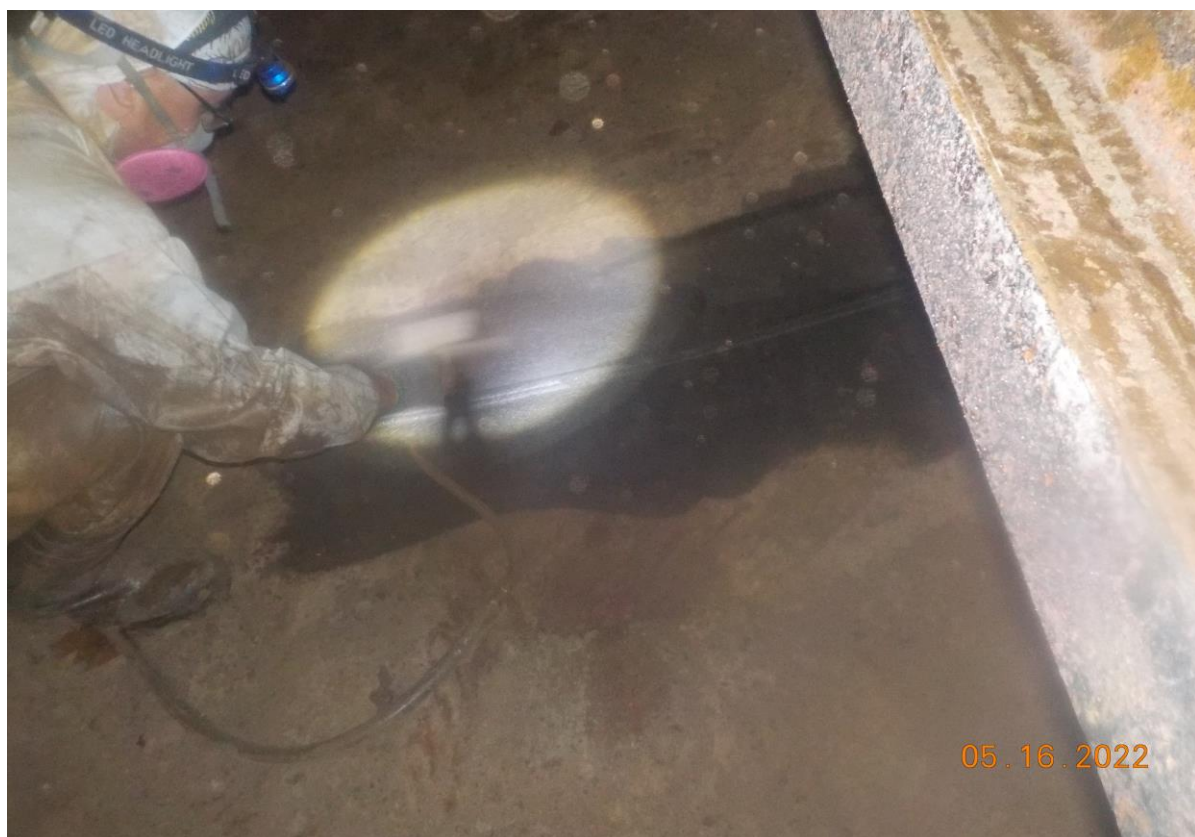
12. 槽內焊道研磨作業(3)
