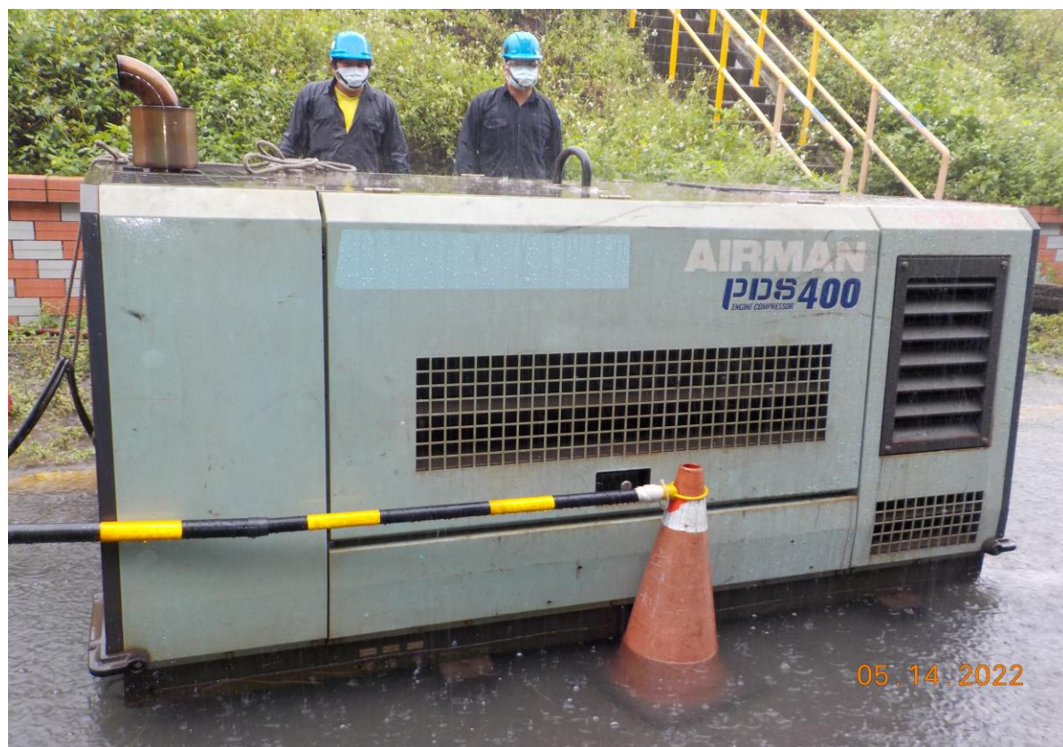
9. 空壓機定位情形
