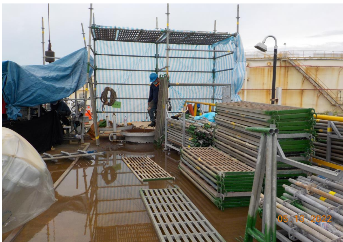
4. 人孔鷹架搭設情形
