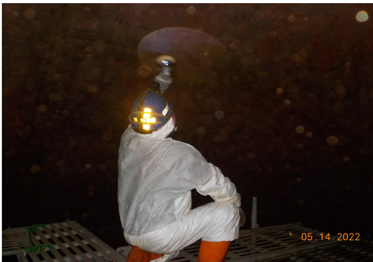
10. 槽內焊道研磨作業(1)
