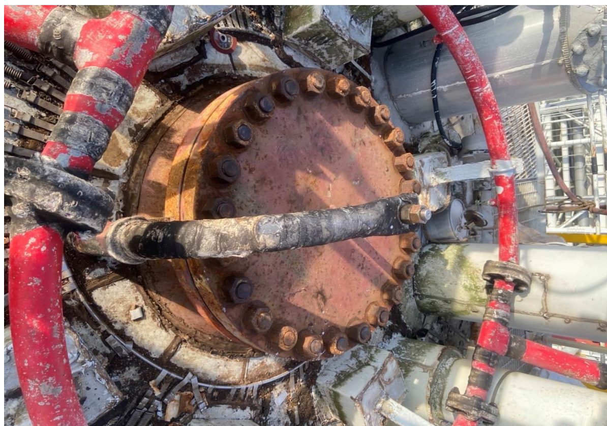
10. 上人孔復原情形
