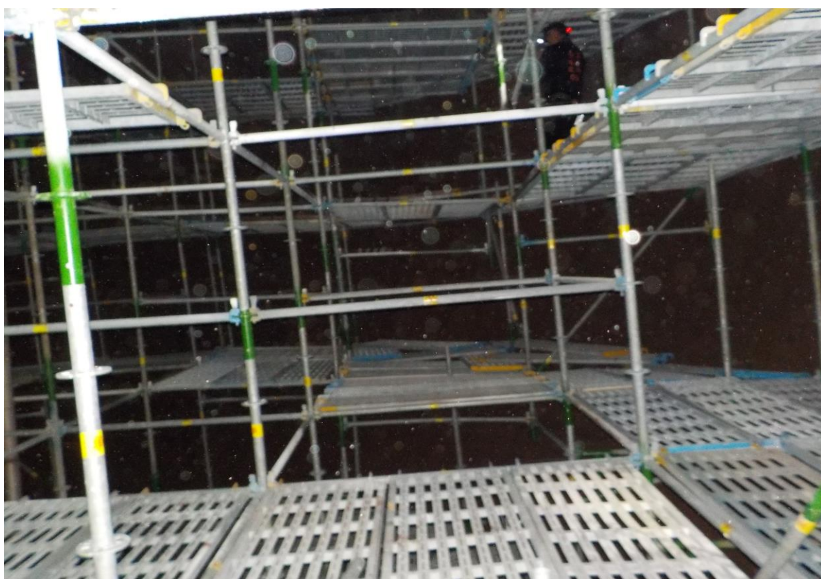
6. 槽內搭架作業情形(3)
