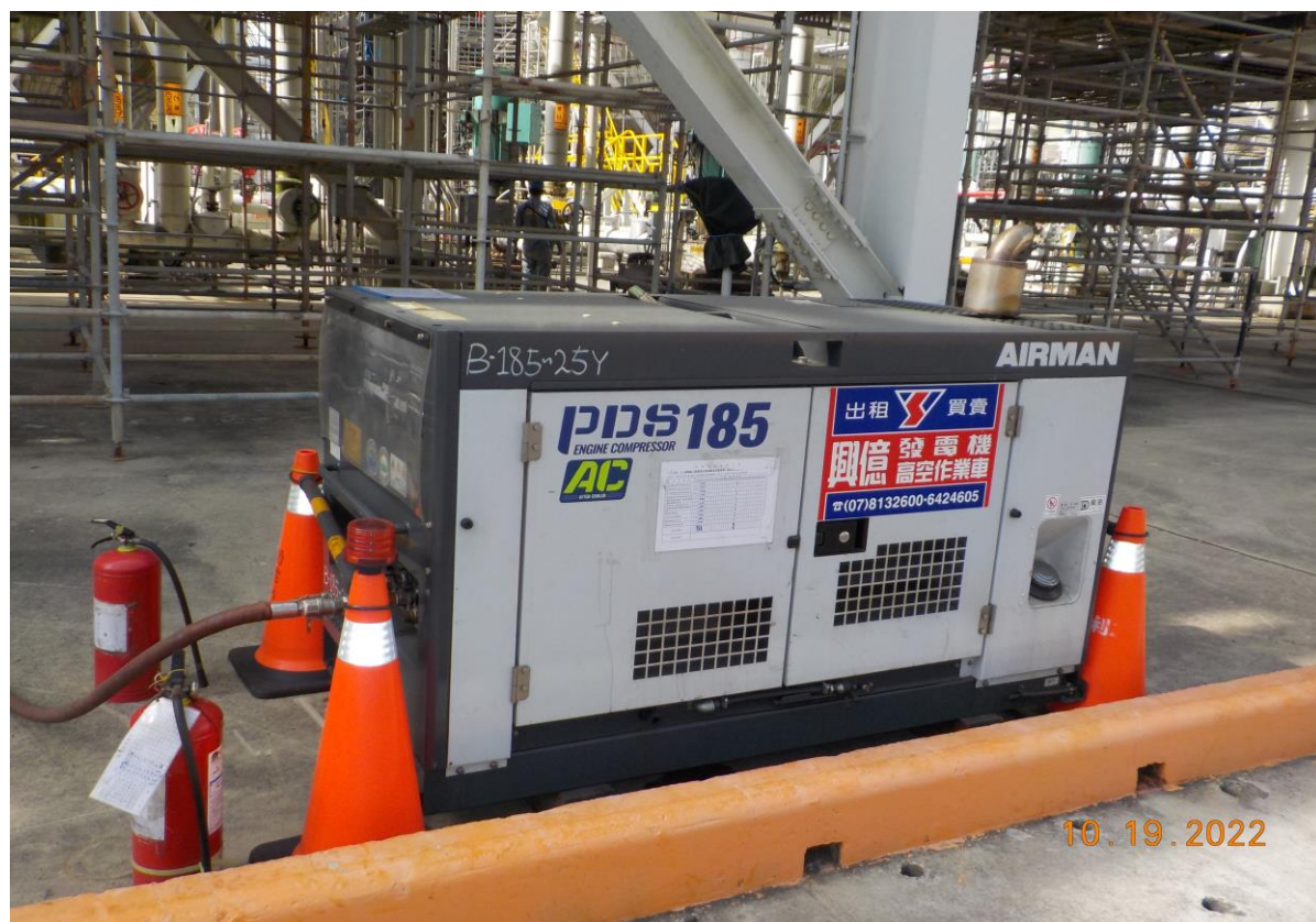
3. 空壓機定位情形
