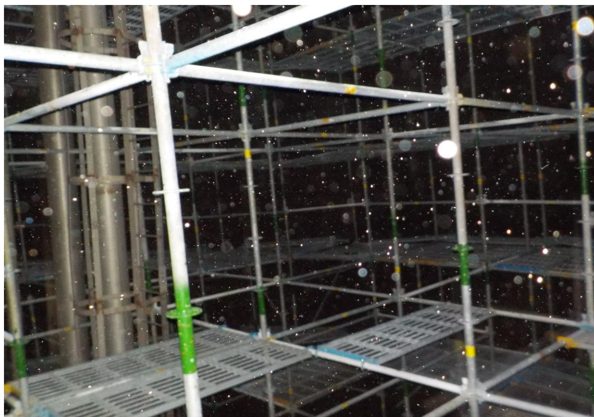
4. 槽內搭架作業情形(1)
