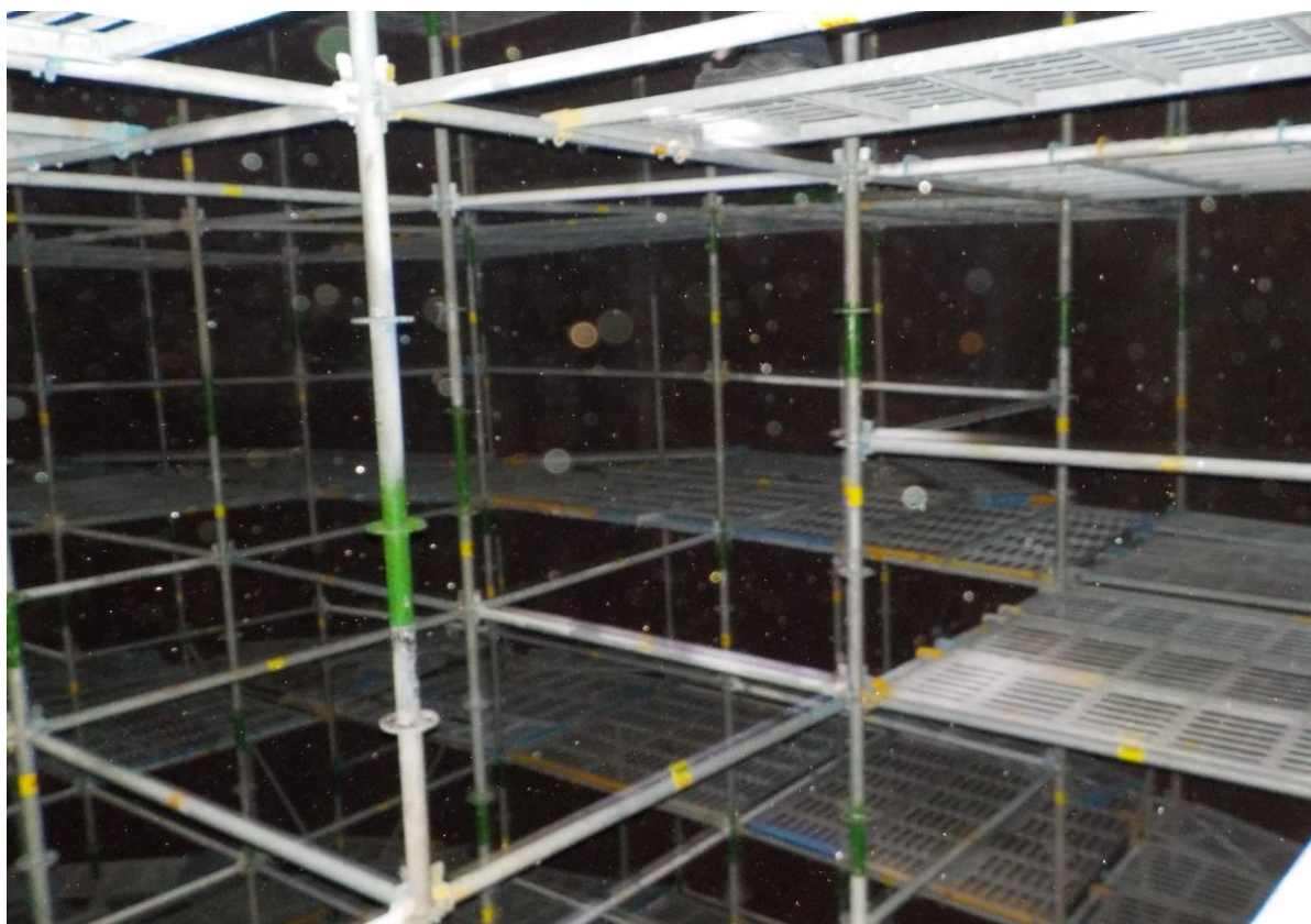
5. 槽內搭架作業情形(2)
