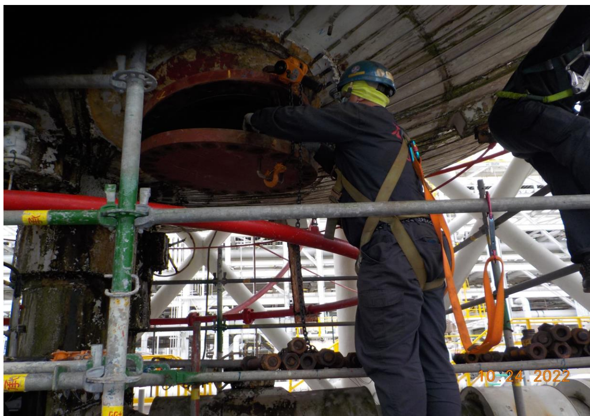
8. 下人孔復原前法蘭面整理
