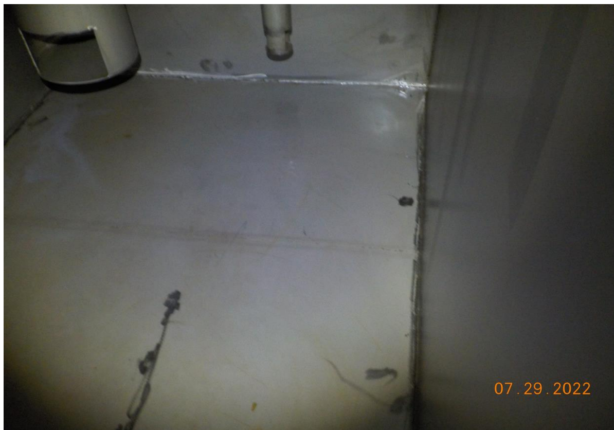
7. 人員擦拭 Z301 後槽內之情形
