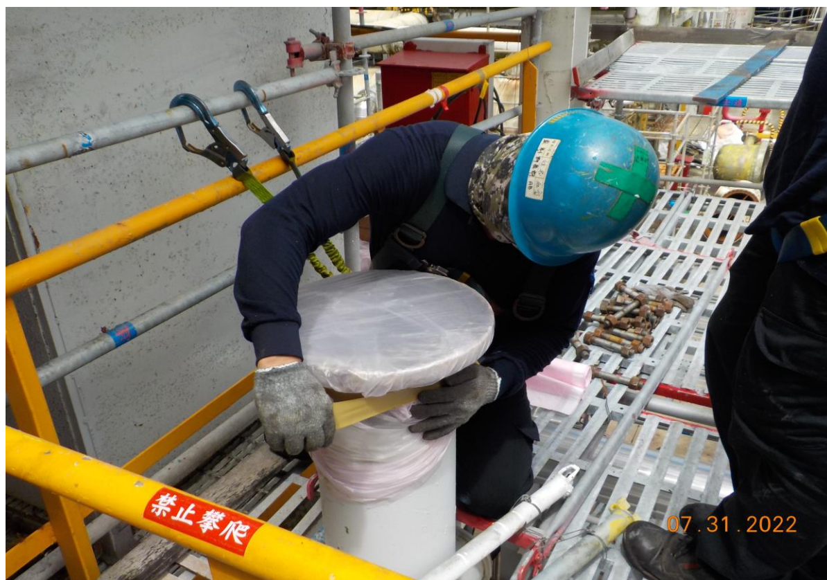
9. 火焰捕捉器移除後法蘭包覆情形
