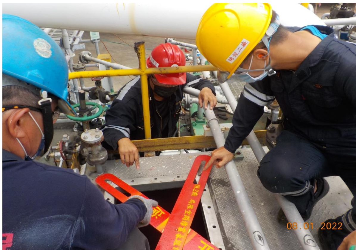
11.業主確認槽內擦拭情形
