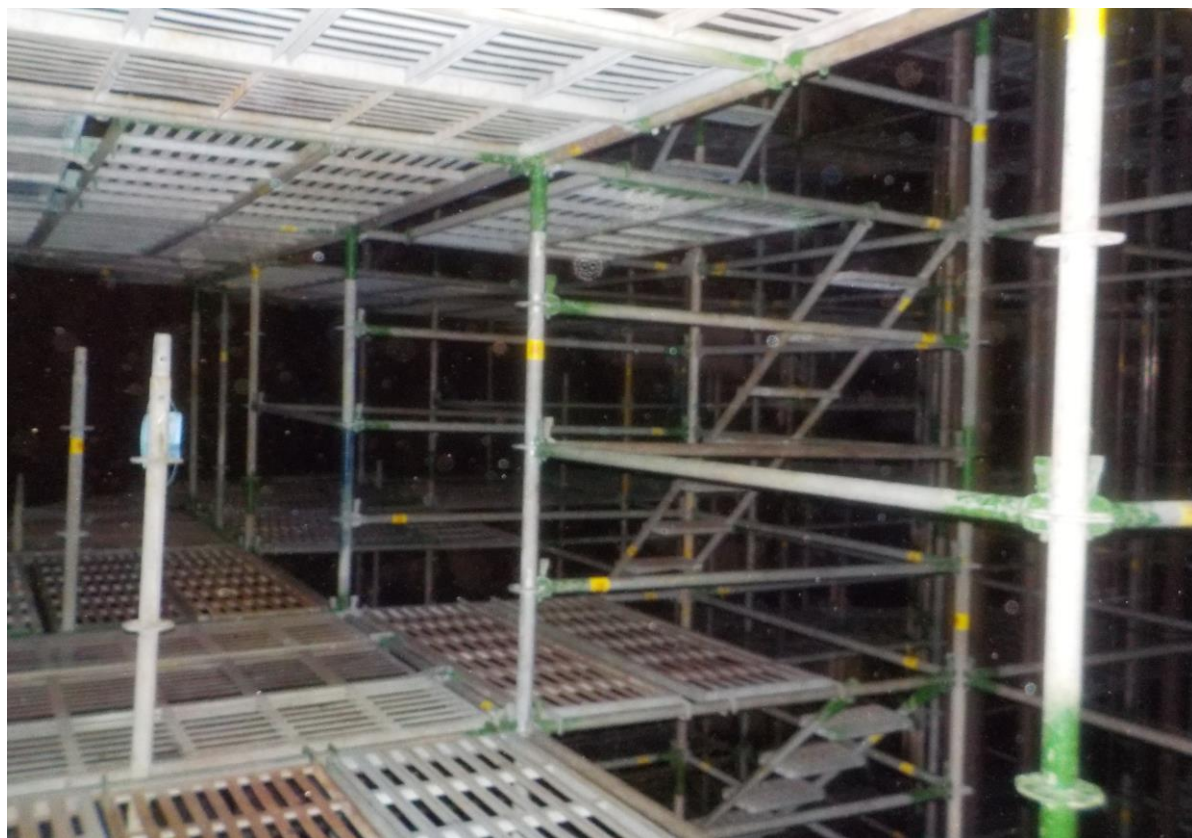
7. 槽內搭架作業情形(3)
