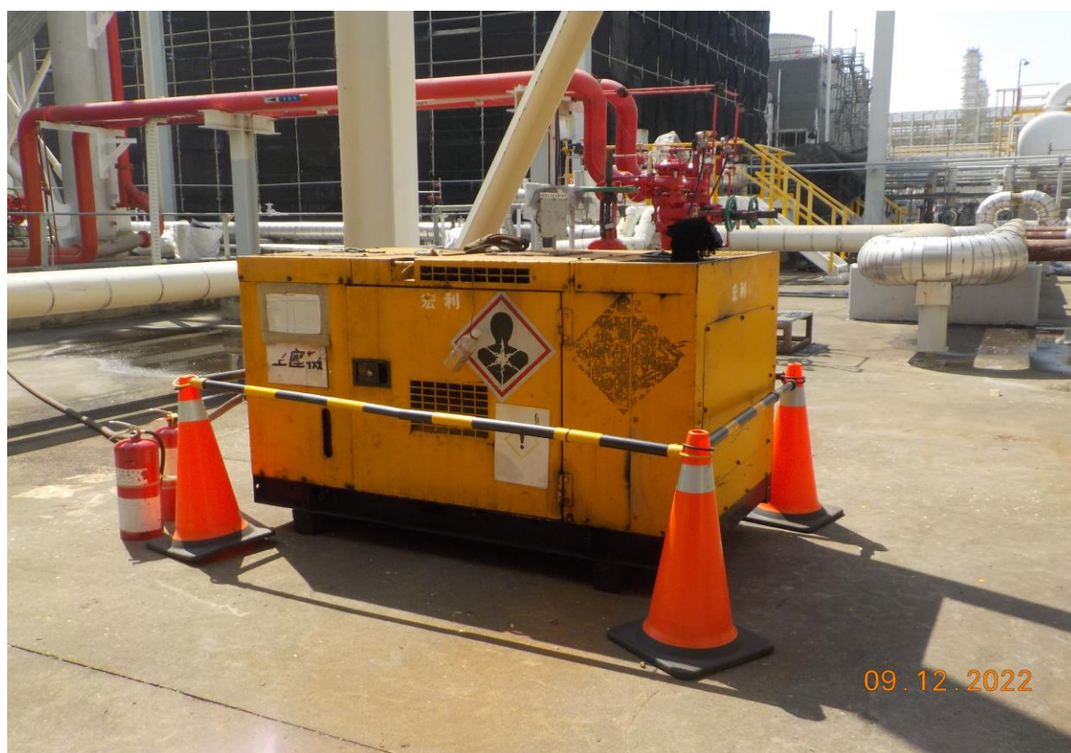
4. 空壓機定位情形
