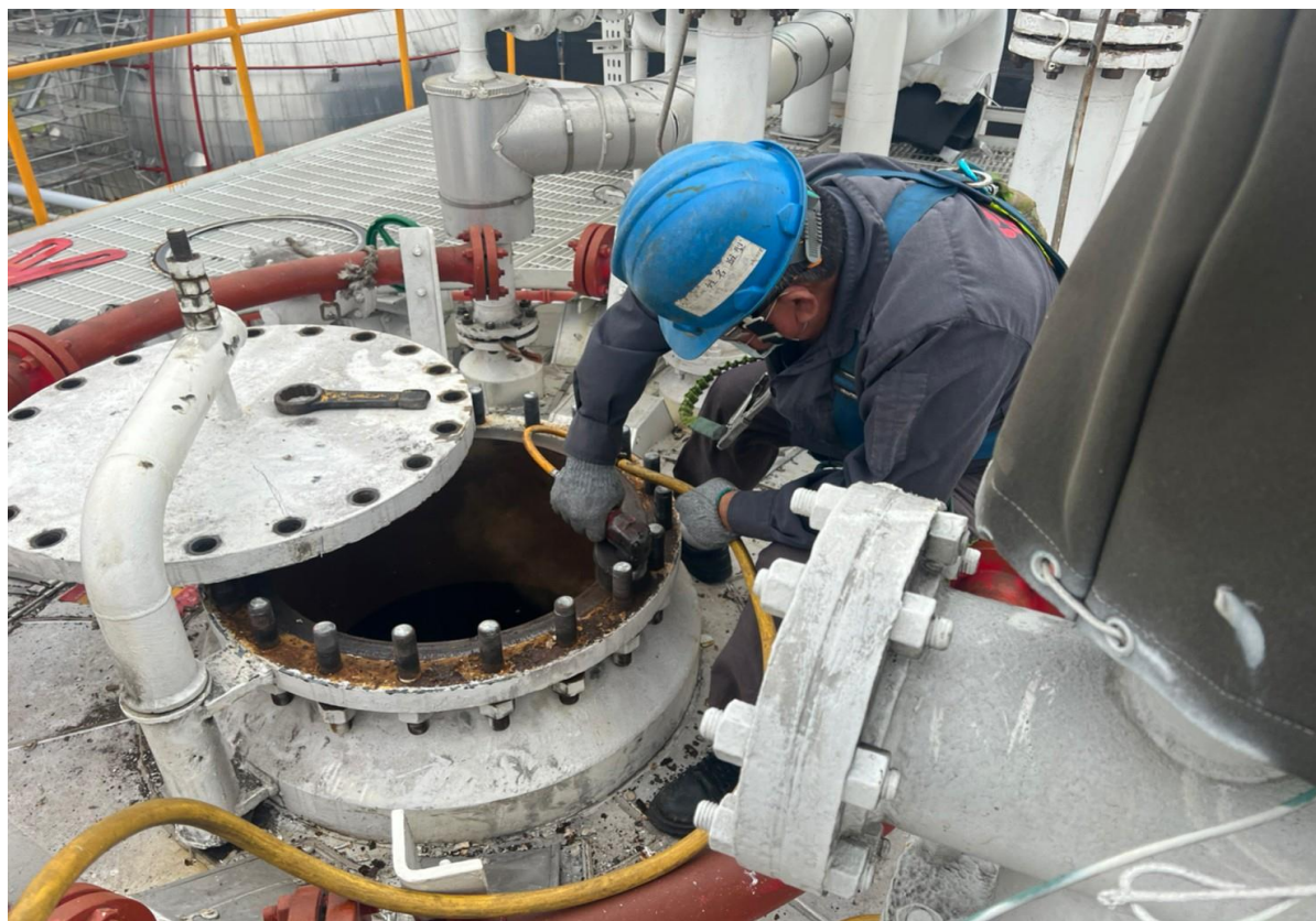
11. 上人孔復原前法蘭面整理
