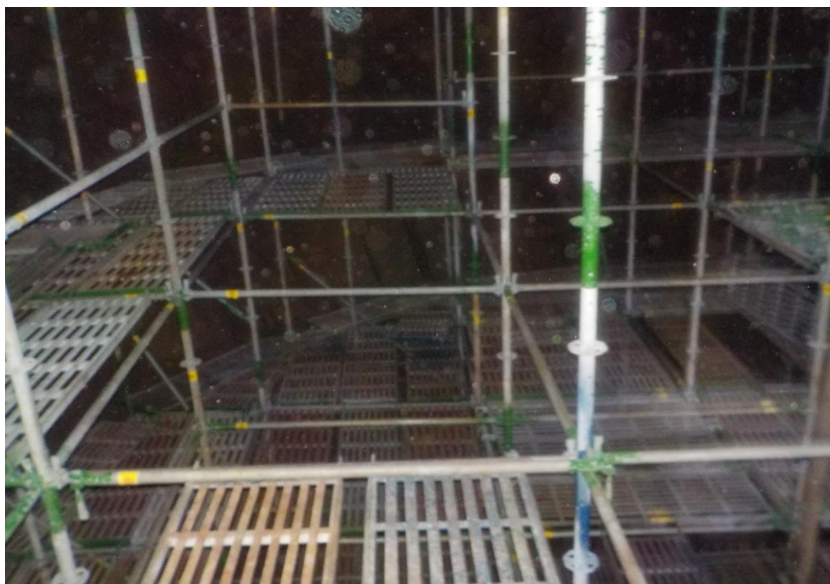
8. 槽內搭架作業情形(4)
