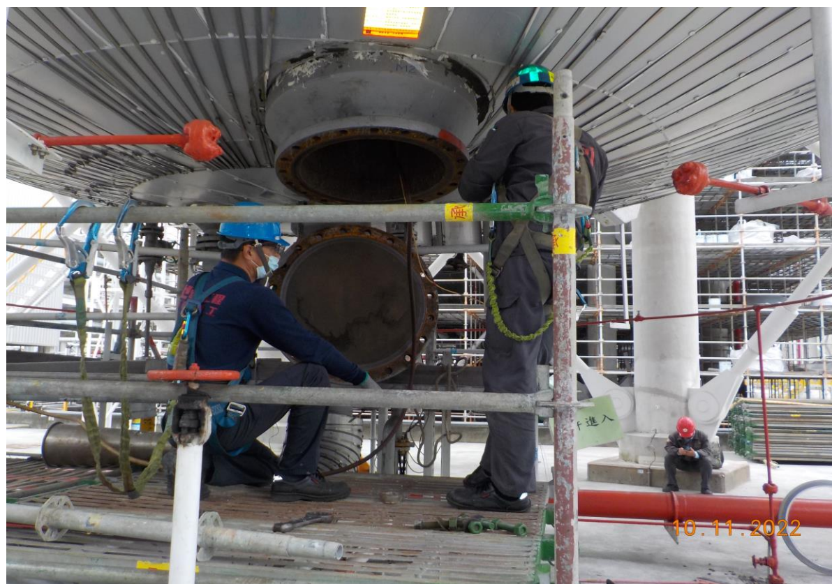
10. 人孔復原前法蘭面整理
