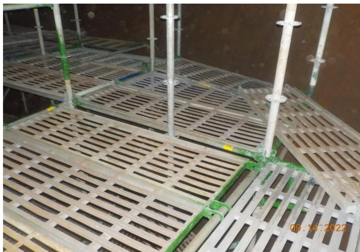
6. 槽內搭架作業情形(2)
