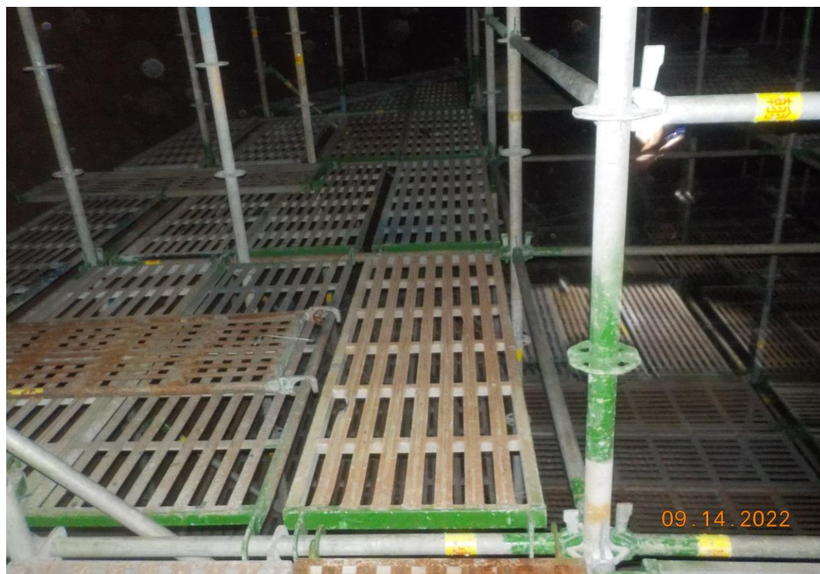
5. 槽內搭架作業情形(1)
