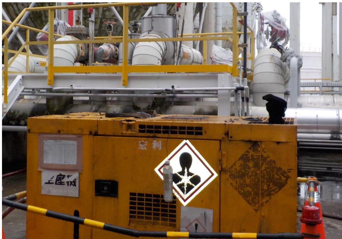
3. 空壓機定位情形
