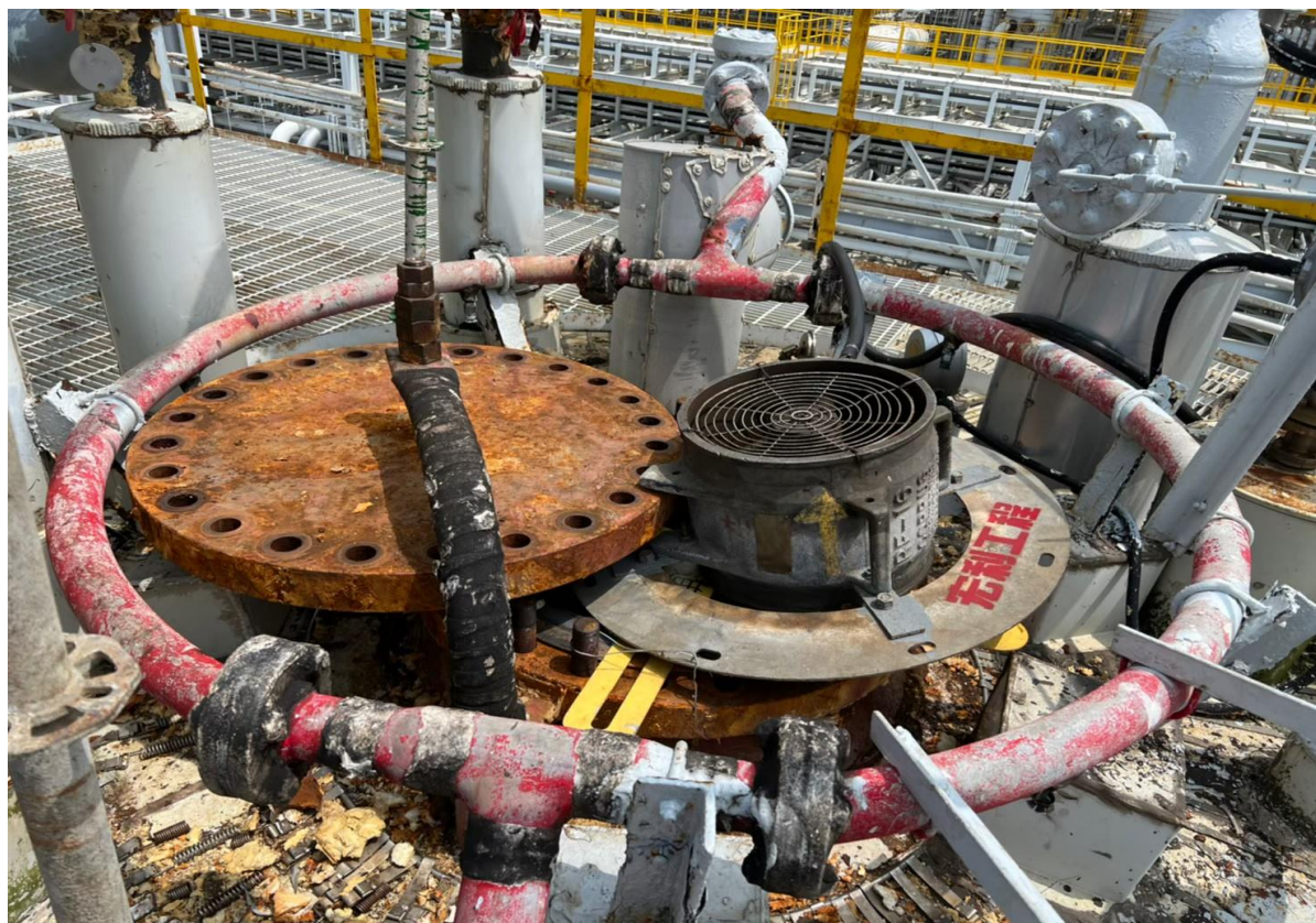
9. 上人孔設備通風情形
