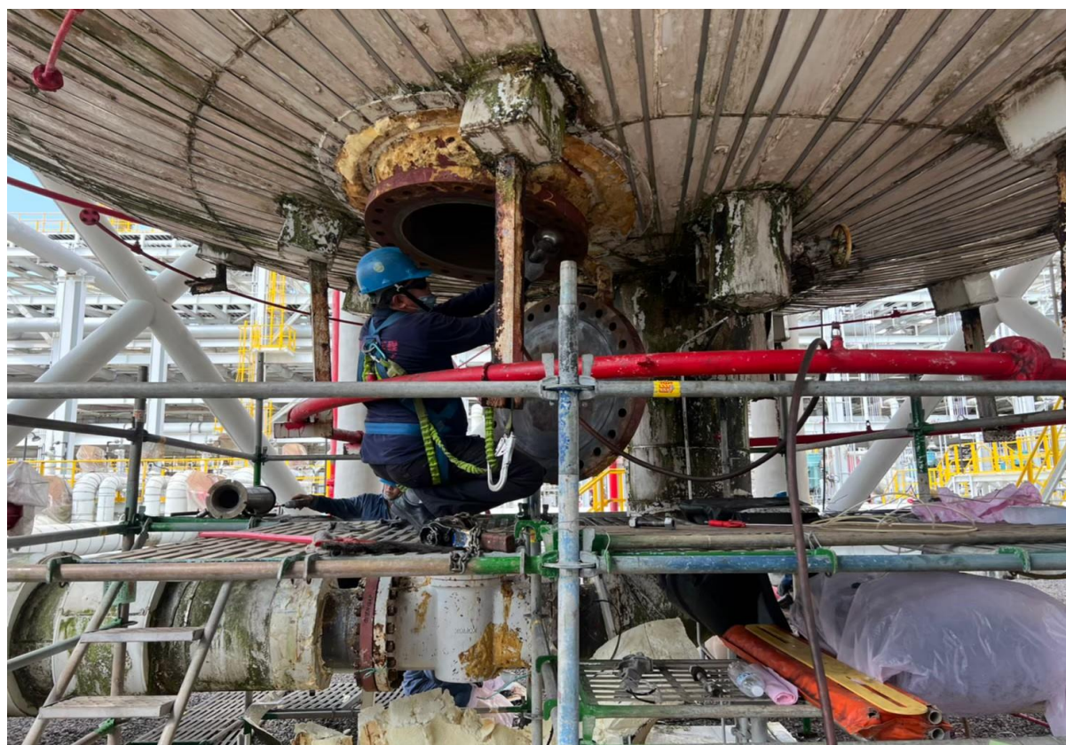
11. 下人孔復原前法蘭面整理
