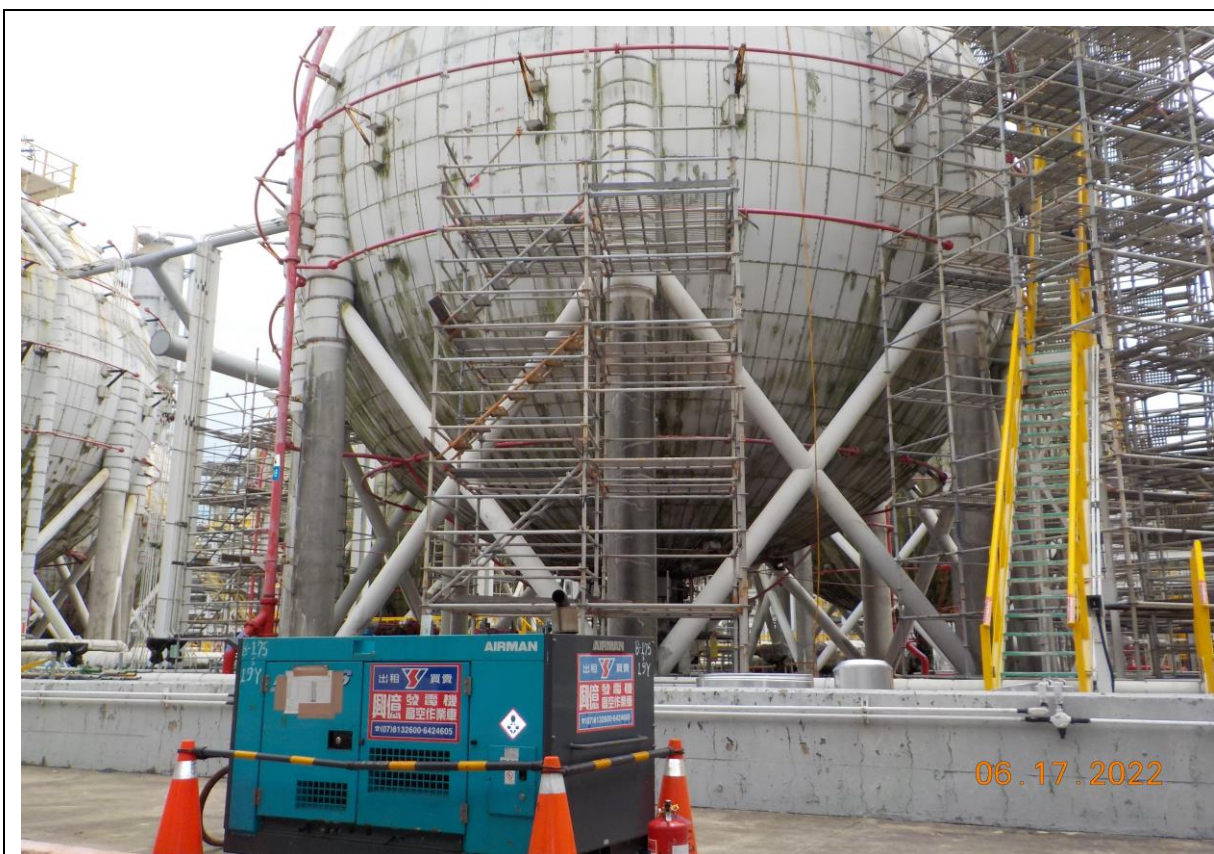
3. 空壓機定位情形
