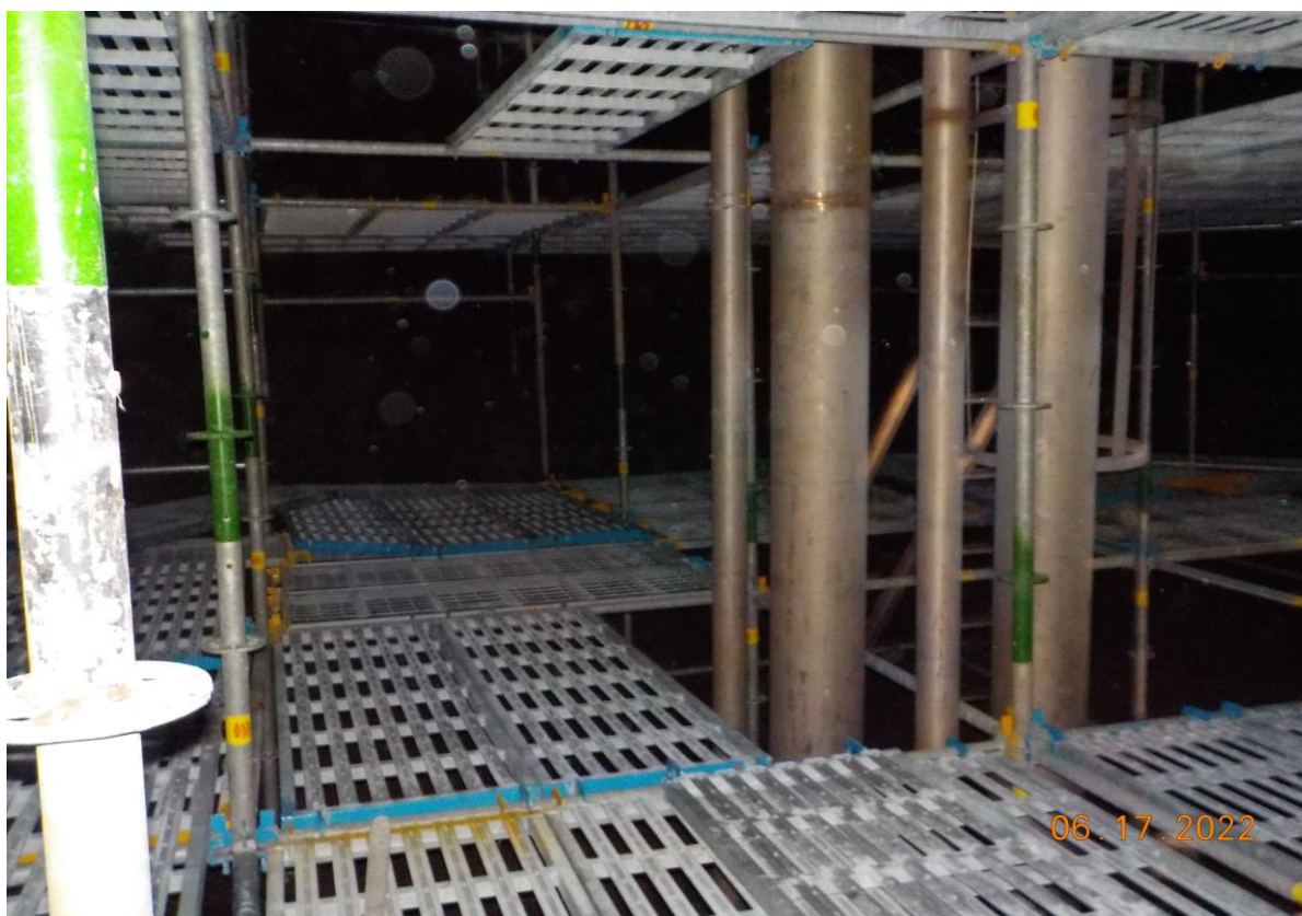
6. 槽內搭架作業情形(3)
