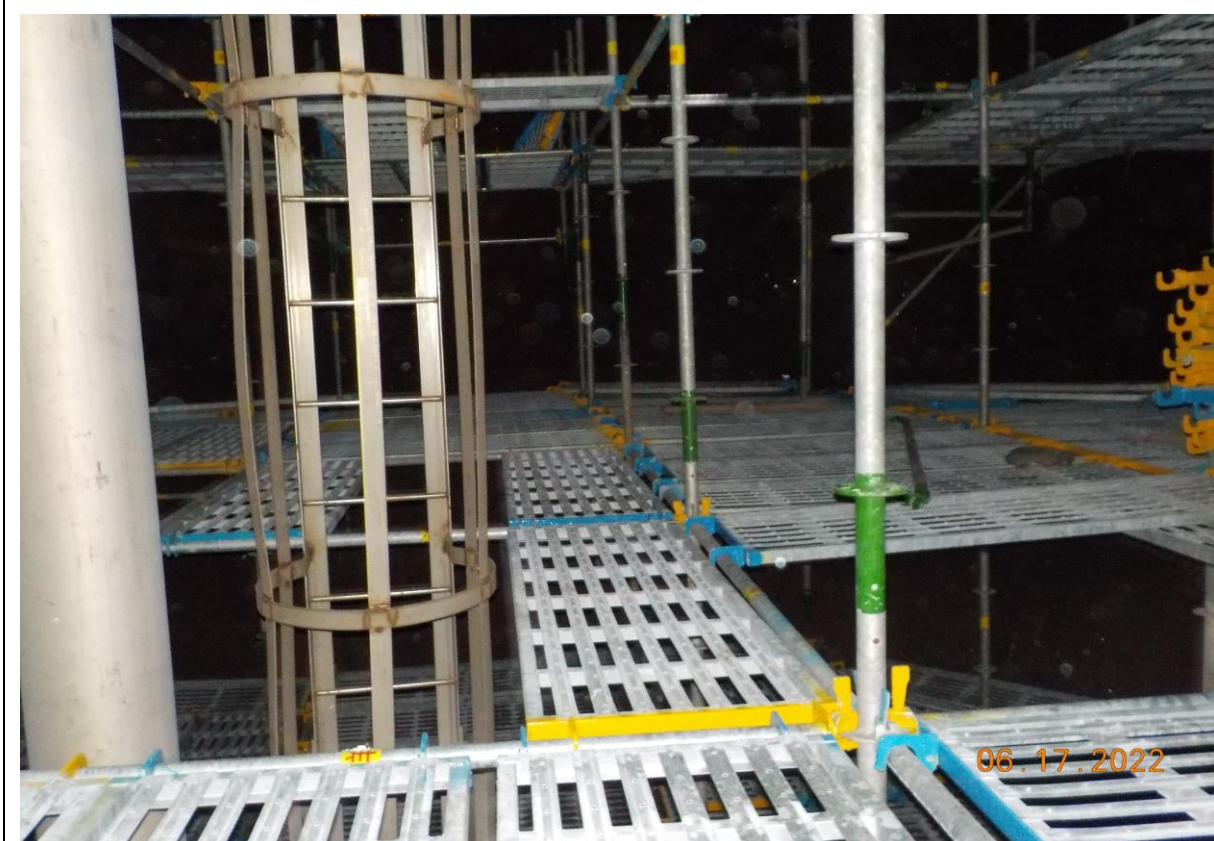
4. 槽內搭架作業情形(1)
