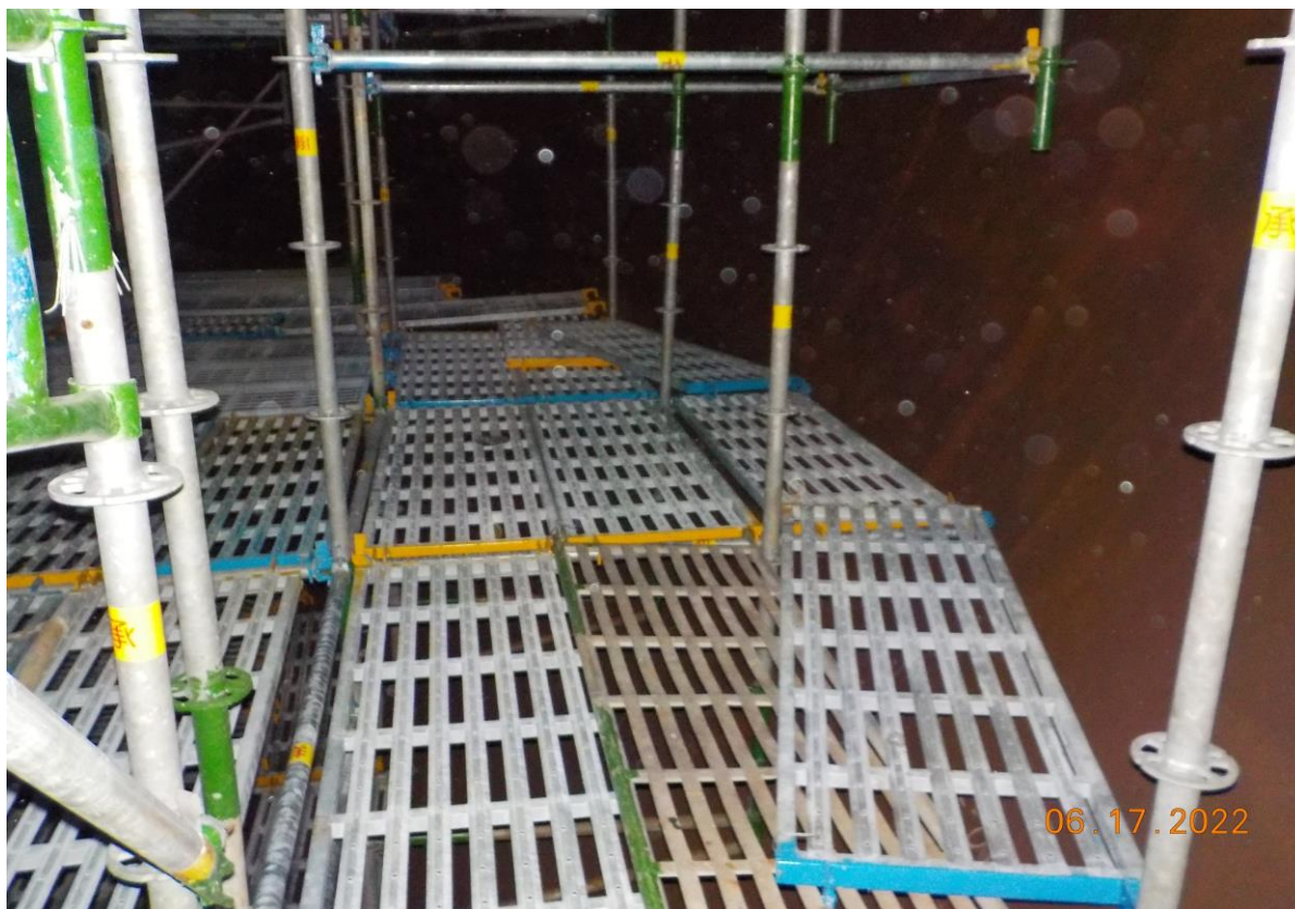
5. 槽內搭架作業情形(2)
