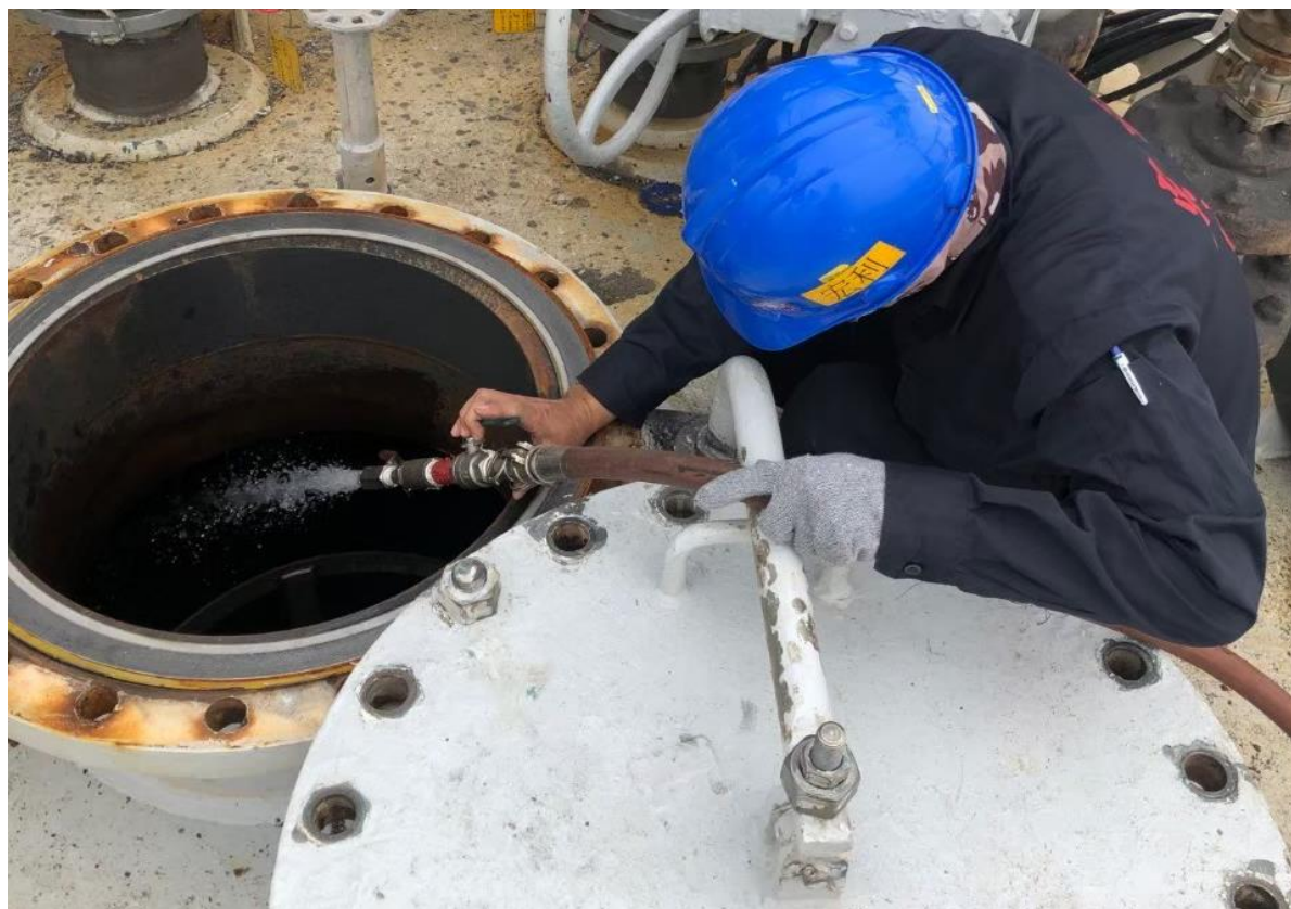
5. 槽內清洗作業
