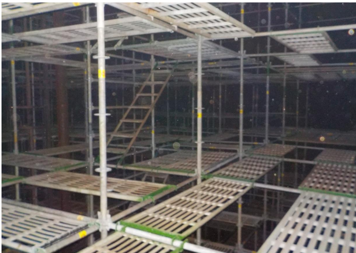
11. 槽內搭架作業情形(3)
