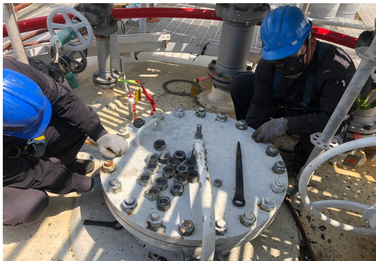
16. 上方人孔復原作業
