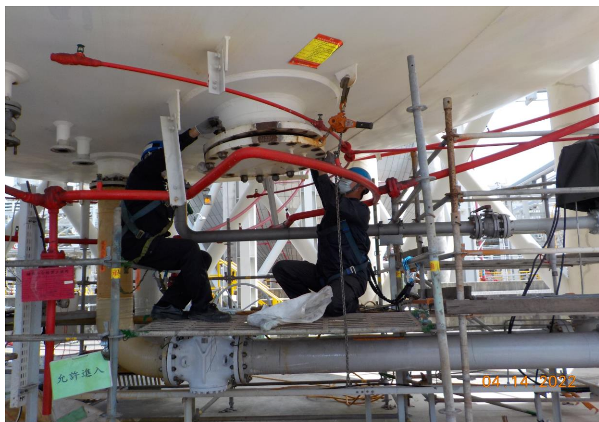
14. 下方人孔復原作業
