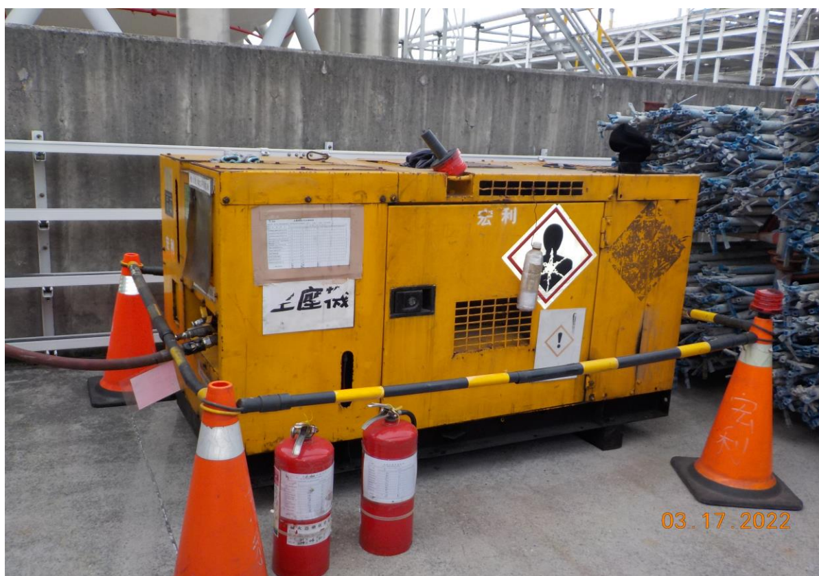
8. 空壓機定位情形
