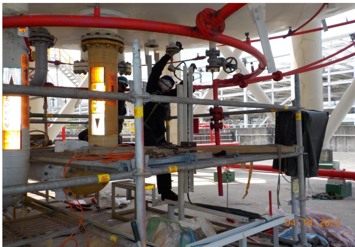
15. 管線抽盲作業
