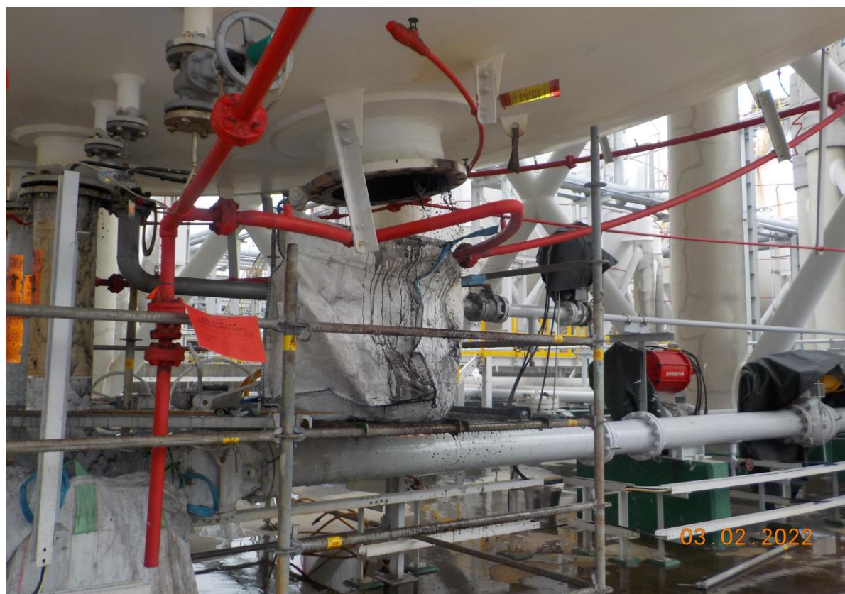
6. 槽內水洗下人孔承接情形
