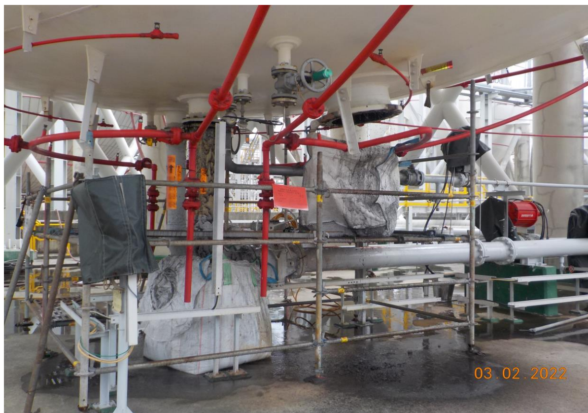
7. 下方人孔及料口太空袋承接情形
