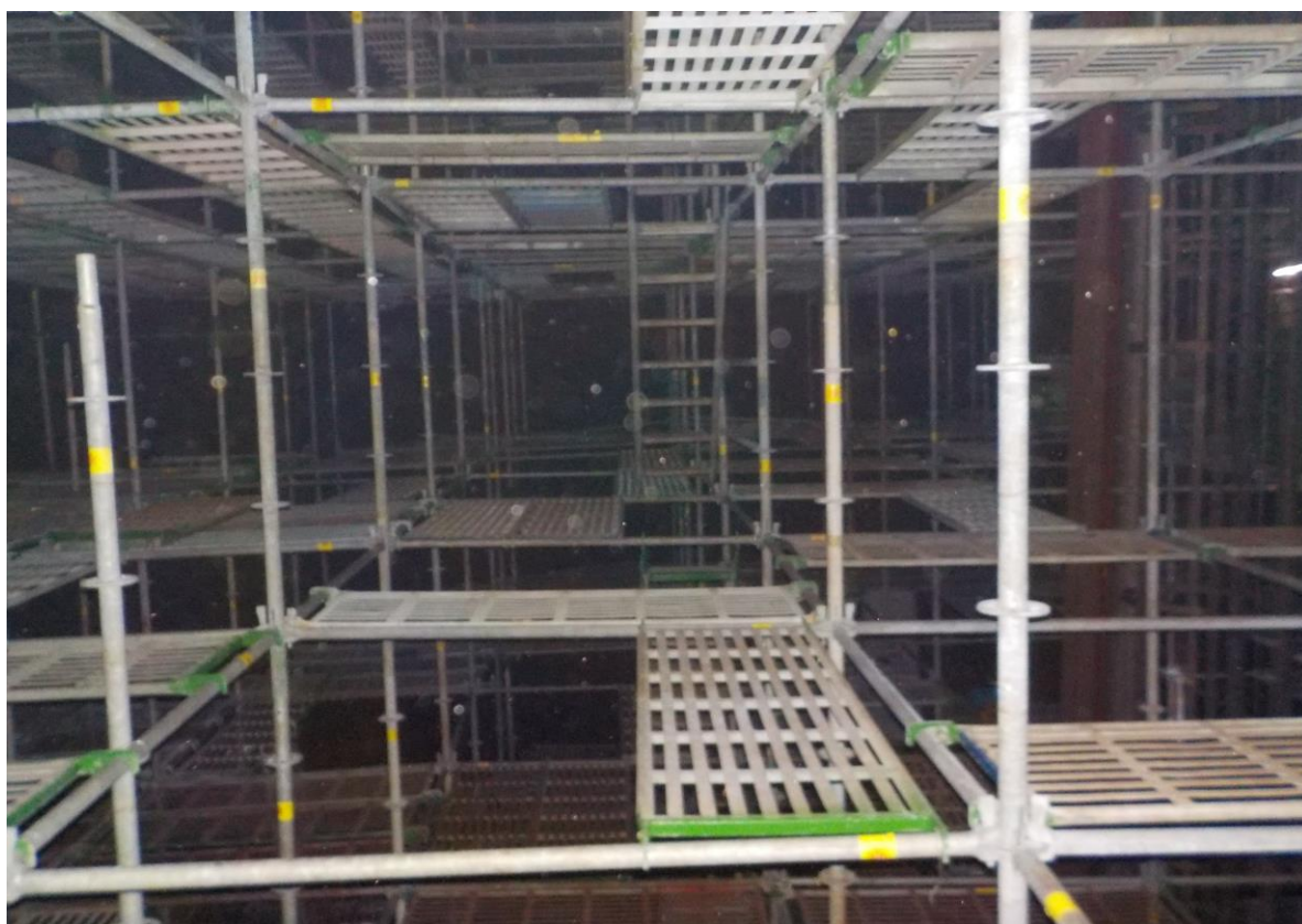
10. 槽內搭架作業情形(2)
