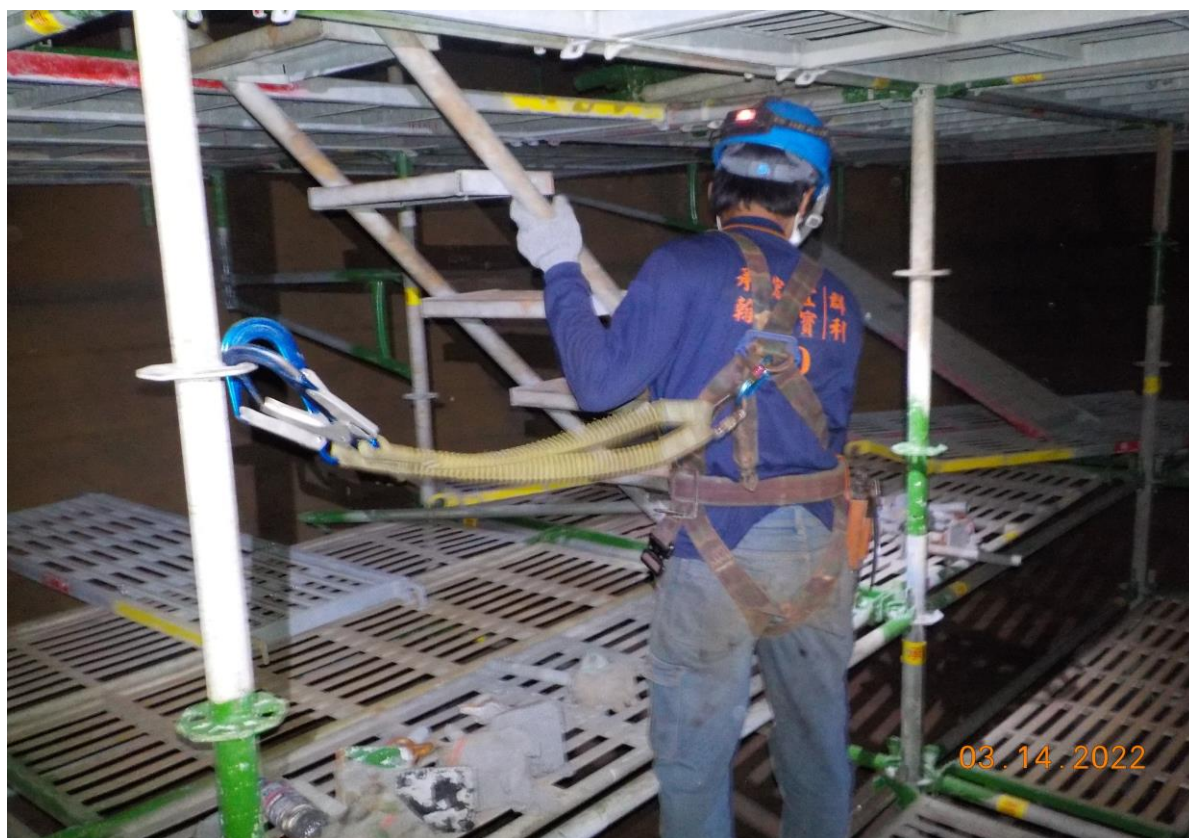
5. 槽內搭架作業情形(1)
