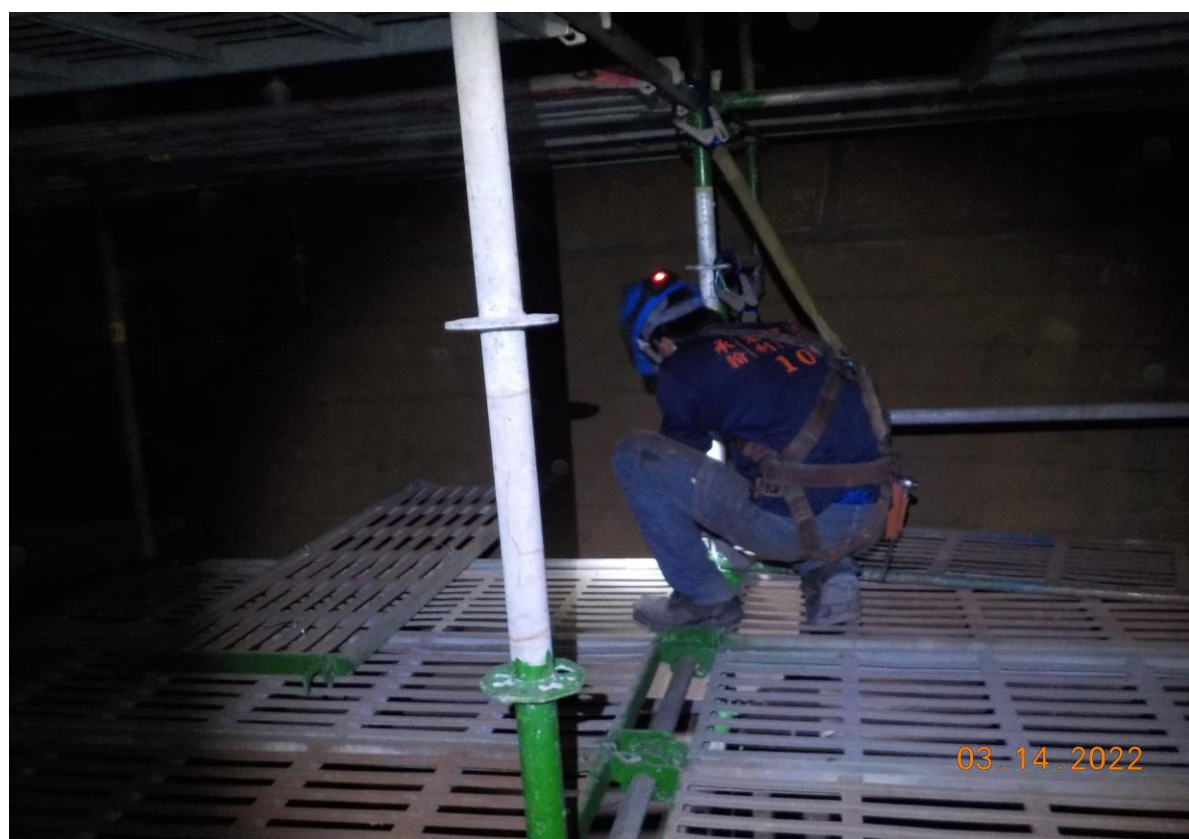
6. 槽內搭架作業情形(2)
