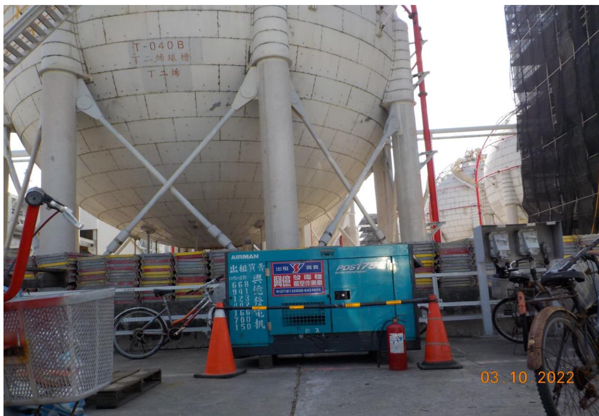
4. 空壓機定位情形
