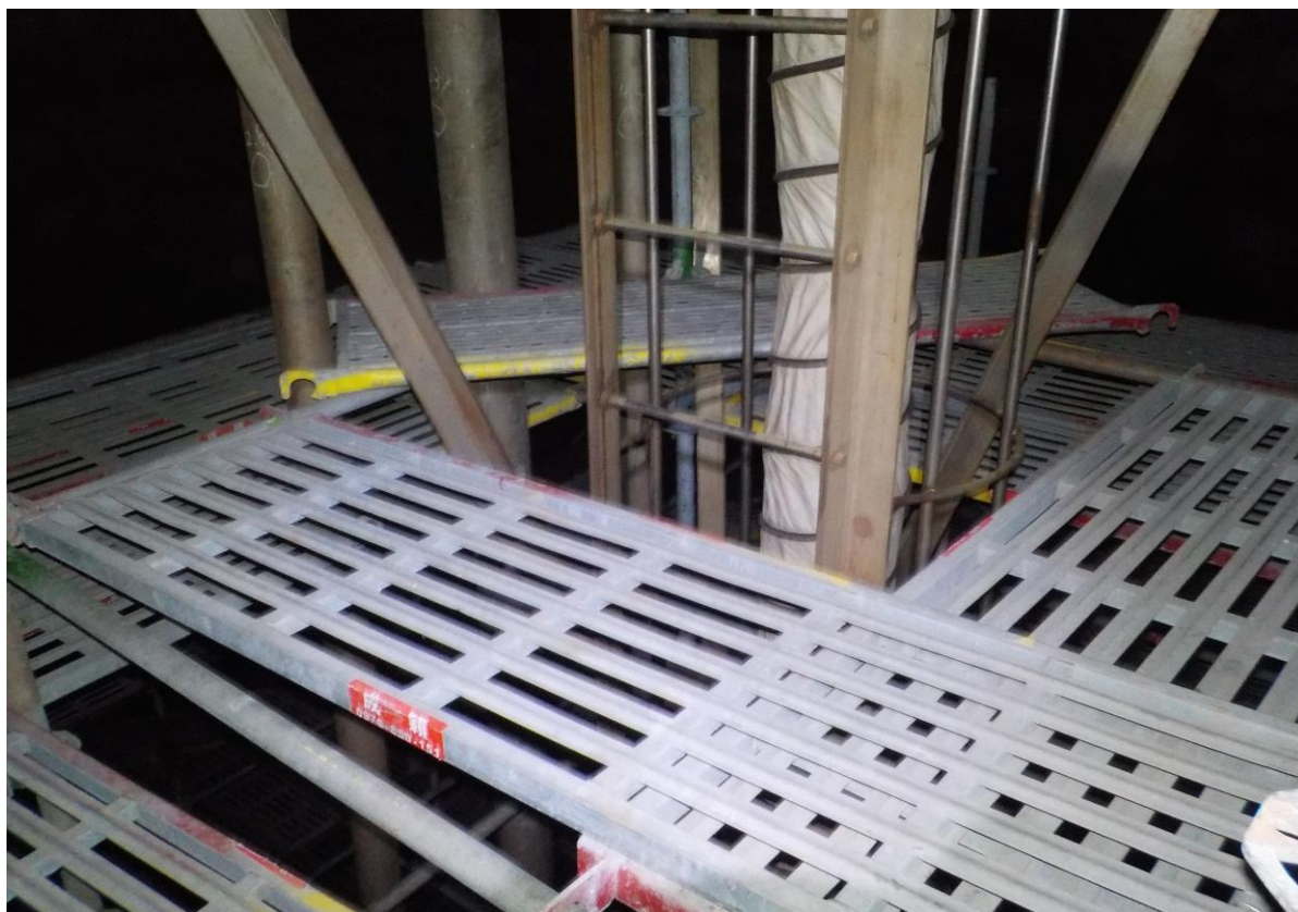
7. 槽內搭架作業情形(3)
