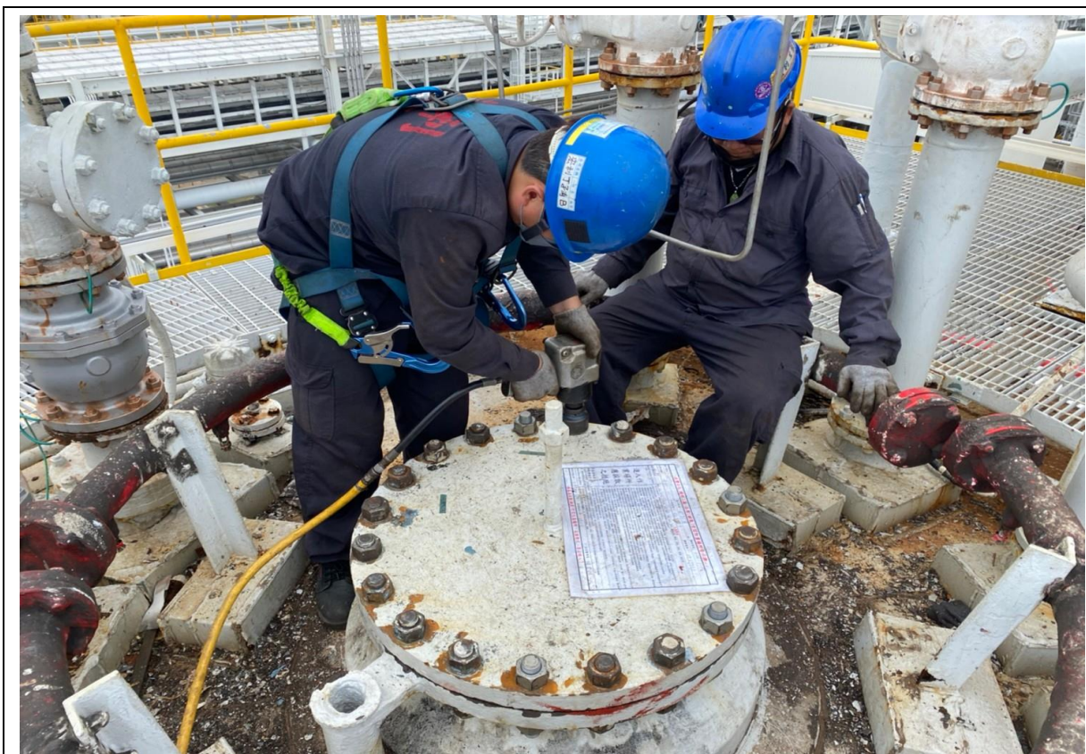
11. 上人孔復原情形
