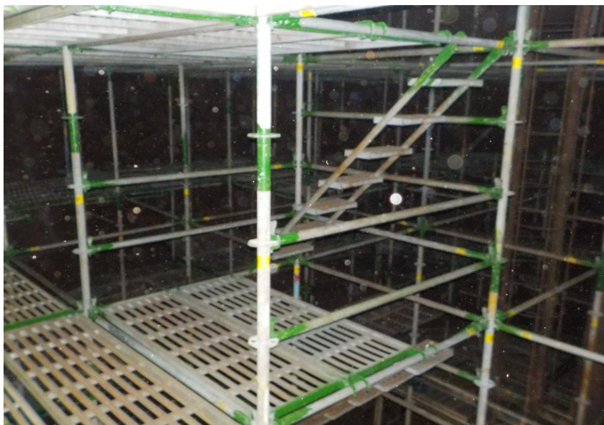
8. 槽內搭架作業情形(4)
