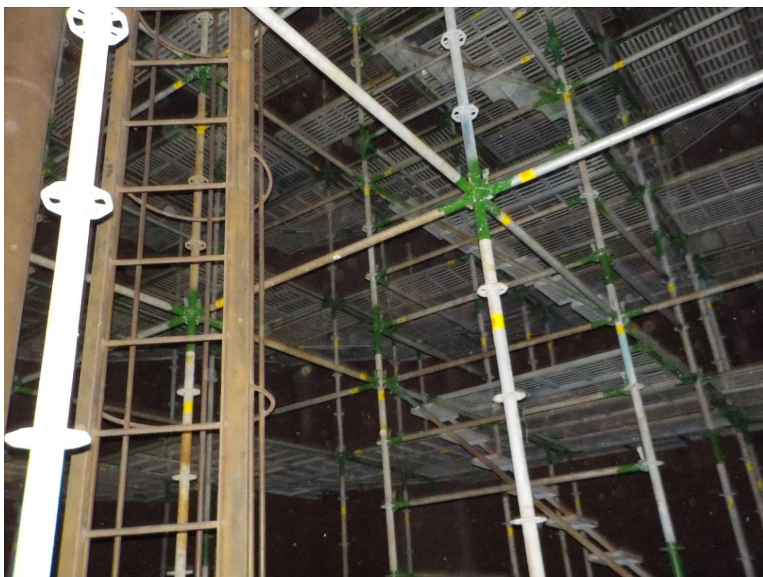
6. 槽內搭架作業情形(2)
