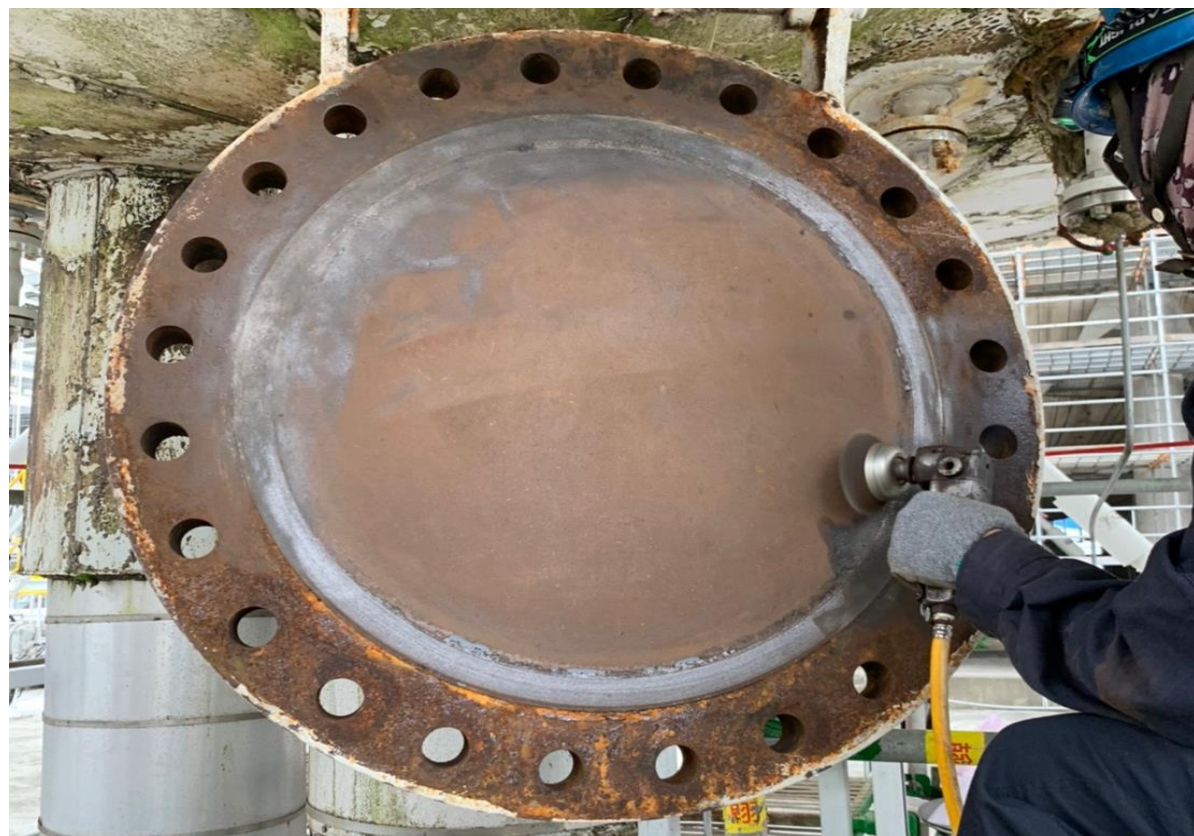
11. 人孔復原前法蘭面整理
