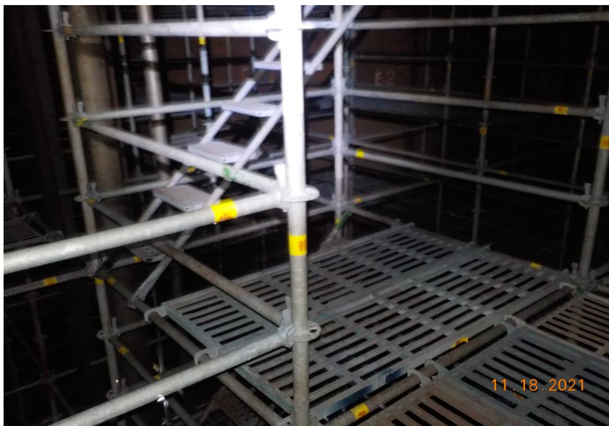
8. 槽內搭架作業情形(4)
