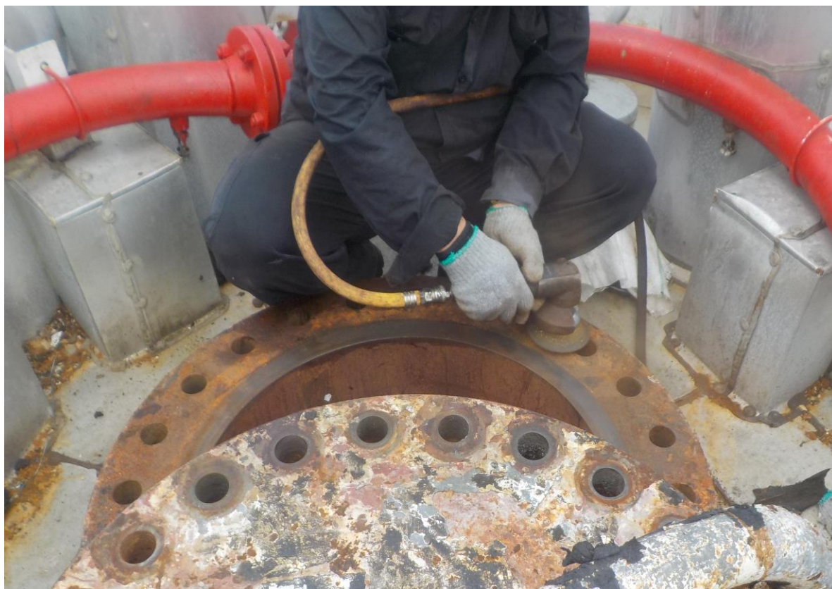
11. 人孔復原前法蘭面整理
