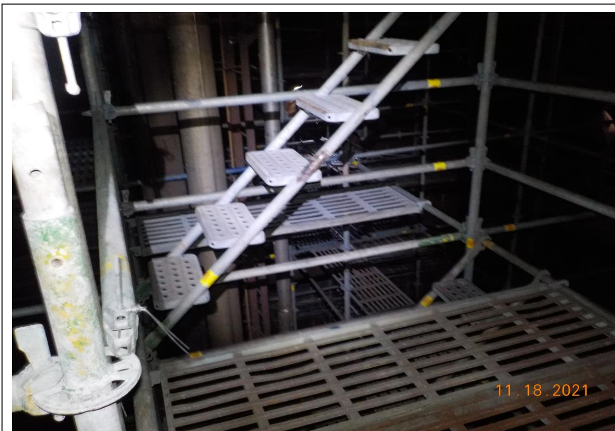
5. 槽內搭架作業情形(1)
