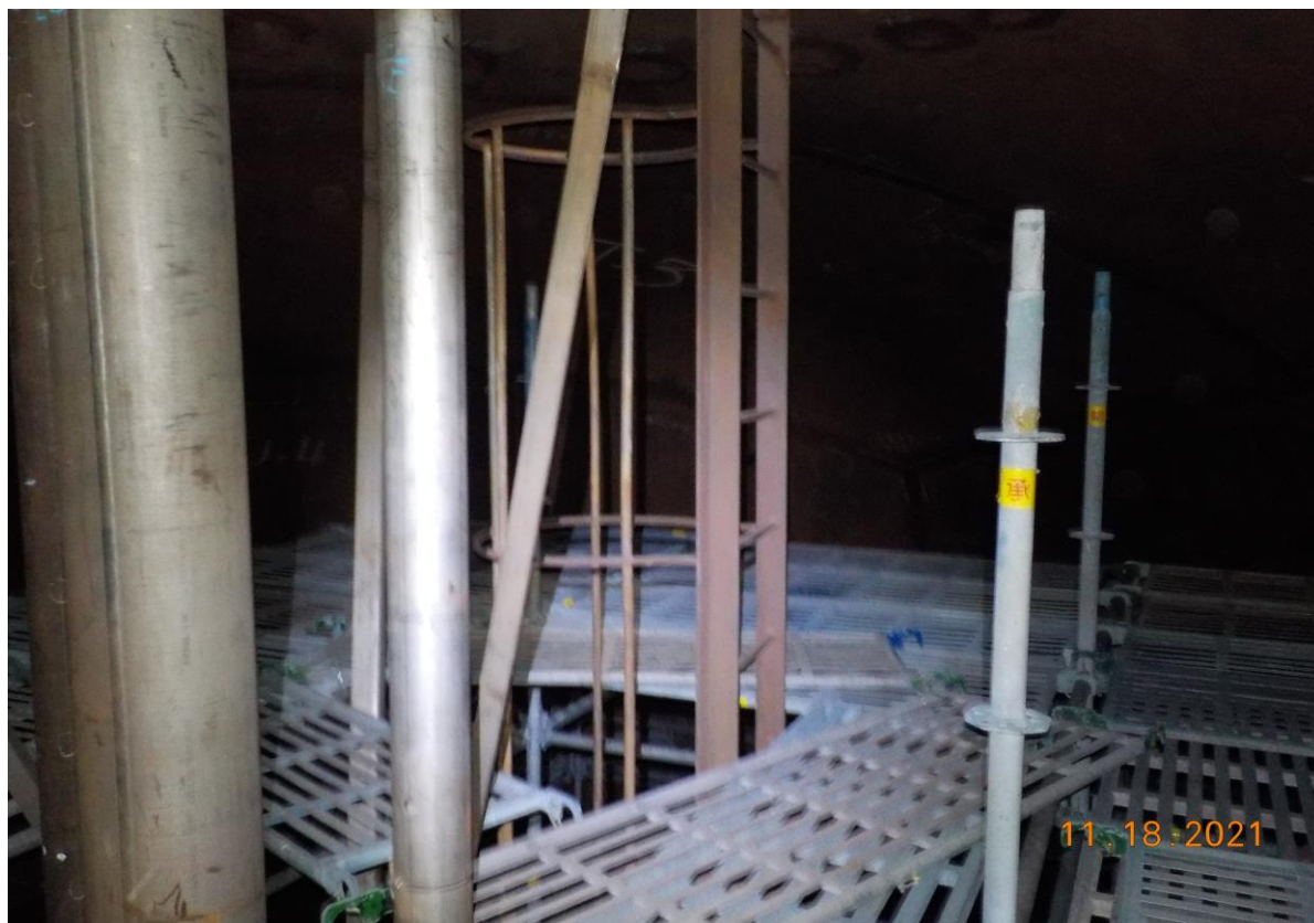
7. 槽內搭架作業情形(3)
