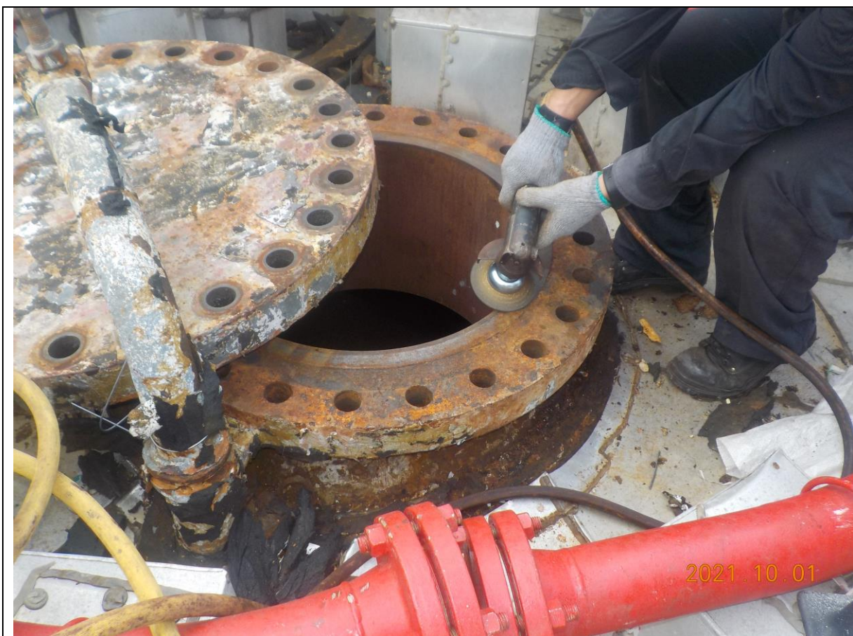
11. 人孔復原前法蘭面整理
