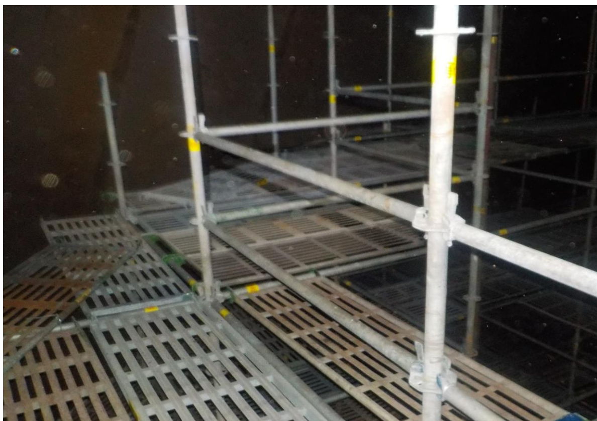
8. 槽內搭架作業情形(4)
