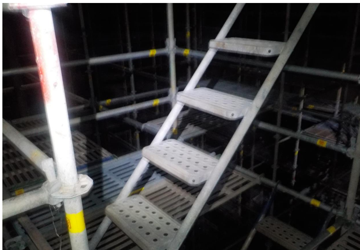
5. 槽內搭架作業情形(1)
