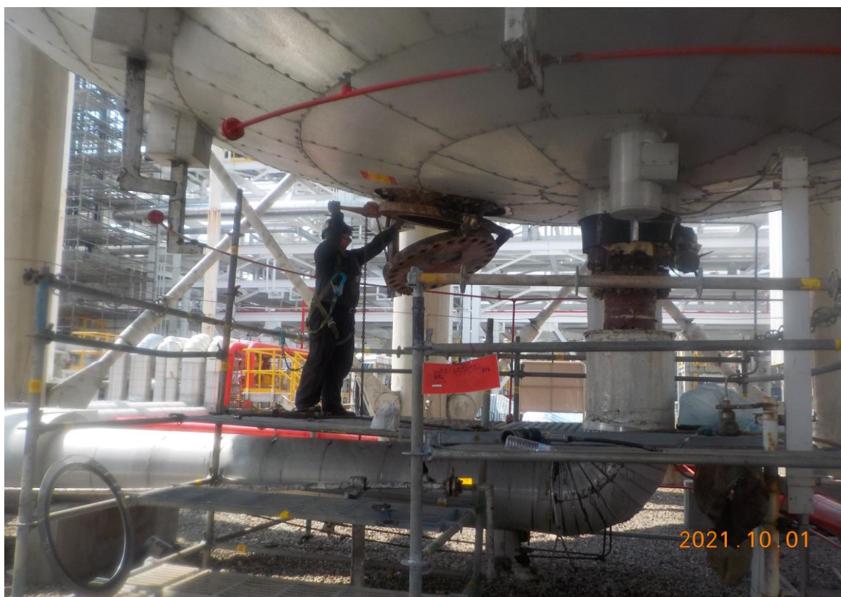
3. 槽外人孔搭架情形
