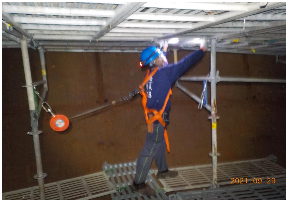
6. 槽內搭架作業情形(2)
