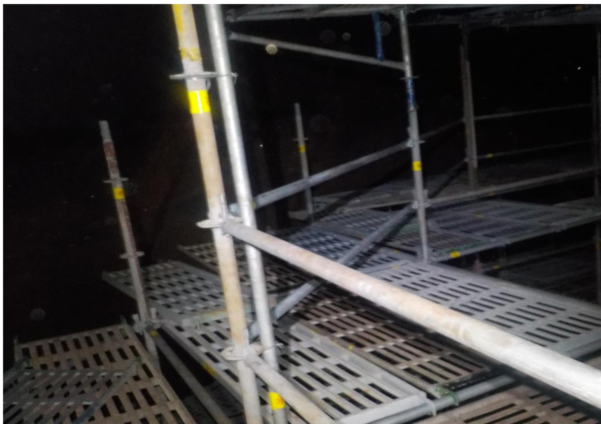
7. 槽內搭架作業情形(3)
