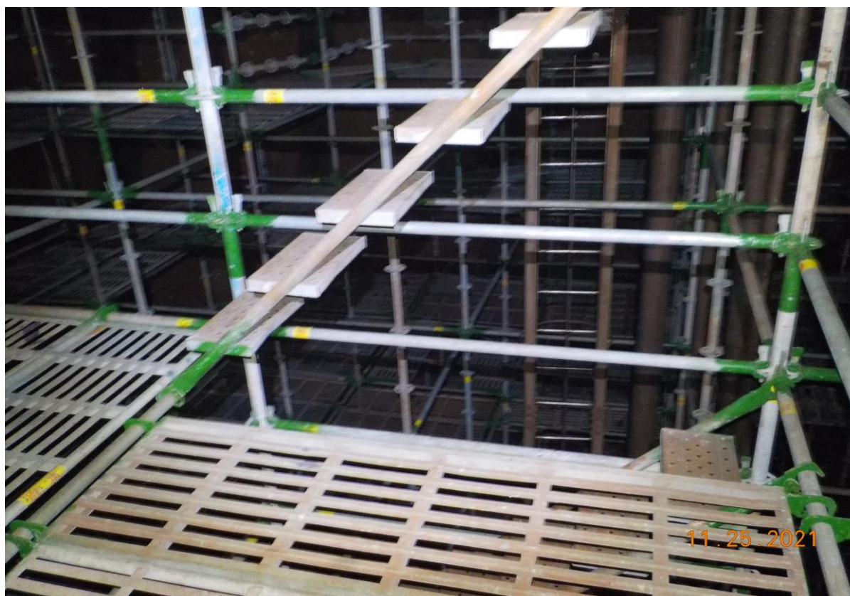
5. 槽內搭架作業情形(1)
