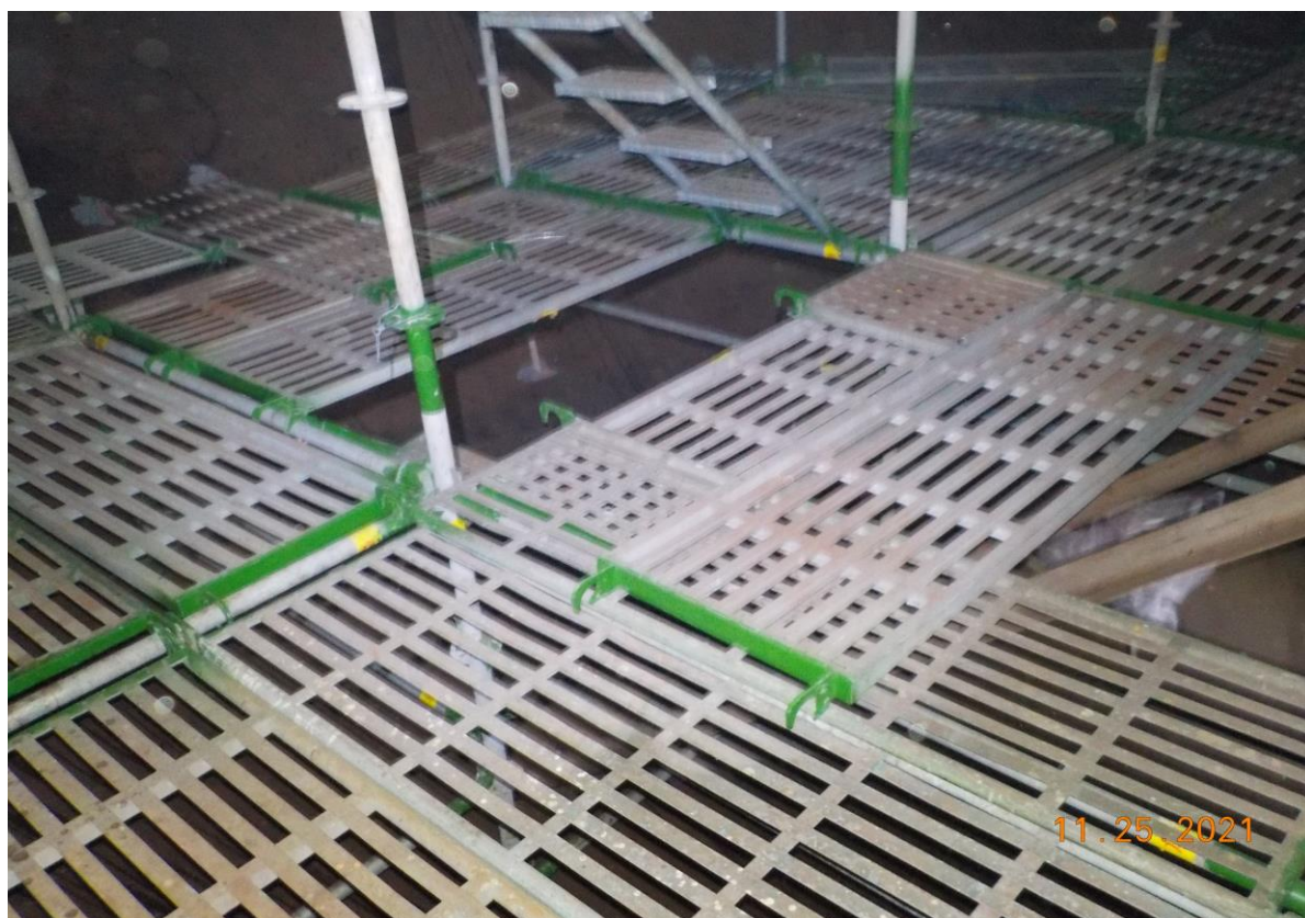
8. 槽內搭架作業情形(4)
