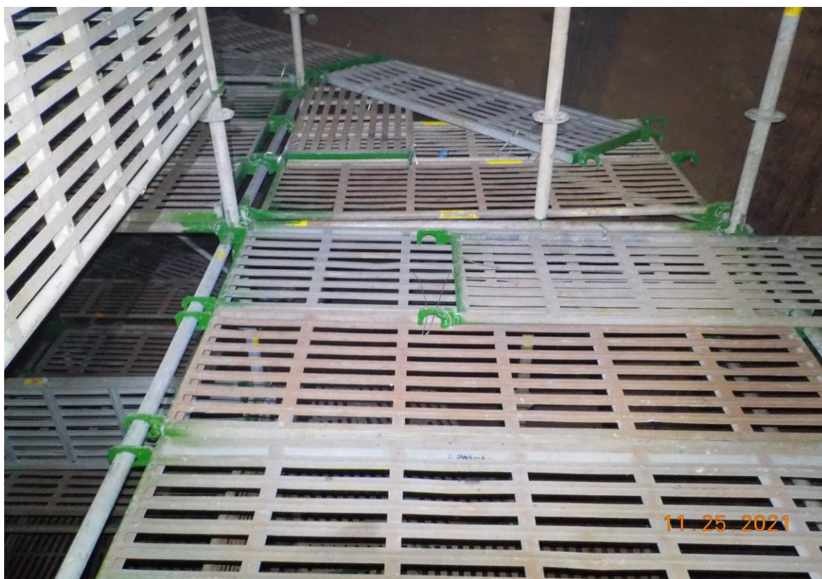
6. 槽內搭架作業情形(2)
