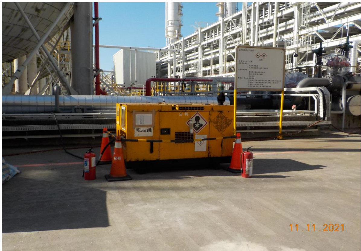
4. 空壓機定位情形
