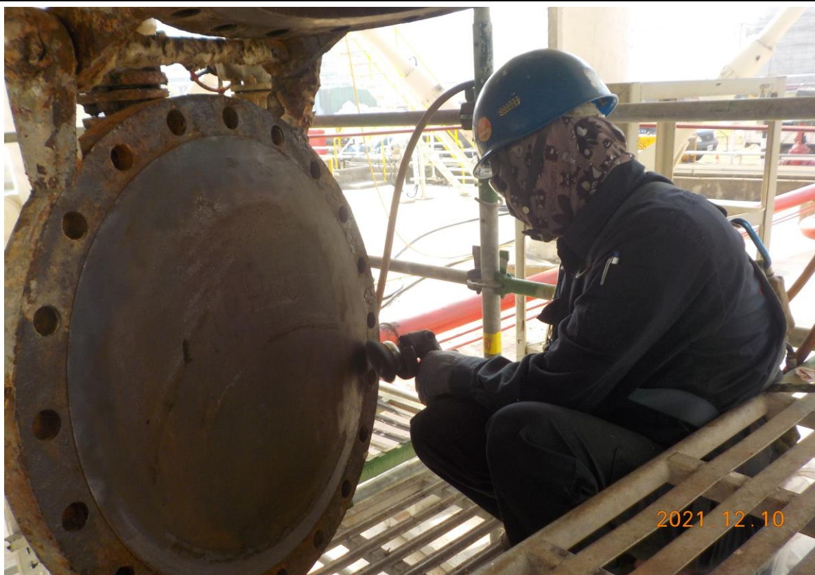
11. 人孔復原前法蘭面整理
