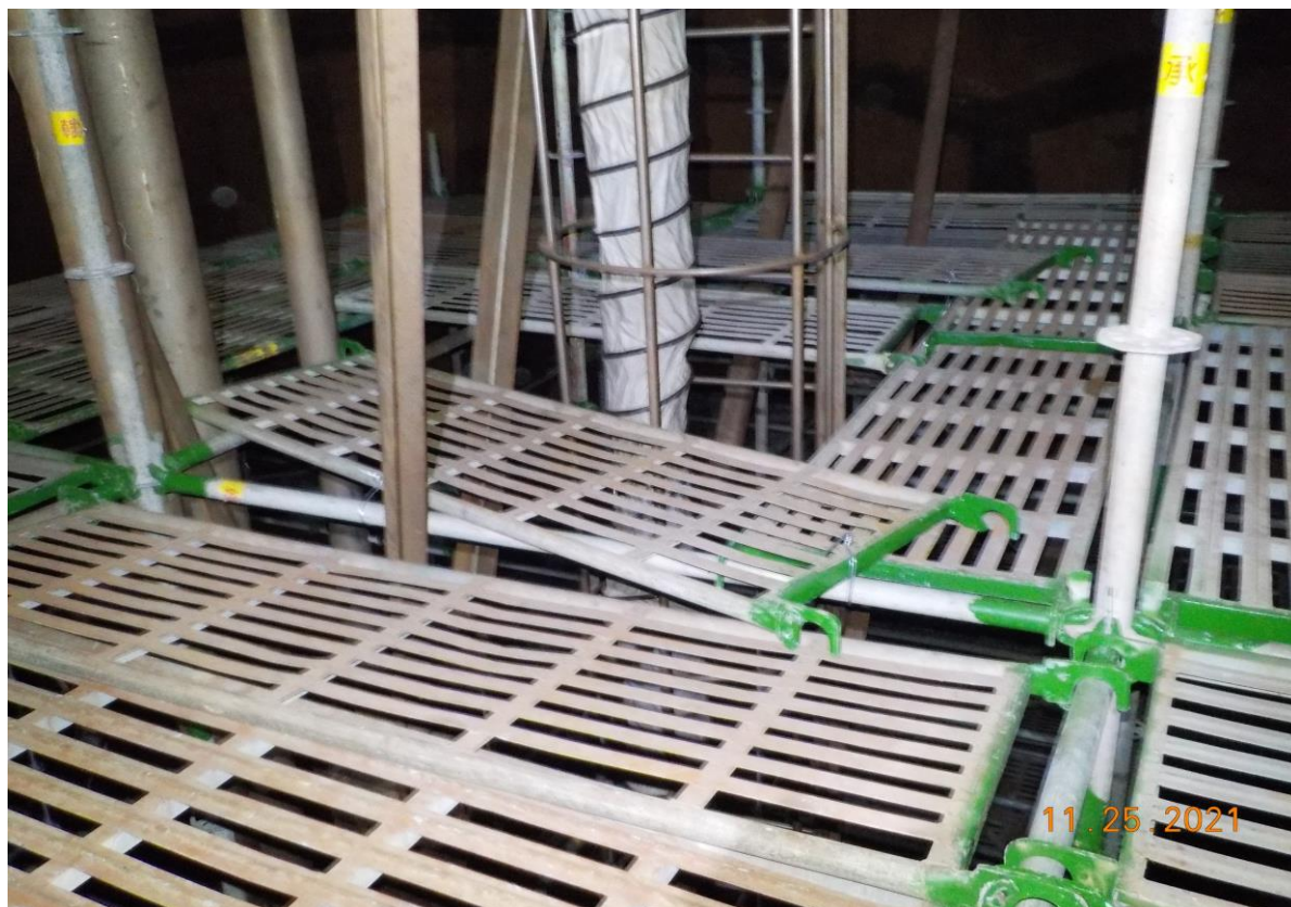
7. 槽內搭架作業情形(3)
