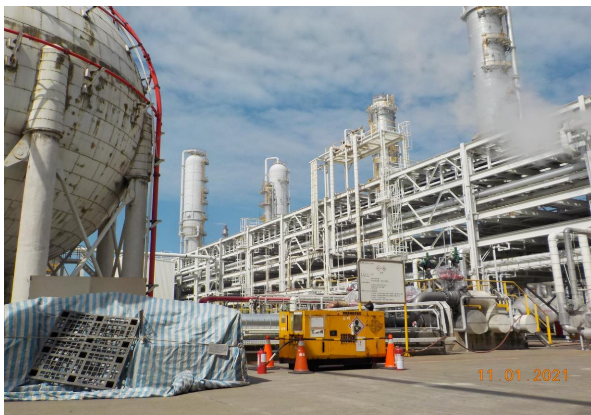
2. 空壓機定位情形
