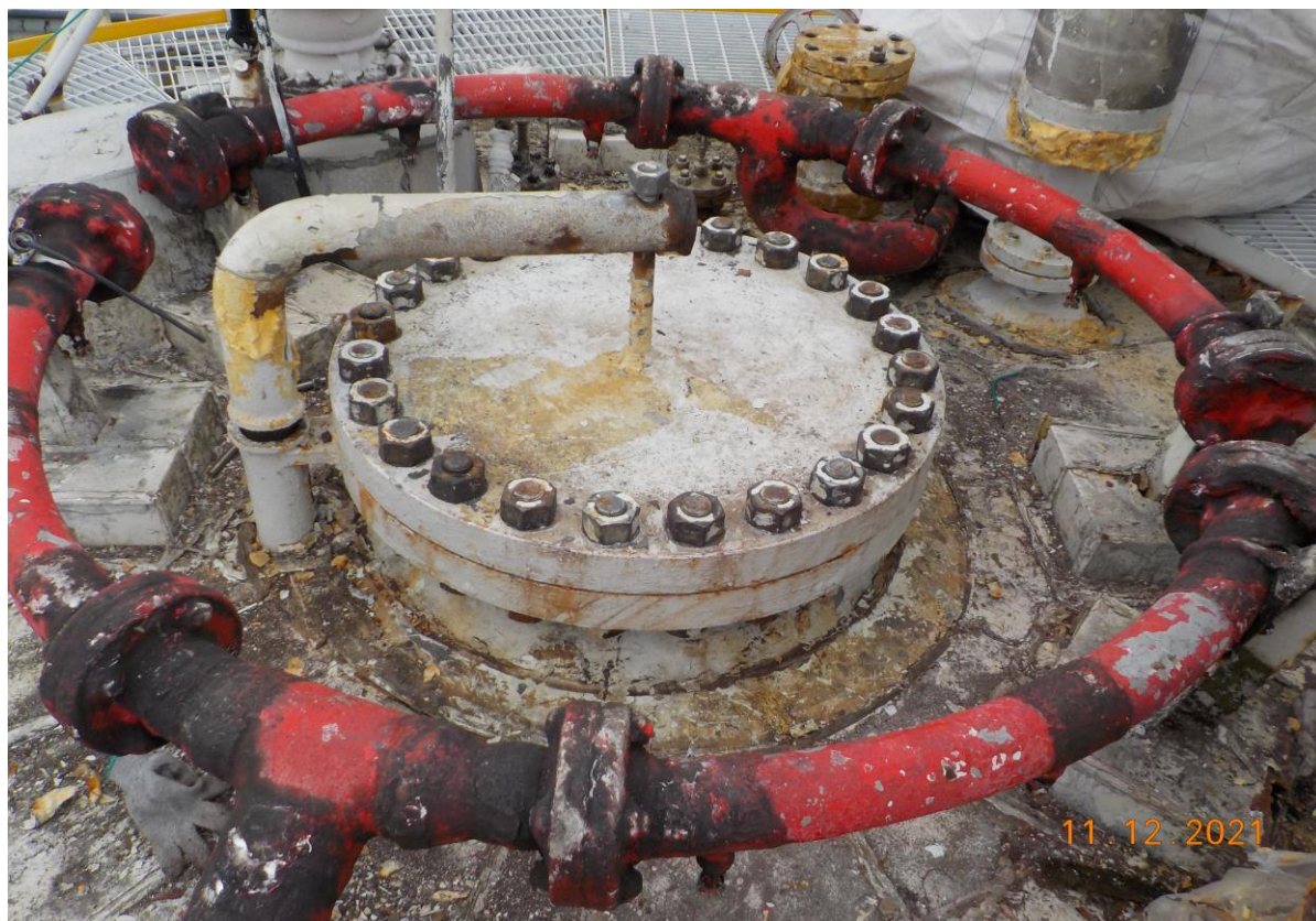
9. 上人孔復原完成
