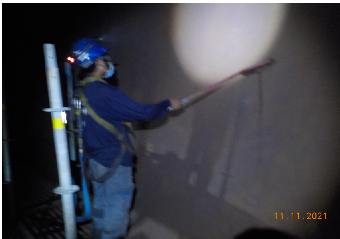
7. 槽內清掃情形
