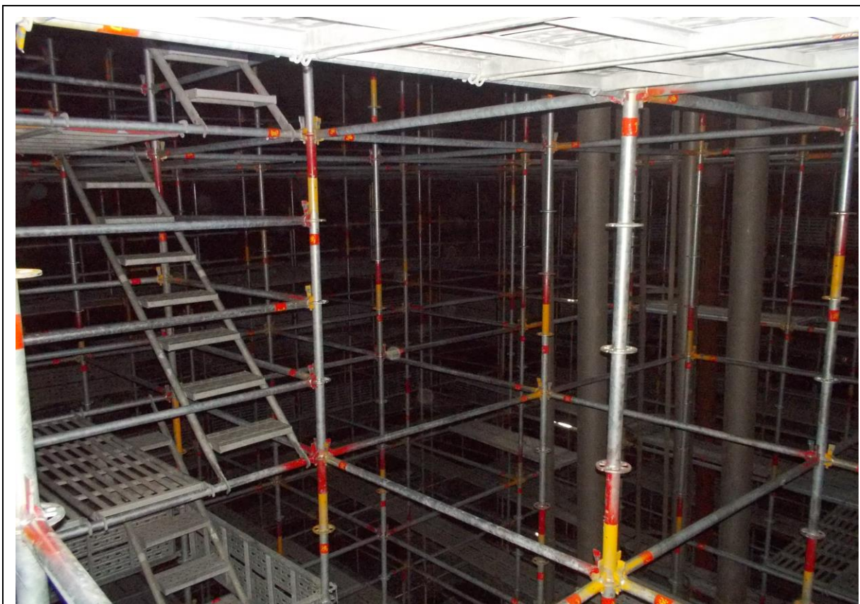
7. 槽內搭架作業情形(3)
