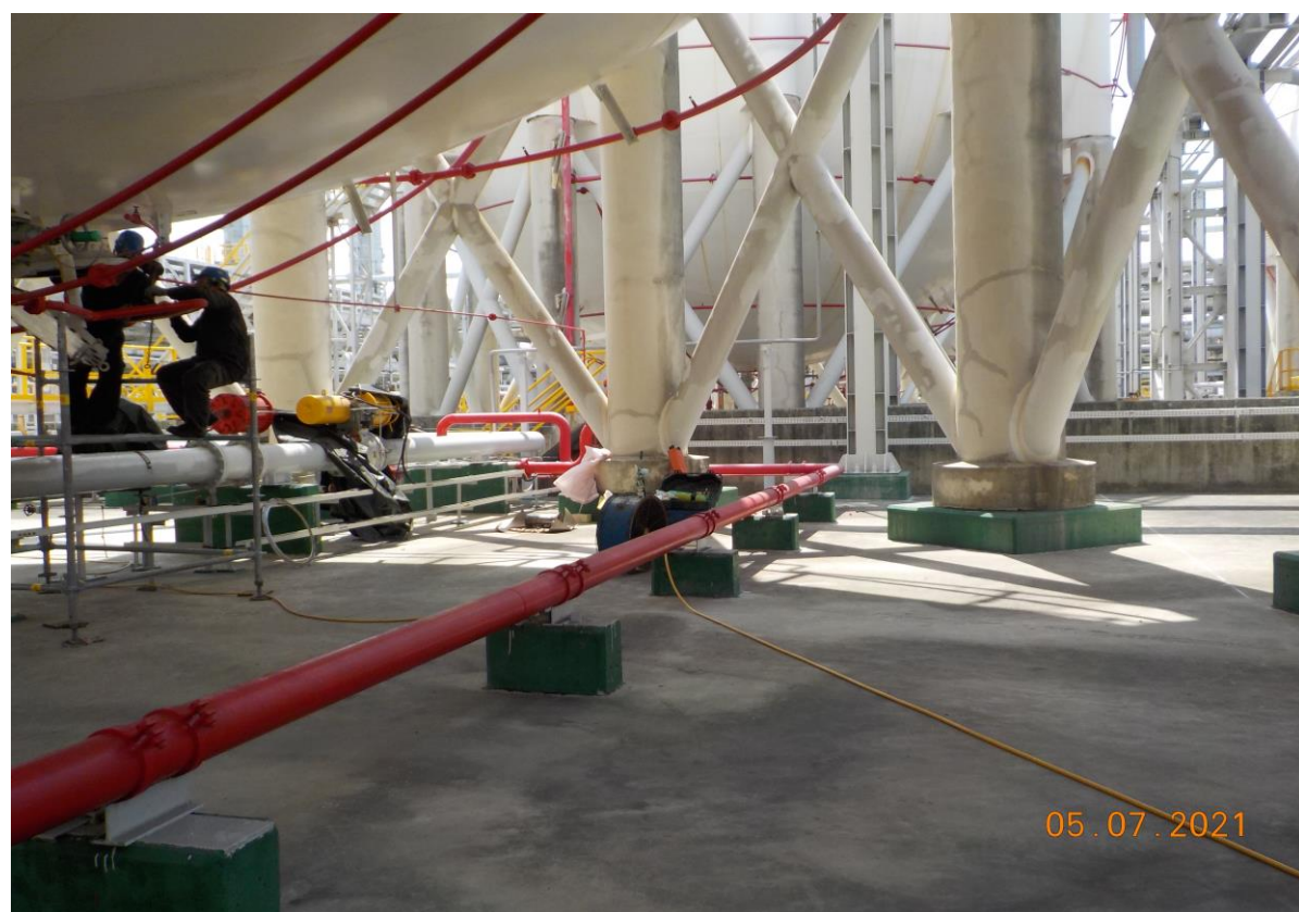
2. 通風器材定位情形
