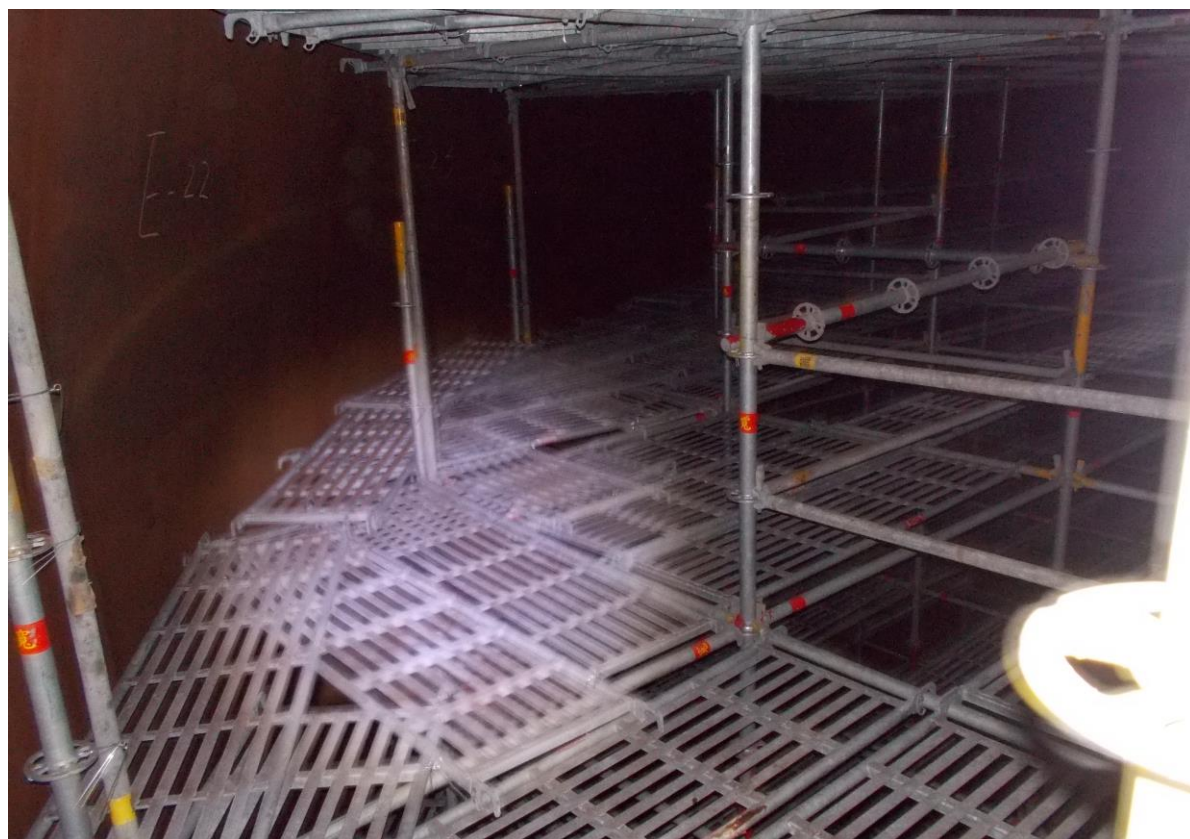
6. 槽內搭架作業情形(2)
