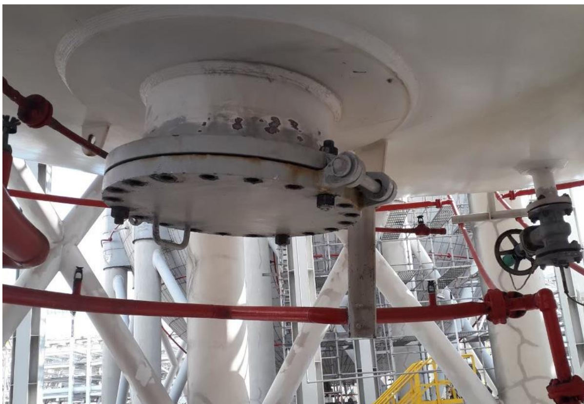
12. 下人孔回裝作業
