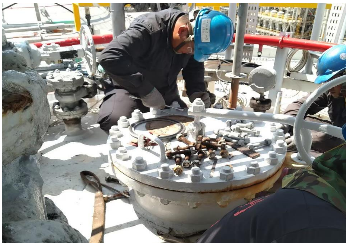
11. 上人孔回裝作業
