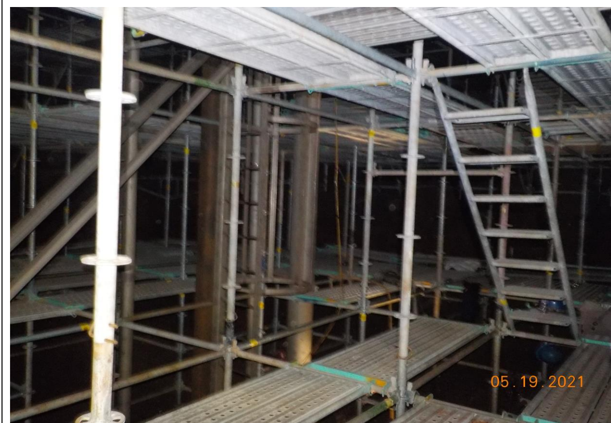
8. 槽內清掃作業(1)
