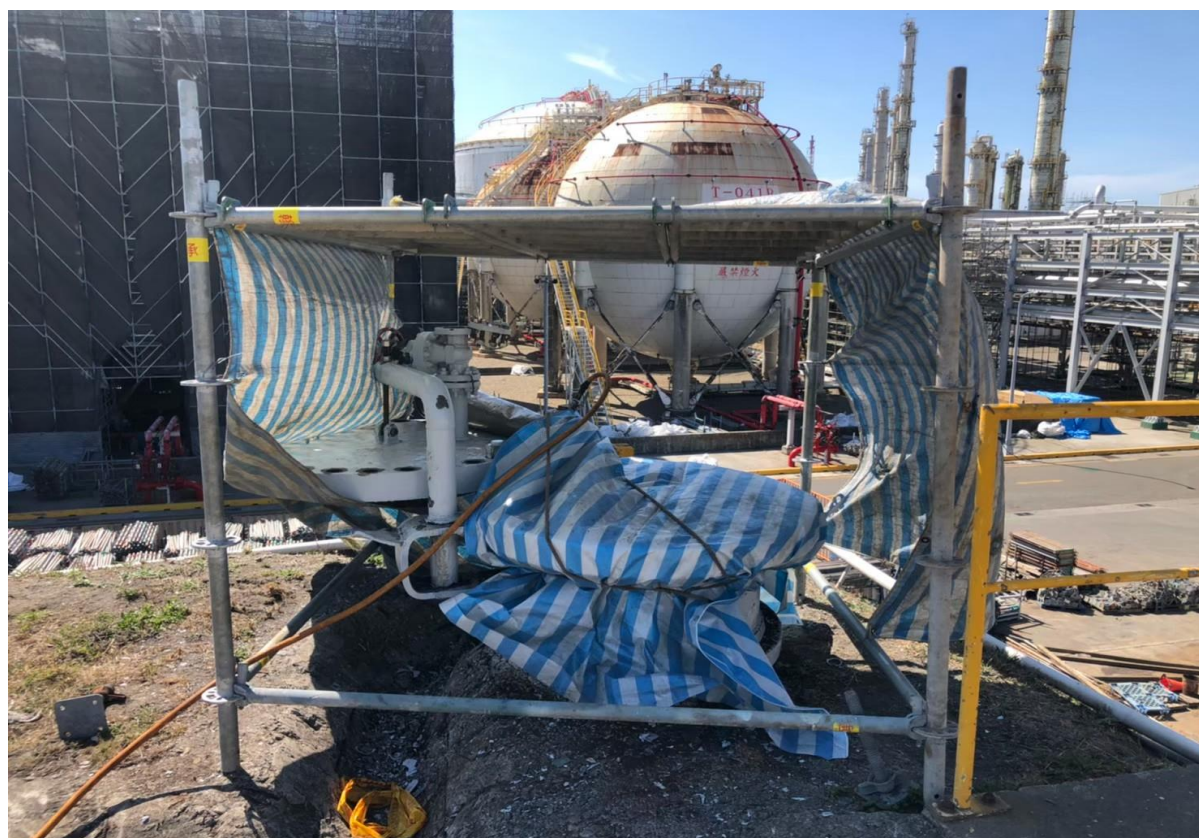
3. 槽外人孔搭架情形
