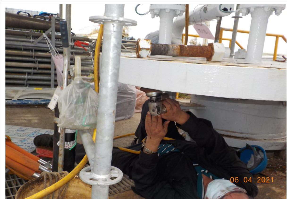
13. 人孔復原前法蘭面整理(2)
