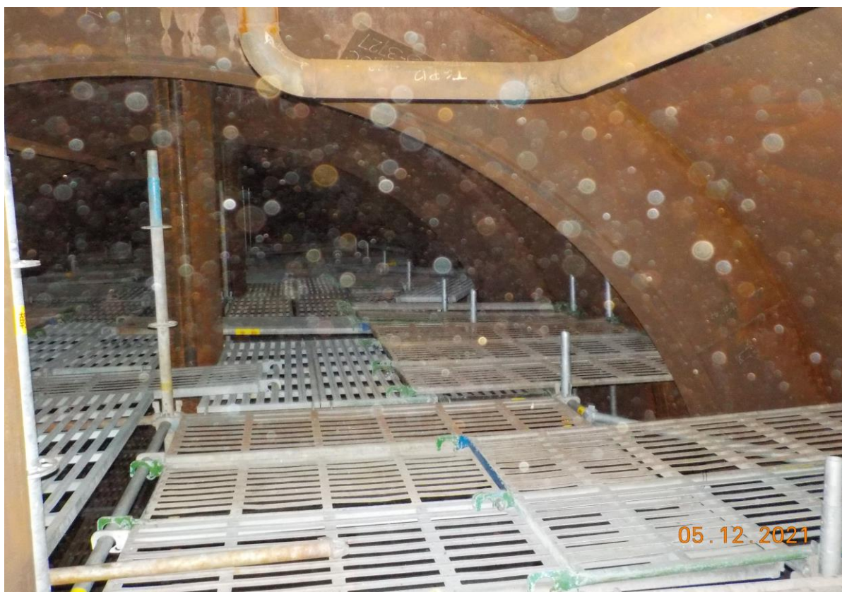
5. 槽內搭架作業情形(1)
