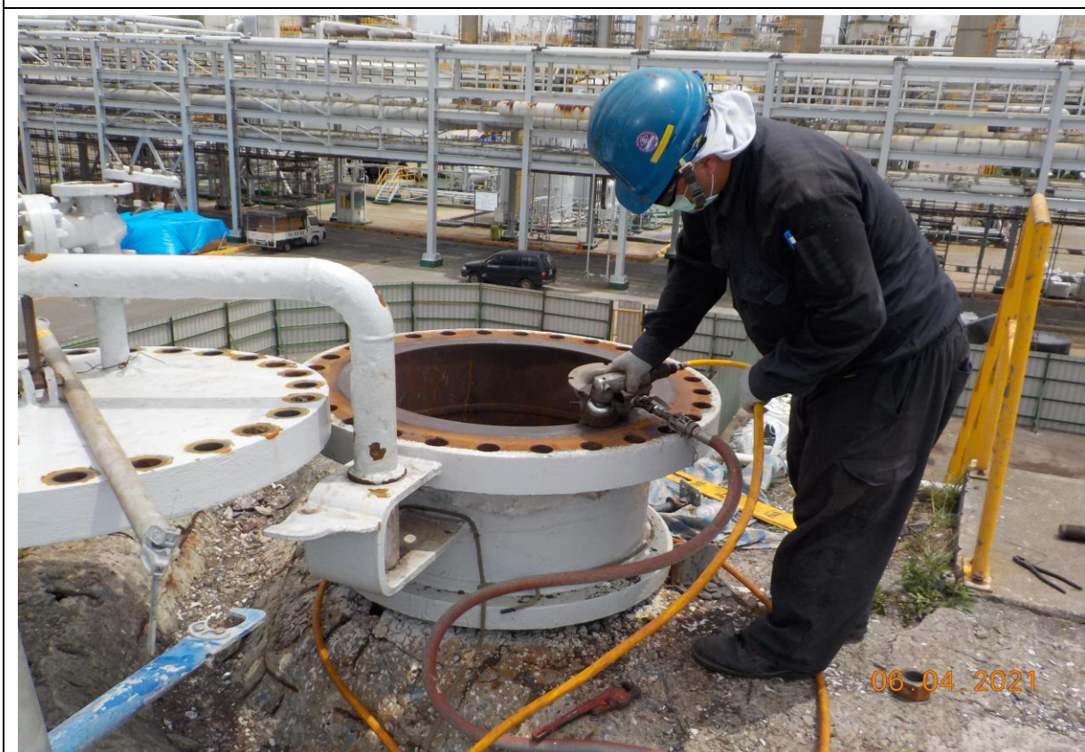
12. 人孔復原前法蘭面整理(1)
