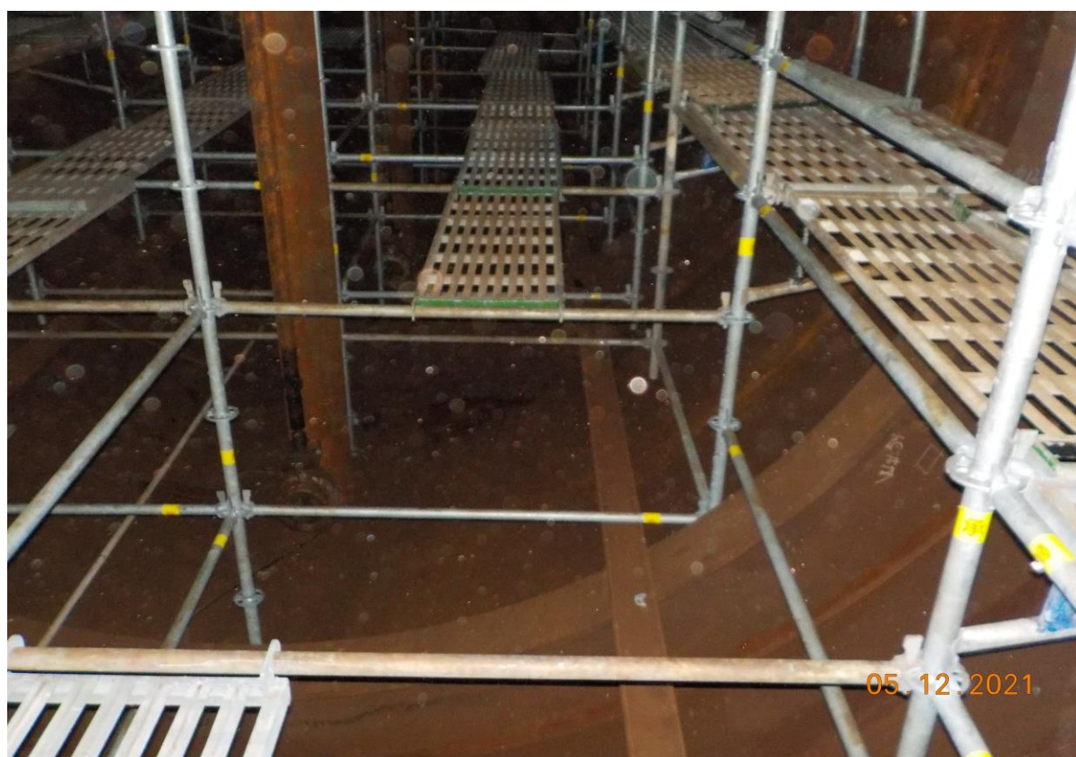
6. 槽內搭架作業情形(2)
