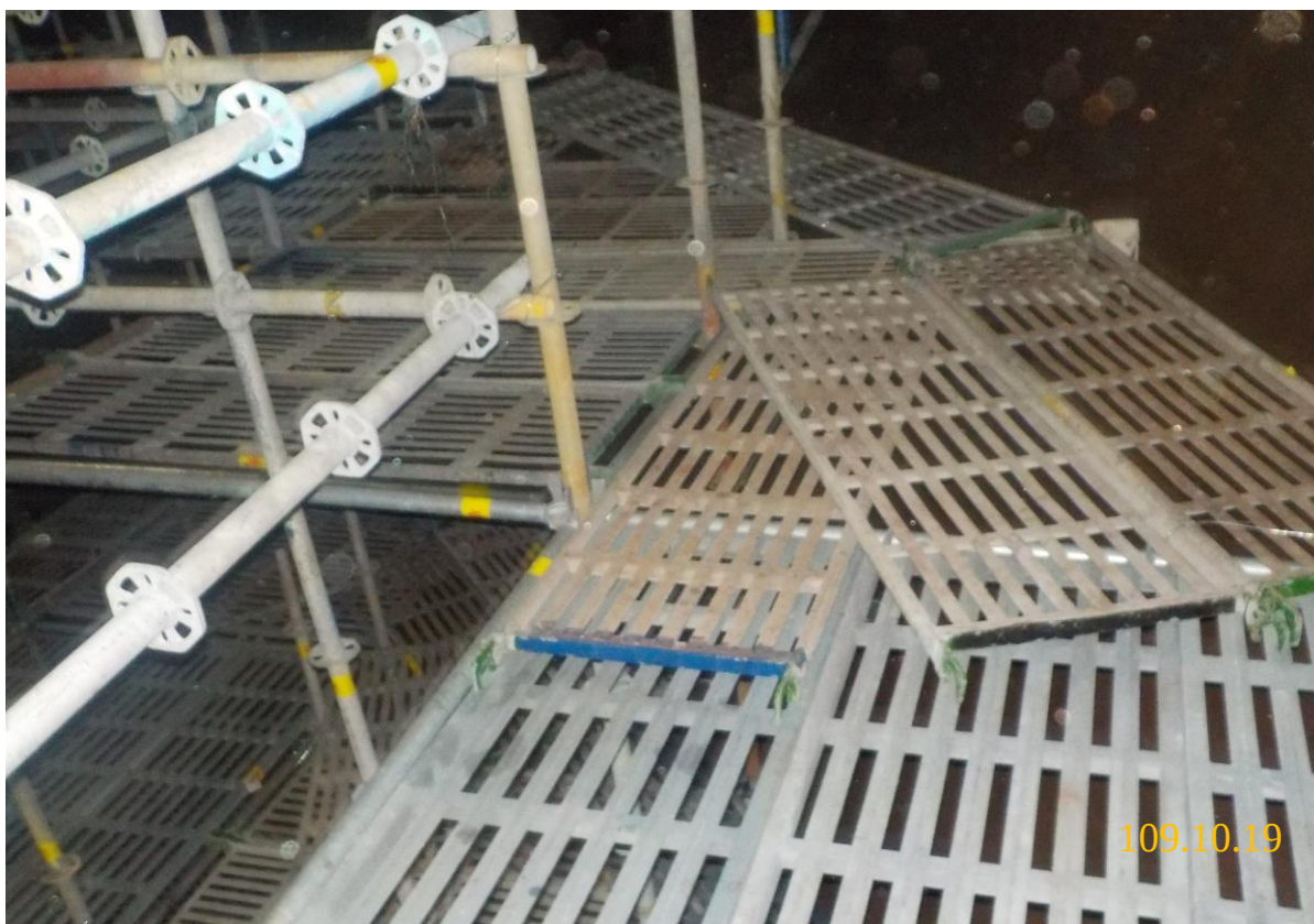
6. 槽內搭架作業情形(3)
