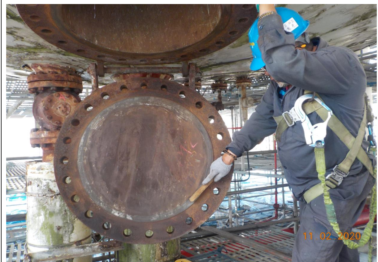
10. 人孔法蘭面整理(2)
