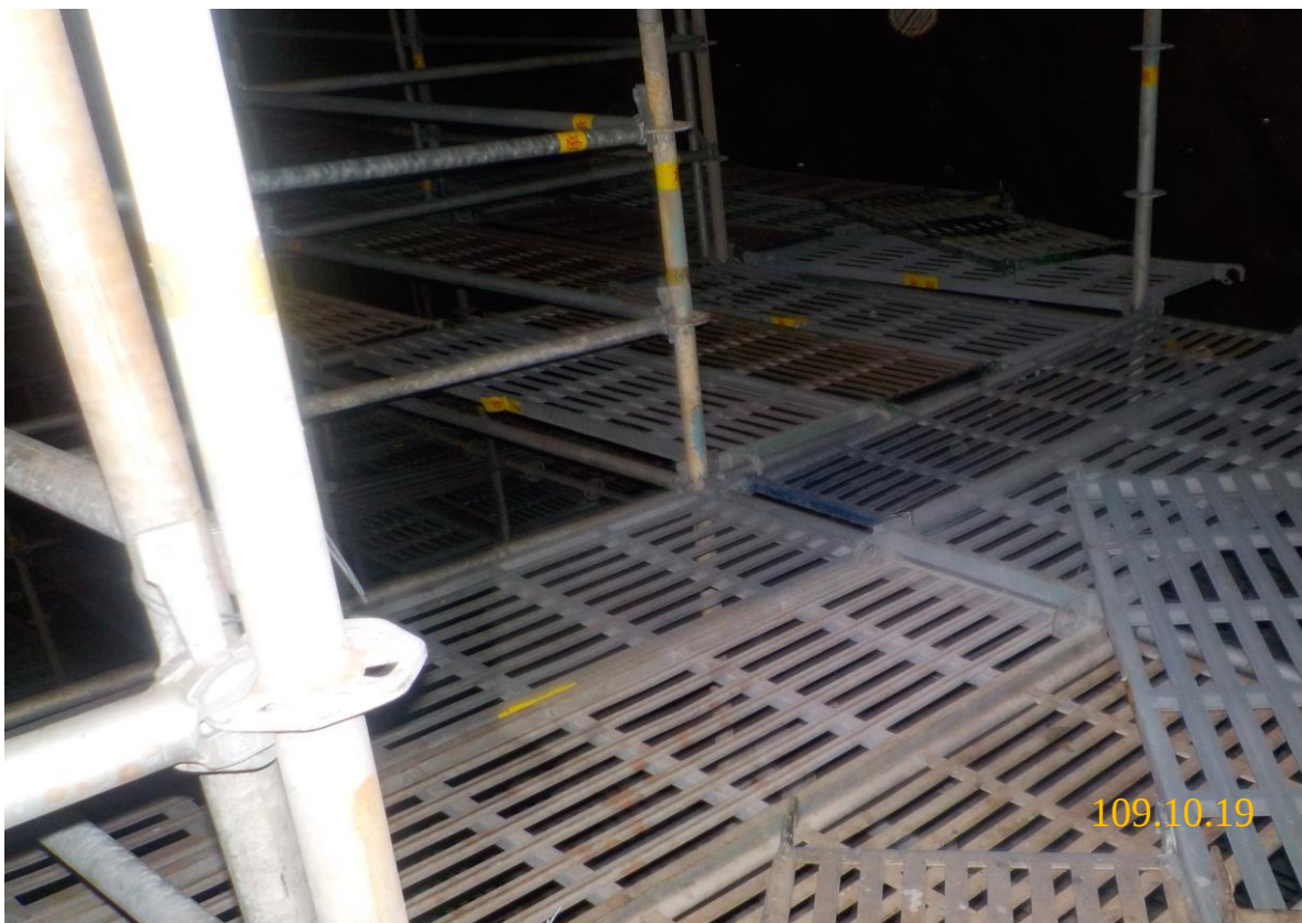
5. 槽內搭架作業情形(2)
