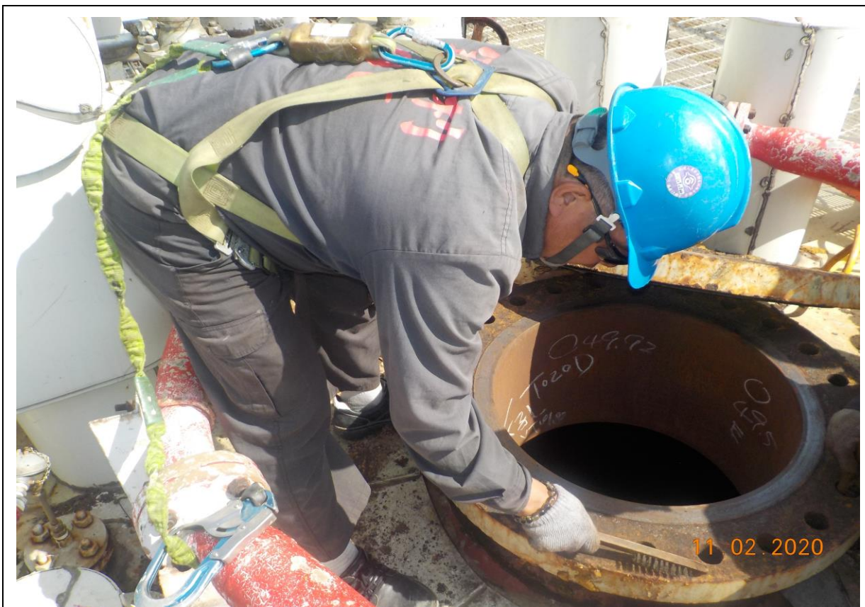
9. 人孔法蘭面整理(1)
