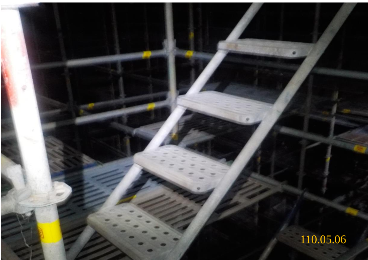
5. 槽內搭架作業情形(3)
