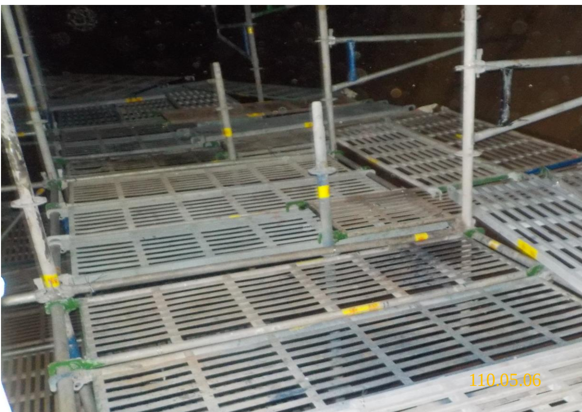
6. 槽內搭架作業情形(4)
