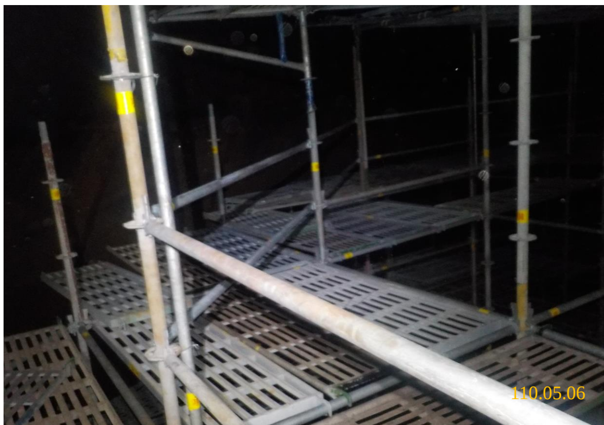
3. 槽內搭架作業情形(1)
