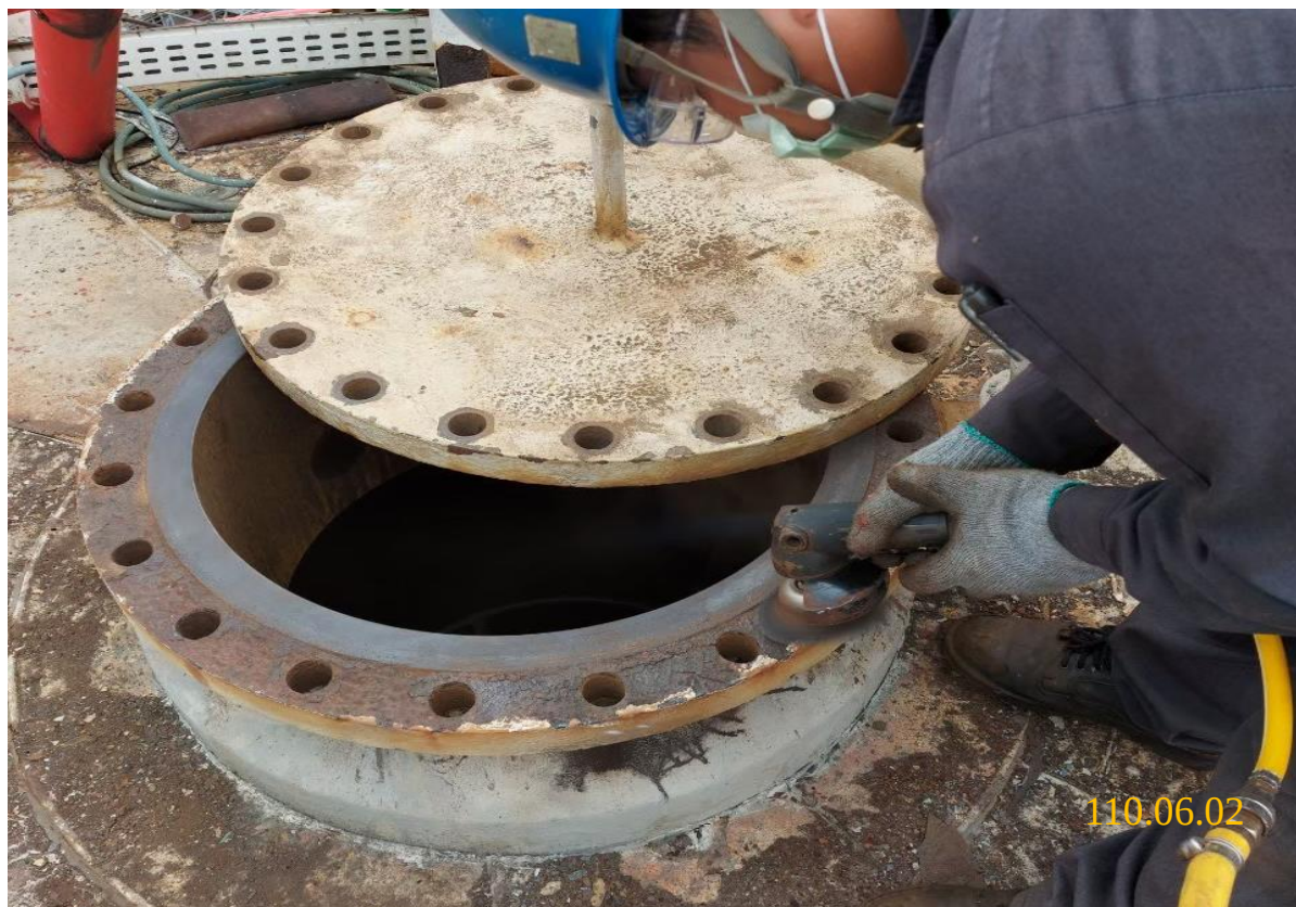
9. 上人孔復原前法蘭面整理
