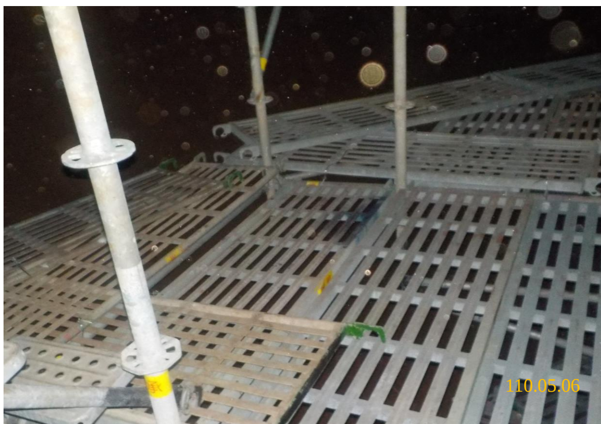
4. 槽內搭架作業情形(2)
