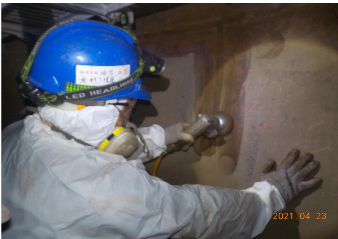
12. 人員進行焊道研磨作業(2)
