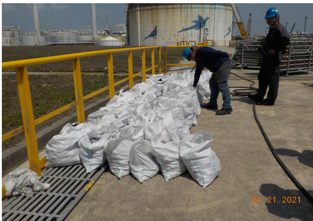
6. 槽內清出之結塊物裝袋情形
