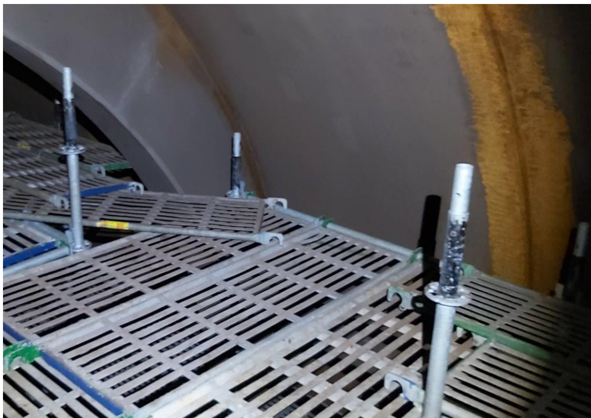
7. 槽內搭架作業情形(1)
