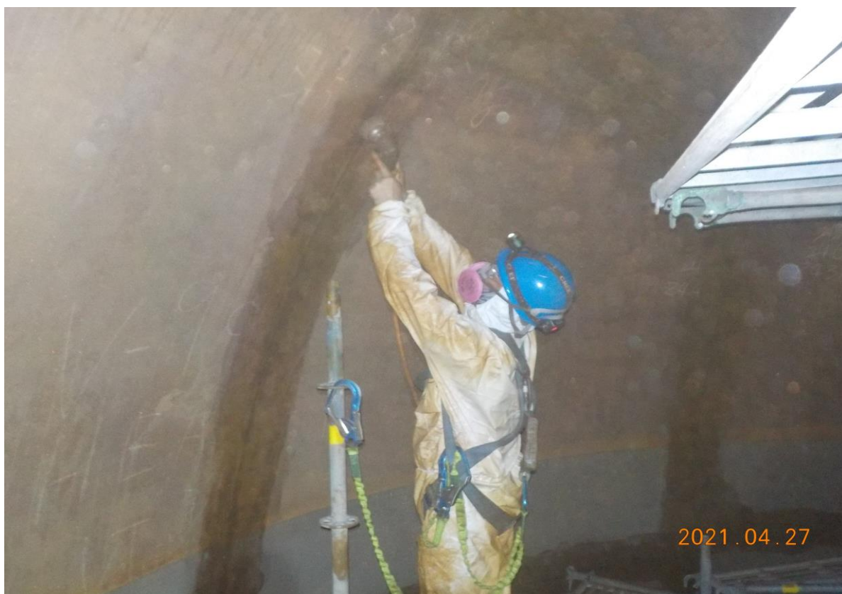
13. 人員進行焊道研磨作業(3)
