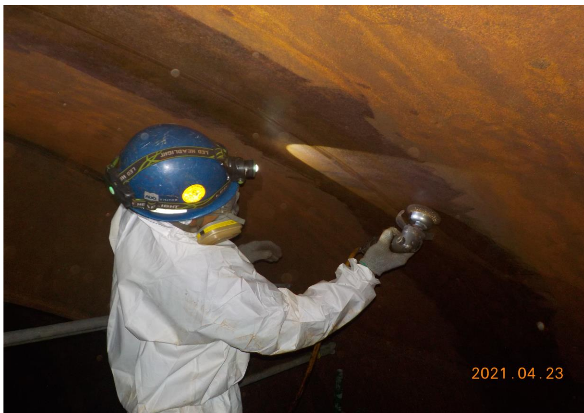
11. 人員進行焊道研磨作業(1)
