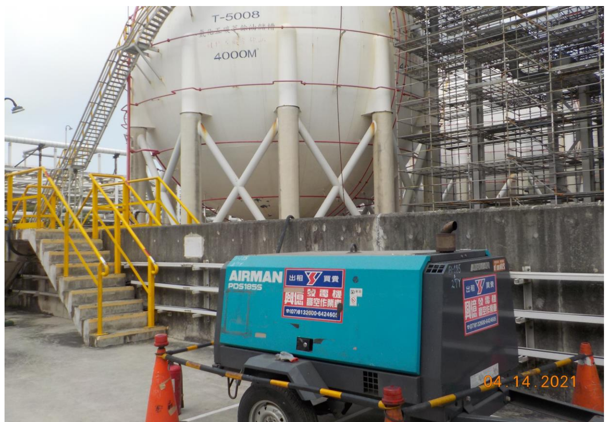
4. 空壓機定位情形
