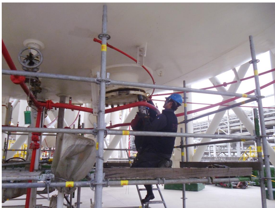
10. 人孔復原作業(1)
