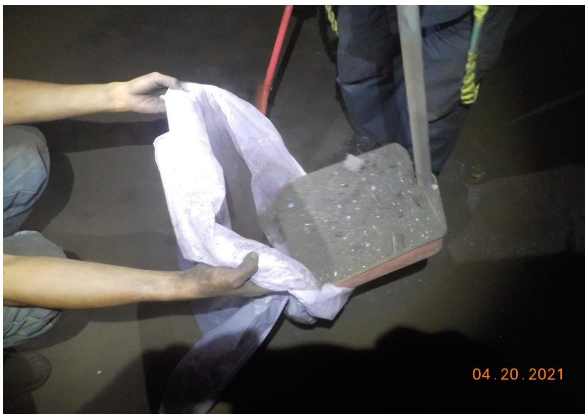
9. 槽內清掃作業(2)
