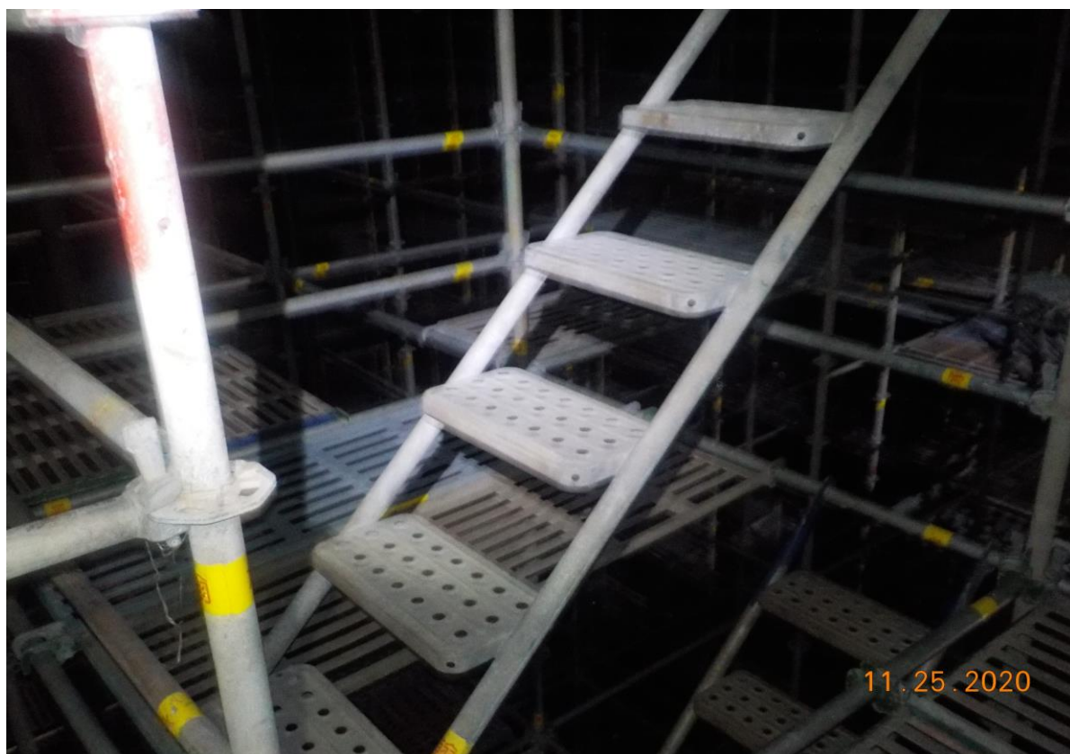
7. 槽內搭架作業情形(3)
