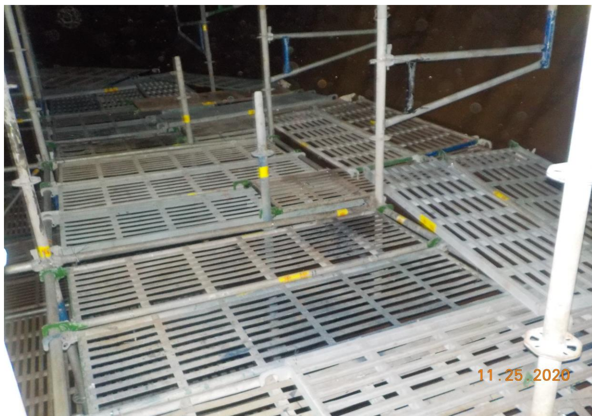
5. 槽內搭架作業情形(1)
