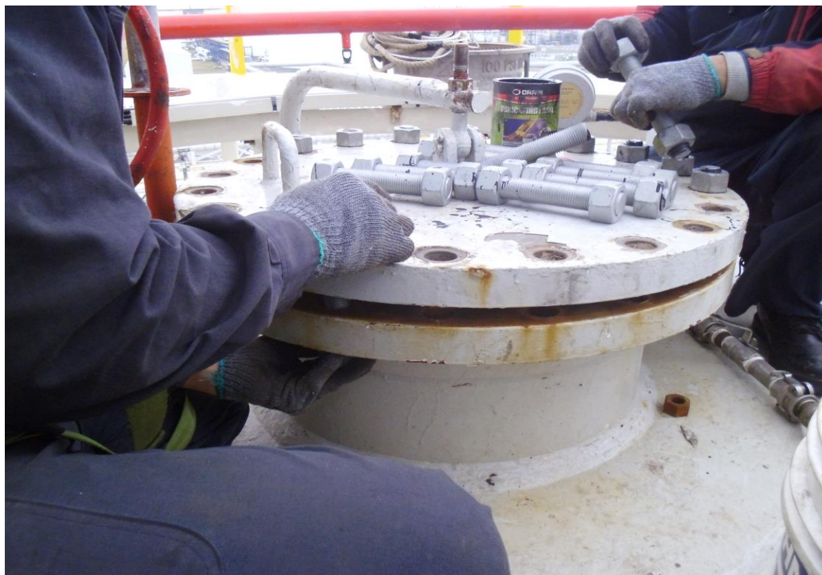
11. 上人孔回裝前法蘭面整理
