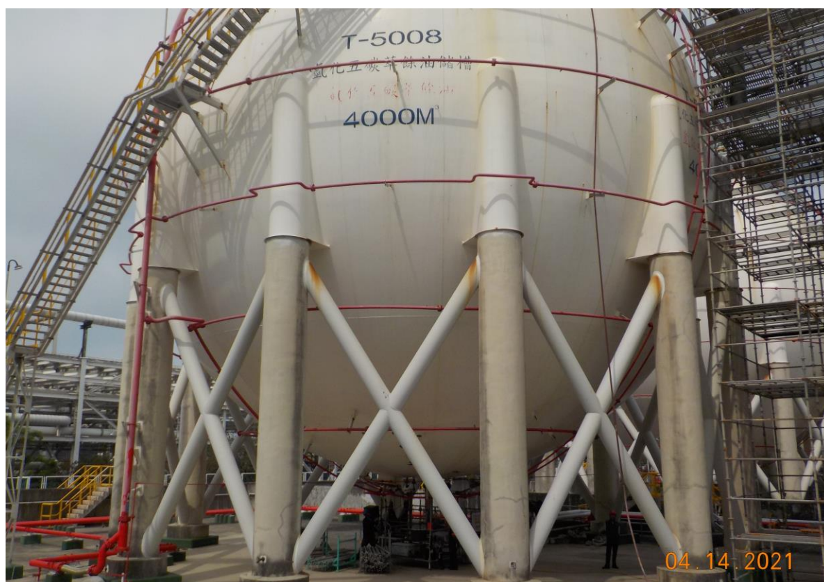
12. 上人孔回裝作業
