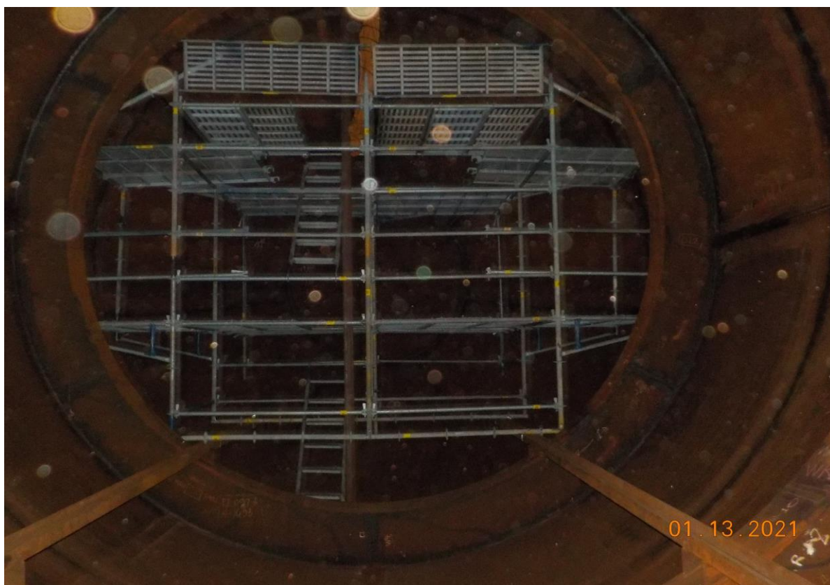
10. 槽內搭架作業情形(4)
