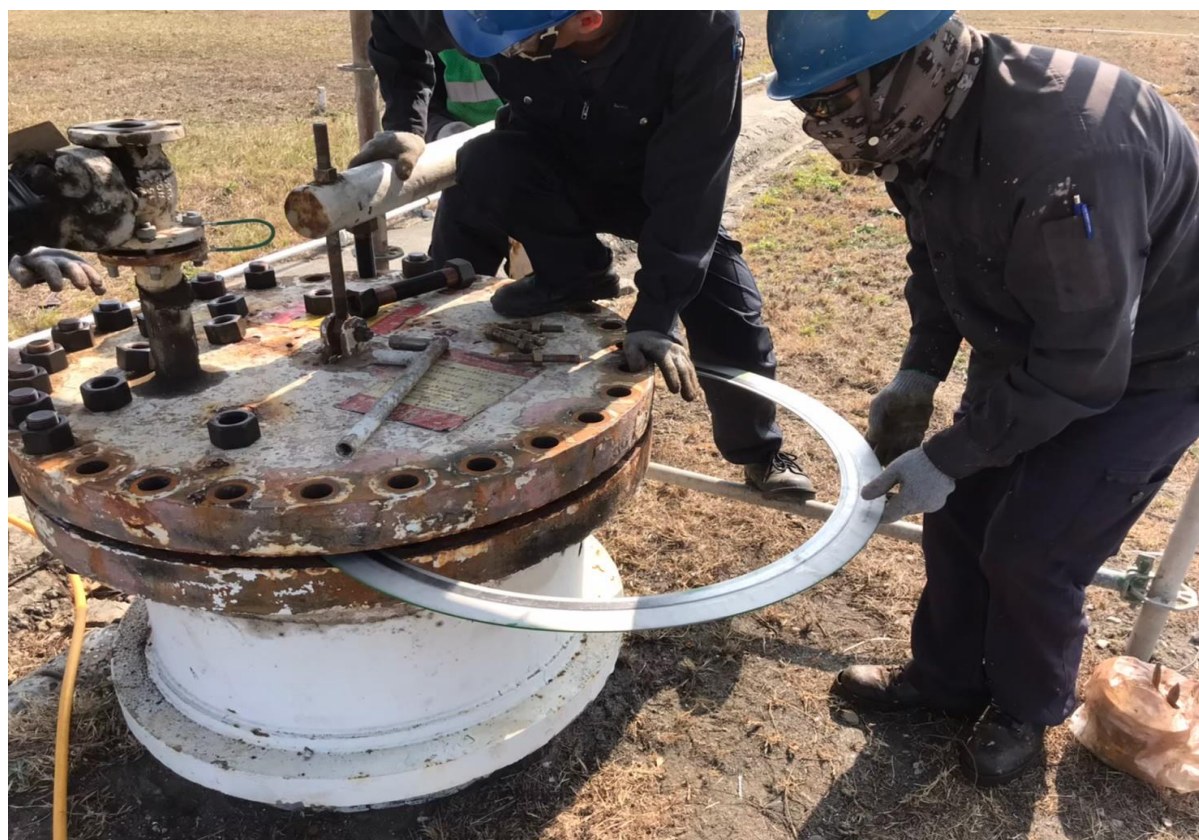
13. 人孔復原之情形(1)
