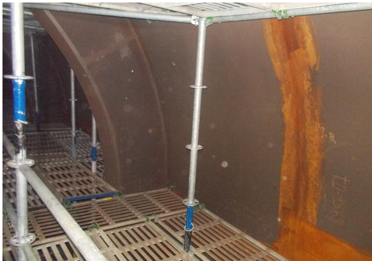
7. 槽內搭架作業情形(1)
