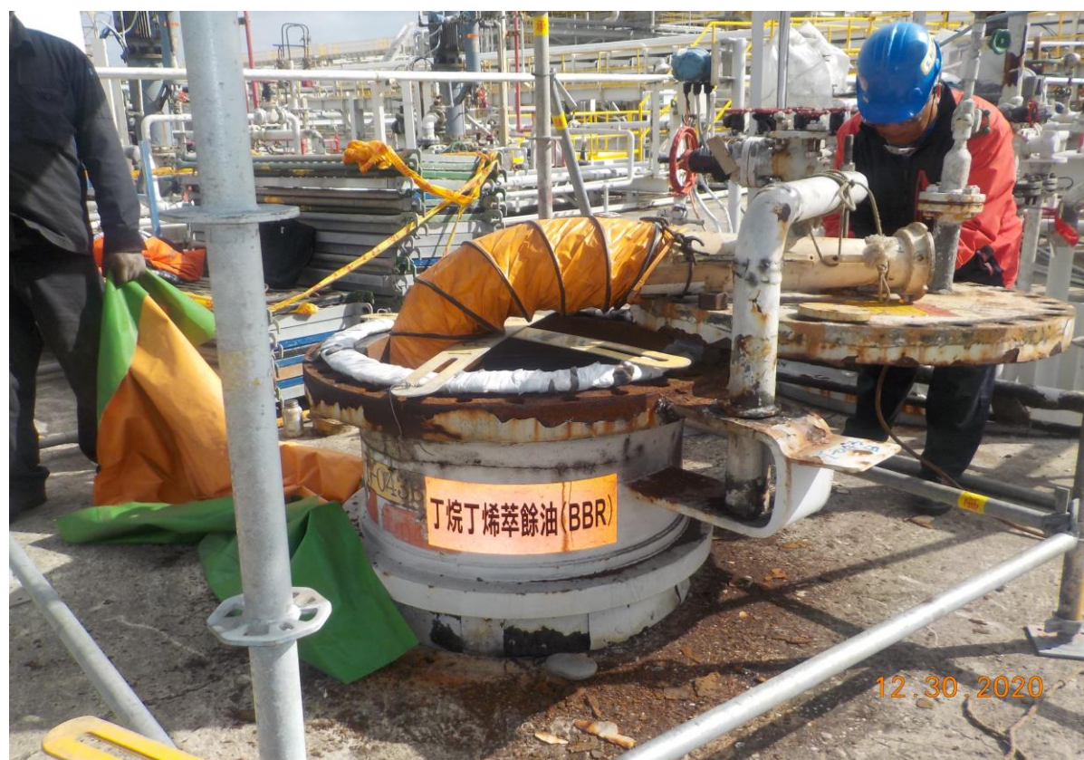
6. 槽外搭架情形
