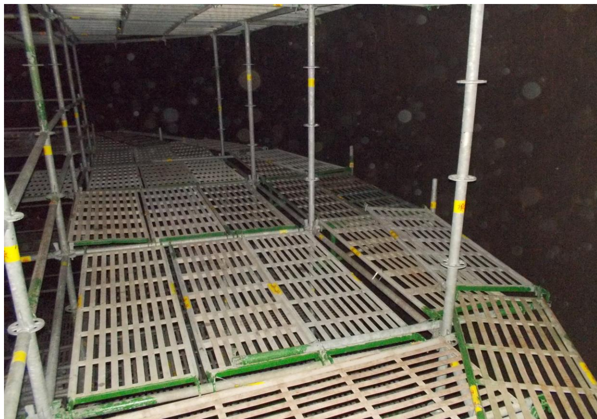
7. 槽內搭架作業情形(4)
