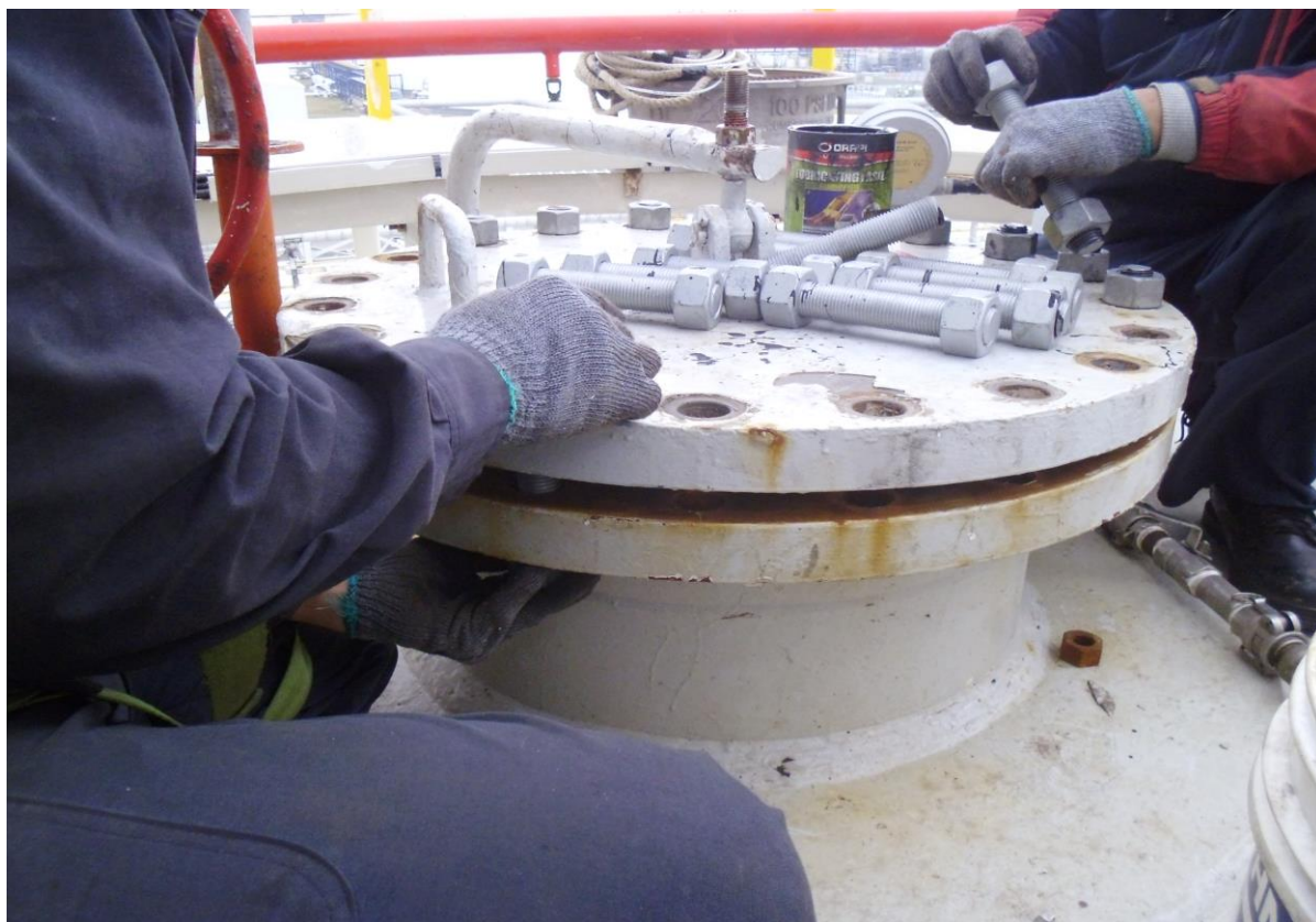
9. 上人孔復原情形
