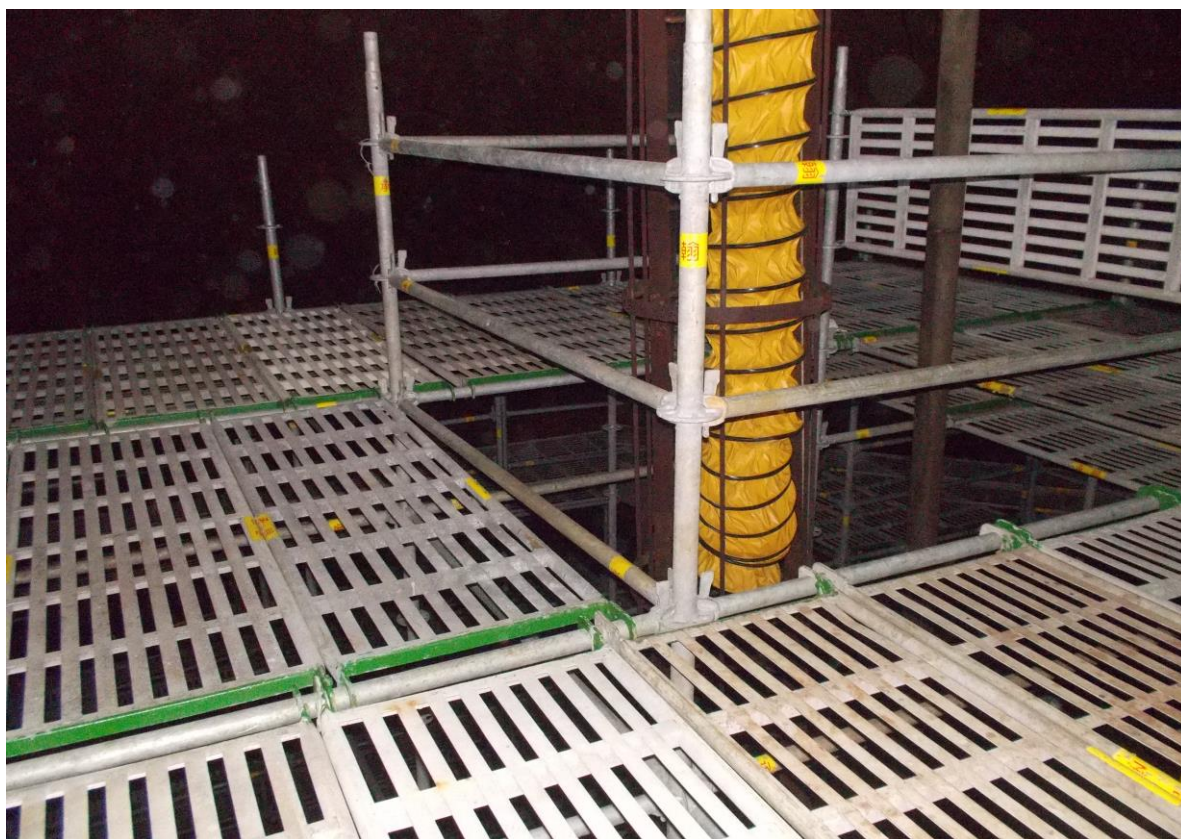
4. 槽內搭架作業情形(1)
