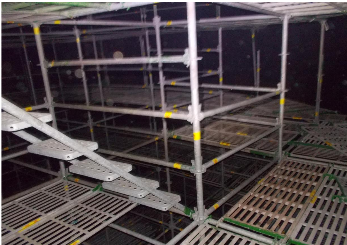
5. 槽內搭架作業情形(2)
