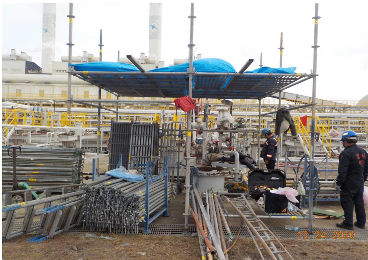
3. 槽外人孔搭架情形
