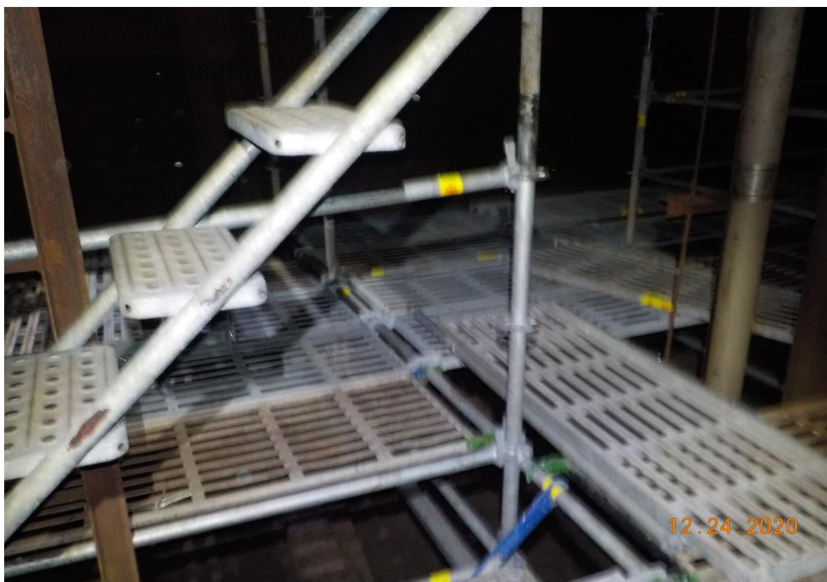
6. 槽內搭架作業情形(2)
