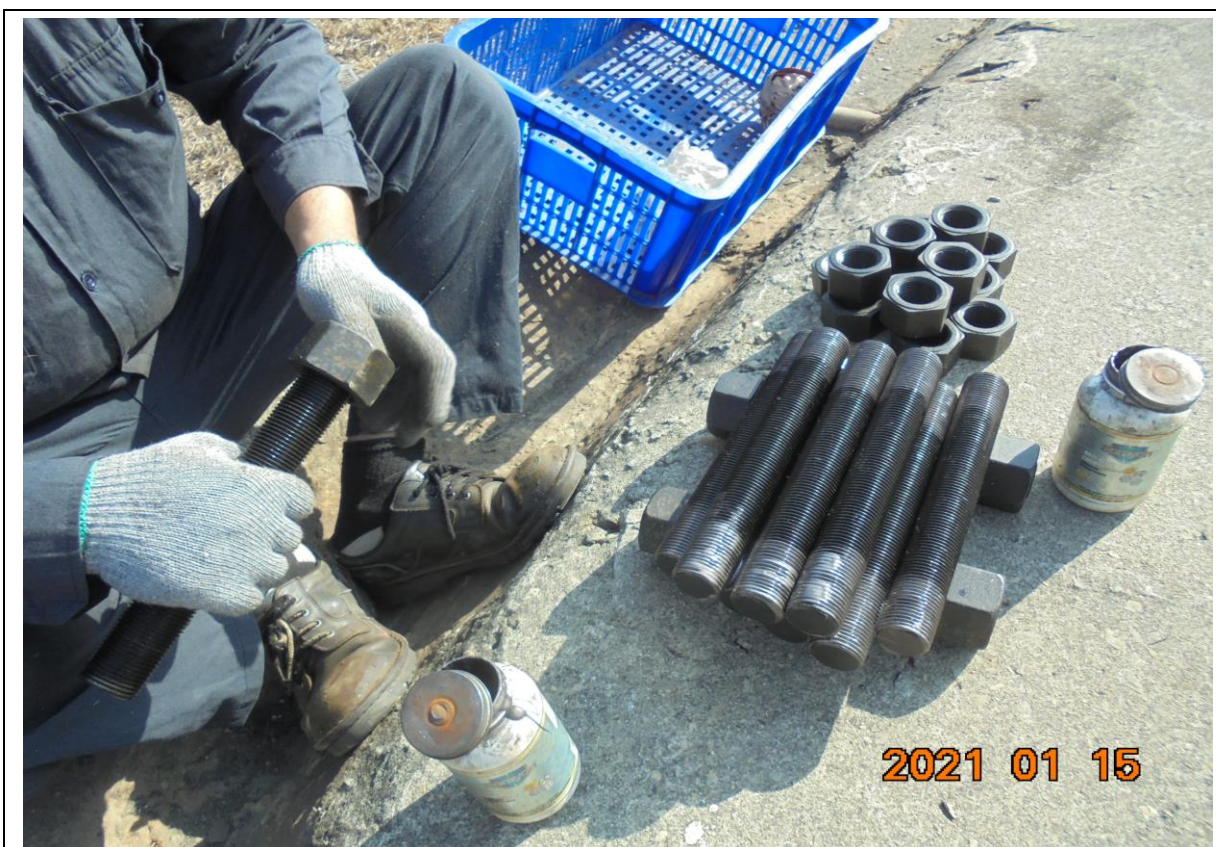
13. 人孔復原前螺絲/栓整理
