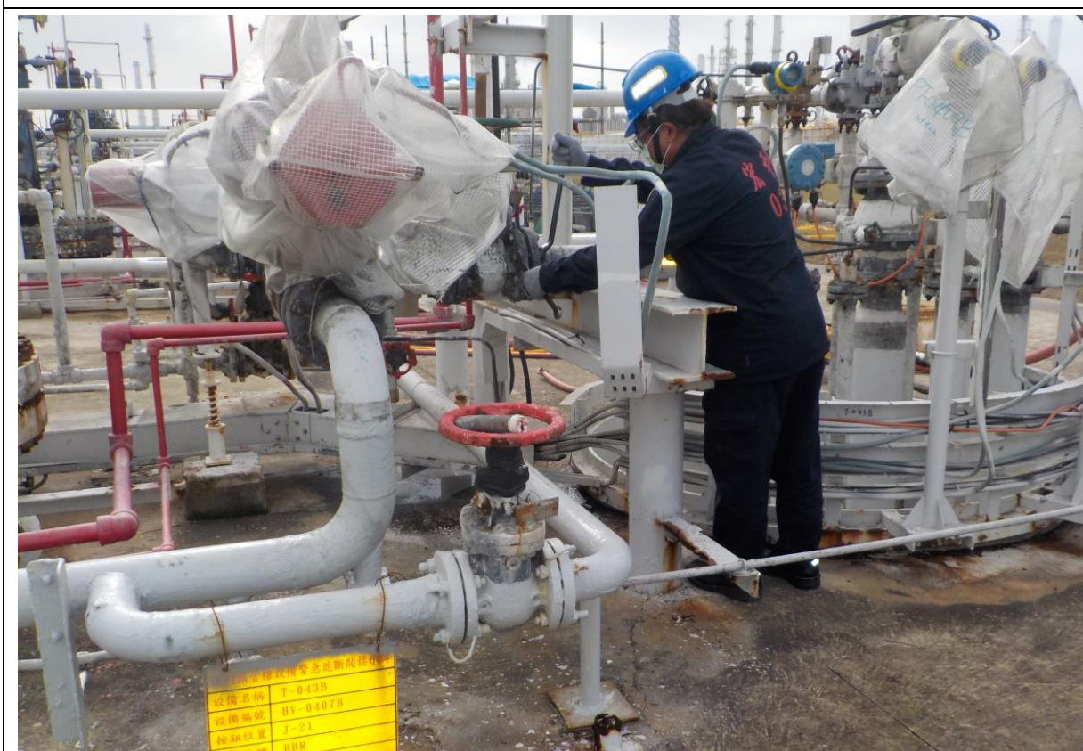
14. 施工完畢，人員進行抽盲
