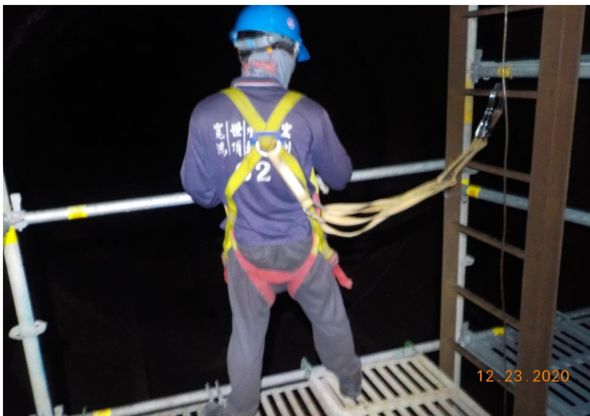
5. 槽內搭架作業情形(1)
