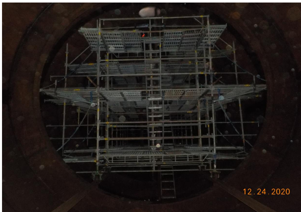
8. 槽內搭架作業情形(4)
