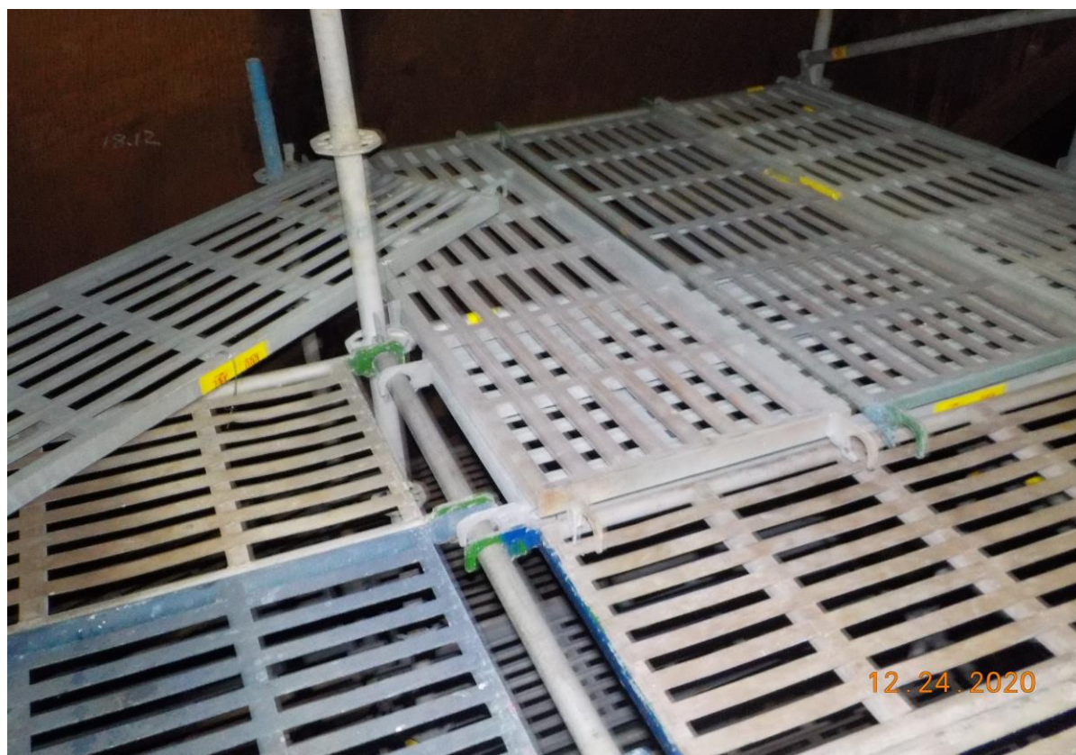
7. 槽內搭架作業情形(3)
