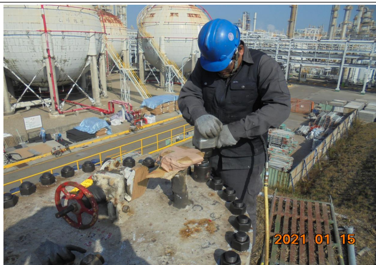
12. 人孔復原作業
