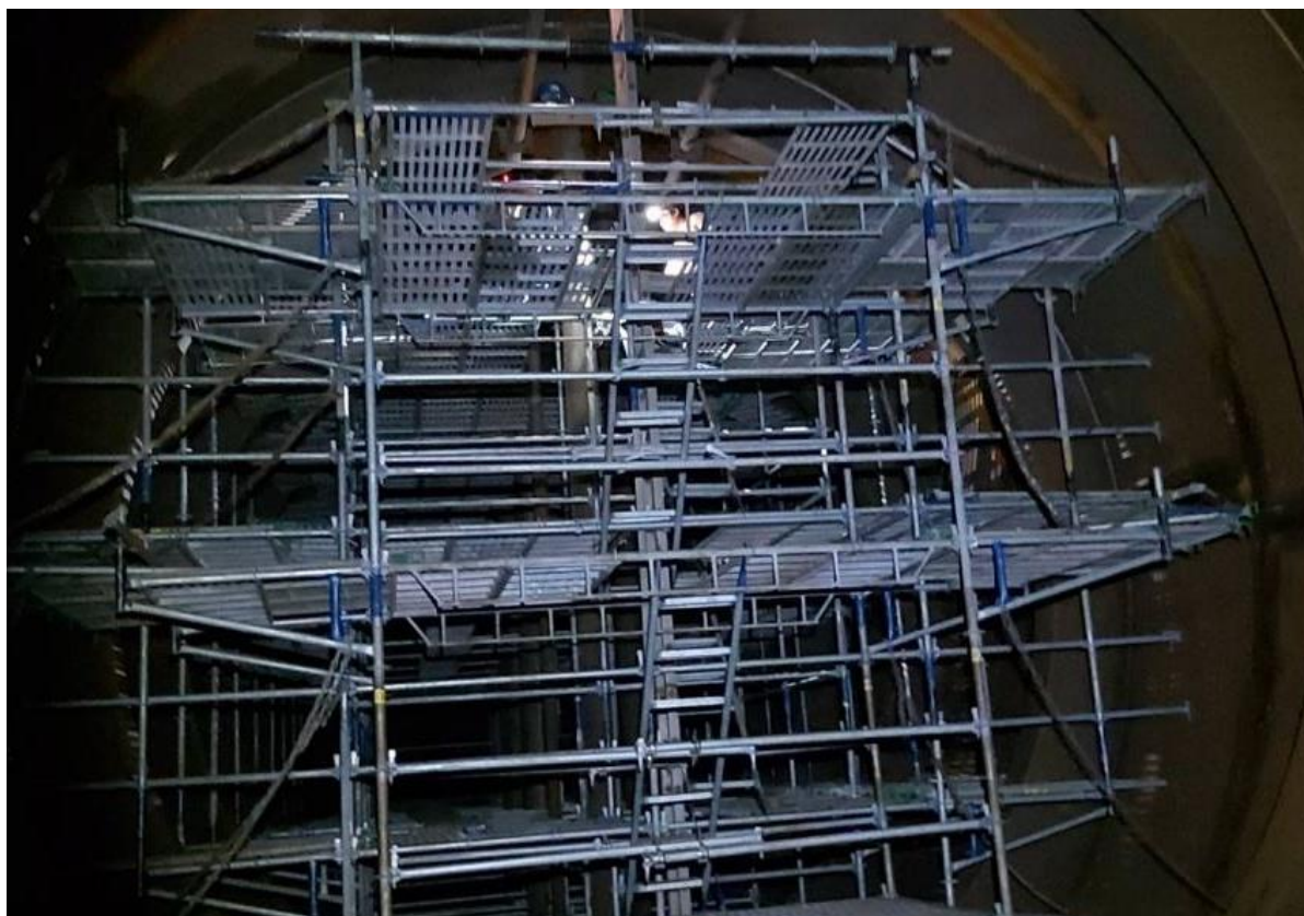
7. 槽內搭架作業情形(1)
