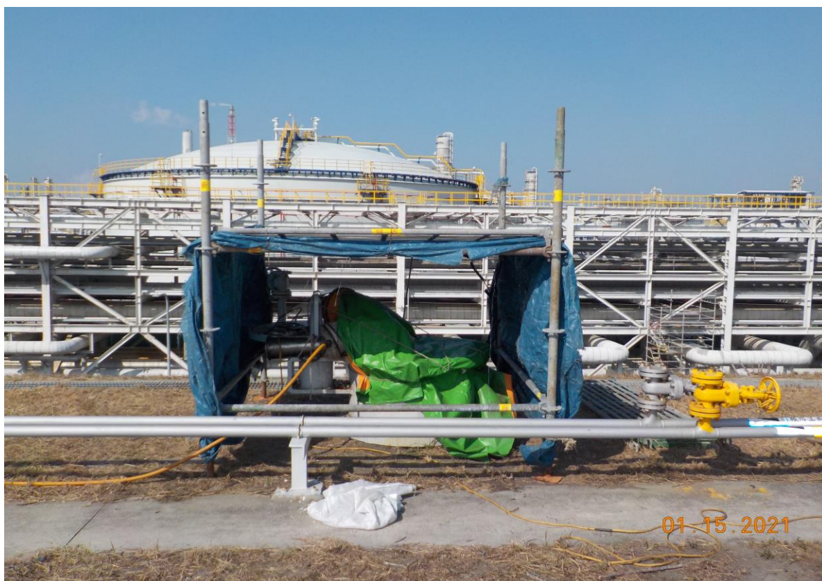
6. 槽外搭架情形
