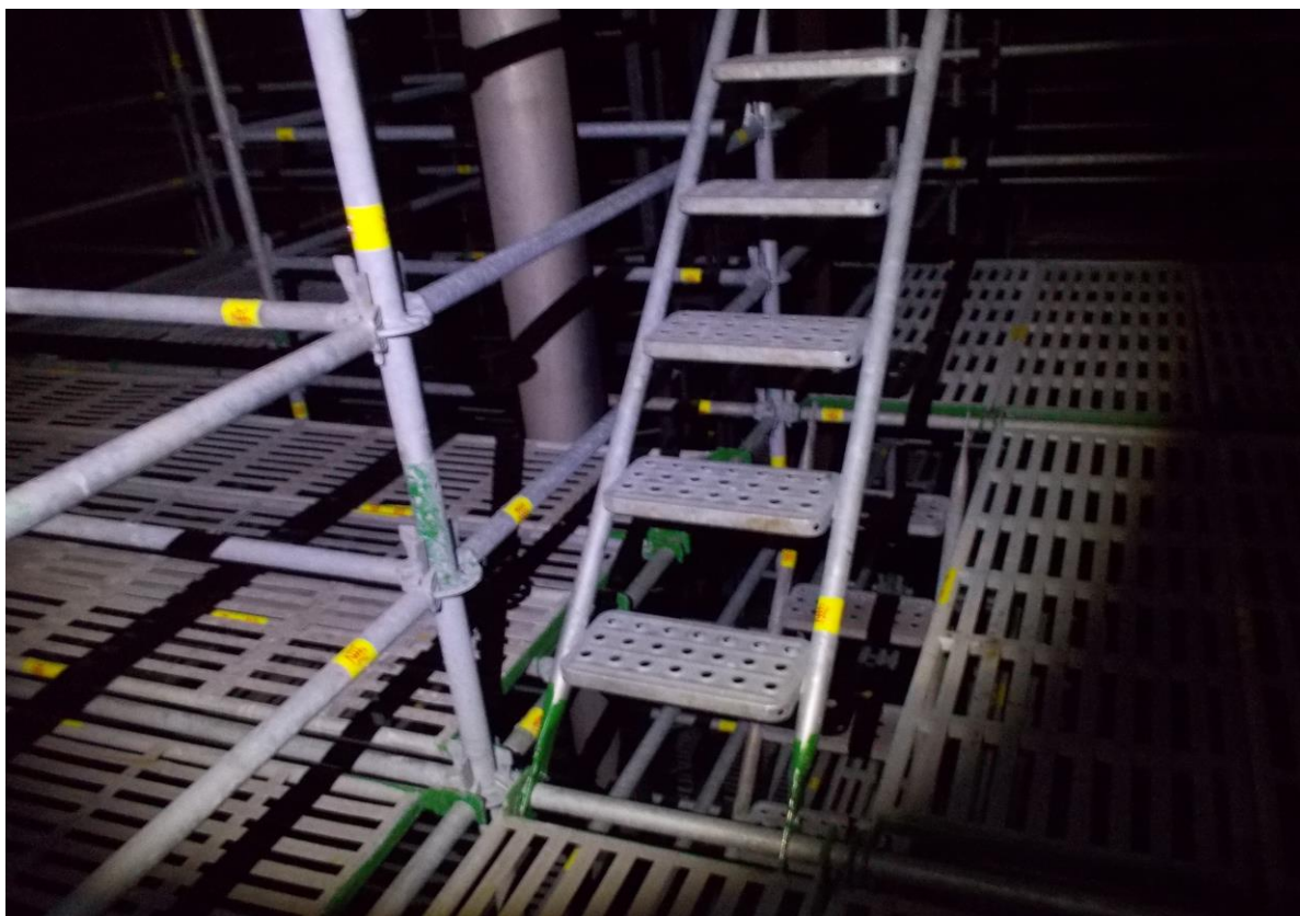
5. 槽內搭架作業情形(1)
