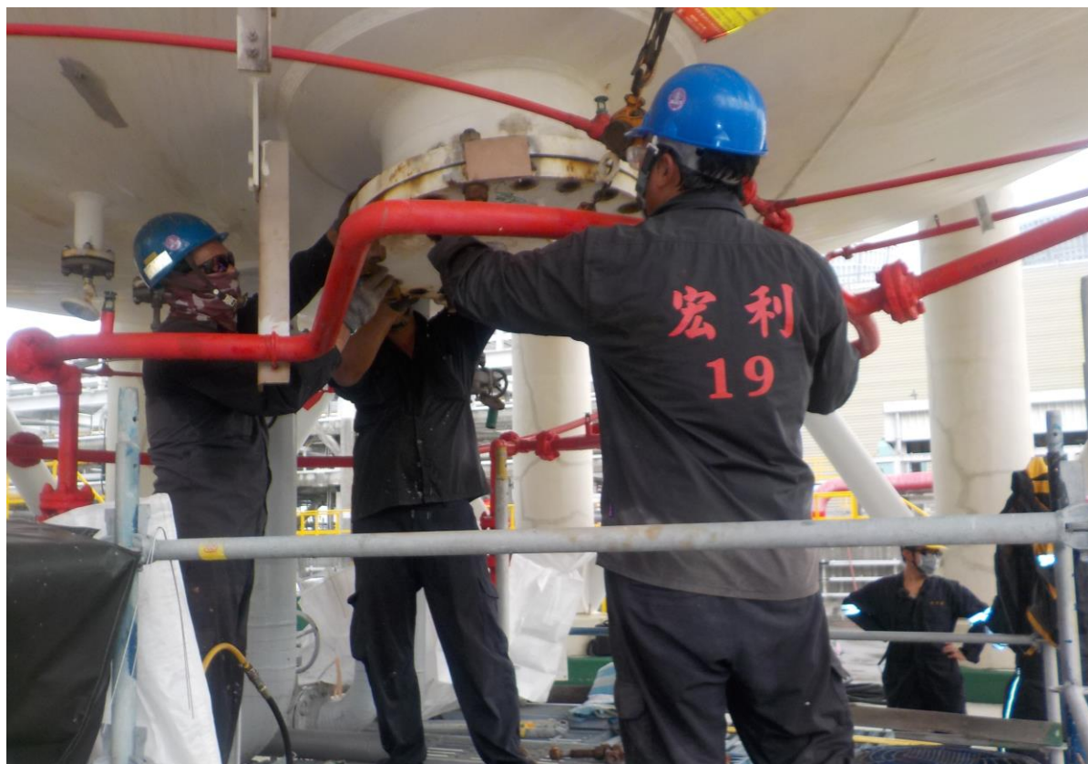
13. 施工完成下人孔復原
