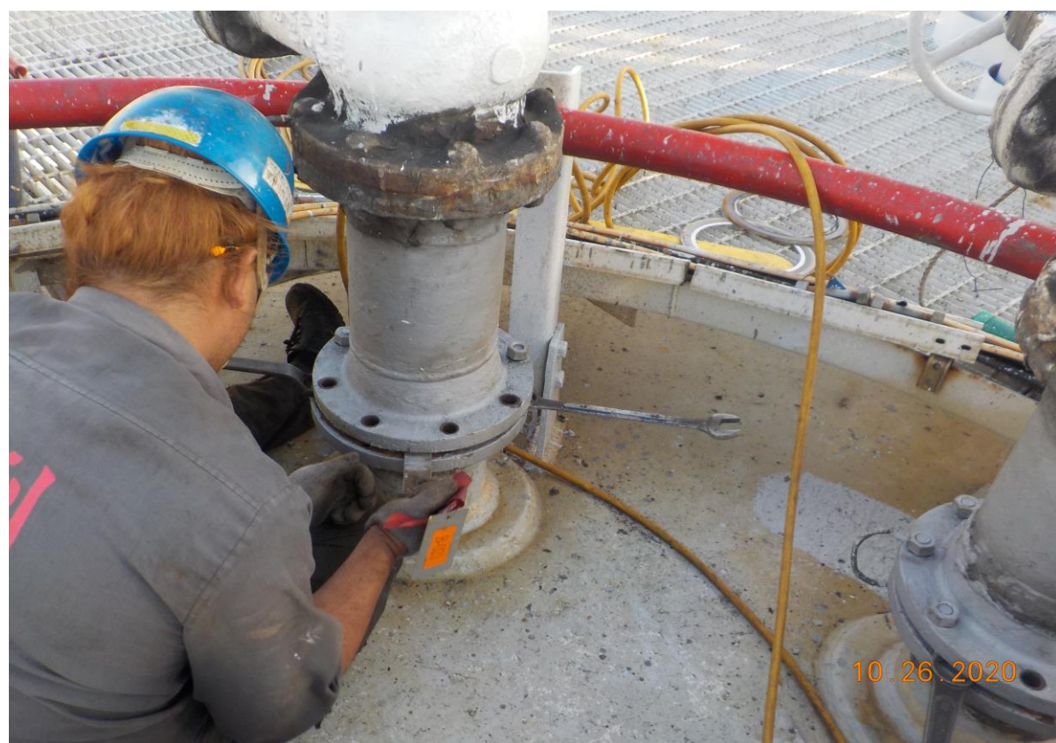
10. 管線抽盲作業(1)
