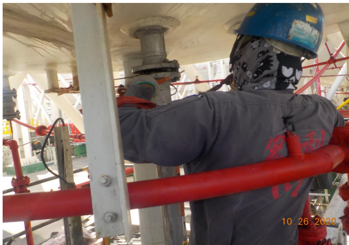
9. 管線抽盲作業(1)
