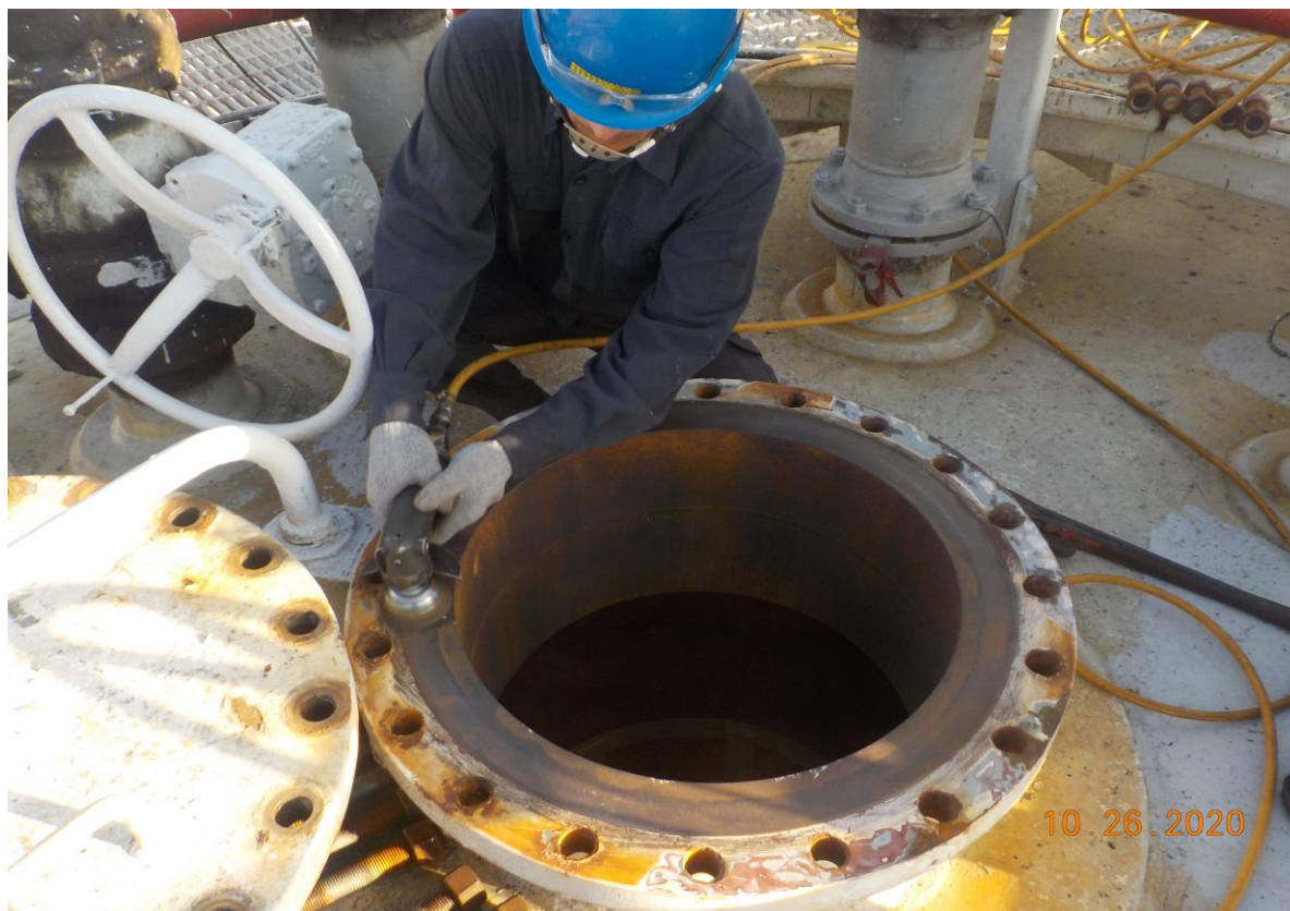
11. 上人孔回裝前法蘭面整理
