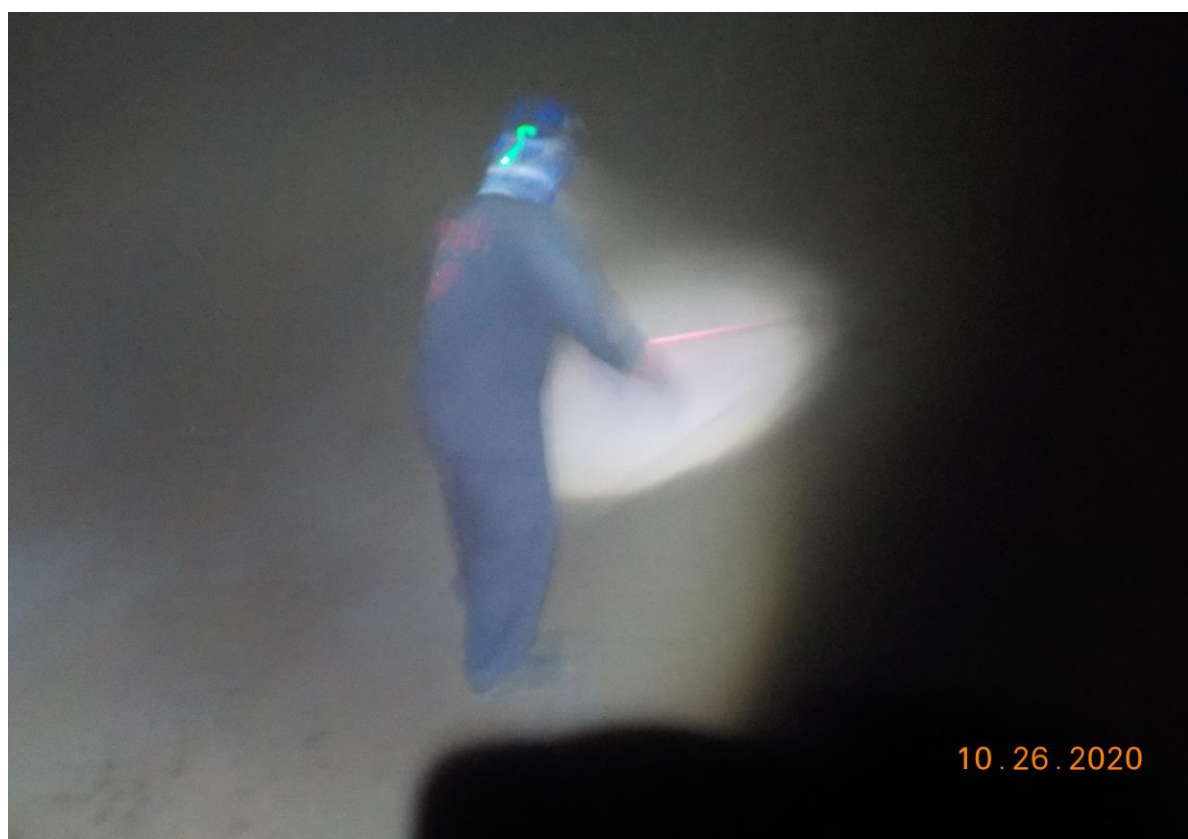
8. 槽內清掃作業
