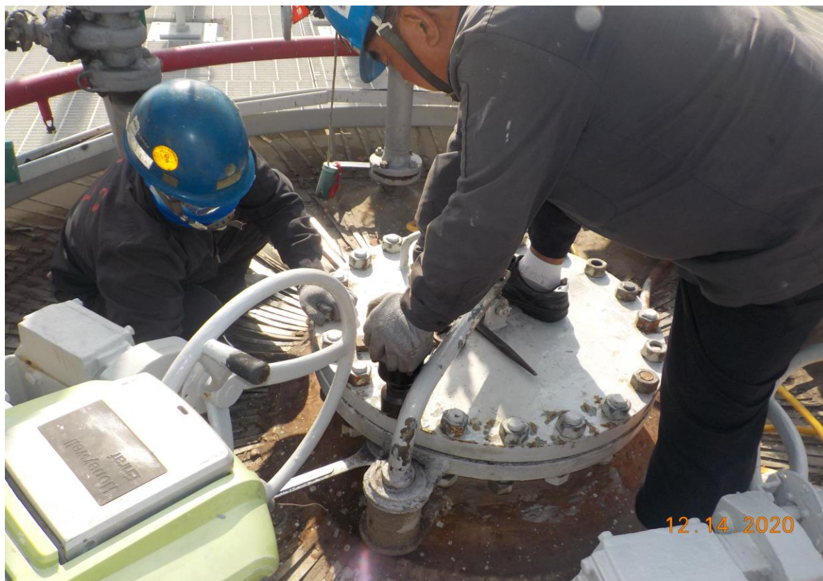
13. 施工完成上人孔復原
