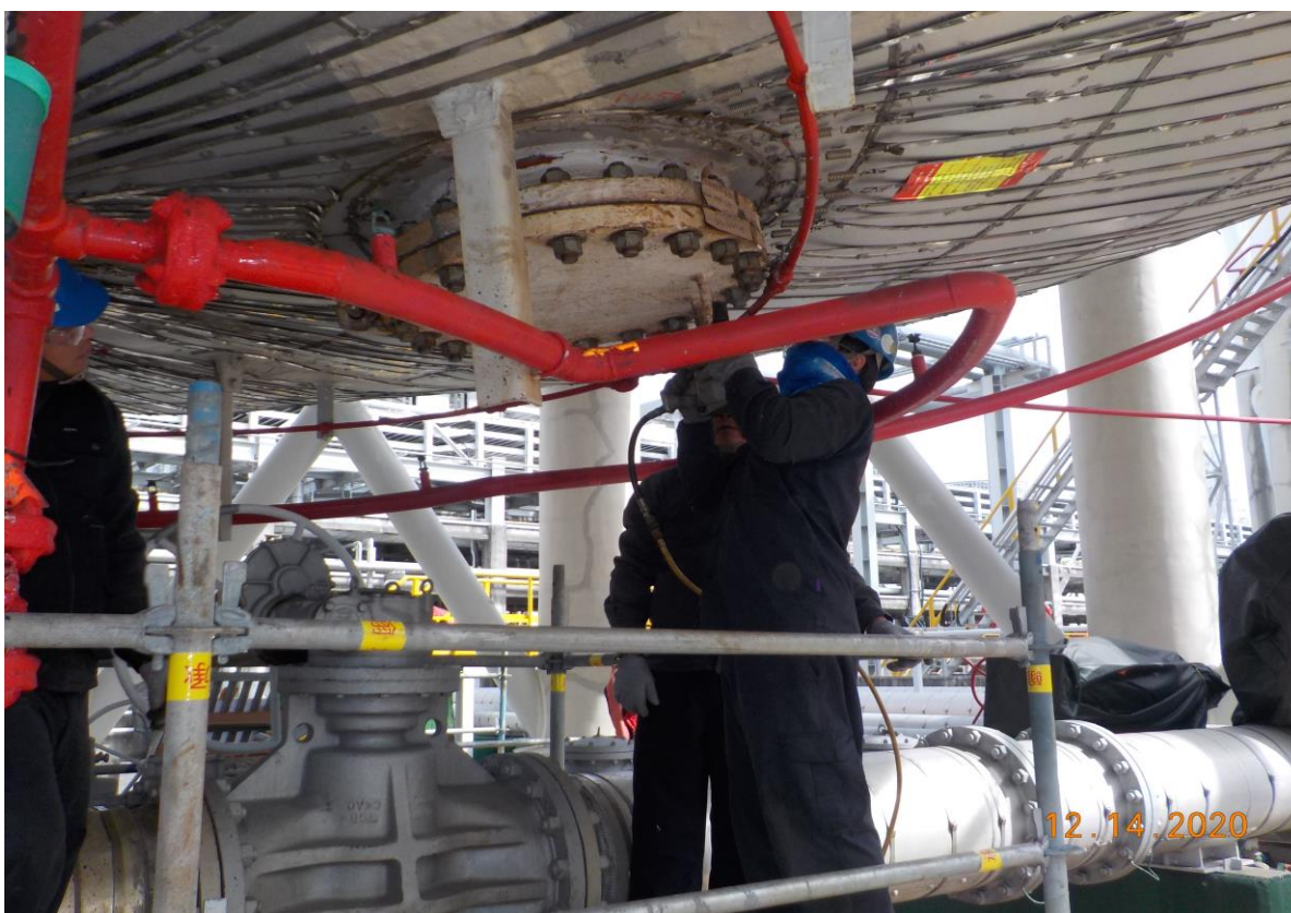
14. 施工完成，下人孔復原
