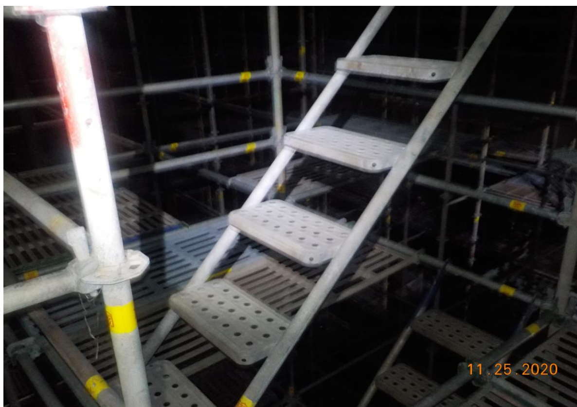
6. 槽內搭架作業情形(2)
