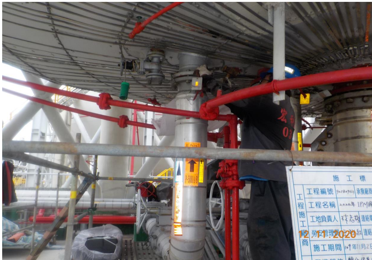
11. 管線抽盲作業(2)
