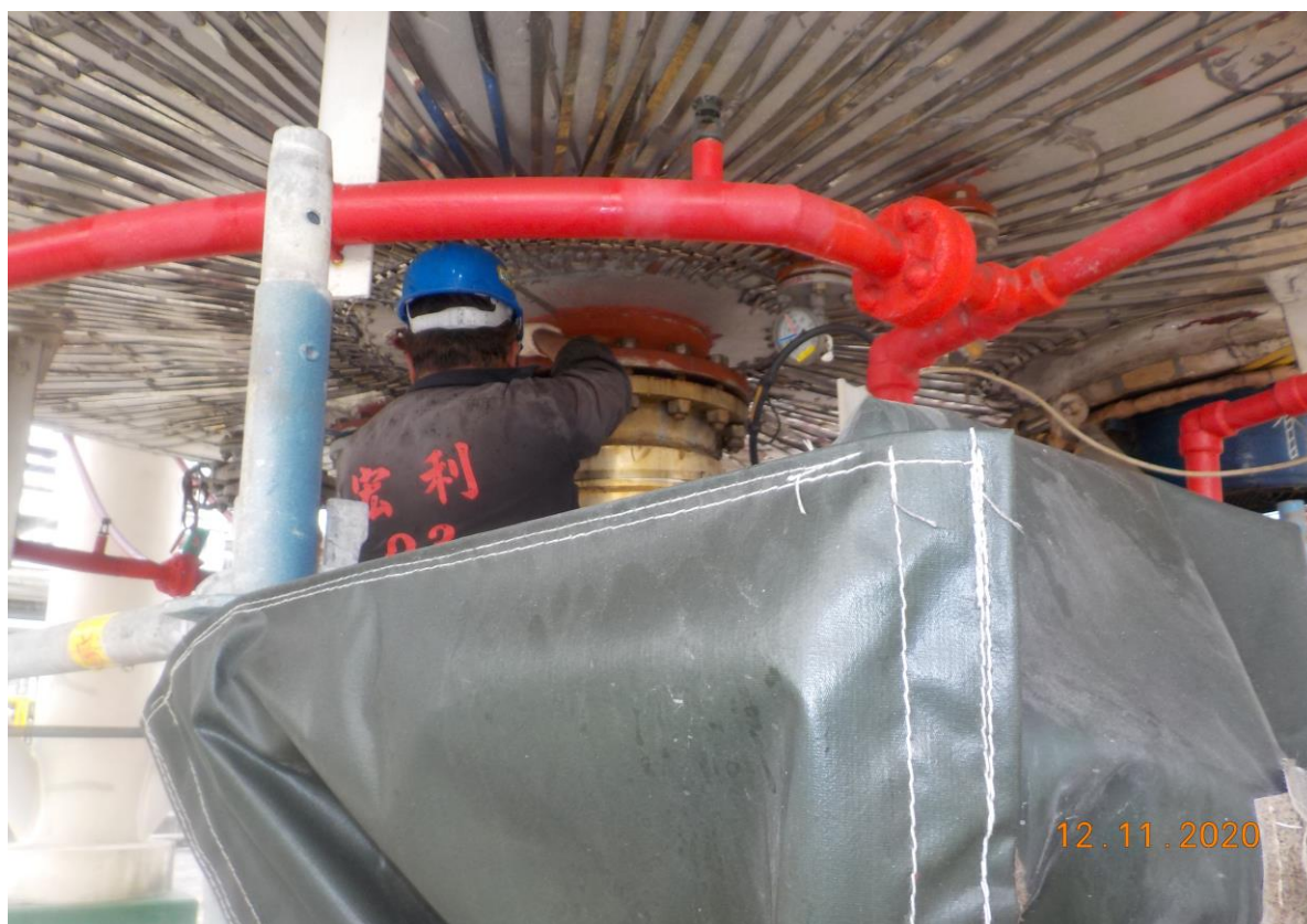
10. 管線抽盲作業(1)
