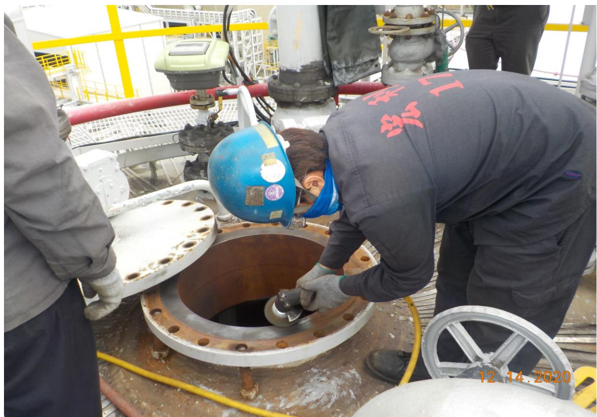
12. 上人孔回裝前法蘭面整理
