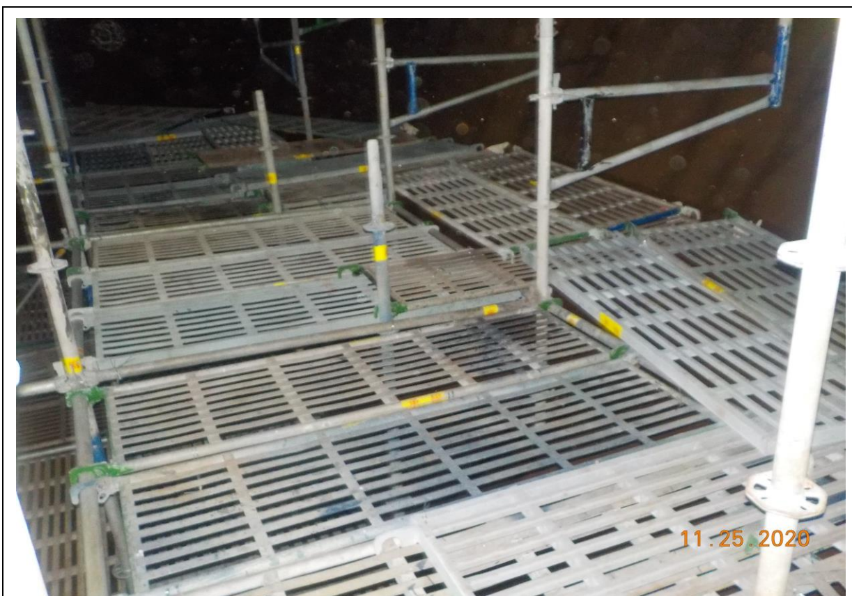
7. 槽內搭架作業情形(3)
