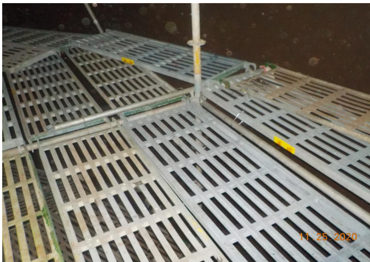
5. 槽內搭架作業情形(1)
