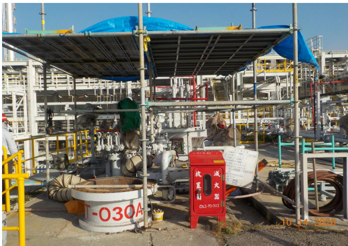
3. 槽外搭架作業(1)
