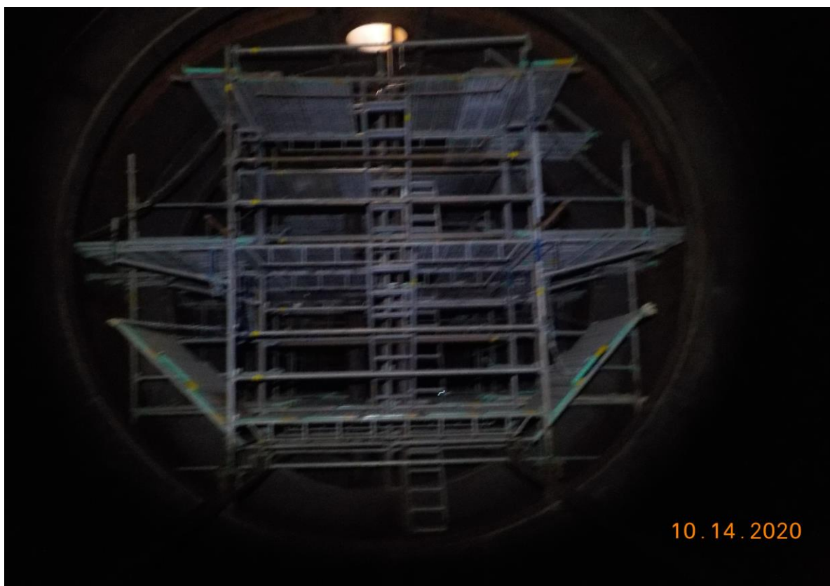
7. 槽內搭架作業情形(4)
