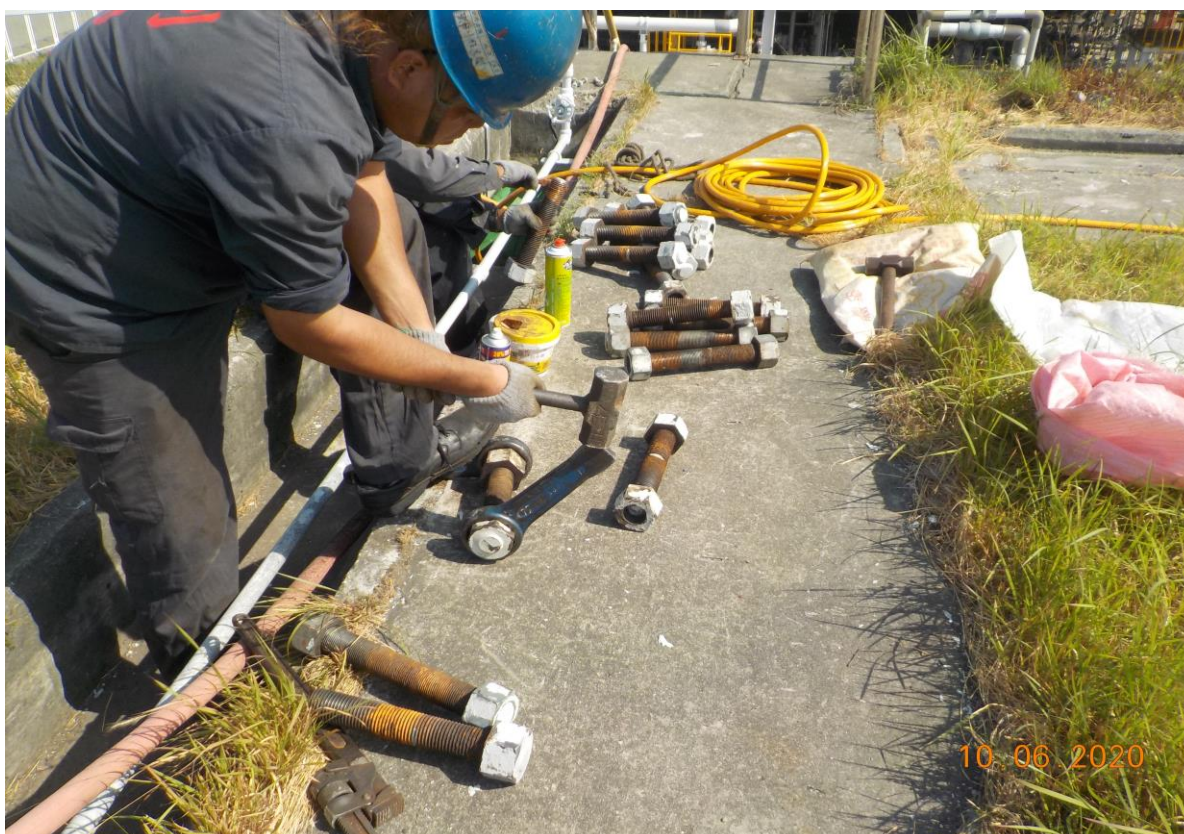
8. 人孔復原前螺絲整理
