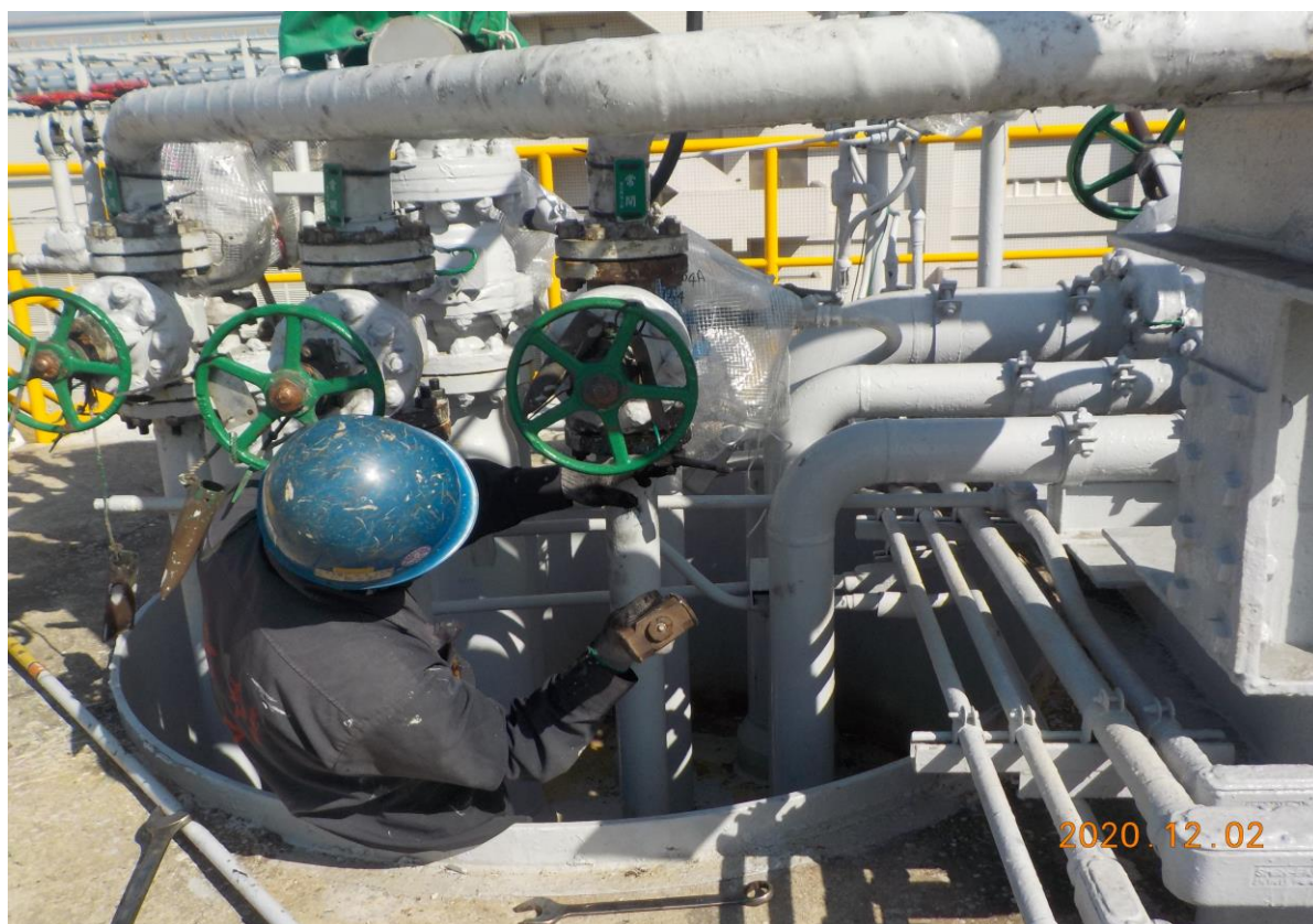
11. 施工完成，管線抽盲
