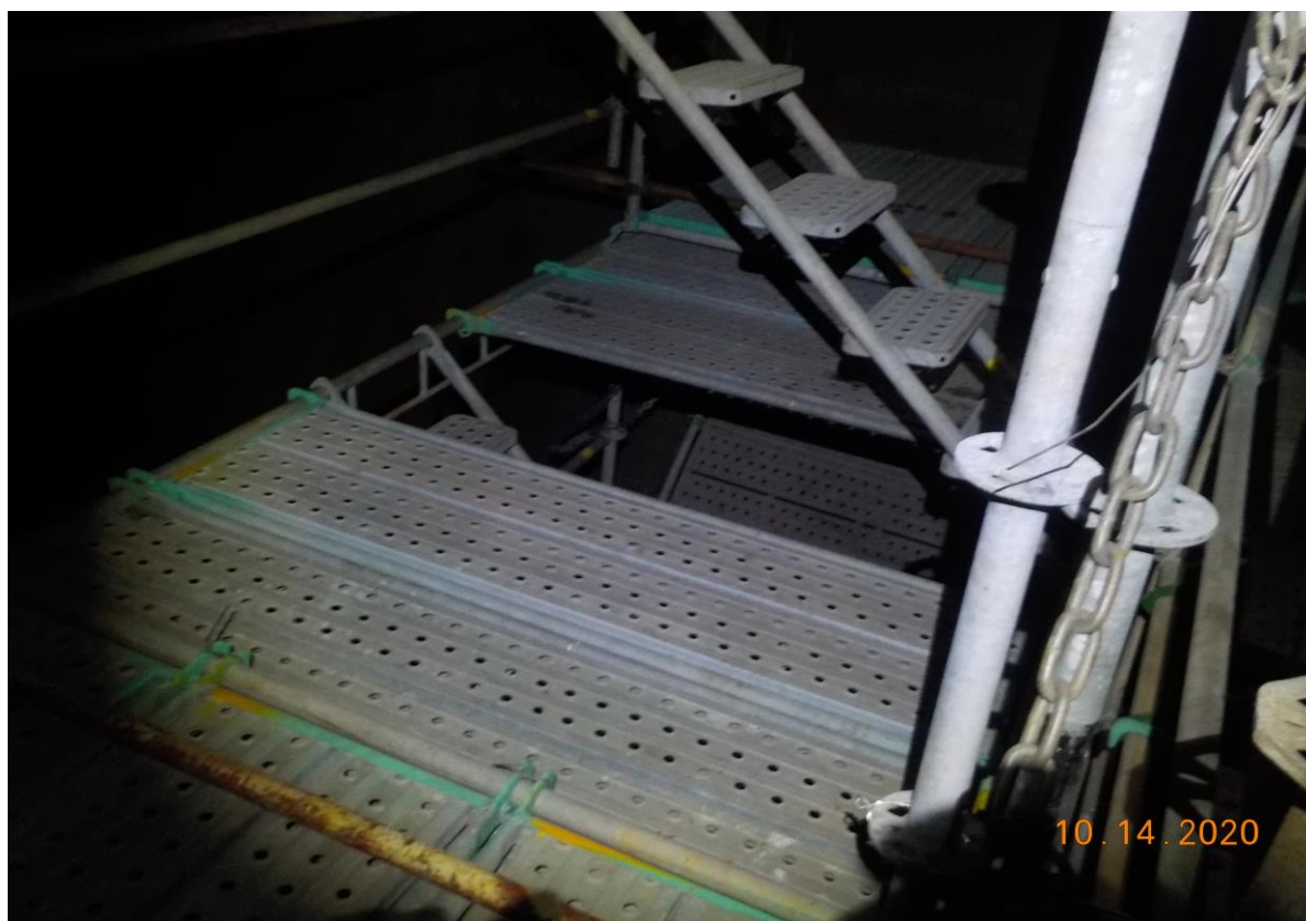
5. 槽內搭架作業情形(2)
