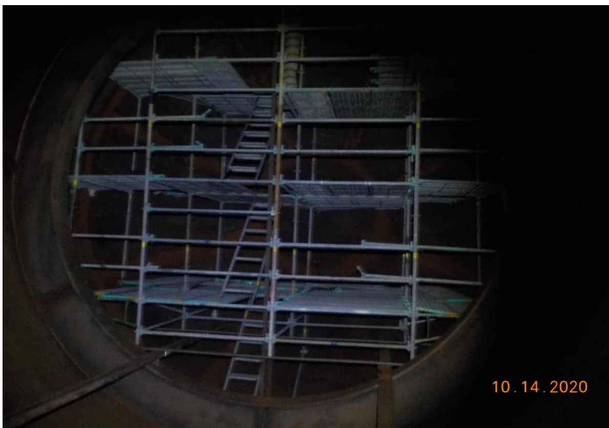
6. 槽內搭架作業情形(3)
