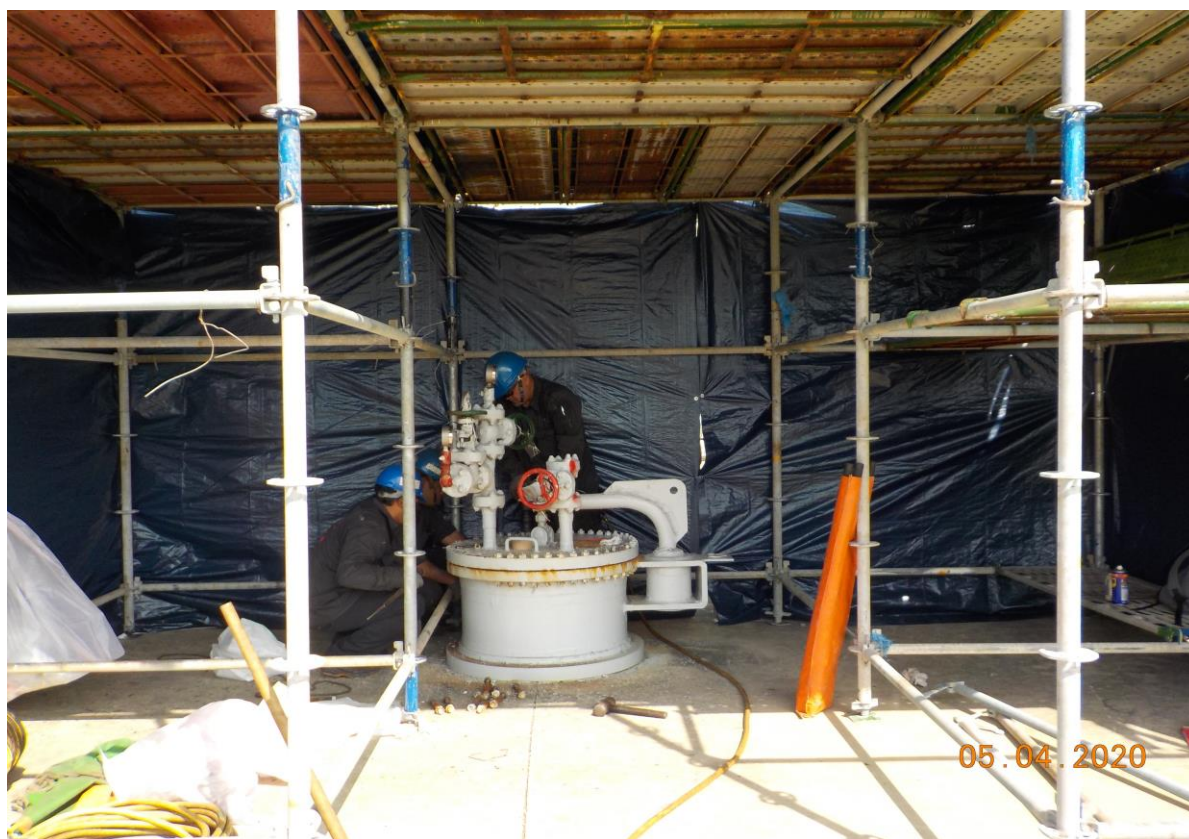
6. 槽外搭架情形
