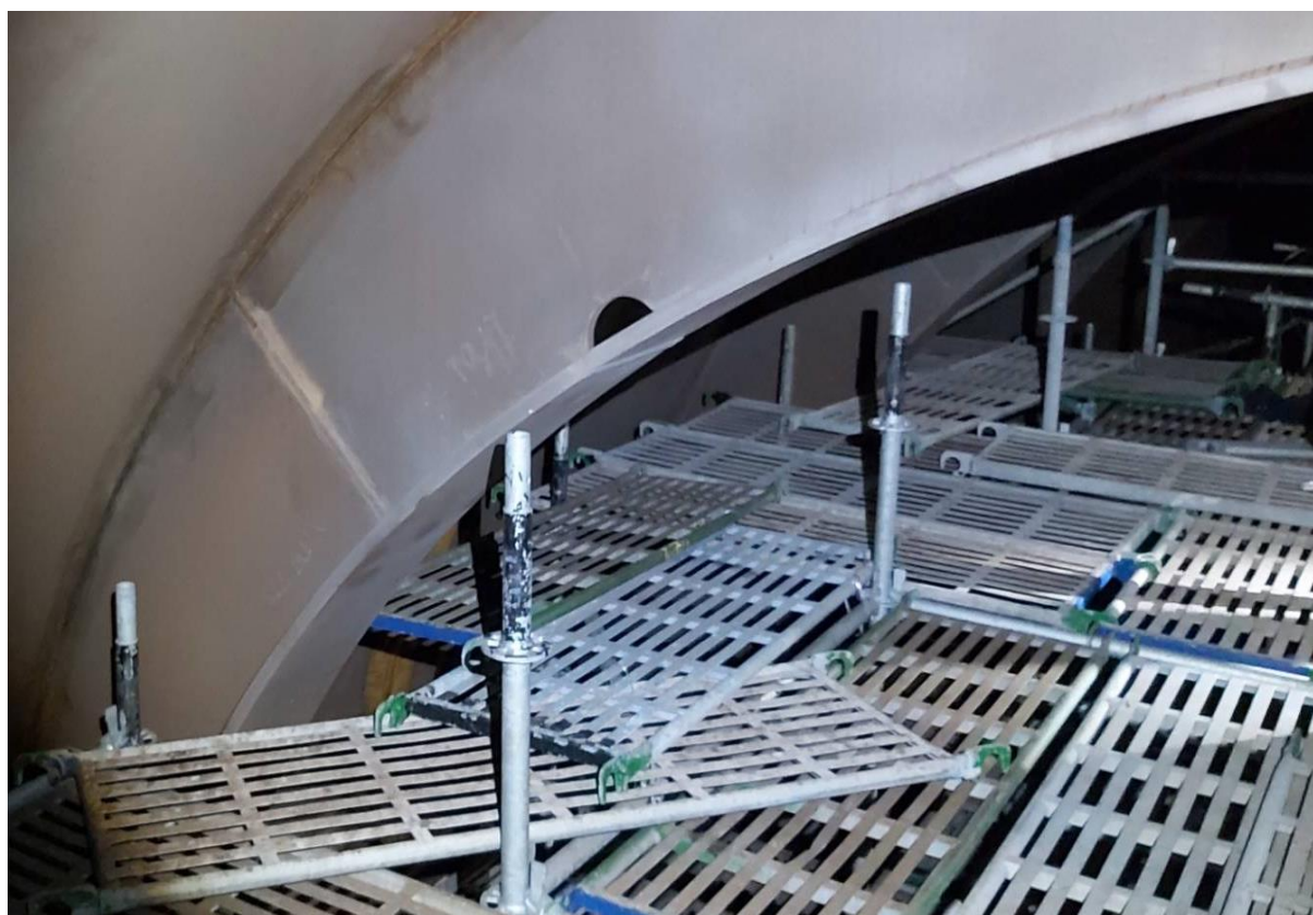
9. 槽內搭架作業情形(3)
