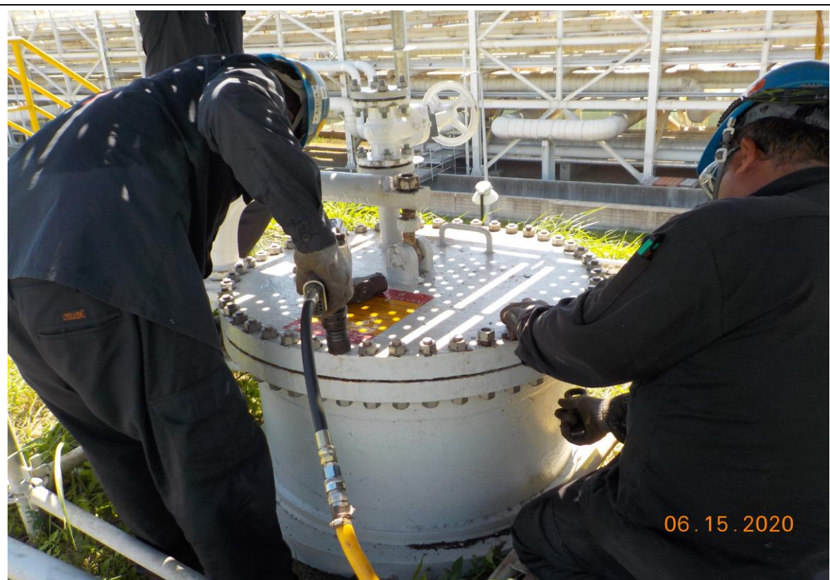
14.施工完畢，人孔復原完成
