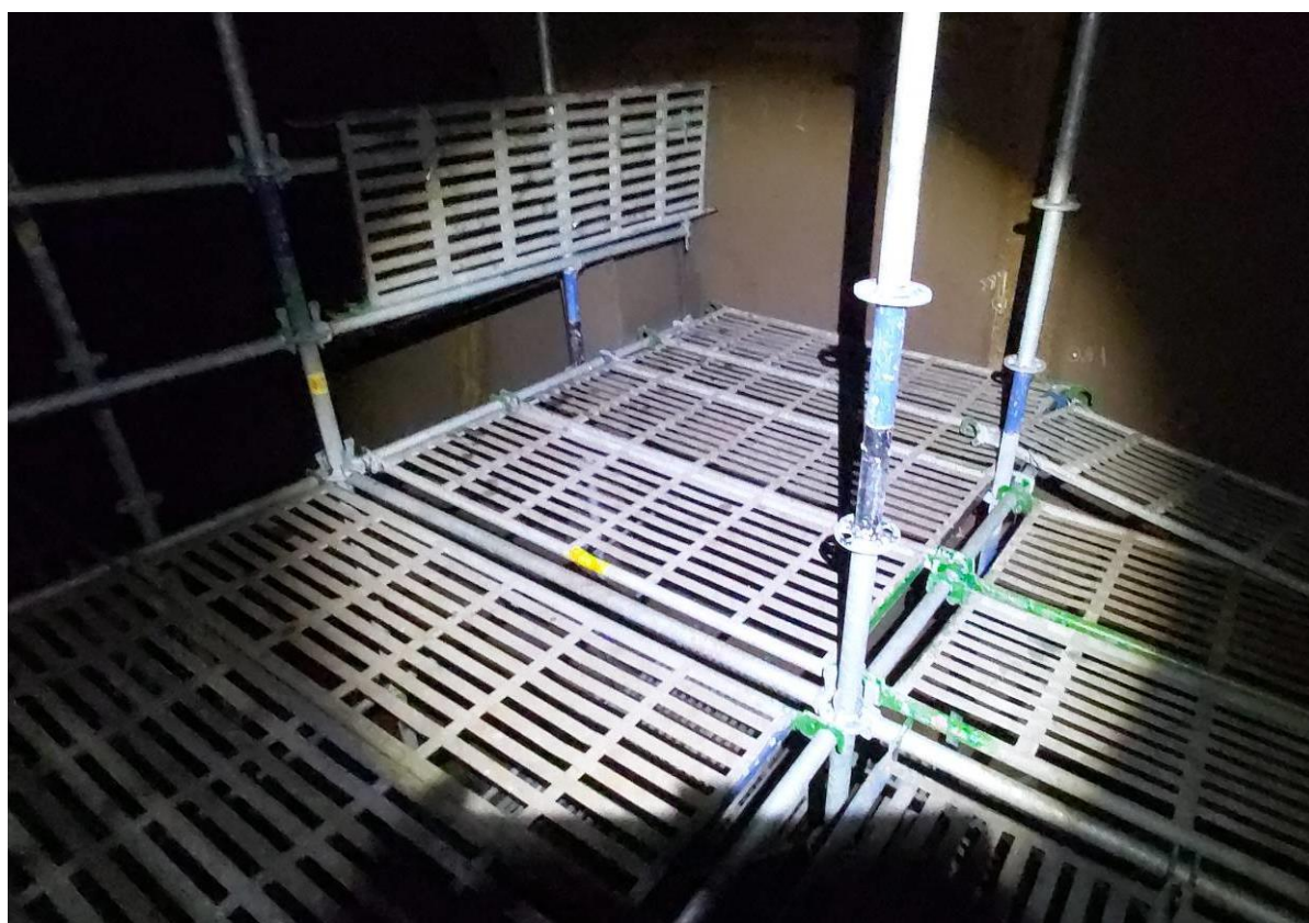
6. 槽內搭架作業情形(3)
