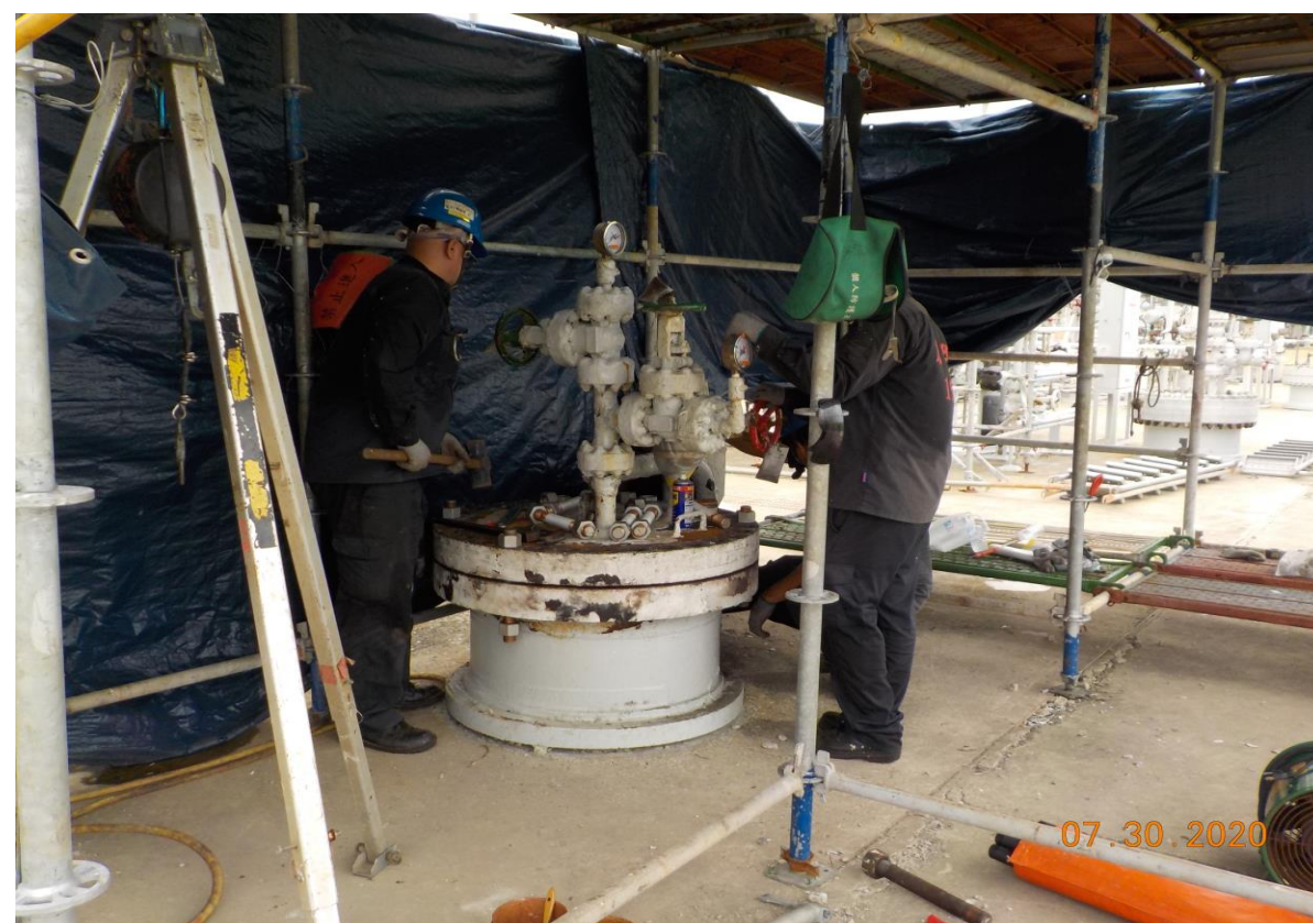
12. 施工完成人孔復原
