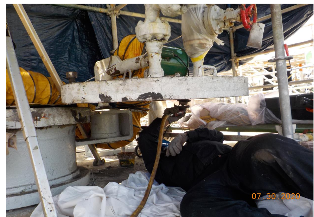
10. 人孔復原前法藍面清理
