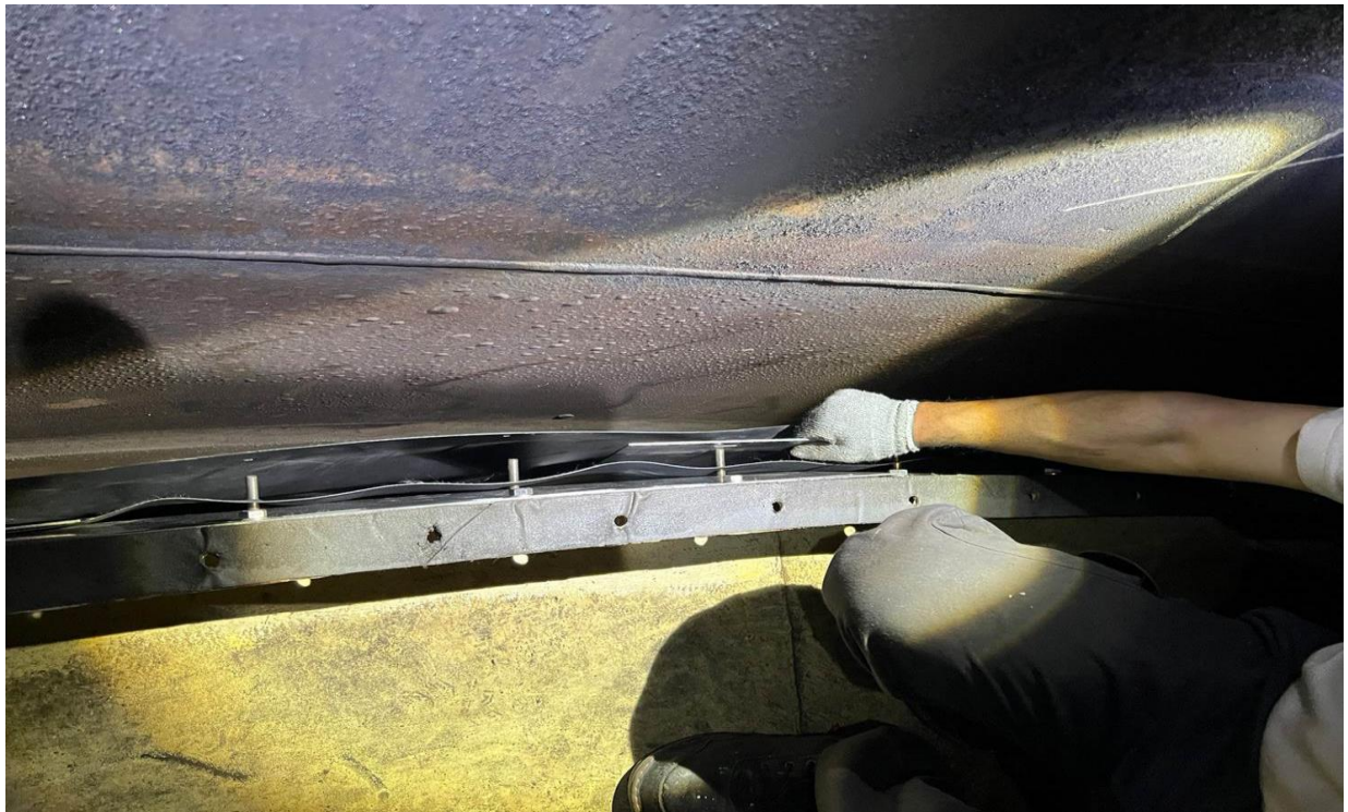
安裝延伸板情形(9)
