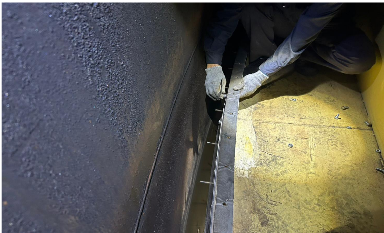
人員安裝延伸板情形 (8)
