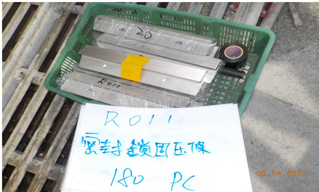
物料放置於現場之情形 (7)
