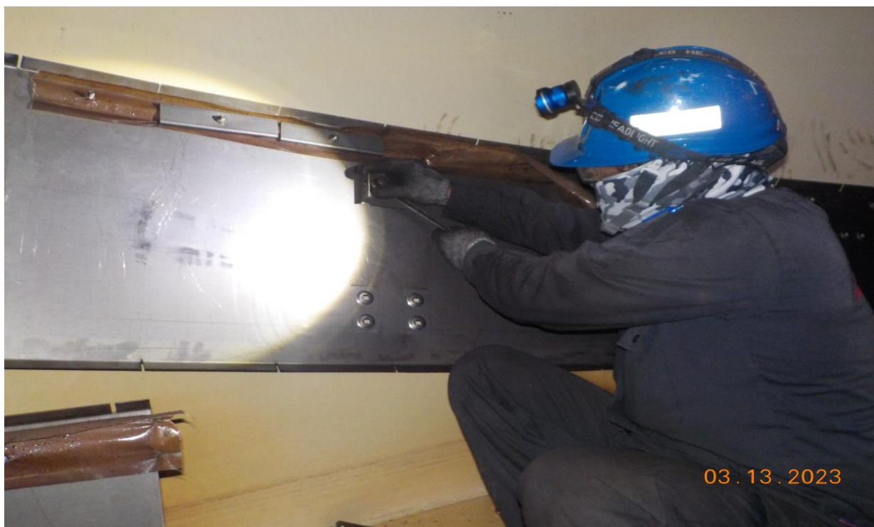
舊料拆除之情形(5)
