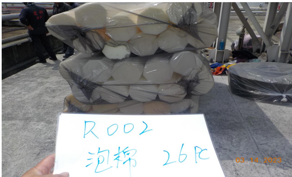
物料放置於現場之情形 (6)
