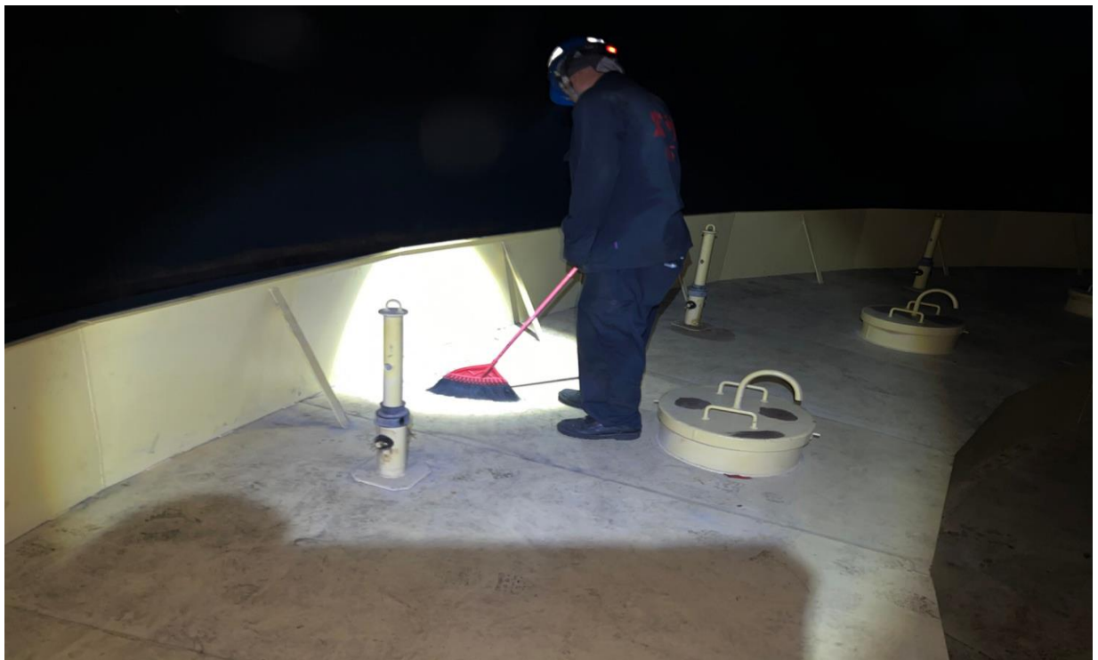
施工完成槽內清掃 (16)
