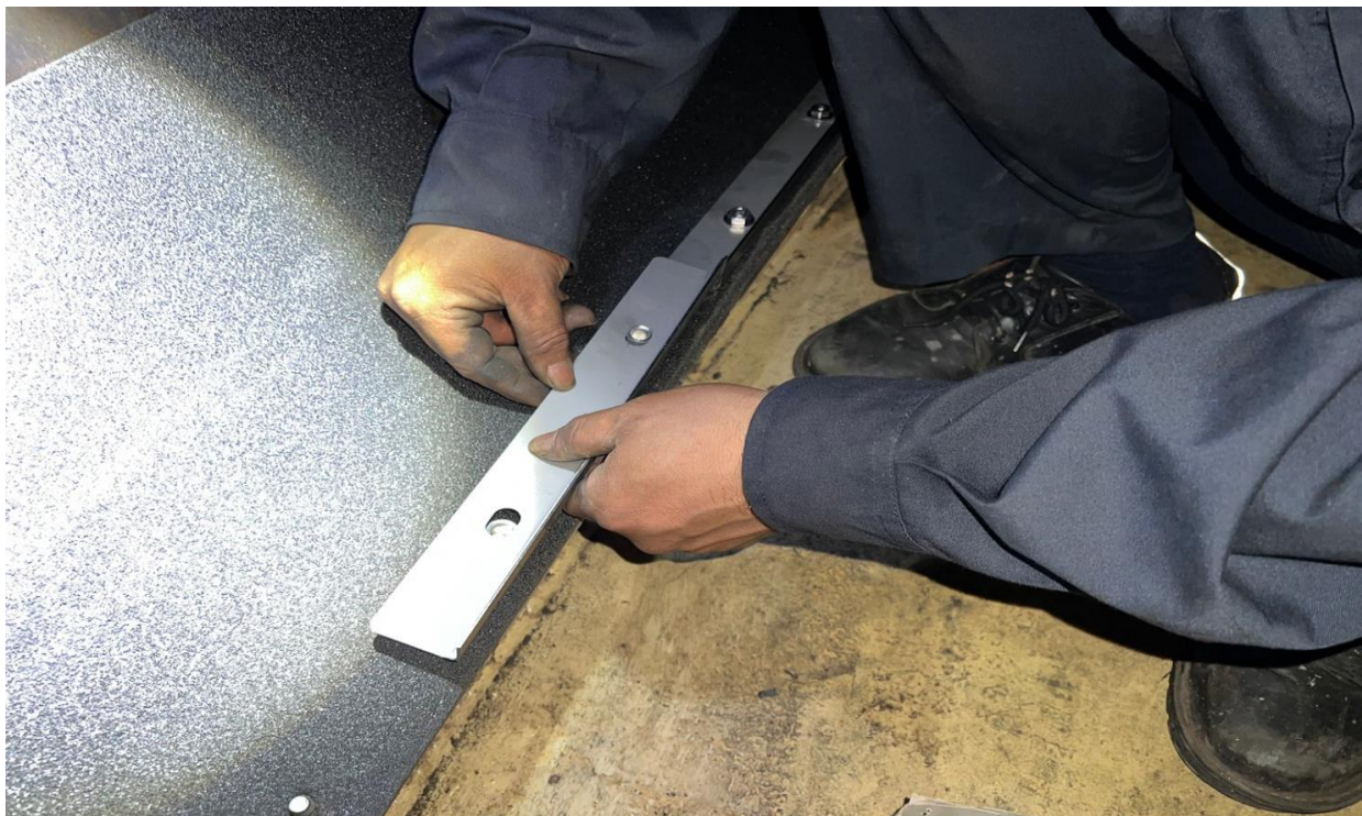
人員安裝壓板之情形(14)
