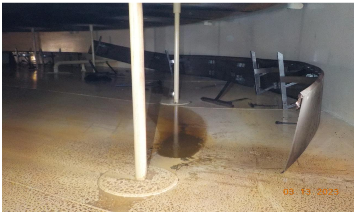
舊料拆除情形 (4)
