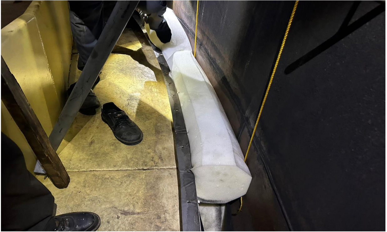
安裝海棉之情形(11)
