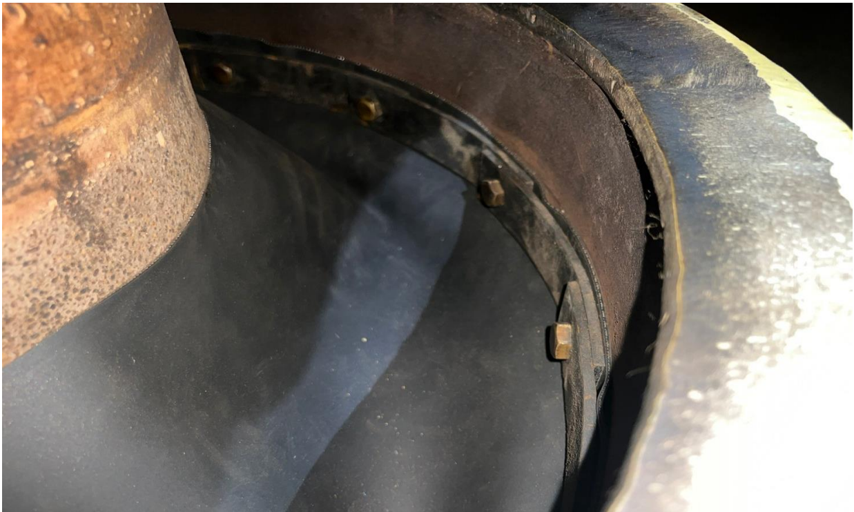
人員安裝之情形(12)
