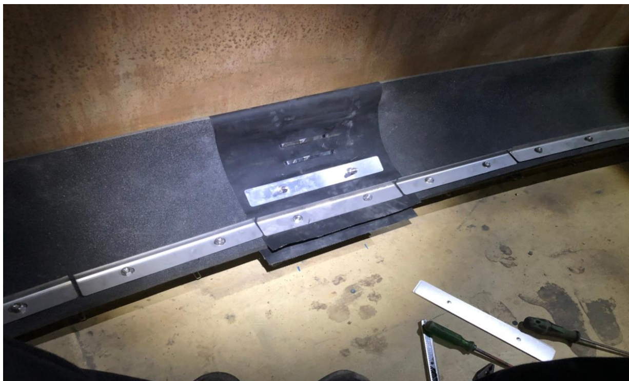
安裝二次刮板情況(13)
