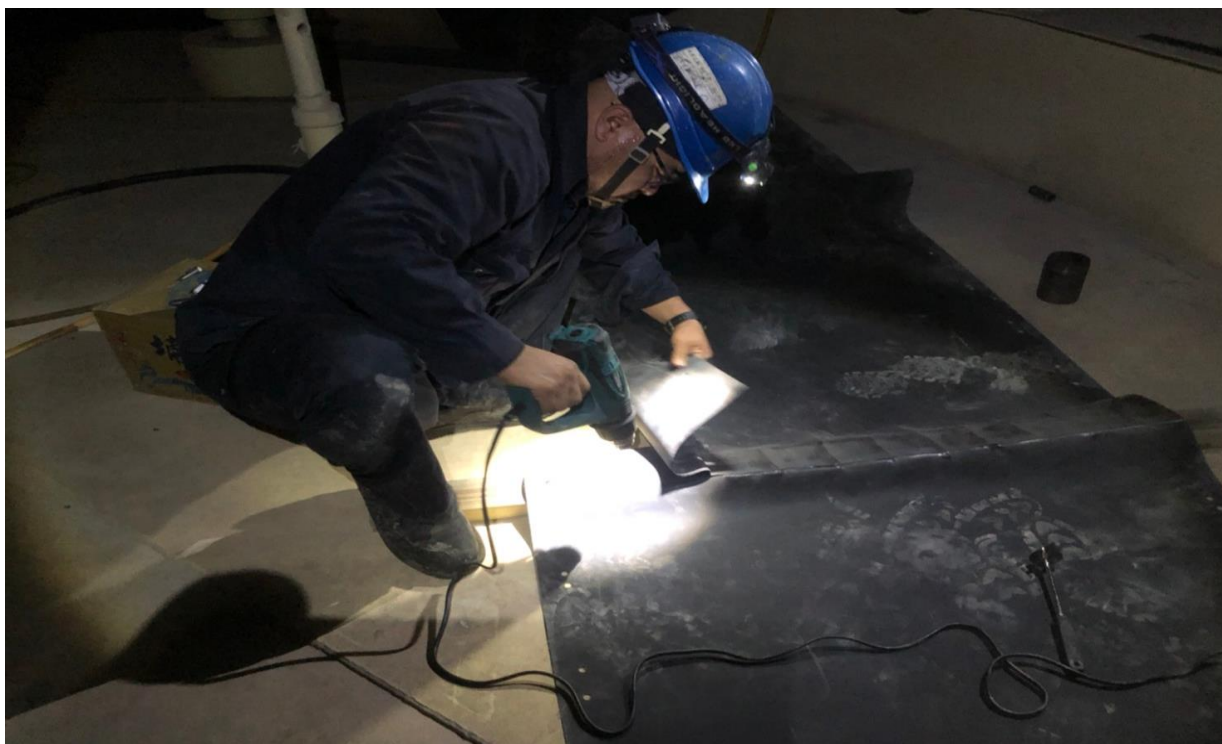
安裝封帶加熱接合情形(10)
