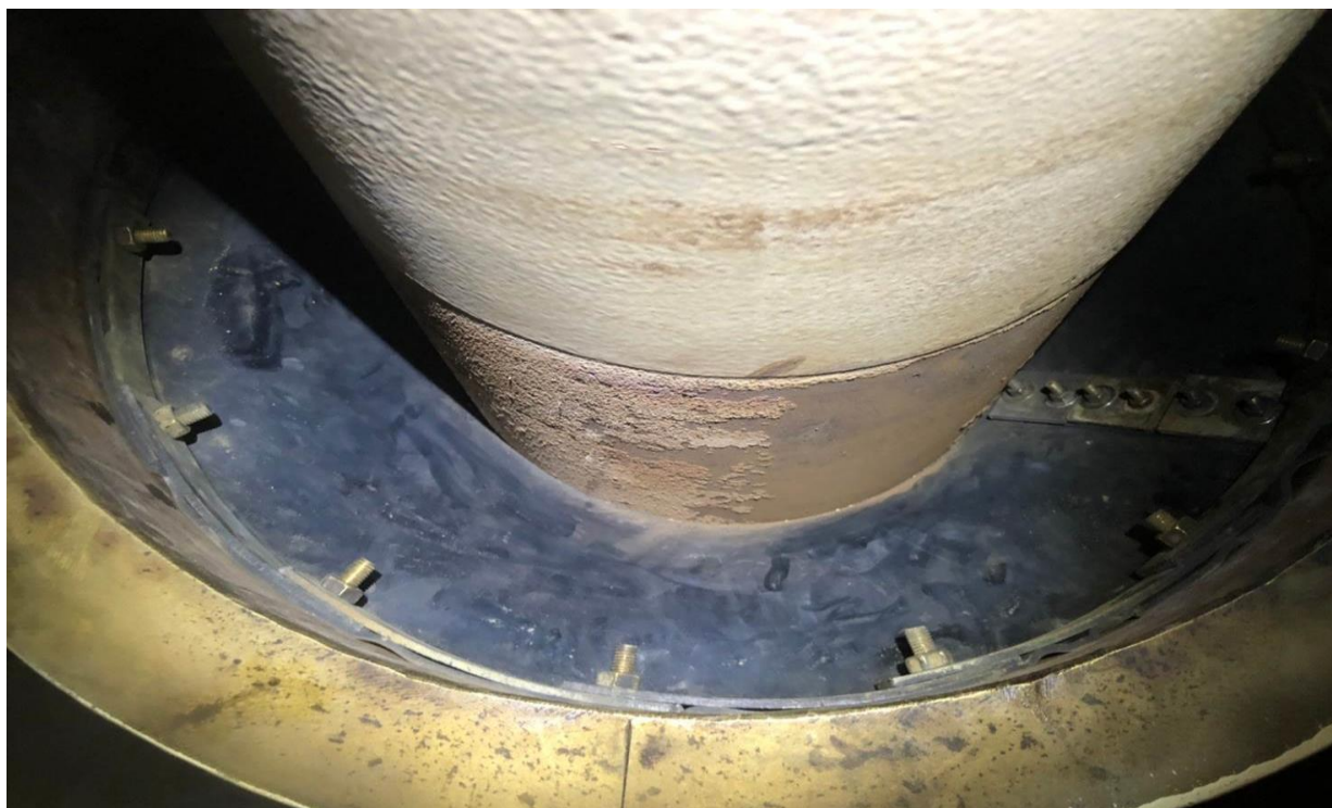
人員安裝之情形(12)
