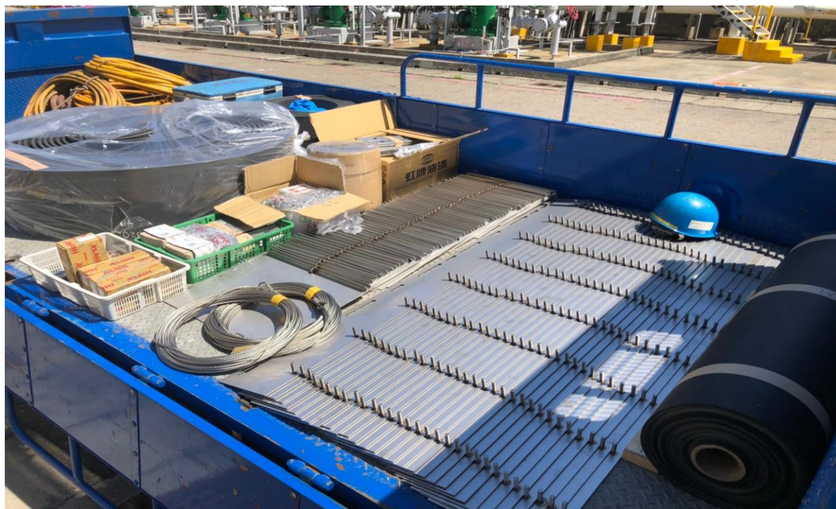
物料放置於現場之情形（6）
