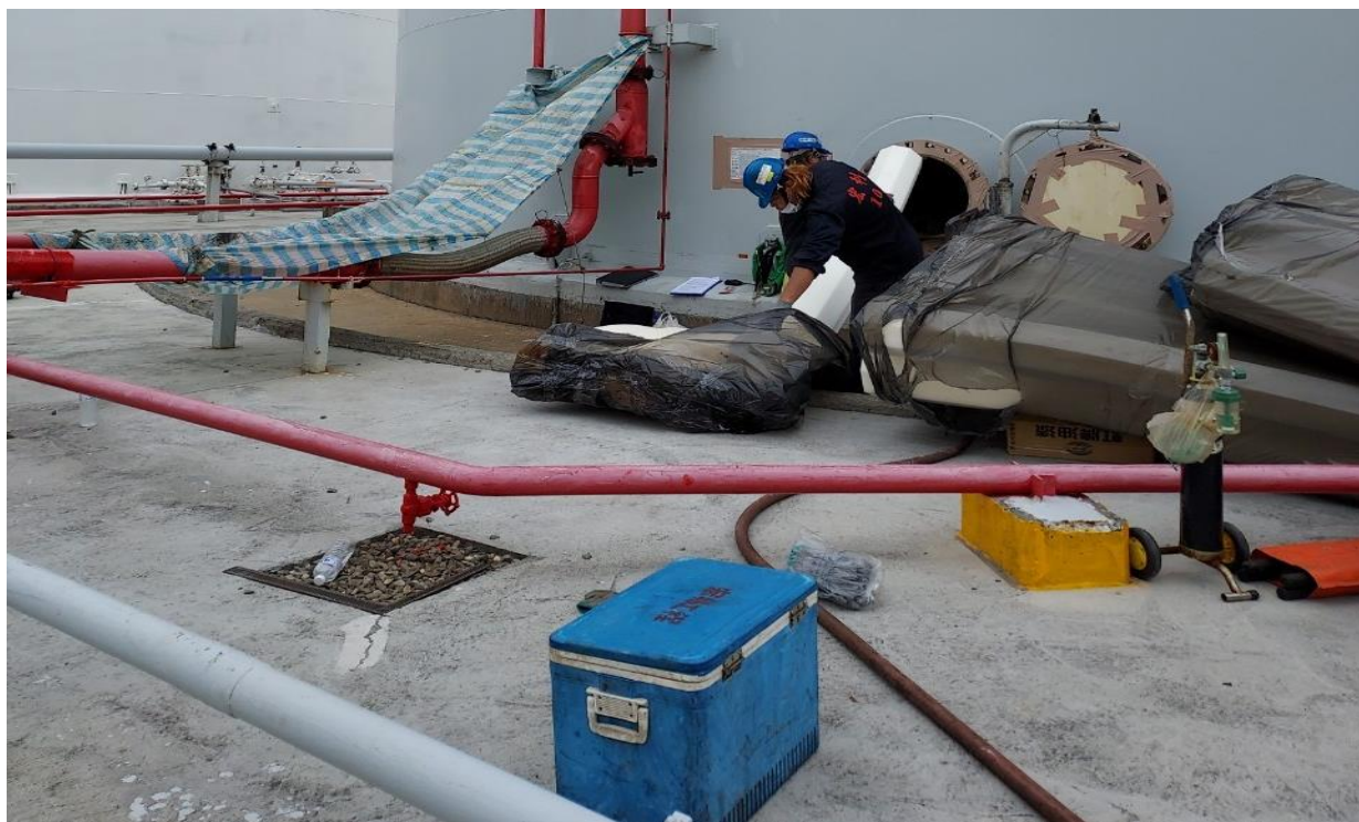
海綿傳遞至槽內之情形 (7)
