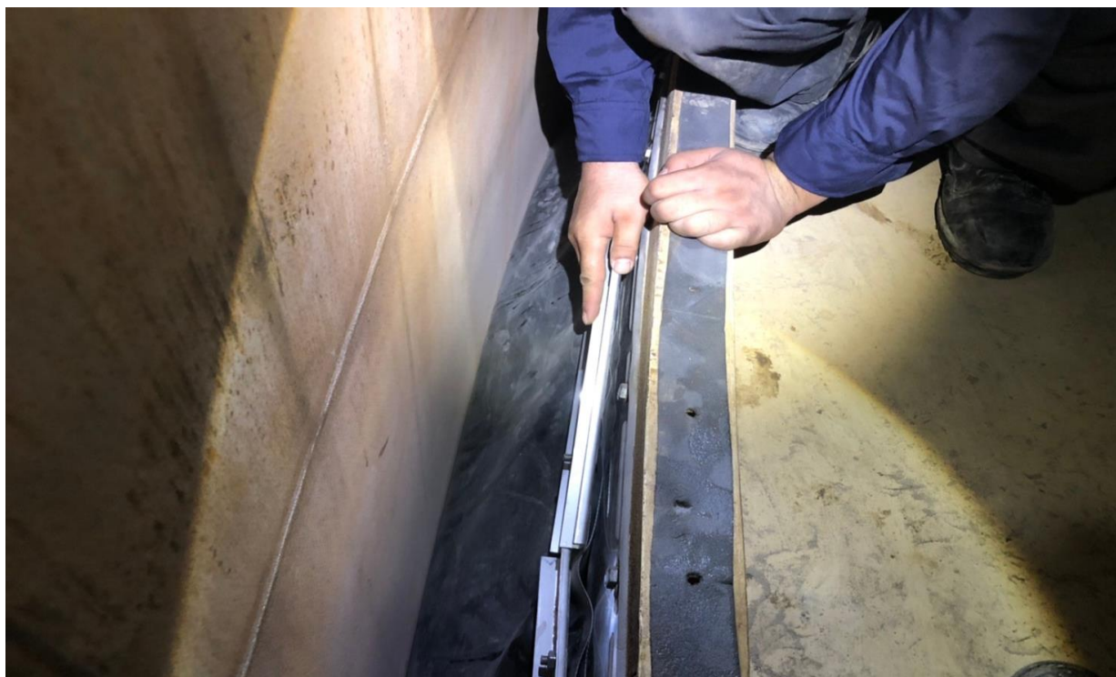
人員安裝封袋之情形(14)
