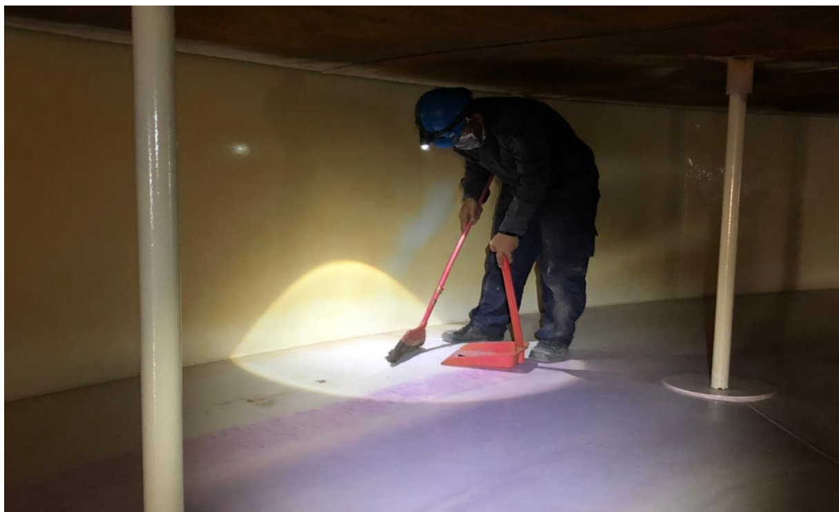
施工完成槽內清掃！(16)
