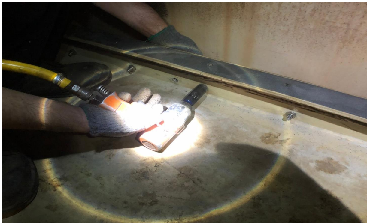
安裝延伸板情形(9)
