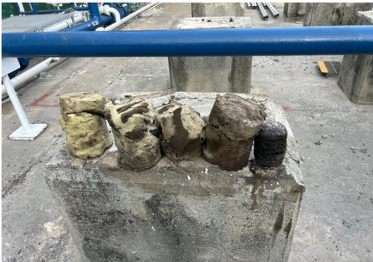
15. 接收端海綿取出情形
