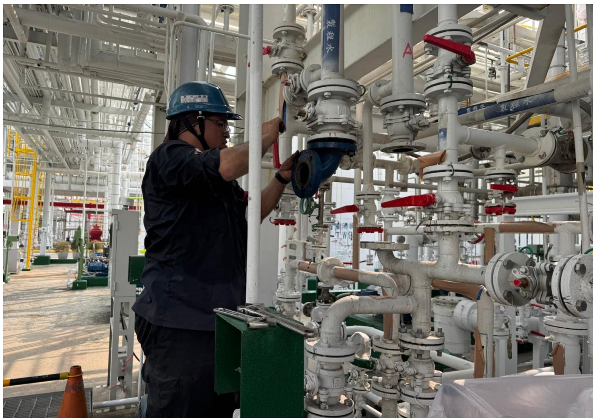
7. B 管發射段安裝情形
