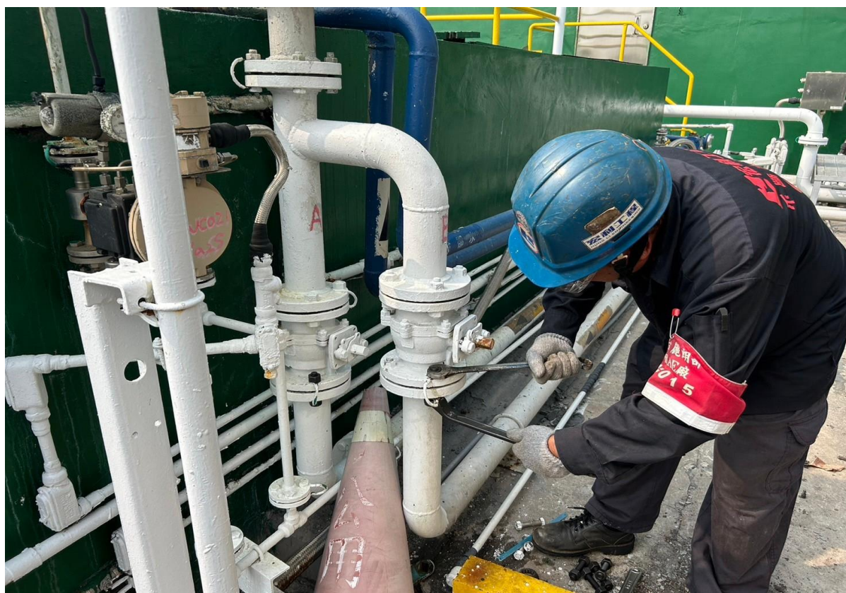
4. 閥件移除作業
