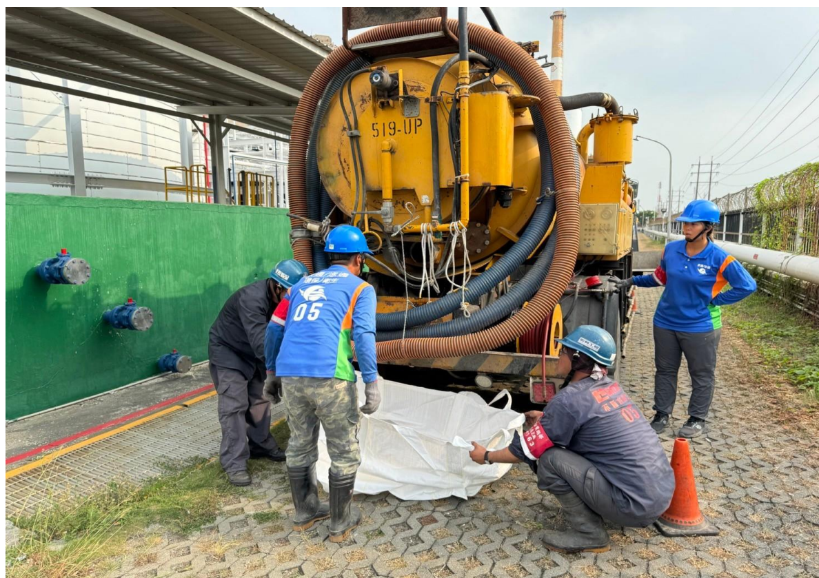
12. 槽車承接淤泥情形
