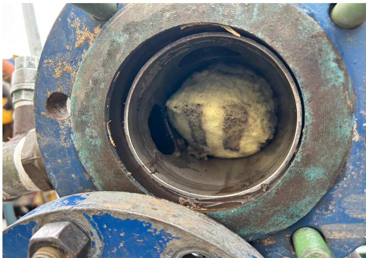
16. 接收端海綿取出情形
