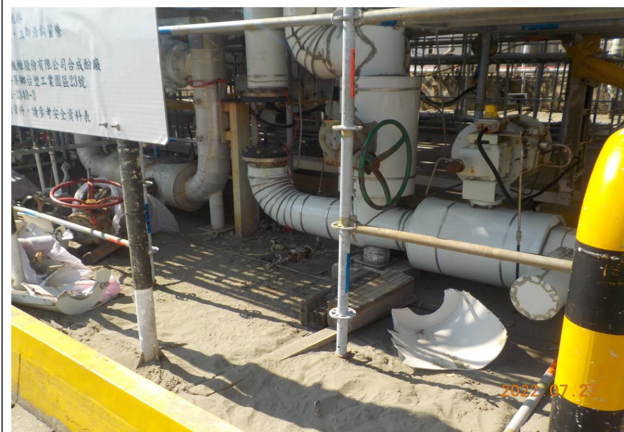
12. 施工完成管線復原(管線上下盲法蘭復原共 16DB)
