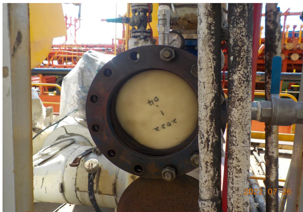
8. 驗收 PIG 安裝情形
