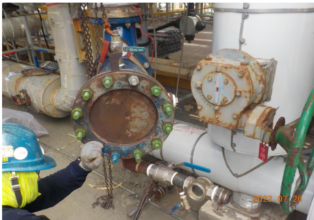
5. 接收端接收器安裝情形
