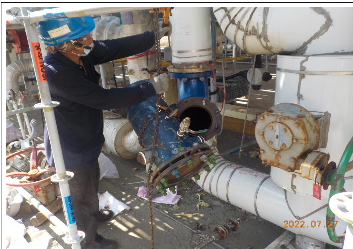
11. 接收端管線復原情形
