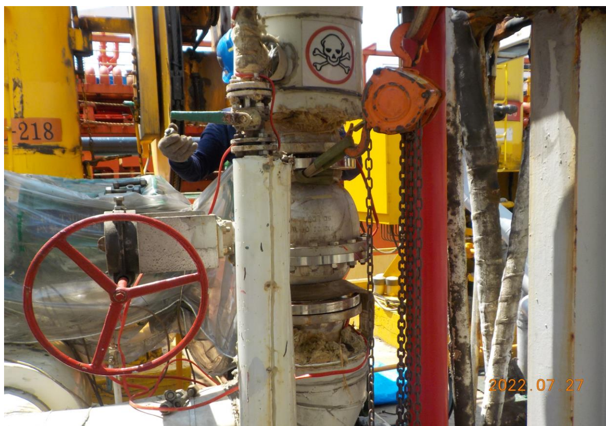
10. 發射端管線復原情形(閥件上下法蘭回裝共 16DB)
