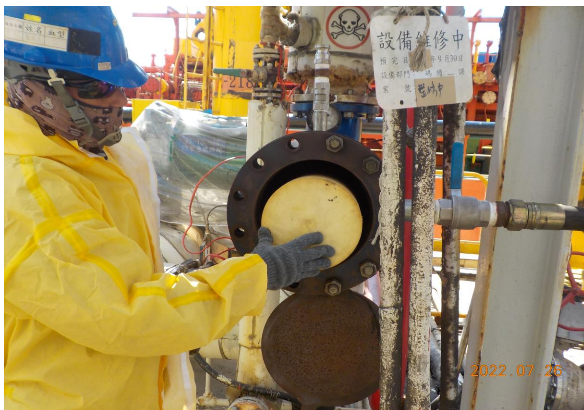
6. 人員安裝 PIG 情形
