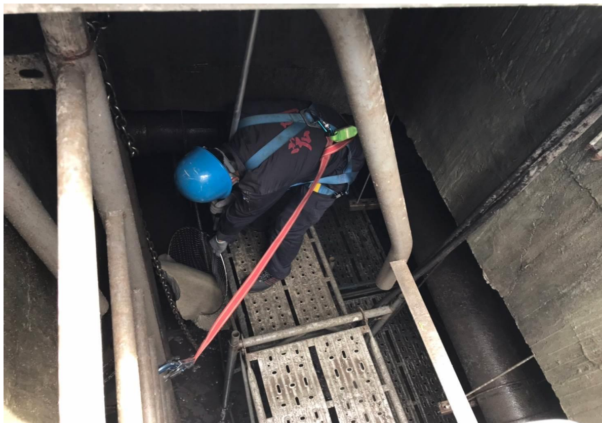
6. 接收端 PIG 打撈情形
