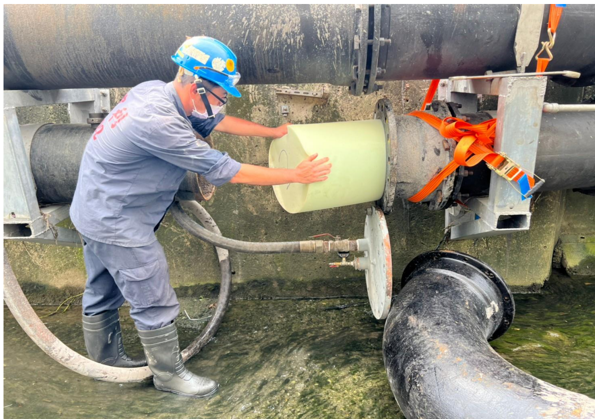
5. 管線安裝發射端情形
