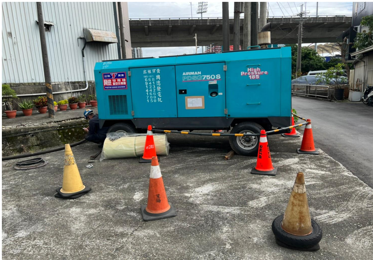
1. 空壓機定位情形
