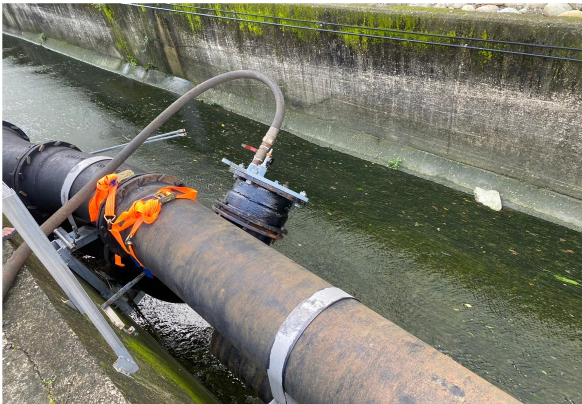
2. 管線發射端安裝情形
