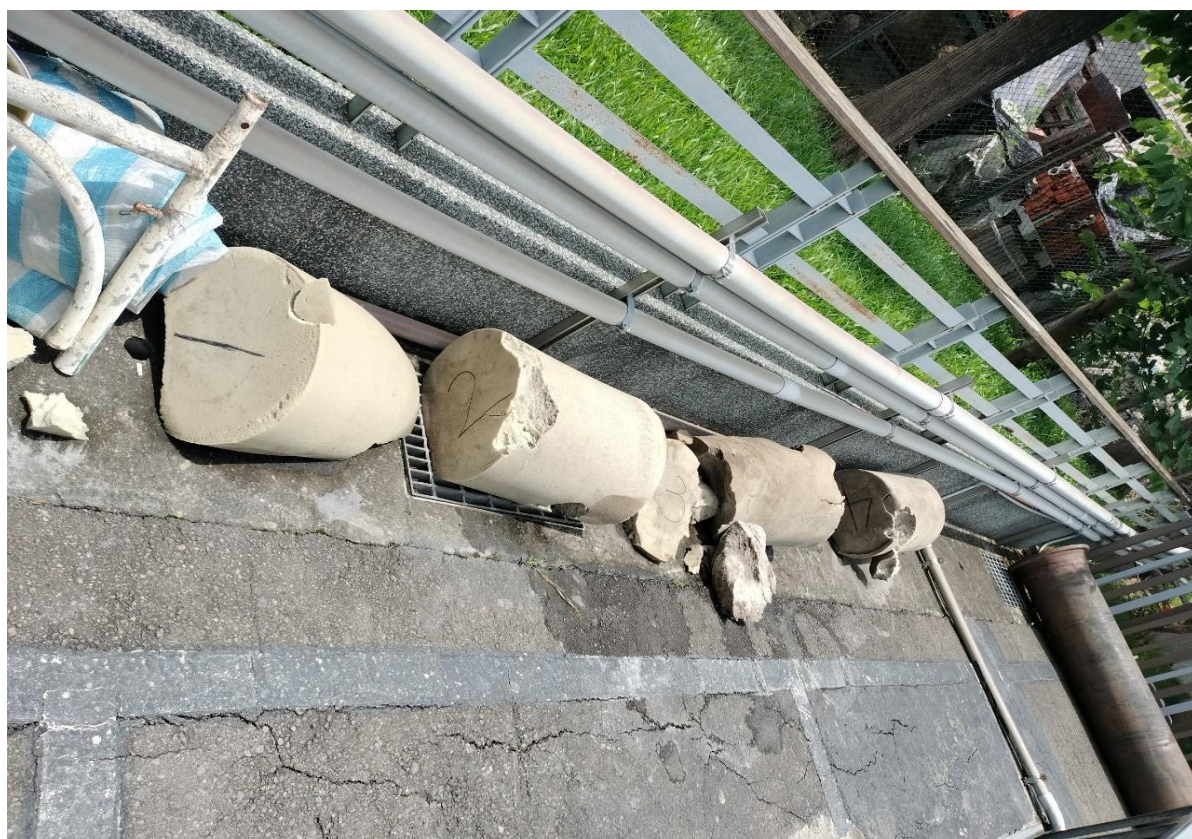
8. 施工完成 PIG 全部打撈出來情形
