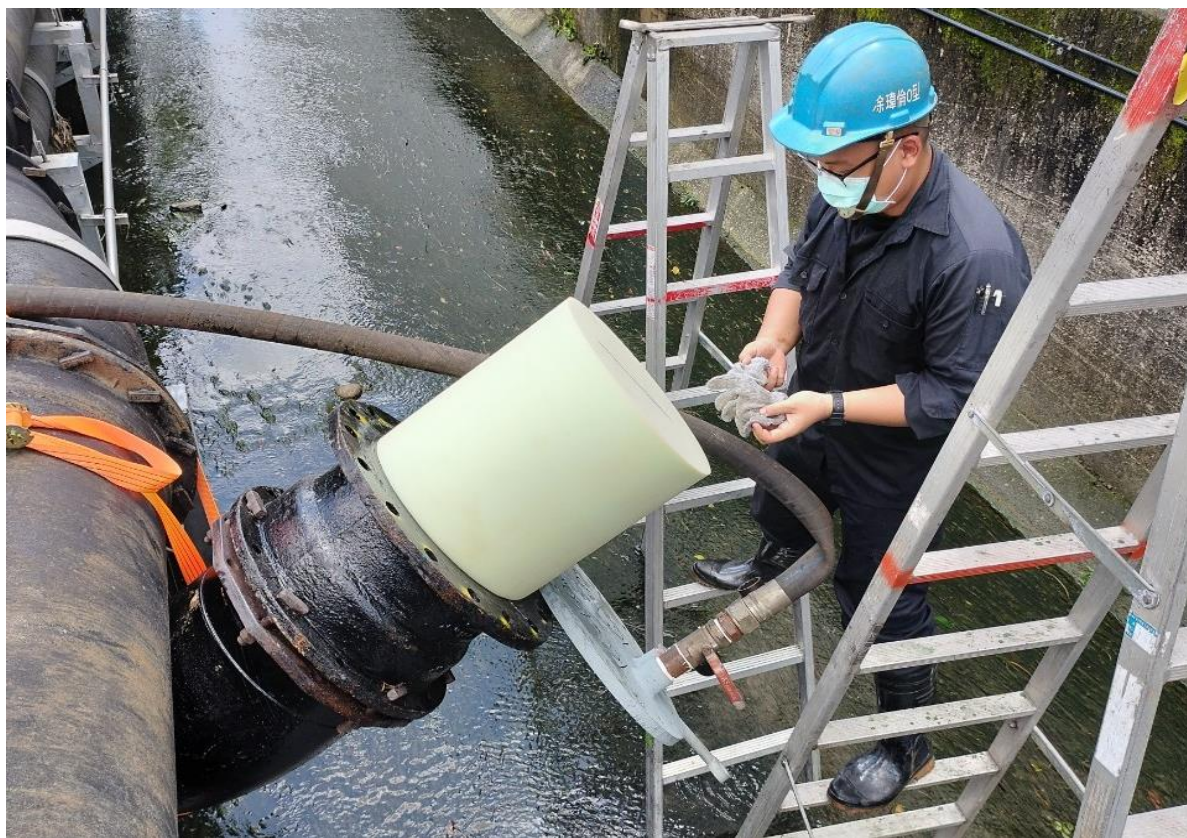
3. 海綿安裝情形
