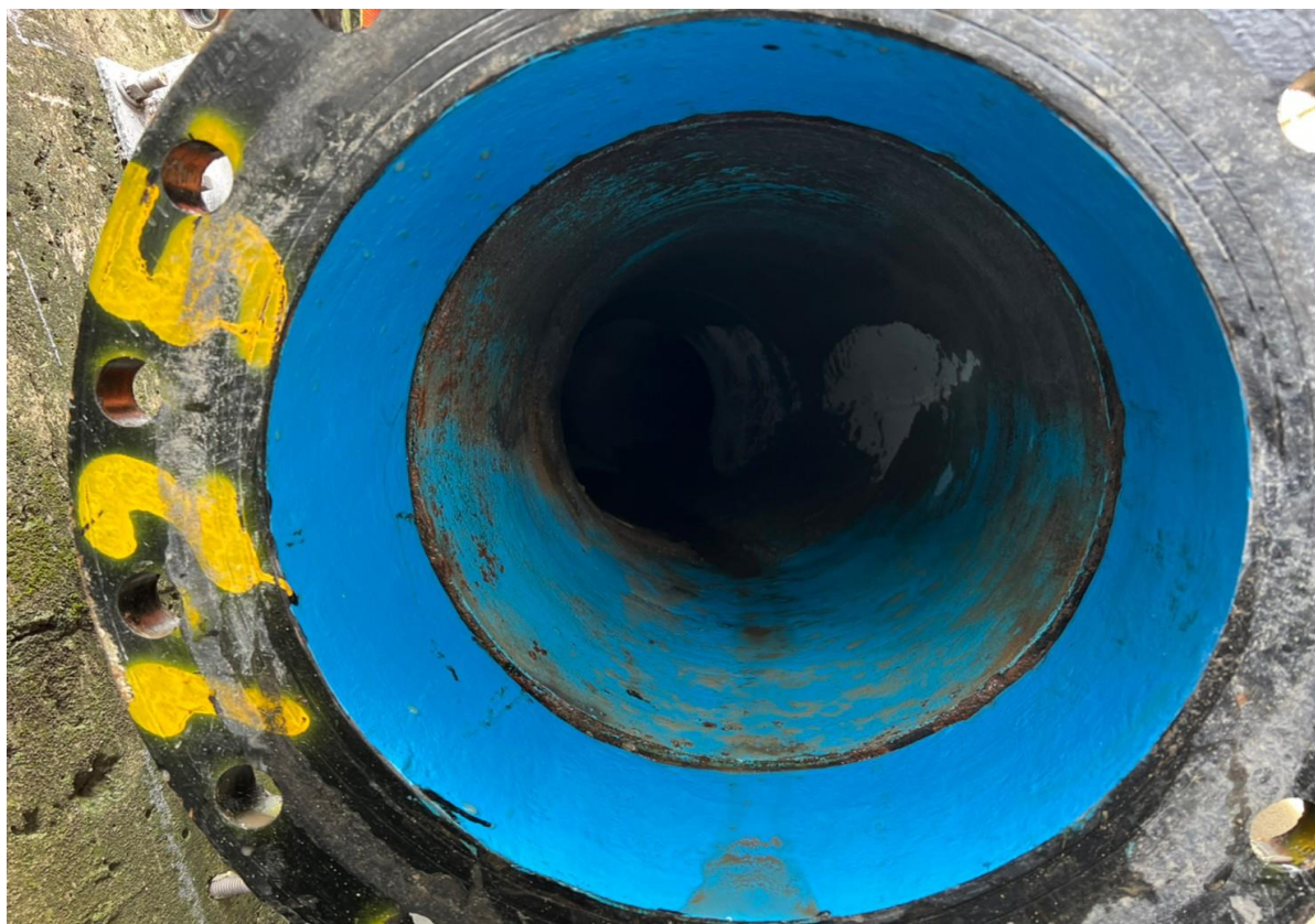
7. 管內清管後情形
