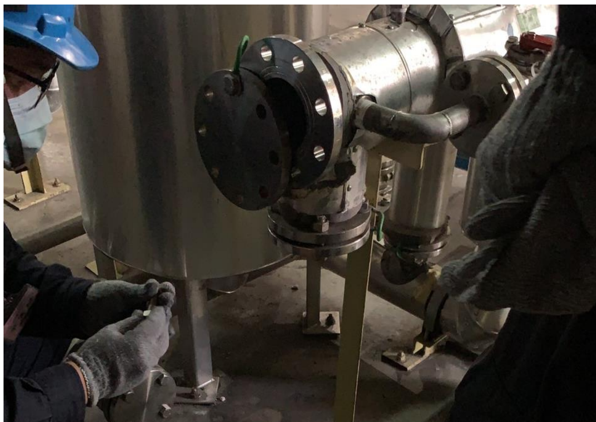
8. 施工完成，管線復原
