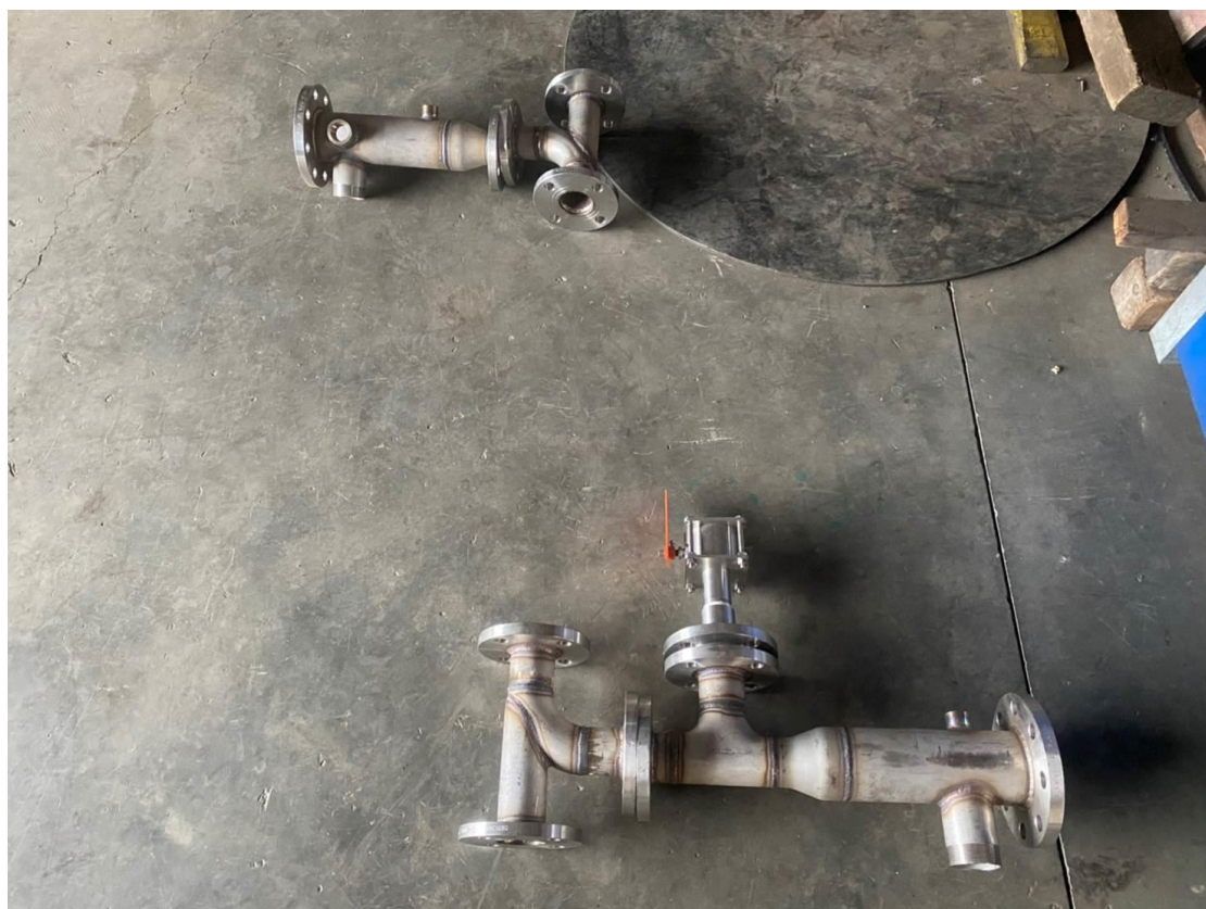
2. 管件預製完成情形(2)
