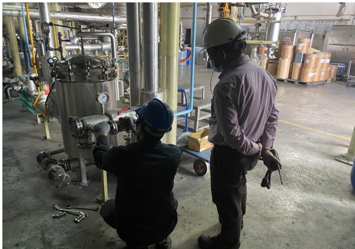
3. 現場安裝情形
