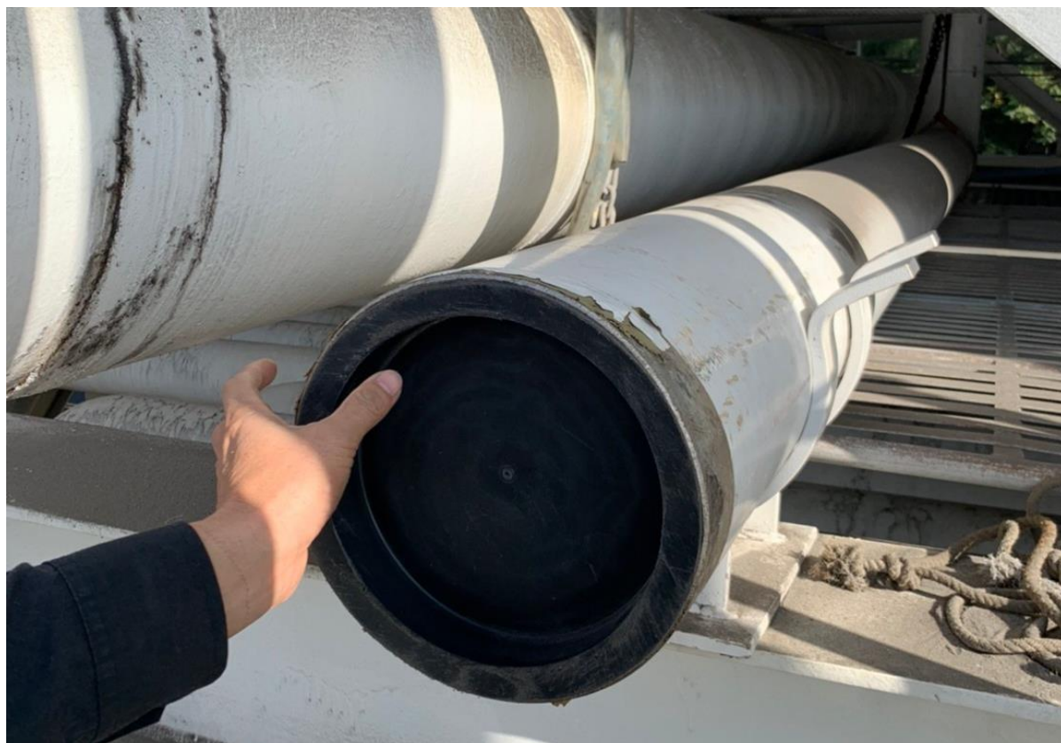
11. 清管完成，管蓋封住
