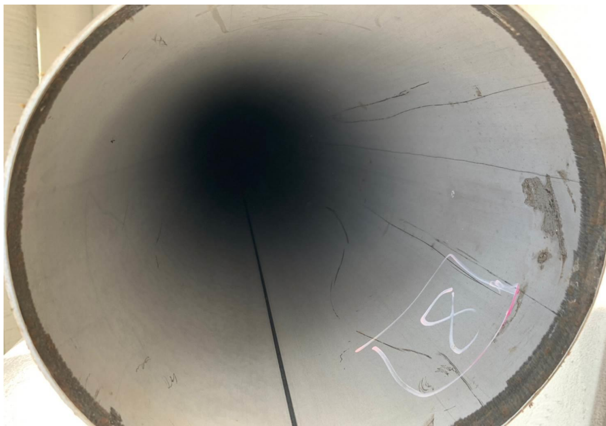
10. 清管完成，管內壁情形
