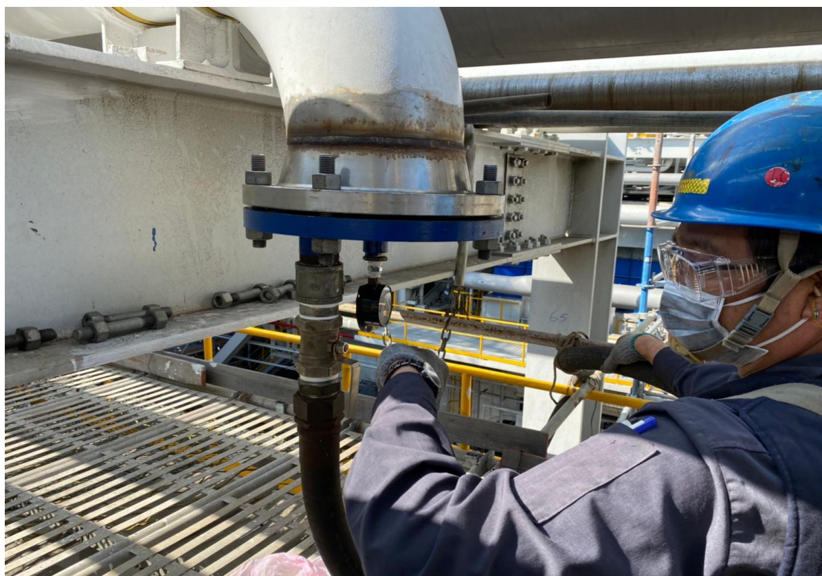
4. 發射端安裝情形(2)
