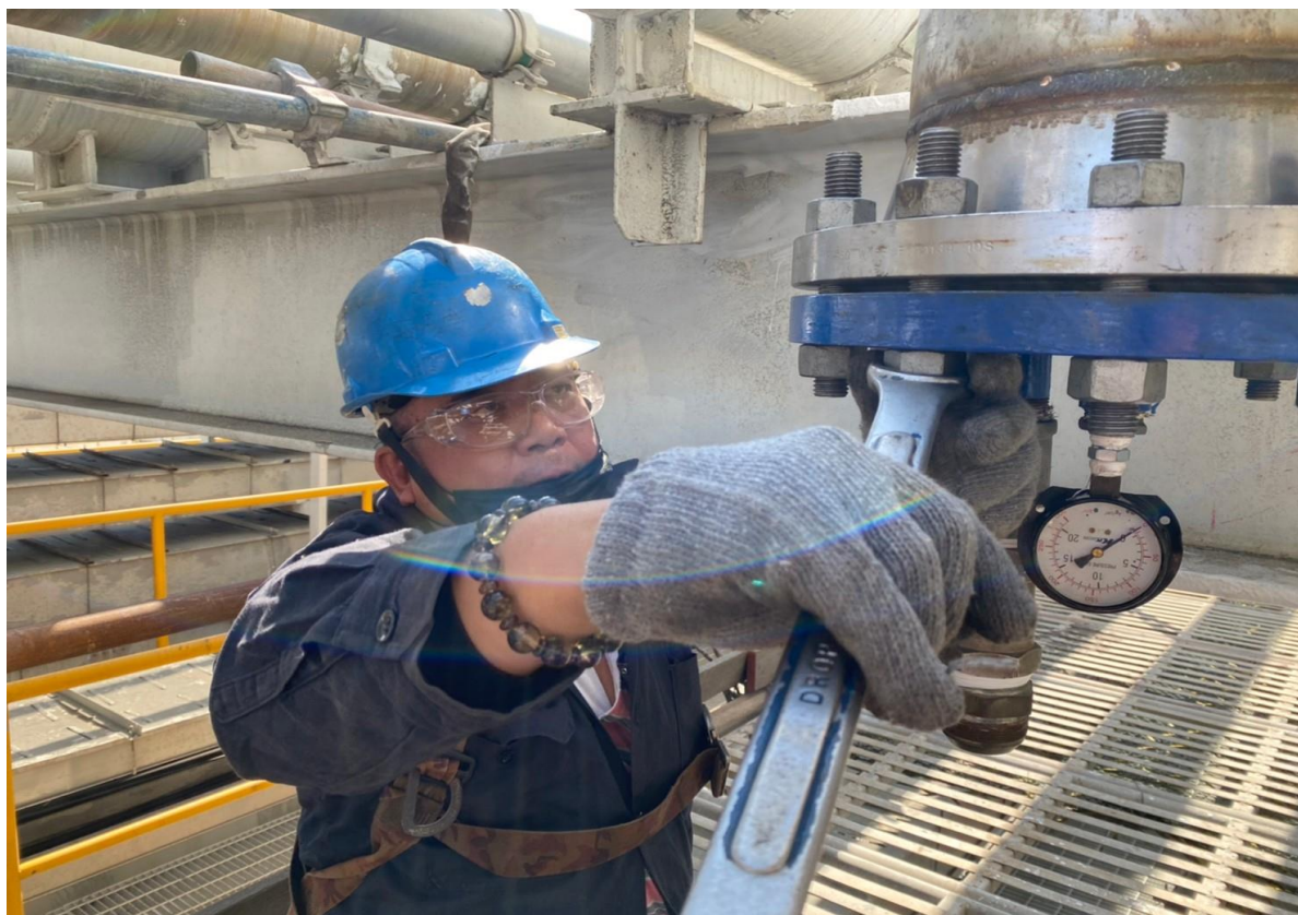
3. 發射端安裝情形(1)
