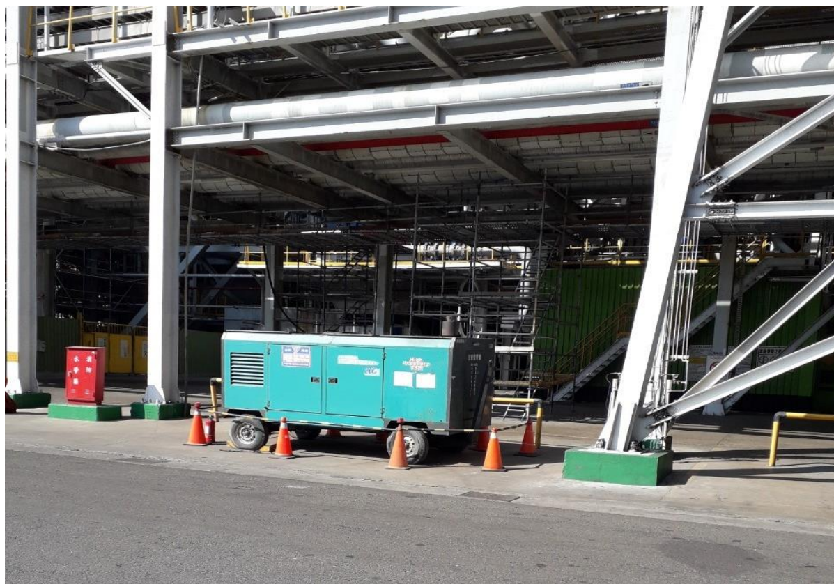
1. 空壓機定位情形
