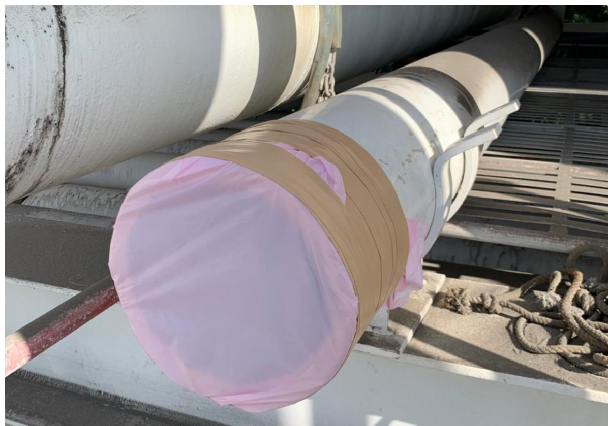
12. 清管完成，管包覆情形
