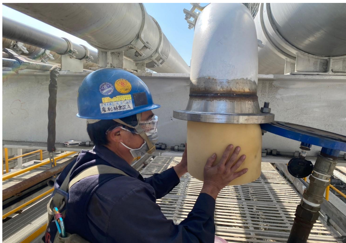
5. PIG 海綿安裝之情形
