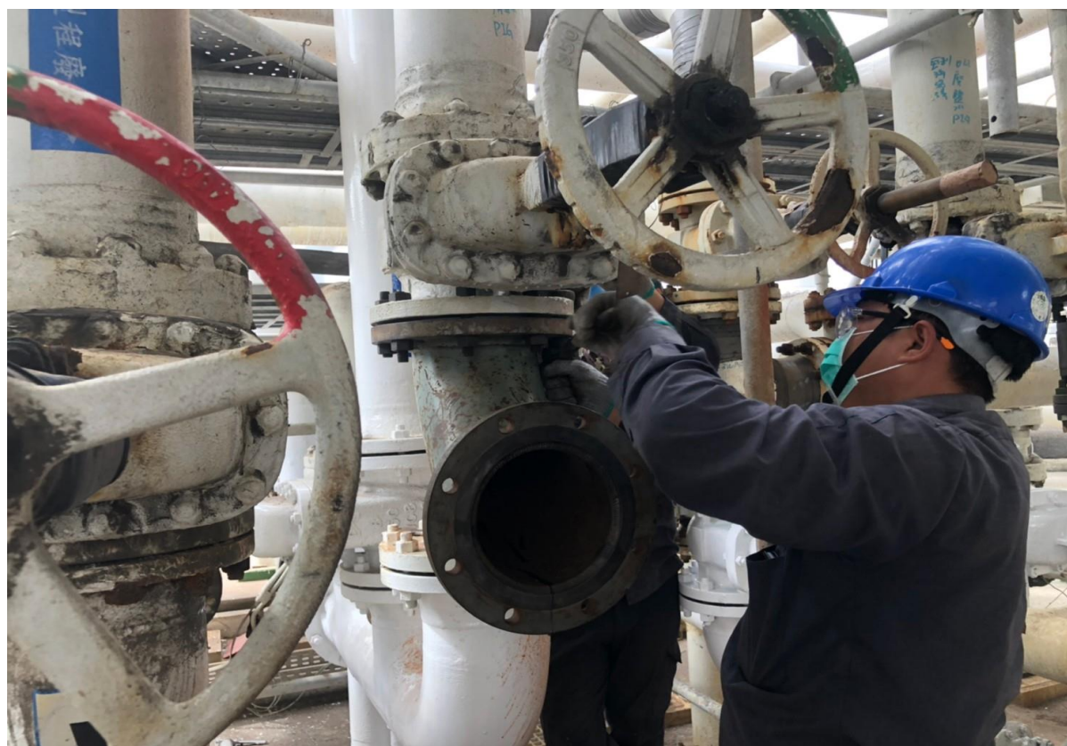
2. 人員安裝發射端情形
