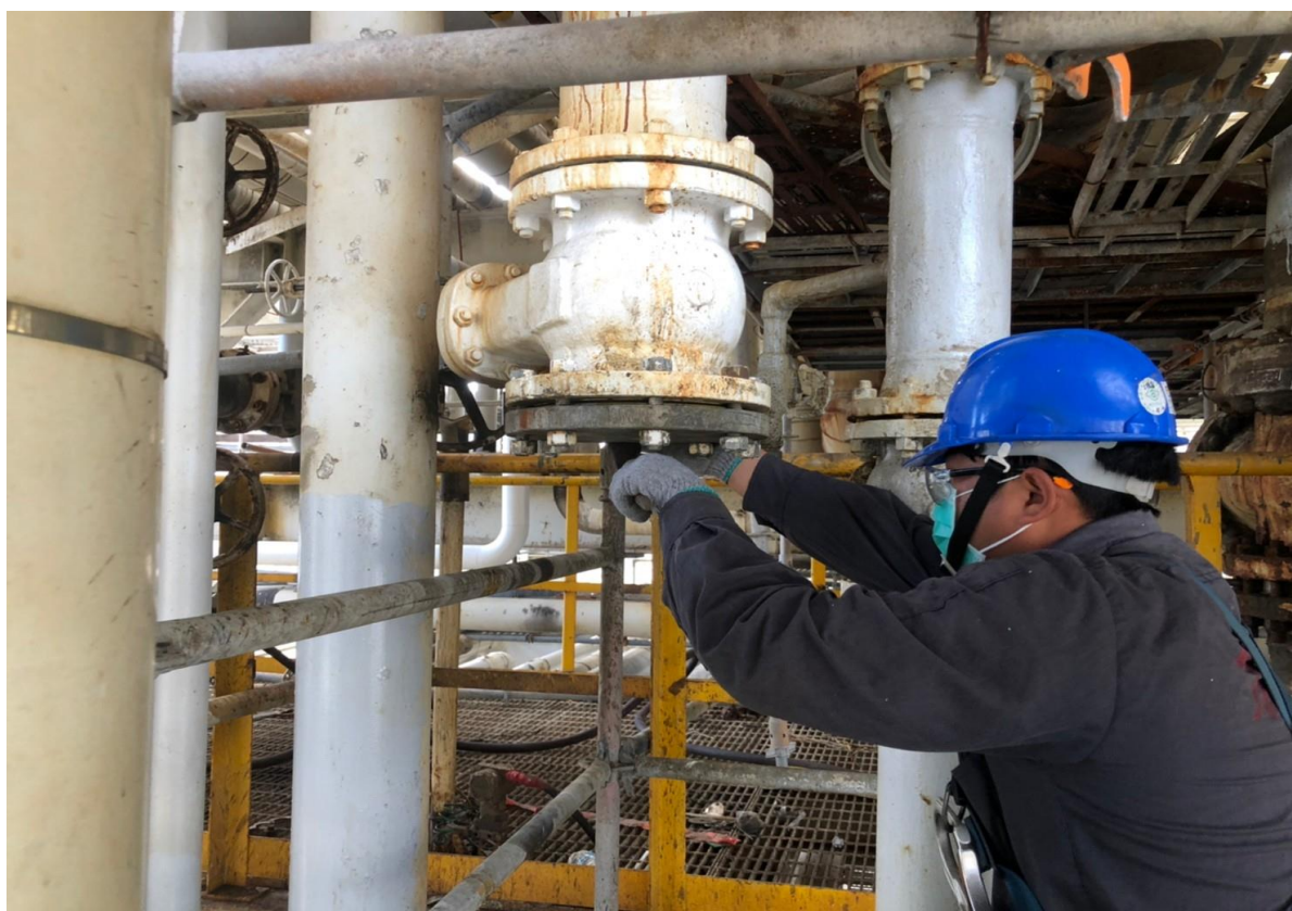
12. 施工完成管線盲封
