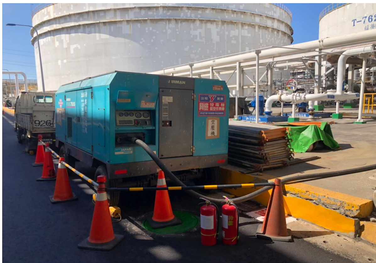
1. 空壓機定位情形
