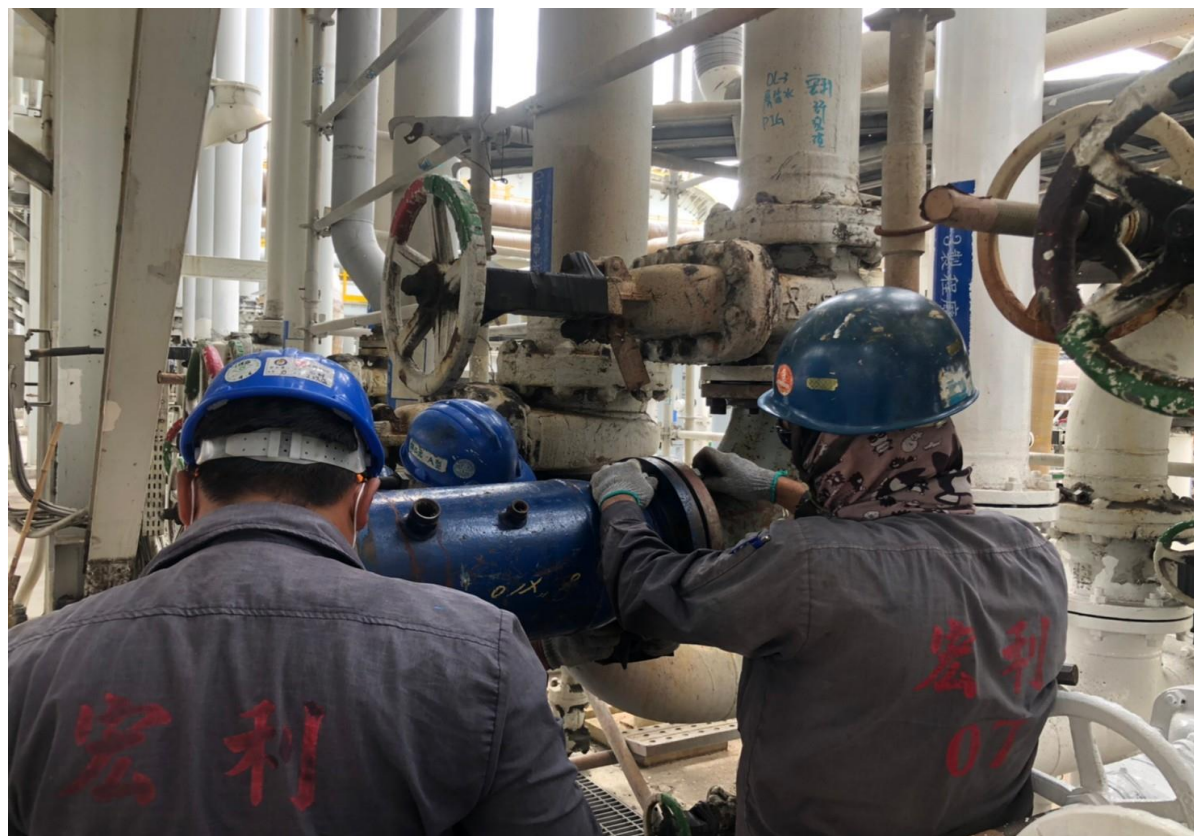
3. 人員於發射端(8")安裝發射器情形
