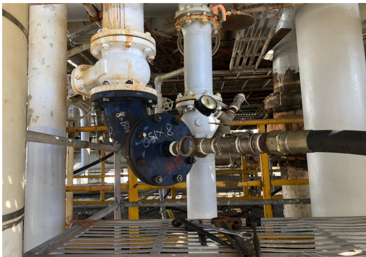
4. 接收端(8")收料安裝情形
