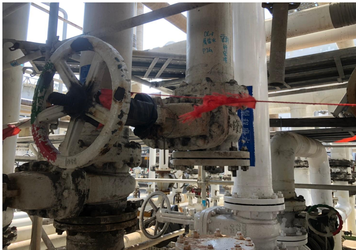
13. 施工完成管線盲封
