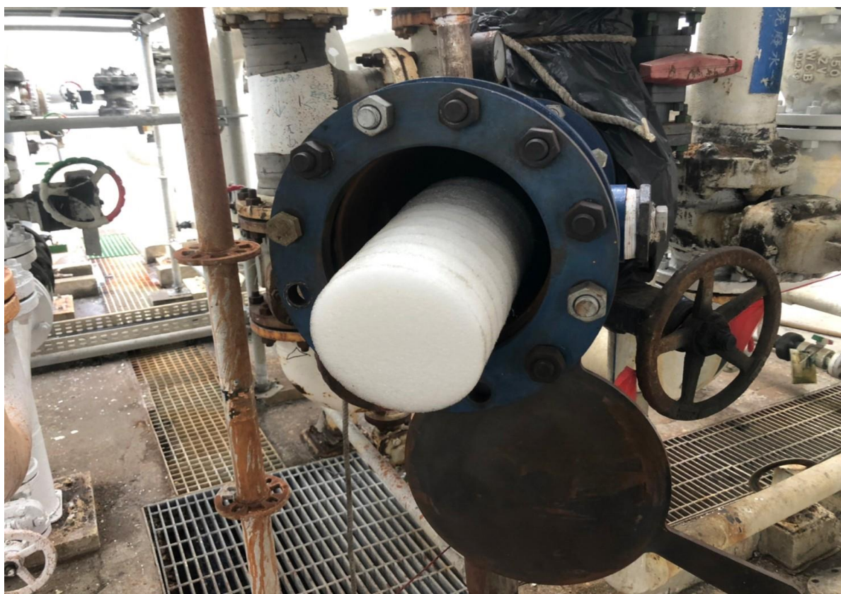
8. 發射端(6")PIG 安裝情形
