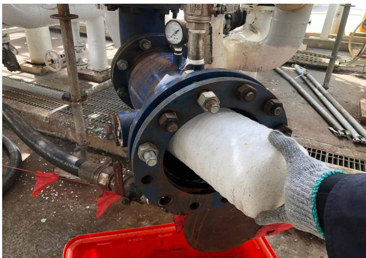
6. 人員安裝 PIG 情形
