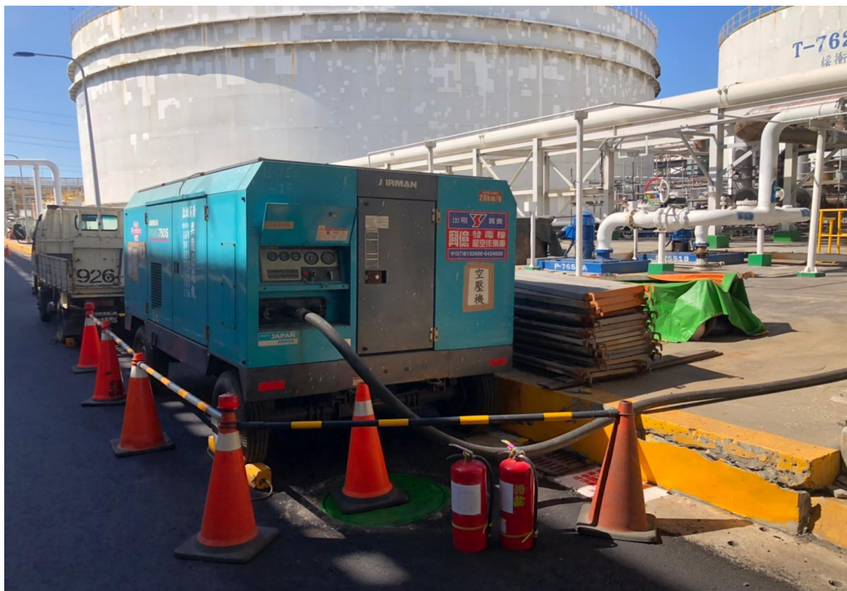
1. 空壓機定位情形
