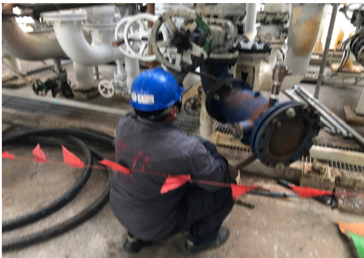
2. 人員安裝發射端情形
