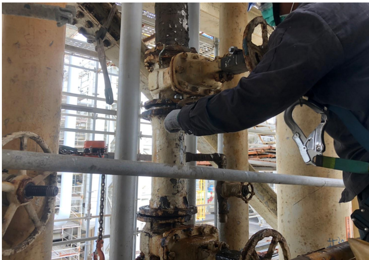
3. 接收端短管移除作業
